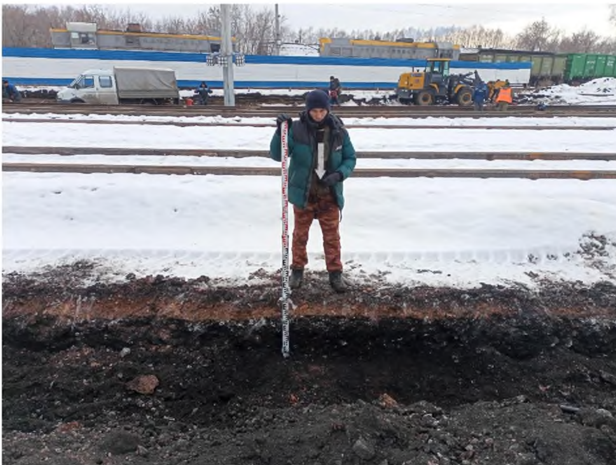
Рис. 34. «Пункт текущего отцепочного ремонта вагонов на ст. Мереть...». Зачистка №1 после производства работ. Фото с С.
