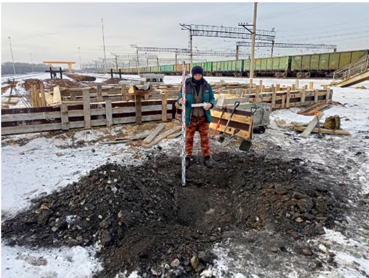
Рис. 30. «Пункт текущего отцепочного ремонта вагонов на ст. Мереть...». Шурф №1 после выборки. Фото с В.
