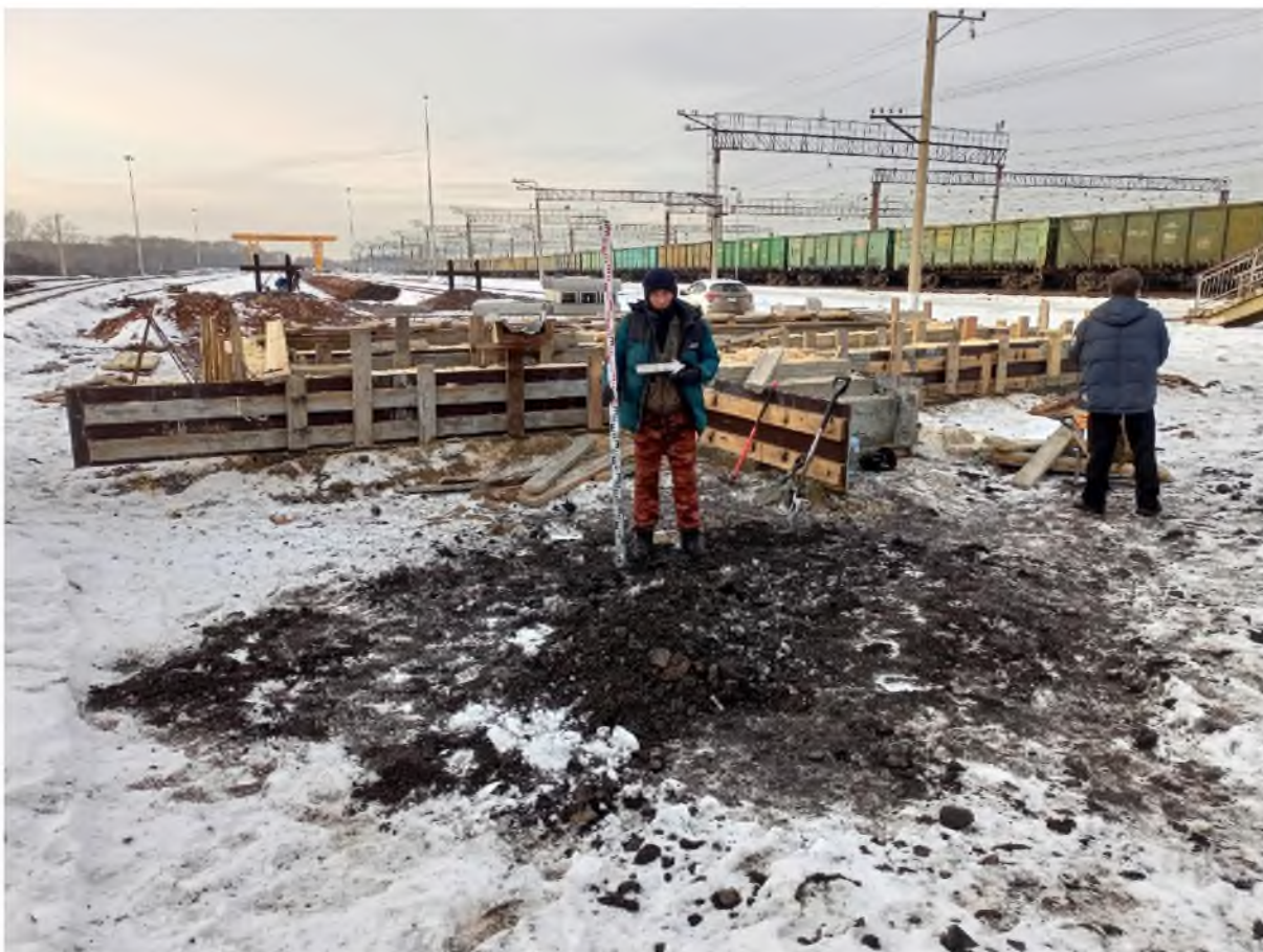
Рис. 32. «Пункт текущего отцепочного ремонта вагонов на ст. Мереть...». Шурф №1. Рекультивация. Фото с В.
