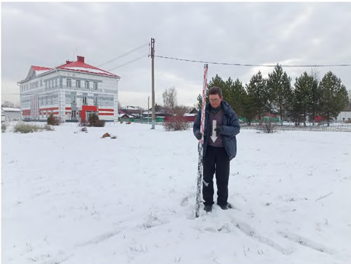
Рис. 15. «Пункт текущего отцепочного ремонта вагонов на ст. Мереть...». Точка фотофиксации №2 ( 54^{\circ}30'4.73''\text{C} , 86^{\circ}19'0.66''\text{B} ). Фото с С.
