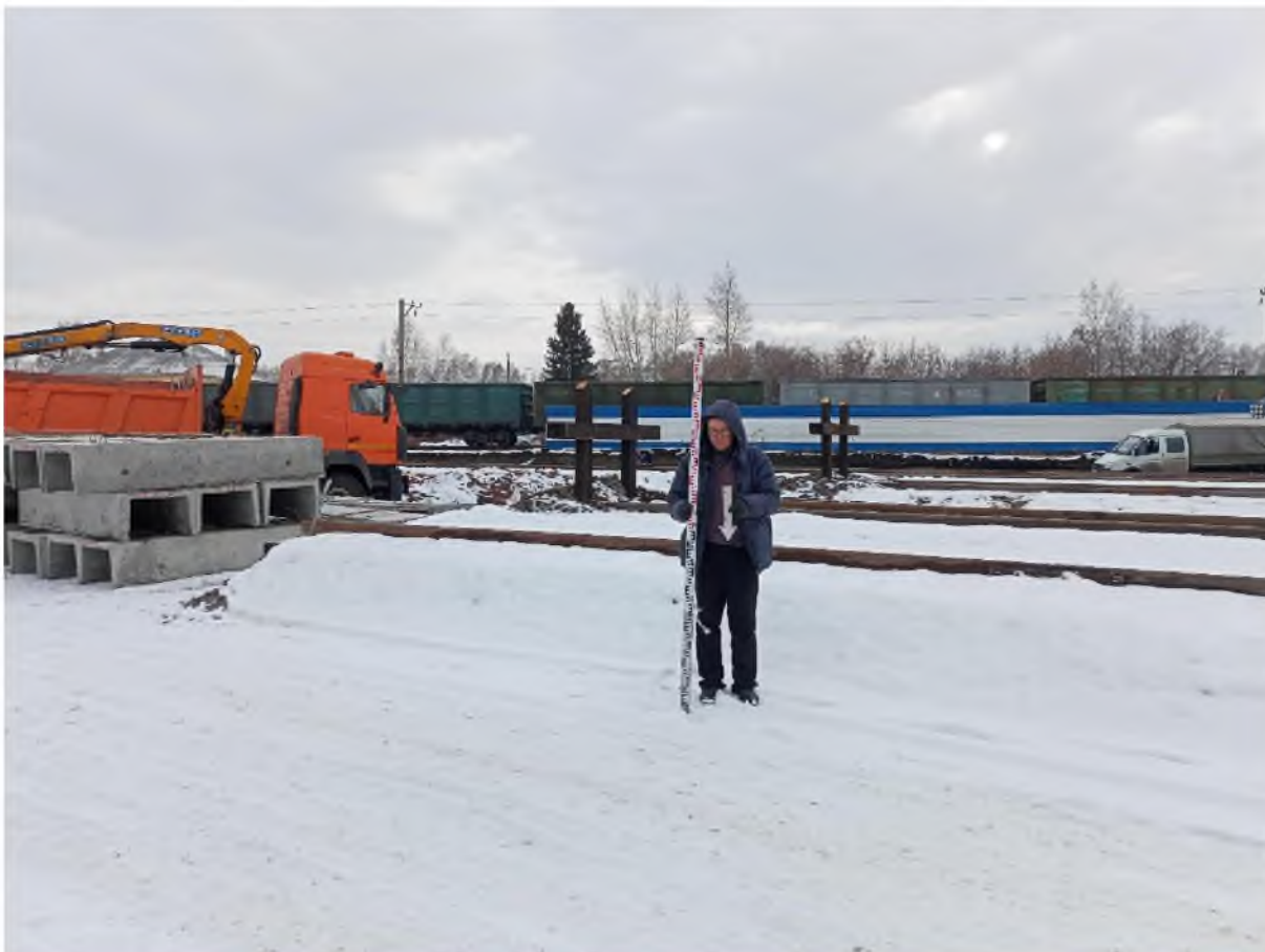
Рис. 27. «Пункт текущего отцепочного ремонта вагонов на ст. Мереть...». Точка фотофиксации №5 ( 54^{\circ}30'7.21''\text{С} , 86^{\circ}18'51.10''\text{В} ). Фото с С.
