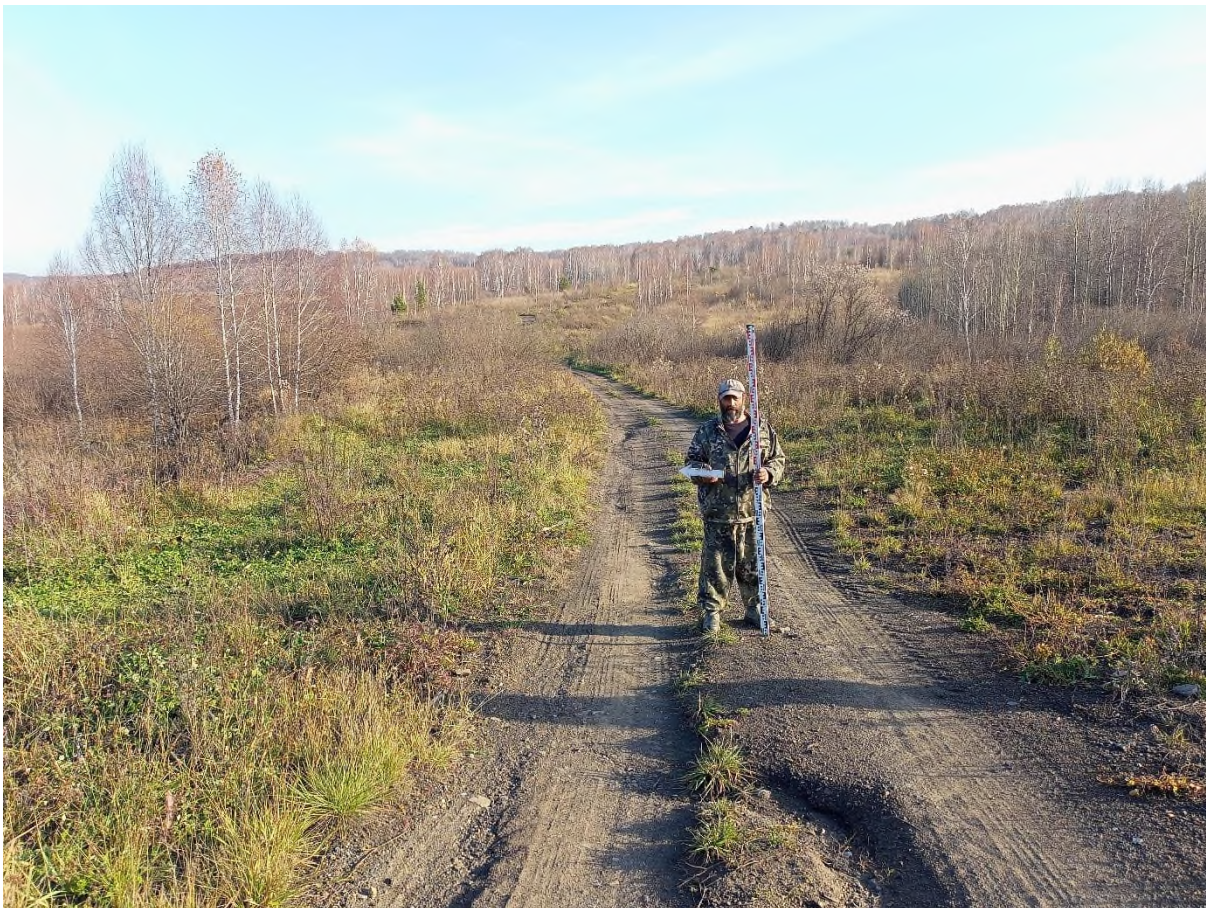
Рис. 63. «Подъездная автомобильная дорога необщего пользования...». Точка фотофиксации №14 ( 53^{\circ}38'52.72''\text{С} , 86^{\circ}56'43.30''\text{В} ). Фото с З.
