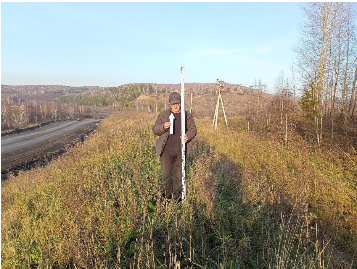
Рис. 66. «Подъездная автомобильная дорога необщего пользования...». Точка фотофиксации №15 ( 53^{\circ}38'45.66''\text{С} , 86^{\circ}56'30.56''\text{В} ). Фото с Ю.
