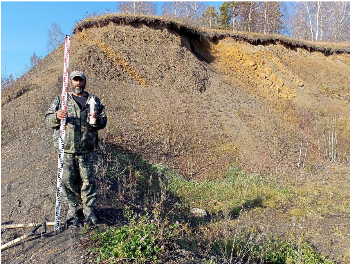
Рис. 59. «Подъездная автомобильная дорога необщего пользования...». Точка фотофиксации №13 ( 53^{\circ}38'57.40''\text{С} , 86^{\circ}56'49.86''\text{В} ). Фото с Ю.
