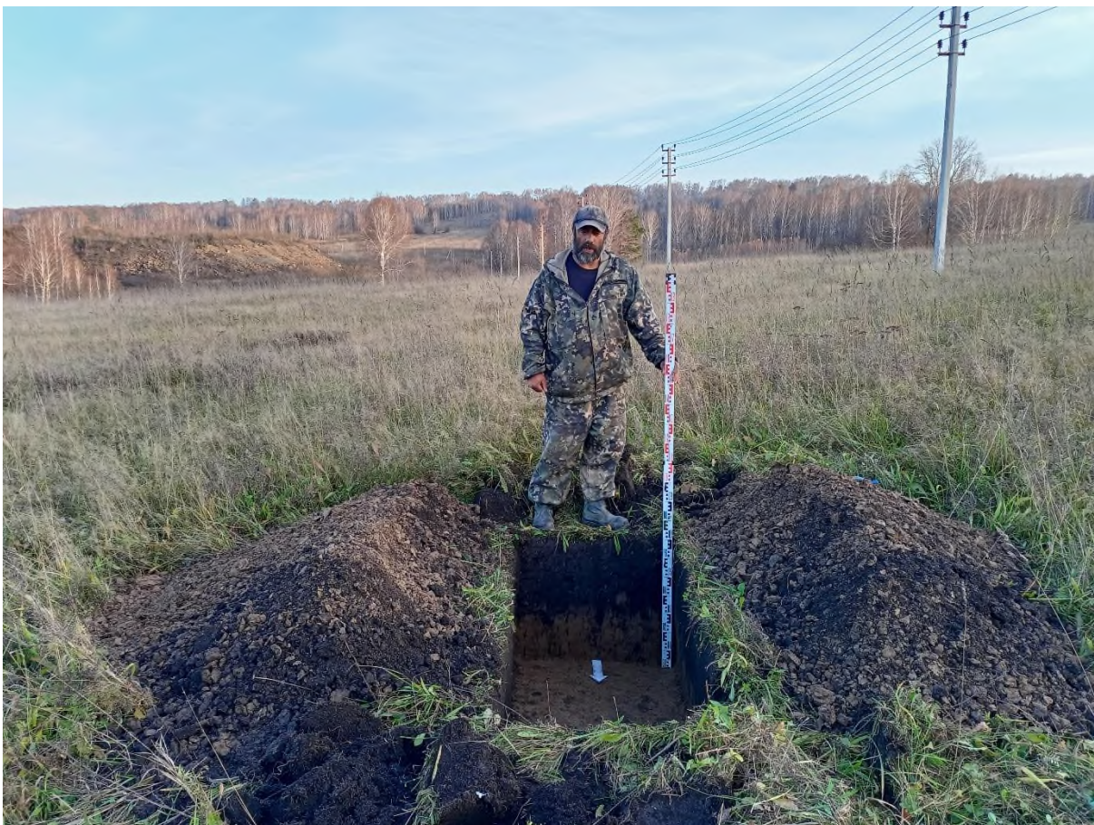
Рис. 98. «Подъездная автомобильная дорога необщего пользования...». Шурф №7 после выборки. Фото с С.
