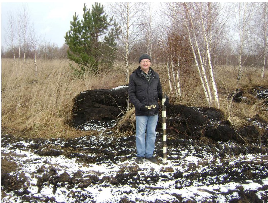
Рис. 21. Вид на обнажения и отвалы грунта в В части проектируемого землеотвода. Фото с ЮЗ стороны.
