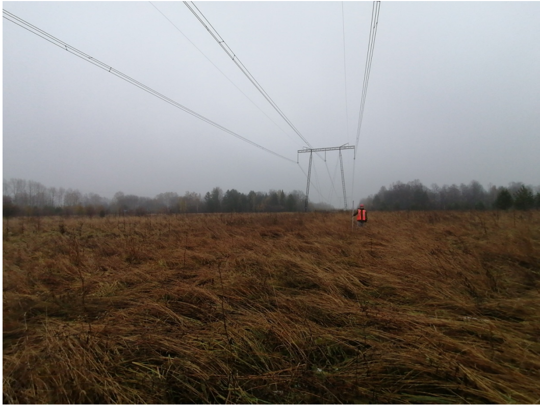
Рис.12. «МН Анжеро-Судженск-Красноярск, ДУ 1200мм, 0,0 - 68,216 км. Участок 51 км-54 км. Новосибирское РНУ. Реконструкция». ТФ №2. Вид участок №1, пересечение ЛЭП в западной части. Снято с З.
