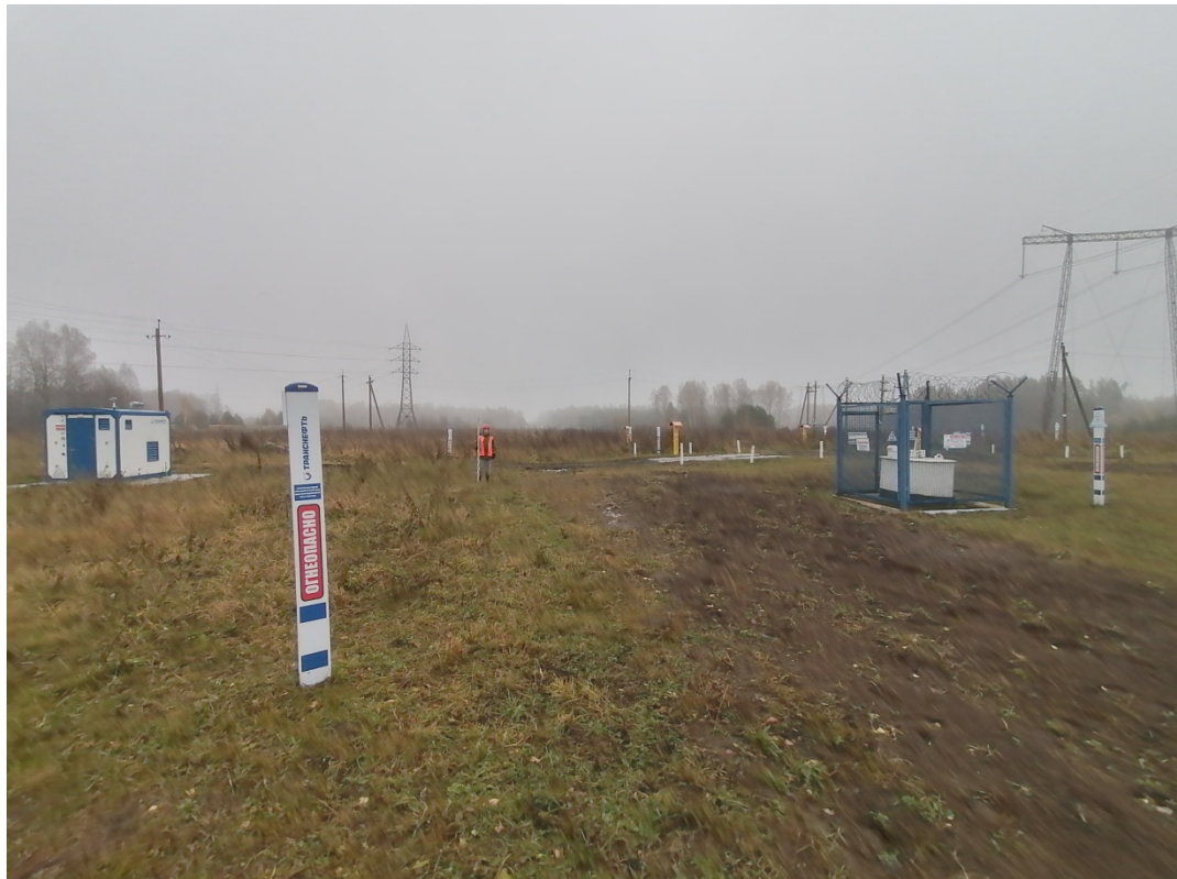
Рис.23. «МН Анжеро-Судженск-Красноярск, ДУ 1200мм, 0,0 - 68,216 км. Участок 51 км-54 км. Новосибирское РНУ. Реконструкция». ТФ №7. Вид участок №1. Снято с Ю.
