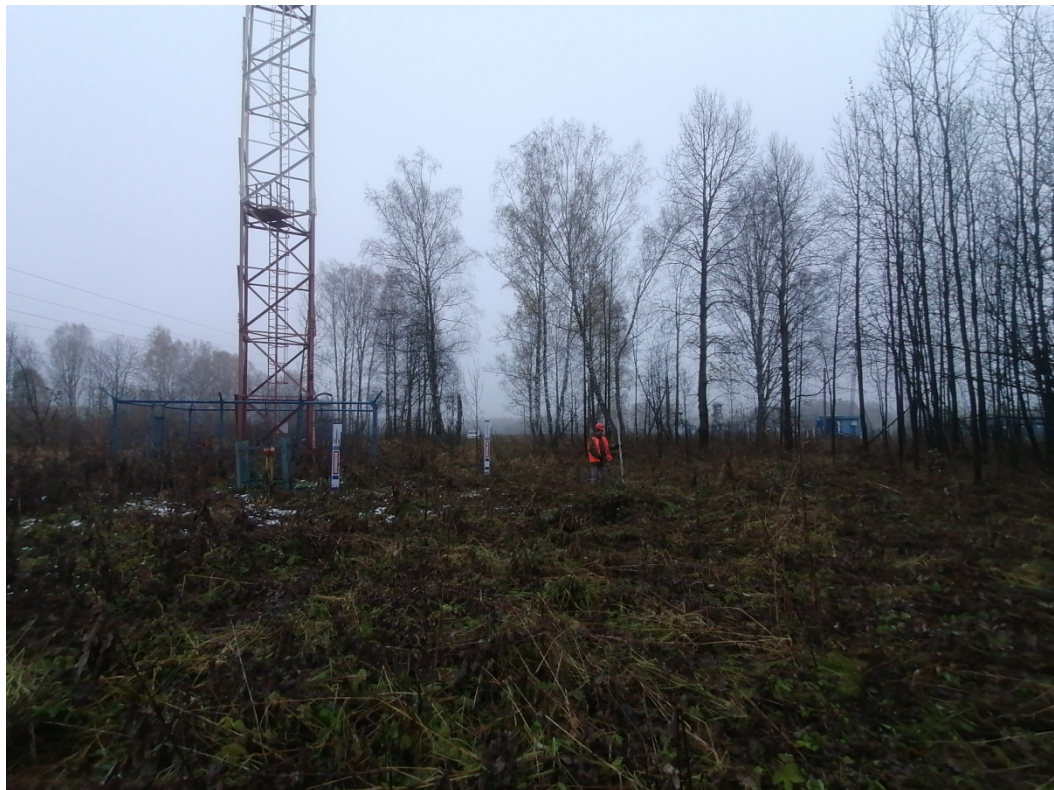
Рис.21. «МН Анжеро-Судженск-Красноярск, ДУ 1200мм, 0,0 - 68,216 км. Участок 51 км-54 км. Новосибирское РНУ. Реконструкция». ТФ №б. Вид участок №1. Центральная часть участка обследования. Снято с З.
