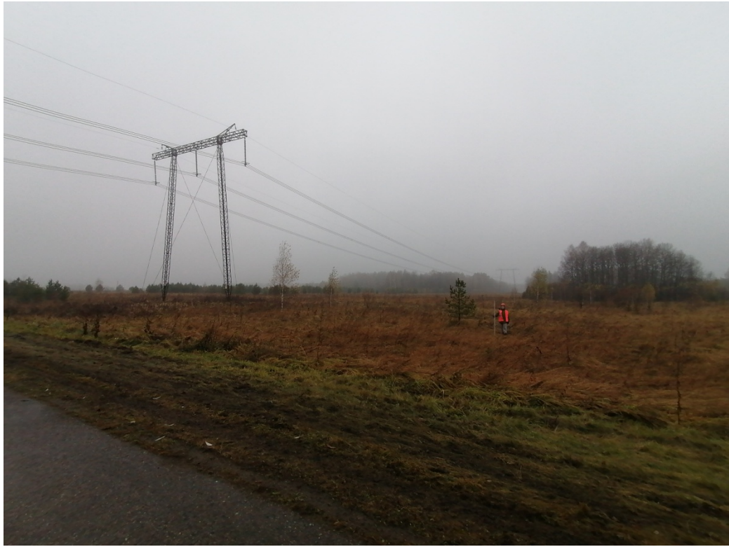
Рис.14. «МН Анжеро-Судженск-Красноярск, ДУ 1200мм, 0,0 - 68,216 км. Участок 51 км-54 км. Новосибирское РНУ. Реконструкция». ТФ №3. Вид участок №1, пересечение автодороги к с. Ломачевка, в западной части. Снято с В.
