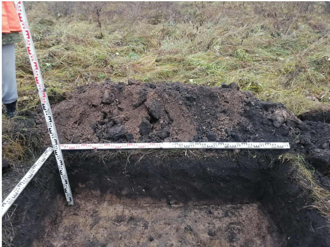
Рис.55. «МН Анжеро-Судженск-Красноярск, ДУ 1200мм, 0,0 - 68,216 км. Участок 51 км-54 км. Новосибирское РНУ. Реконструкция». Участок №2. Шурф №4. Северная стенка. Снято с Ю.
