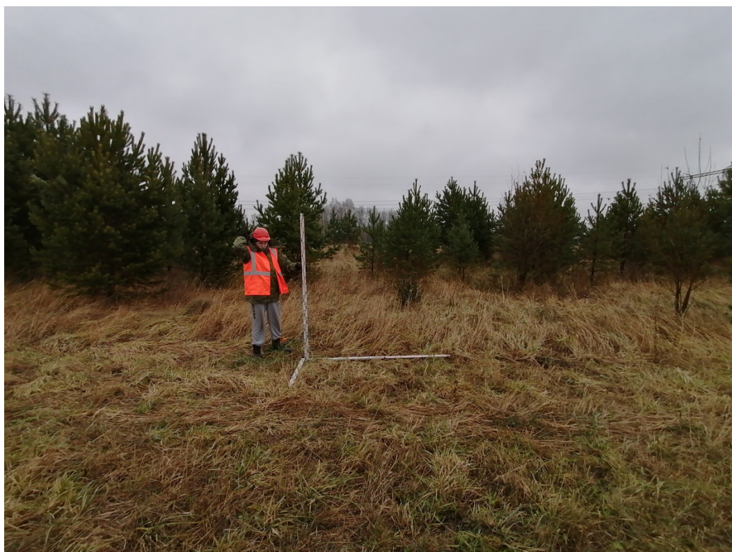
Рис.41. «МН Анжеро-Судженск-Красноярск, ДУ 1200мм, 0,0 - 68,216 км. Участок 51 км-54 км. Новосибирское РНУ. Реконструкция». Участок №1. Шурф №1. Место закладки. Снято с Ю.
