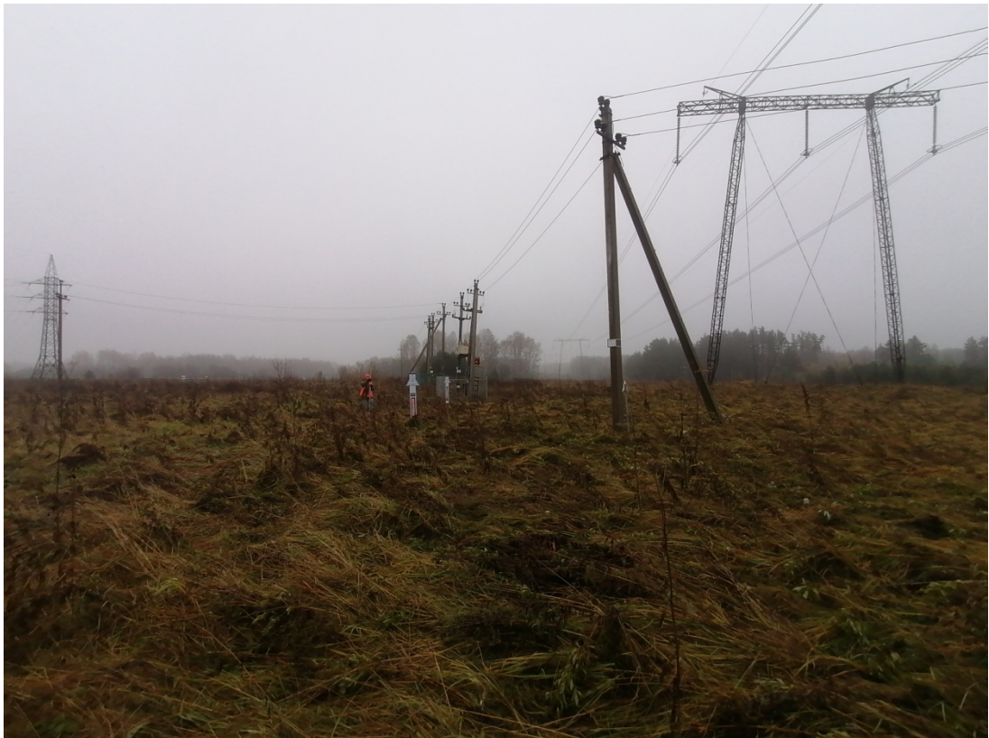
Рис.25. «МН Анжеро-Судженск-Красноярск, ДУ 1200мм, 0,0 - 68,216 км. Участок 51 км-54 км. Новосибирское РНУ. Реконструкция». ТФ №8. Вид участок №1. Снято с ЮВ.
