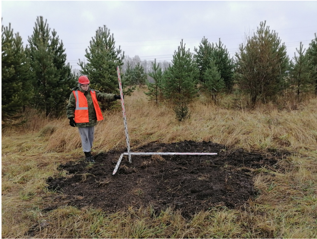
Рис.44. «МН Анжеро-Судженск-Красноярск, ДУ 1200мм, 0,0 - 68,216 км. Участок 51 км-54 км. Новосибирское РНУ. Реконструкция». Участок №1. Шурф №1. Рекультивация. Снято с Ю.
