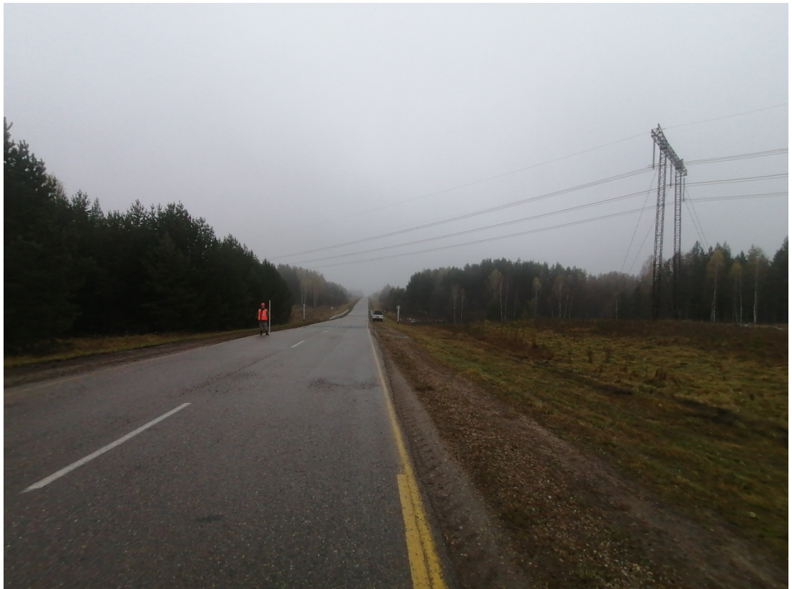
Рис.27. «МН Анжеро-Судженск-Красноярск, ДУ 1200мм, 0,0 - 68,216 км. Участок 51 км-54 км. Новосибирское РНУ. Реконструкция». ТФ №9. Вид участок №1. Снято с С.
