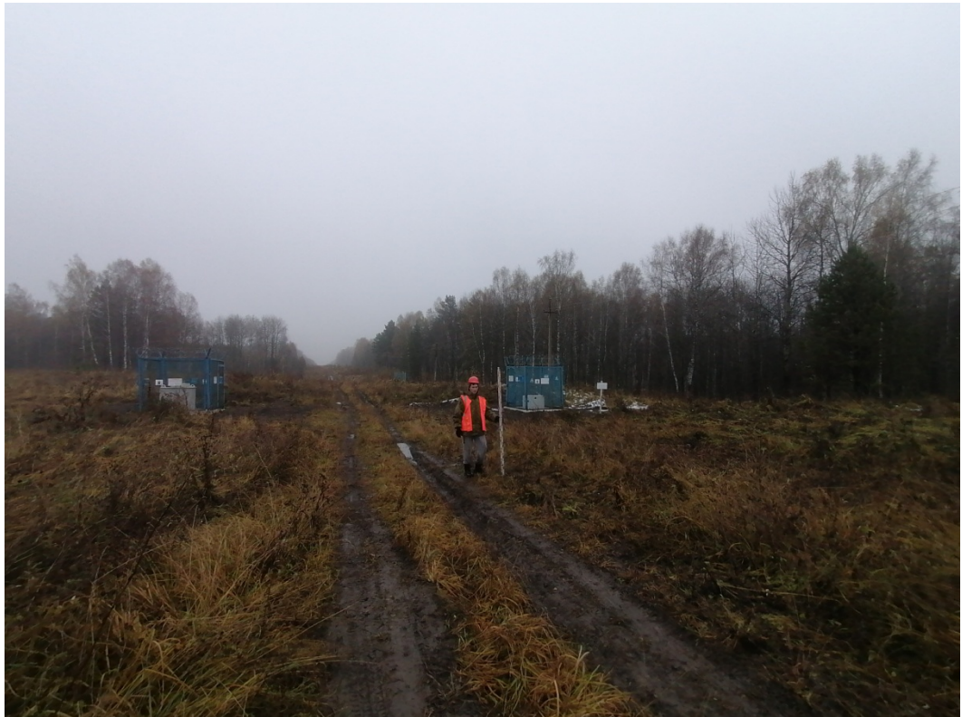
Рис.29. «МН Анжеро-Судженск-Красноярск, ДУ 1200мм, 0,0 - 68,216 км. Участок 51 км-54 км. Новосибирское РНУ. Реконструкция». ТФ №10. Вид участок №1. Восточная часть. Снято с З.
