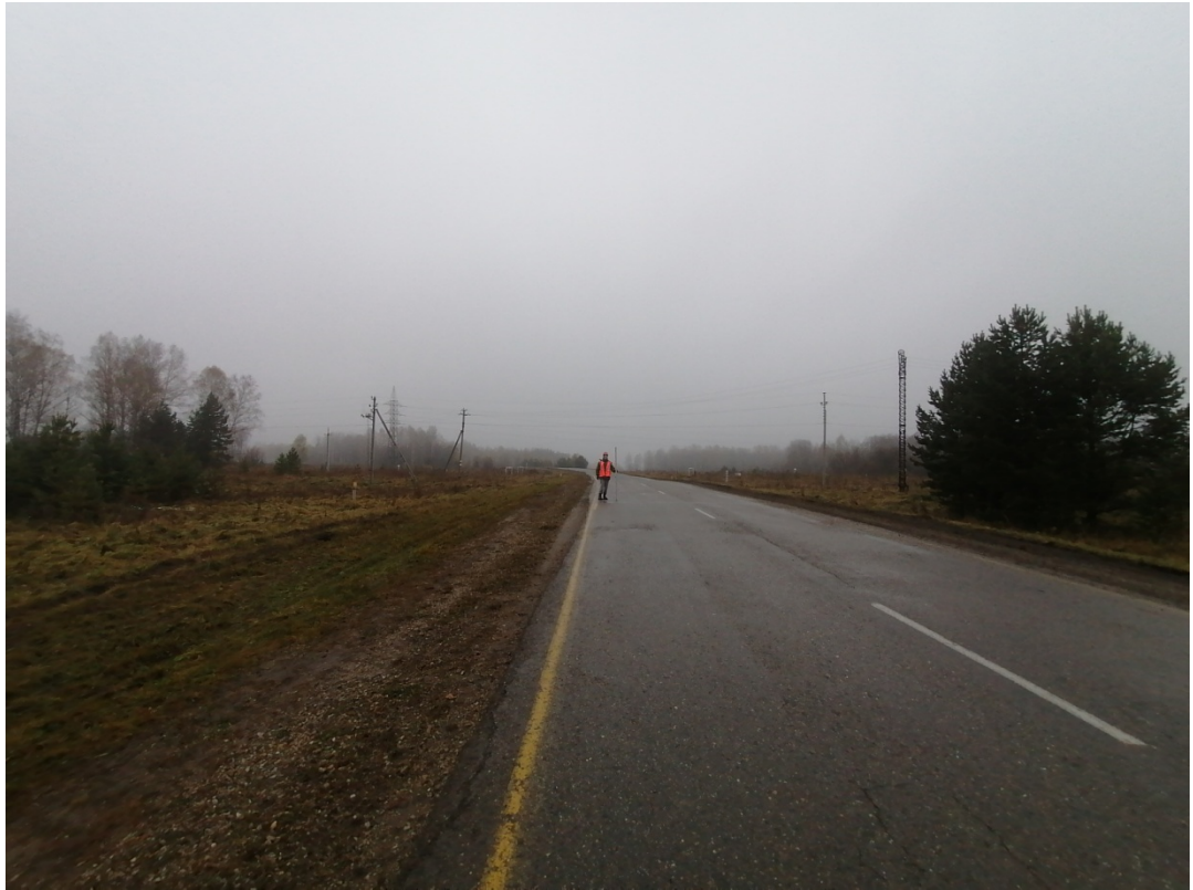
Рис.28. «МН Анжеро-Судженск-Красноярск, ДУ 1200мм, 0,0 - 68,216 км. Участок 51 км-54 км. Новосибирское РНУ. Реконструкция». ТФ №9. Вид участок №1. Снято с Ю.
