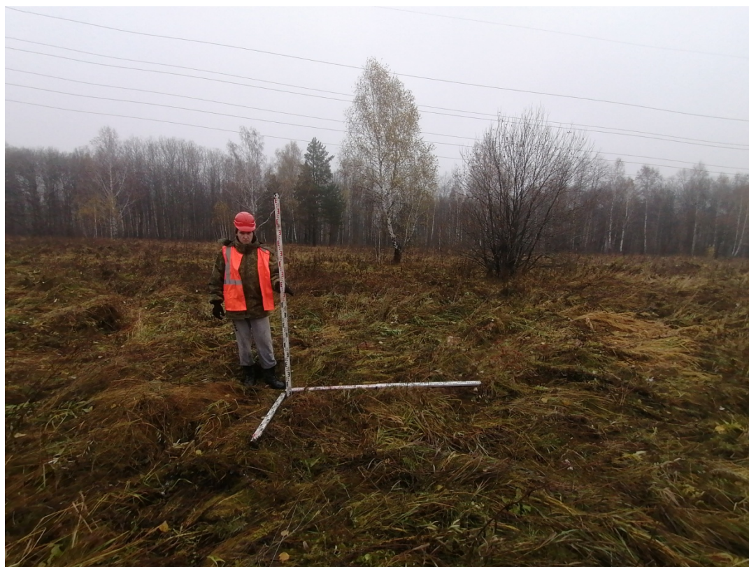
Рис.53. «МН Анжеро-Судженск-Красноярск, ДУ 1200мм, 0,0 - 68,216 км. Участок 51 км-54 км. Новосибирское РНУ. Реконструкция». Участок №2. Шурф №4. Место закладки. Снято с Ю.
