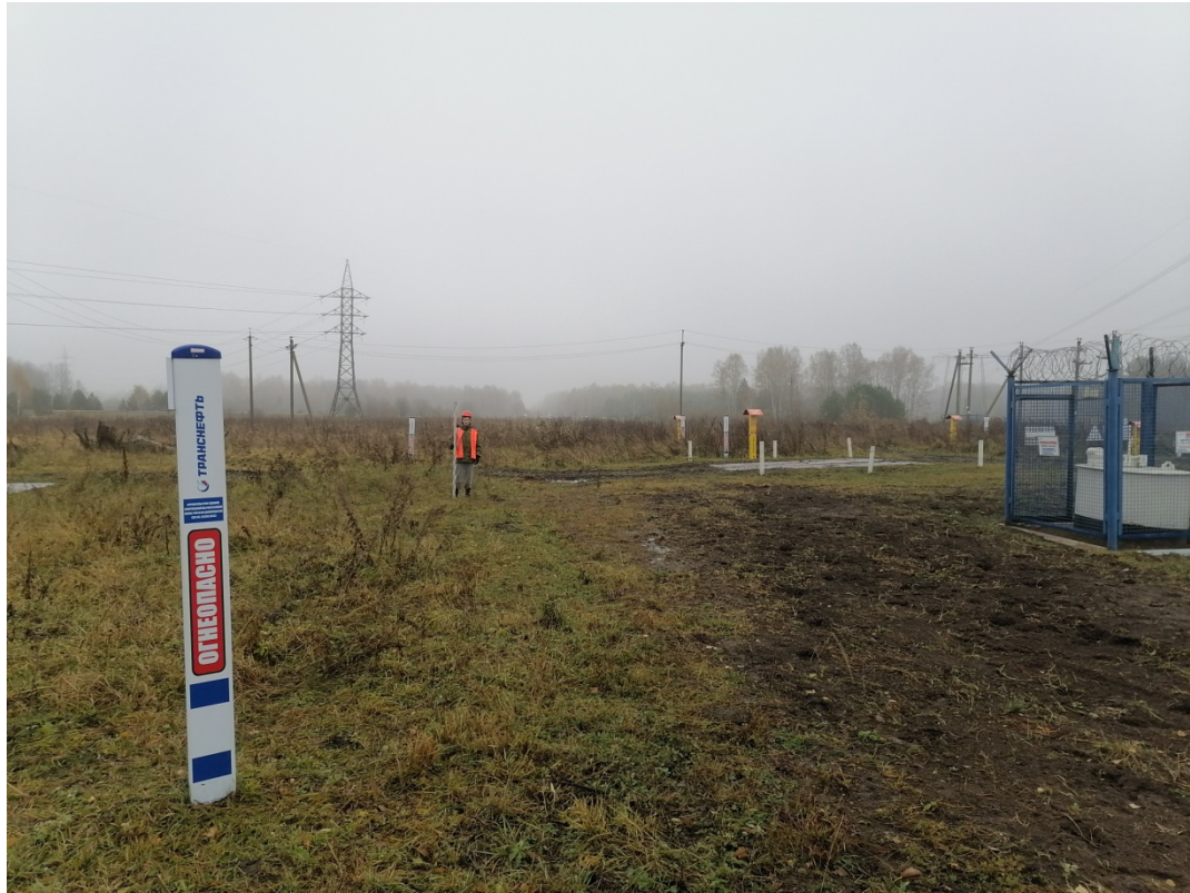
Рис.22. «МН Анжеро-Судженск-Красноярск, ДУ 1200мм, 0,0 - 68,216 км. Участок 51 км-54 км. Новосибирское РНУ. Реконструкция». ТФ №7. Вид участок №1. Снято с С.
