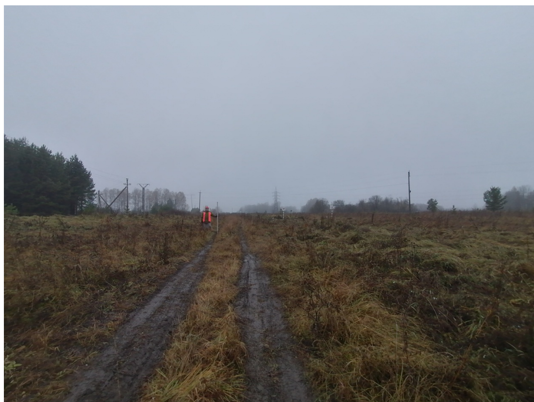
Рис.31. «МН Анжеро-Судженск-Красноярск, ДУ 1200мм, 0,0 - 68,216 км. Участок 51 км-54 км. Новосибирское РНУ. Реконструкция». ТФ №10. Вид участок №1. Восточная часть. Снято с В.
