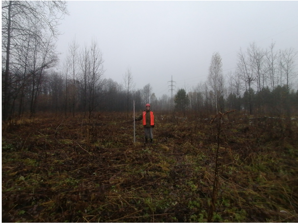
Рис.20. «МН Анжеро-Судженск-Красноярск, ДУ 1200мм, 0,0 - 68,216 км. Участок 51 км-54 км. Новосибирское РНУ. Реконструкция». ТФ №б. Вид участок №1. Центральная часть участка обследования. Снято с В.
