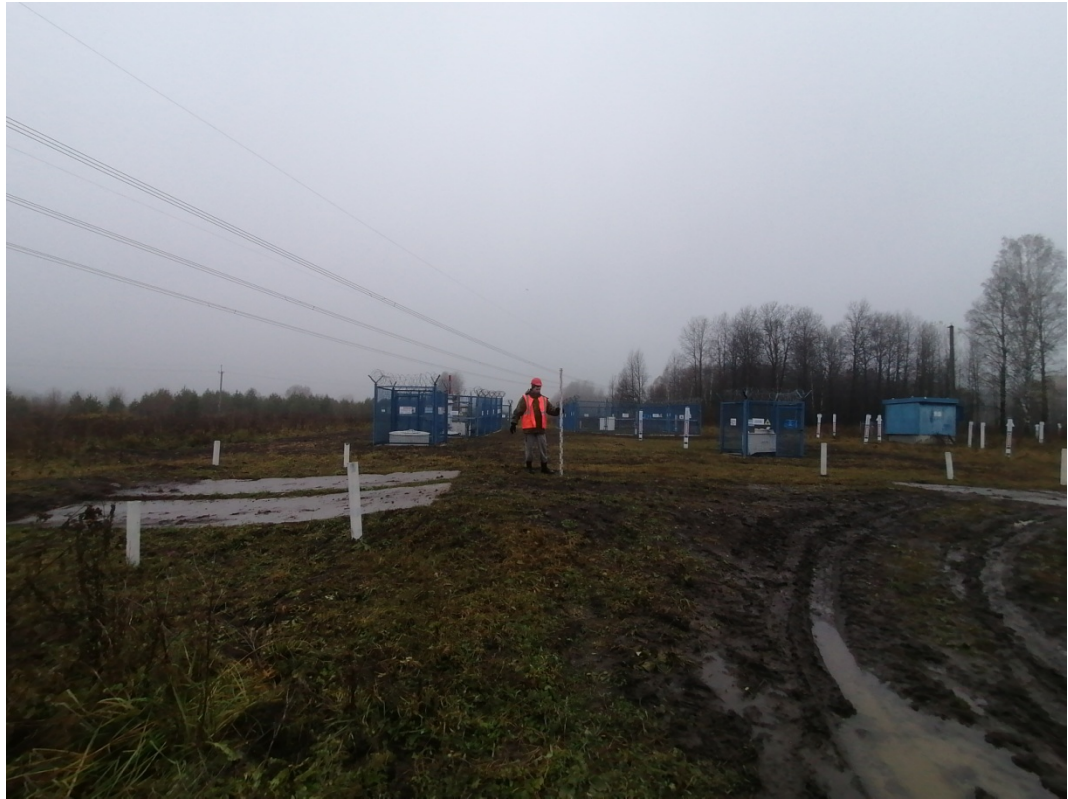
Рис.24. «МН Анжеро-Судженск-Красноярск, ДУ 1200мм, 0,0 - 68,216 км. Участок 51 км-54 км. Новосибирское РНУ. Реконструкция». ТФ №7. Вид участок №1. Снято с В.
