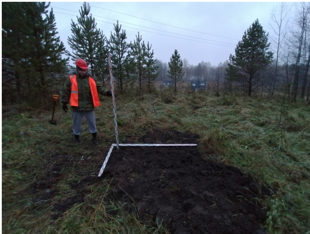
Рис.52. «МН Анжеро-Судженск-Красноярск, ДУ 1200мм, 0,0 - 68,216 км. Участок 51 км-54 км. Новосибирское РНУ. Реконструкция». Участок №1. Шурф №3. Рекультивация. Снято с Ю.
