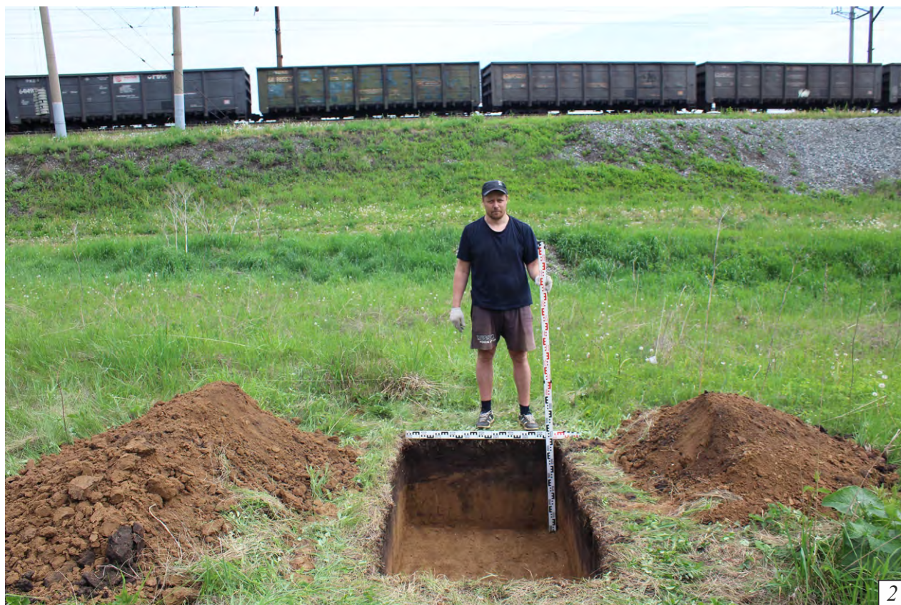
Рис. 26. Археологическое обследование земельного участка, подлежащего воздействию земельных, строительных, хозяйственных и иных работ для разработки раздела проектно-сметной документации по объекту «Тяговая подстанция Тырган» Западно-сибирской Ж. Д.» в Прокопьевском муниципальном округе Кемеровской области. Шурф №1: 1 - разметка; 2 - после выборки. Везде вид с юго-запада.
