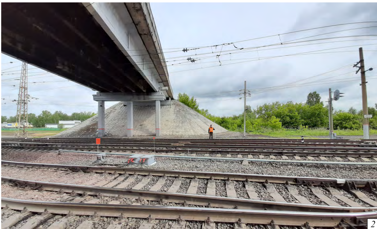
Рис. 53. Археологическое обследование земельного участка, подлежащего воздействию земельных, строительных, хозяйственных и иных работ для разработки раздела проектно-сметной документации по объекту «Тяговая подстанция Томусинская» Западно-сибирской Ж. Д.» в Мысковском городском округе Кемеровской области. Точка фотофиксации № 28. 1 - вид на ЮВ. 2 - вид на С.
