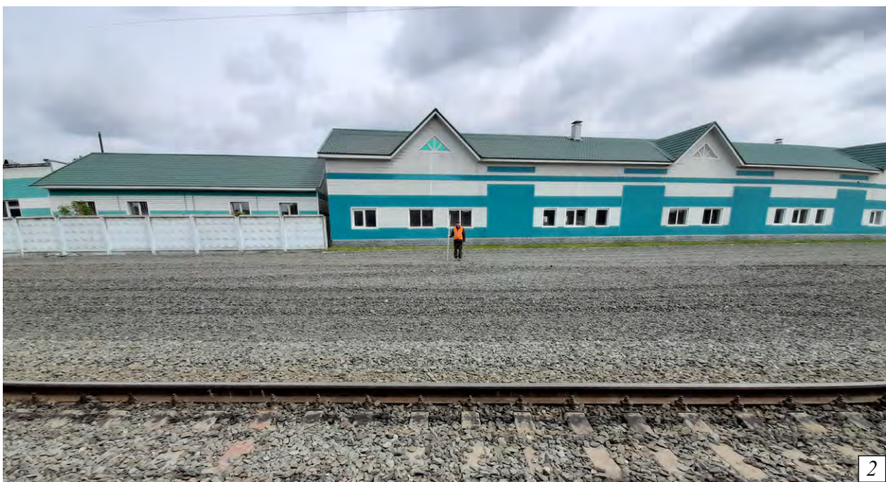
Рис. 52. Археологическое обследование земельного участка, подлежащего воздействию земельных, строительных, хозяйственных и иных работ для разработки раздела проектно-сметной документации по объекту «Тяговая подстанция Томусинская» Западно-сибирской Ж. Д.» в Мысковском городском округе Кемеровской области. Точка фотофиксации № 27. 1 - вид на ЮВ. 2 - вид на С.
