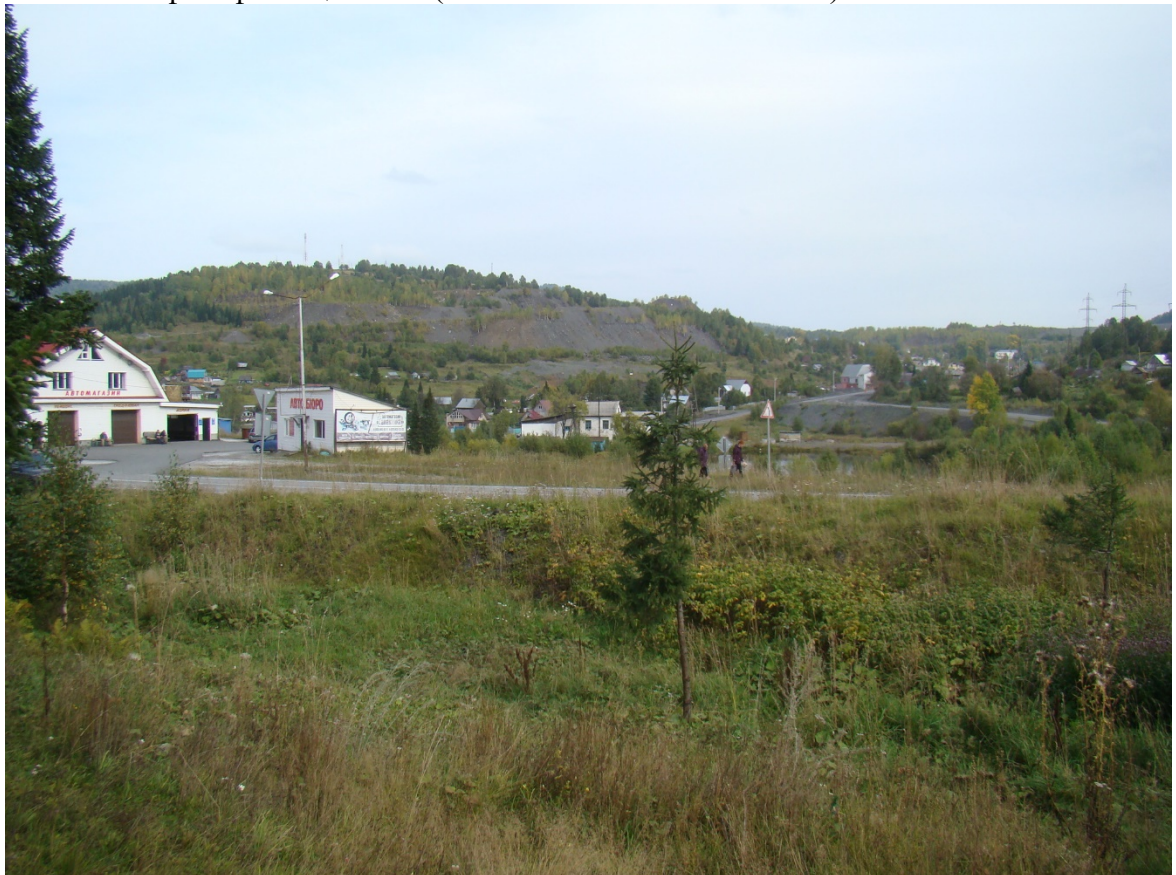
Рис. 16. Вскрытие и отработка запасов Шерегешевского месторождения. Точка фотофиксации № 3 ( 52^{\circ}55'9.01''\text{С} 87^{\circ}59'7.18''\text{В} ). Фото с ЮЗ.
