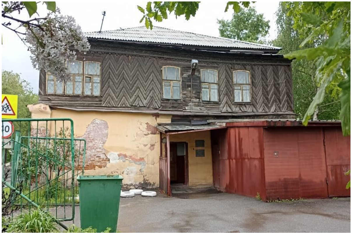
Фото 5. Общий вид Объекта с юго-восточной стороны.
