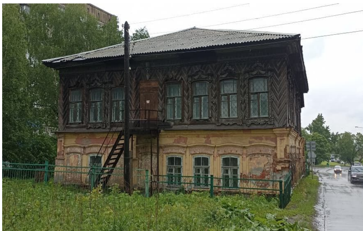
Фото 2. Общий вид Объекта с северо-западной стороны.
