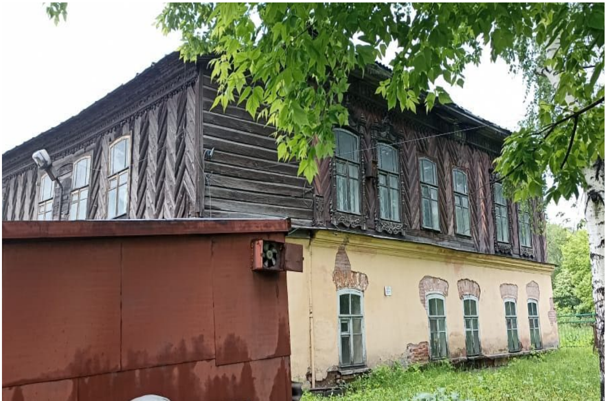
Фото 4. Общий вид Объекта с восточной стороны.
