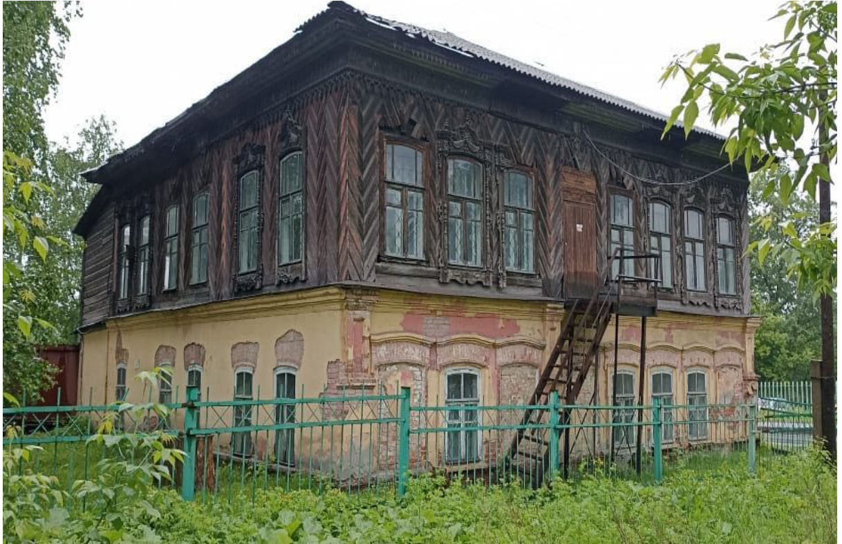
Фото 3. Общий вид Объекта с северной стороны.
