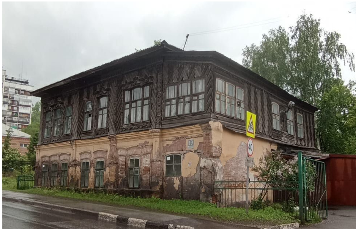
Фото 6. Общий вид Объекта с южной стороны.
