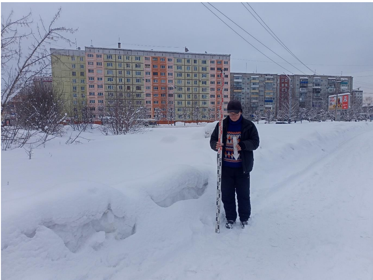
Рис. 29. «Строительство многоквартирных жилых домов ...». Точка фотофиксации №4 ( 53^{\circ}41'48.49''\text{C} , 88^{\circ}2'56.08''\text{В} ). Фото с С.
