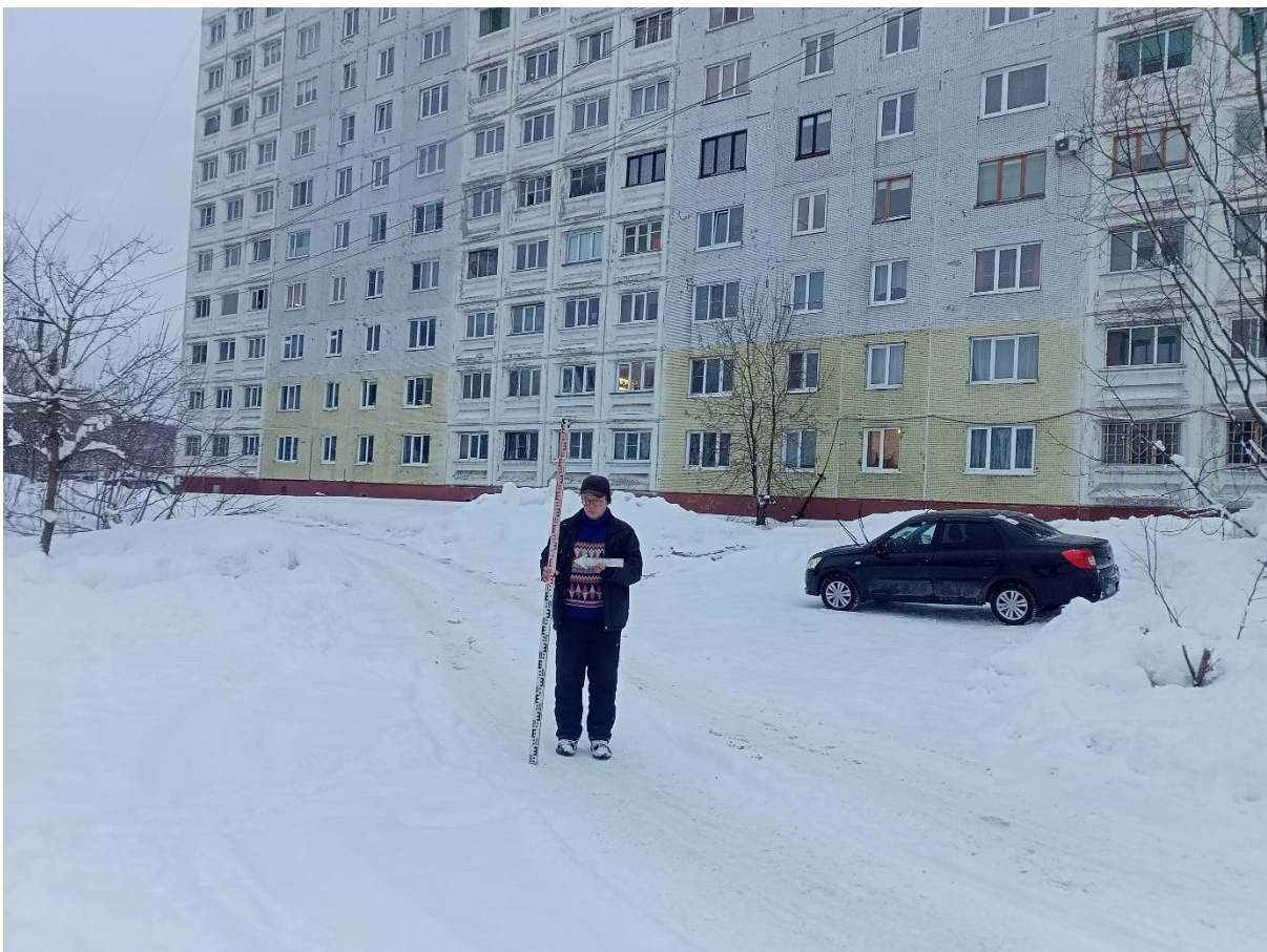
Рис. 53. «Строительство многоквартирных жилых домов ...». Точка фотофиксации №10 ( 53^{\circ}41'48.80''\text{С} , 88^{\circ}3'0.81''\text{В} ). Фото с З.
