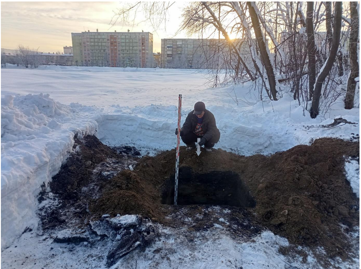
Рис. 67. «Строительство многоквартирных жилых домов ...». Шурф №2 после выборки и снятия теплого павильона. Фото с С.
