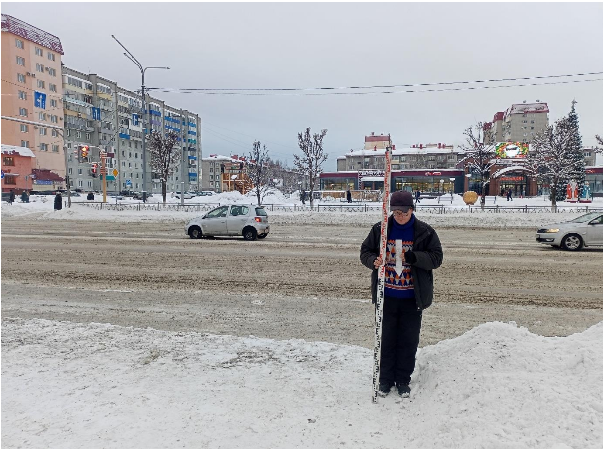
Рис. 21. «Строительство многоквартирных жилых домов ...». Точка фотофиксации №2 ( 53^{\circ}41'44.92''\text{C} , 88^{\circ}2'59.89''\text{B} ). Фото с С.
