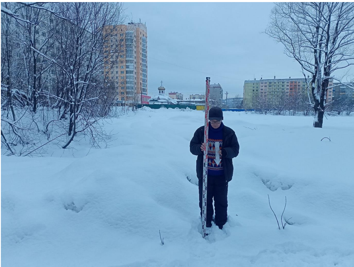
Рис. 46. «Строительство многоквартирных жилых домов ...». Точка фотофиксации №9 ( 53^{\circ}41'51.29''\text{С} , 88^{\circ}3'1.40''\text{В} ). Фото с С.
