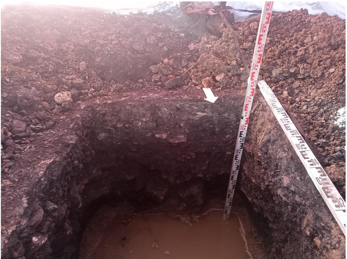
Рис. 58. «Строительство многоквартирных жилых домов ...». Шурф №1 после выборки. Фото с С.
