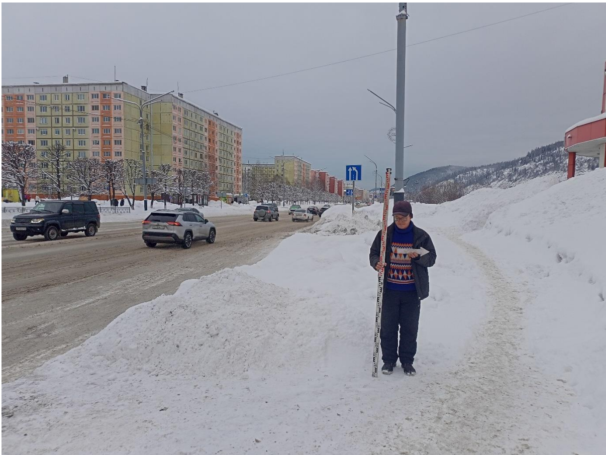
Рис. 18. «Строительство многоквартирных жилых домов ...». Точка фотофиксации №2 ( 53^{\circ}41'44.92''\text{C} , 88^{\circ}2'59.89''\text{В} ). Фото с В.
