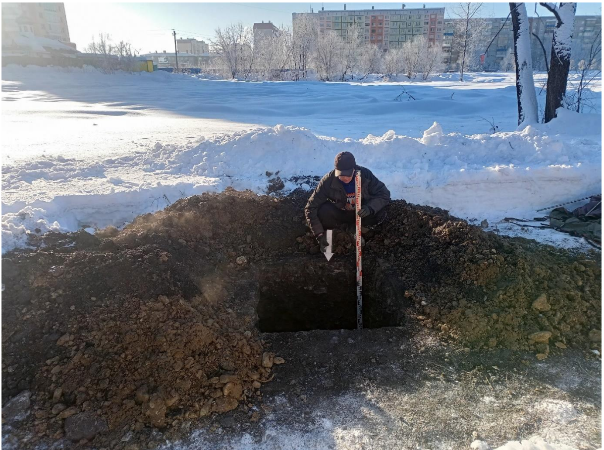
Рис. 59. «Строительство многоквартирных жилых домов ...». Шурф №1 после выборки и снятия теплого павильона. Фото с С.
