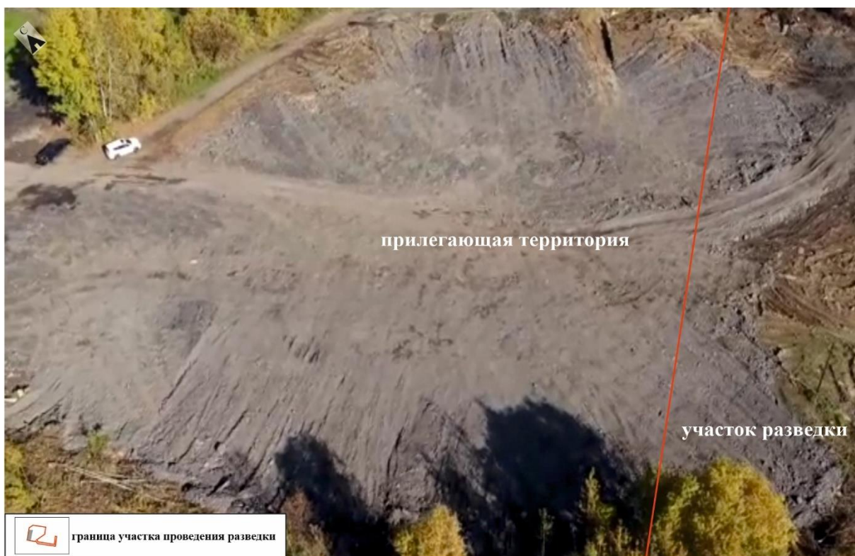
Рис. 11. «Строительство многоквартирных жилых домов ...». Общий вид участка исследования и прилегающей территории. Съемка с БПЛА, сентябрь 2023 г. Фото с ЮВ.
