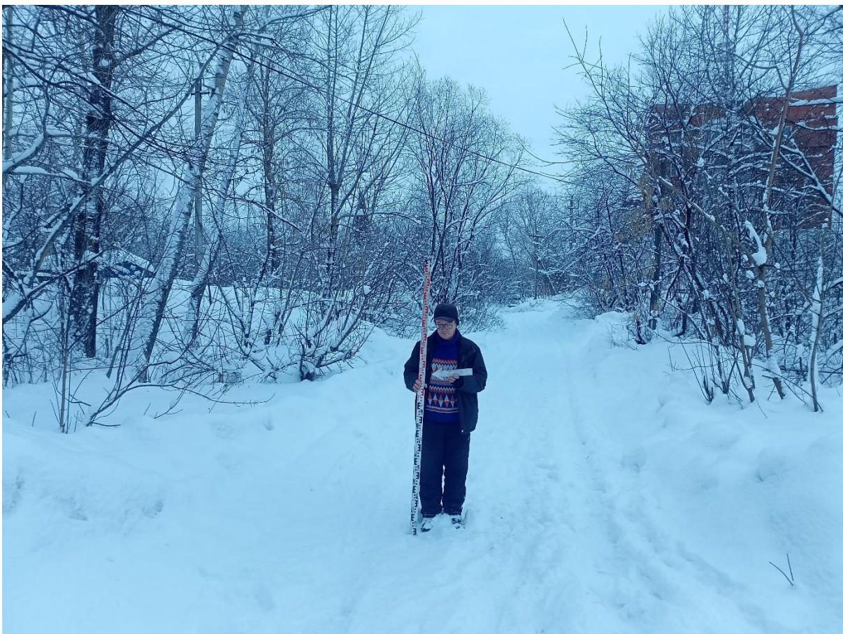
Рис. 49. «Строительство многоквартирных жилых домов ...». Точка фотофиксации №9 ( 53^{\circ}41'51.29''\text{C} , 88^{\circ}3'1.40''\text{B} ). Фото с З.
