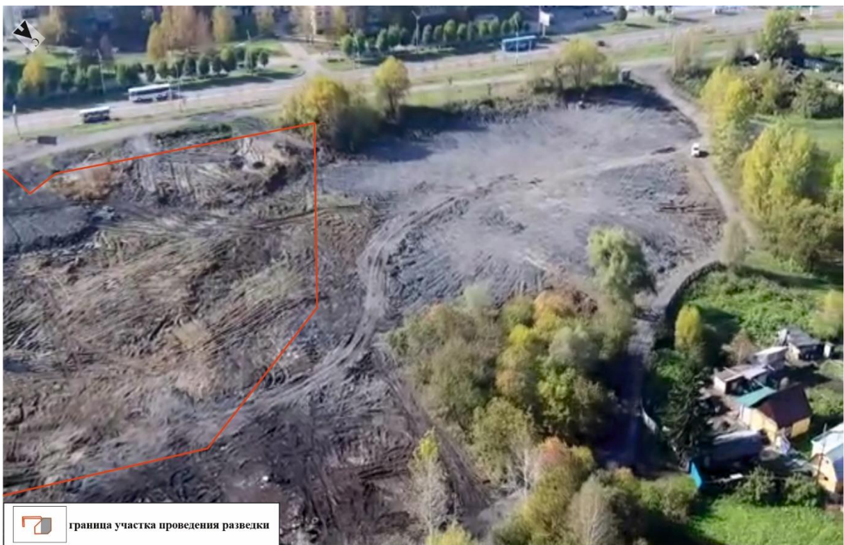
Рис. 9. «Строительство многоквартирных жилых домов ...». Общий вид участка исследования и прилегающей территории. Съемка с БПЛА, сентябрь 2023 г. Фото с СВ.
