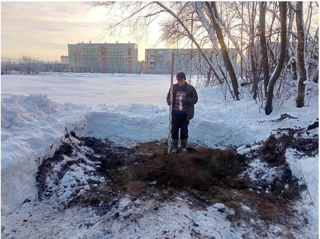
Рис. 69. «Строительство многоквартирных жилых домов ...». Шурф №2. Рекультивация. Фото с С.
