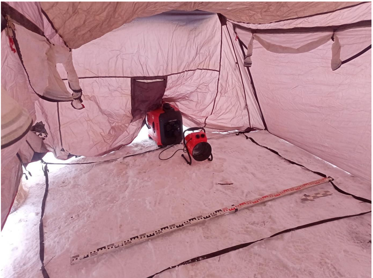
Рис. 57. «Строительство многоквартирных жилых домов ...». Шурф №1. Процесс отопления павильона и прогрева грунта. Фото с СЗ.
