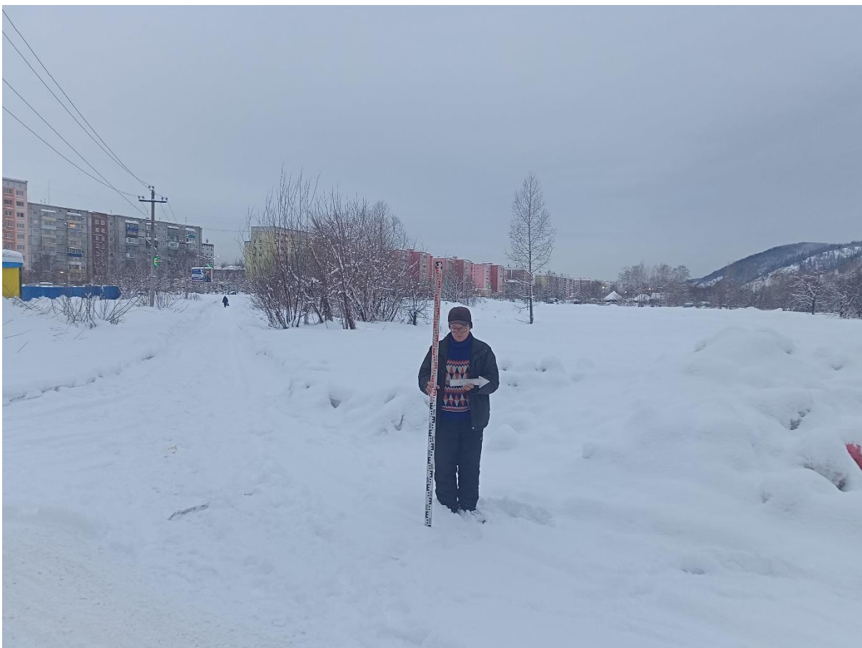
Рис. 51. «Строительство многоквартирных жилых домов ...». Точка фотофиксации №10 ( 53^{\circ}41'48.80''\text{С} , 88^{\circ}3'0.81''\text{В} ). Фото с В.
