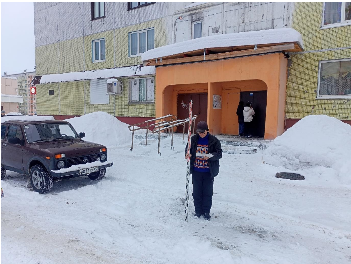
Рис. 17. «Строительство многоквартирных жилых домов ...». Точка фотофиксации №1 ( 53^{\circ}41'47.82''\text{С} , 88^{\circ}3'2.05''\text{В} ). Фото с З.
