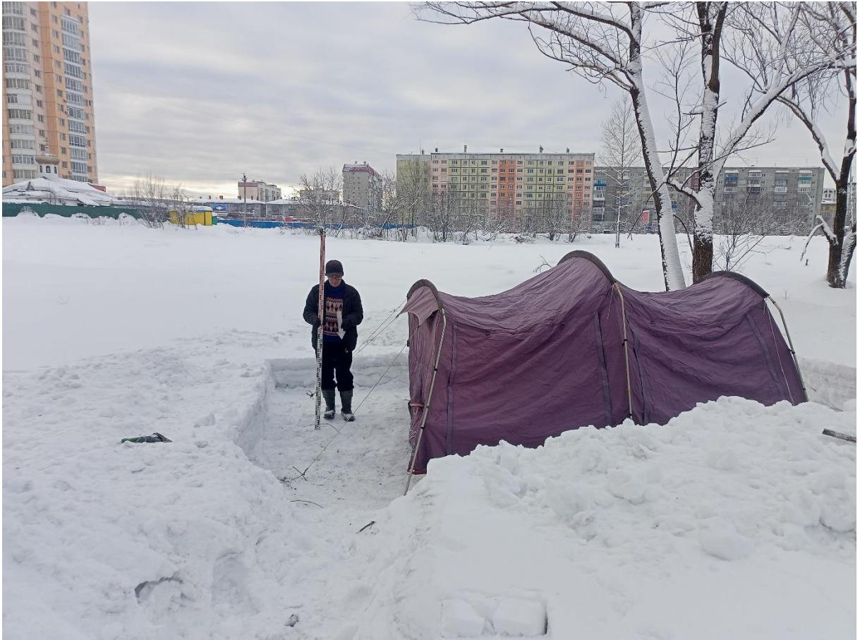
Рис. 56. «Строительство многоквартирных жилых домов ...». Шурф №1. Теплый павильон после установки. Фото с С.
