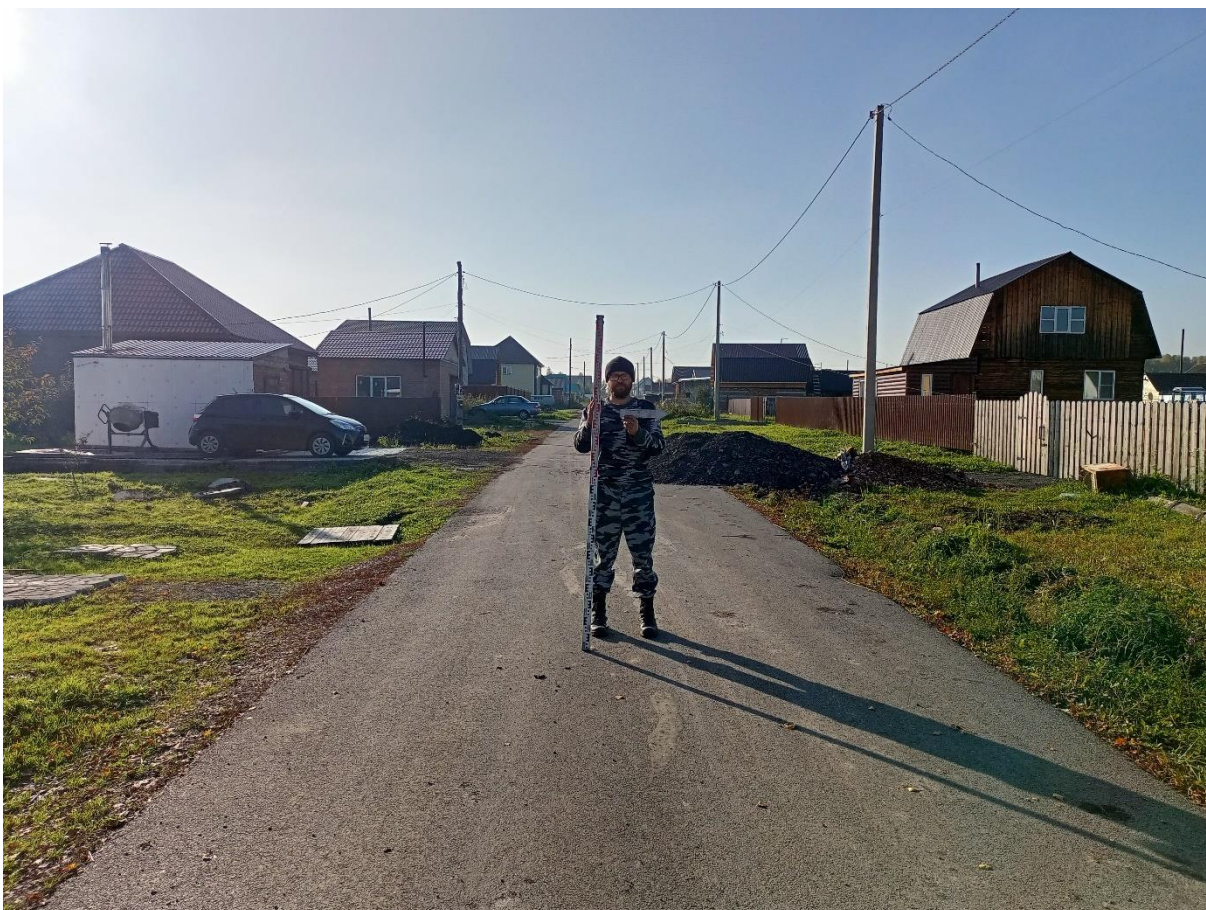
Рис. 37. «Строительство канализационной и тепловой сетей п. Новосафоновский». Точка фотофиксации №5 ( 53^{\circ}51'16.99''\text{С} , 86^{\circ}36'7.21''\text{В} ). Фото с В.
