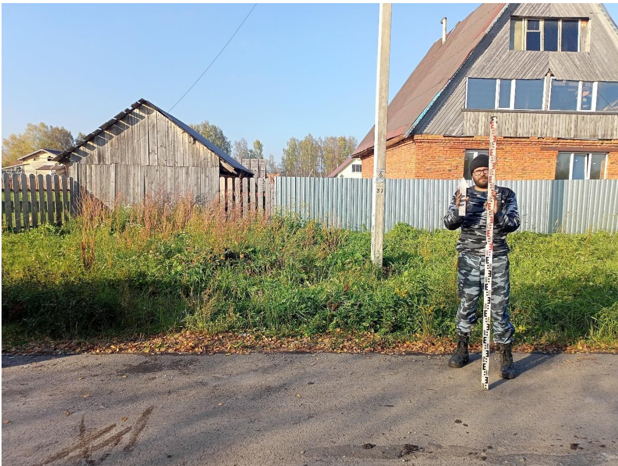
Рис. 34. «Строительство канализационной и тепловой сетей п. Новосафоновский». Точка фотофиксации №5 ( 53^{\circ}51'16.99''\text{С} , 86^{\circ}36'7.21''\text{В} ). Фото с Ю.
