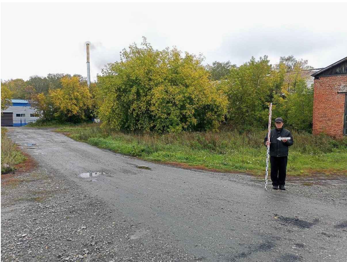
Рис. 167. «Строительство тепловой сети п. Трудармейский». Точка фотофиксации №29 ( 54^{\circ} 7'33.03''\text{С} , 86^{\circ}25'0.34''\text{В} ). Фото с З.
