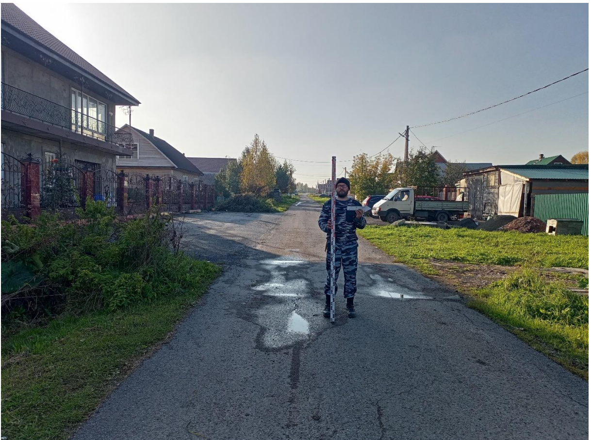
Рис. 49. «Строительство канализационной и тепловой сетей п. Новосафоновский». Точка фотофиксации №8 ( 53^{\circ}51'20.66''\text{С} , 86^{\circ}36'2.76''\text{В} ). Фото с В.
