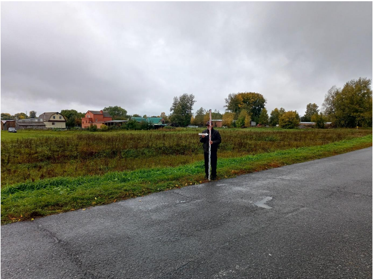
Рис. 135. «Строительство тепловой сети п. Трудармейский». Точка фотофиксации №21 ( 54^{\circ} 7'11.29''\text{С} , 86^{\circ}25'0.04''\text{В} ). Фото с В.
