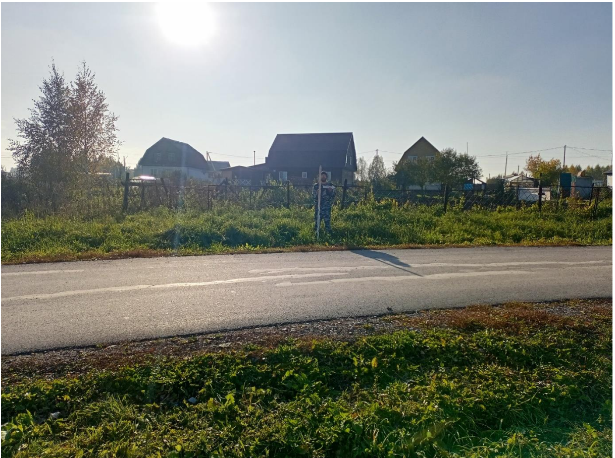
Рис. 41. «Строительство канализационной и тепловой сетей п. Новосафоновский». Точка фотофиксации №6 ( 53^{\circ}51'18.27''\text{C} , 86^{\circ}35'47.14''\text{В} ). Фото с В.
