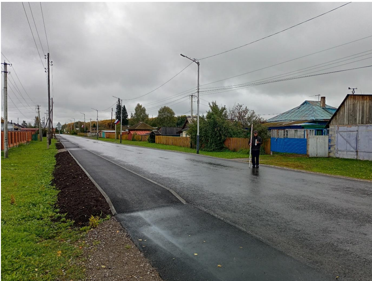
Рис. 164. «Строительство тепловой сети п. Трудармейский». Точка фотофиксации №28 ( 54^{\circ} 7'31.34''\text{С} , 86^{\circ}24'56.70''\text{В} ). Фото с С.
