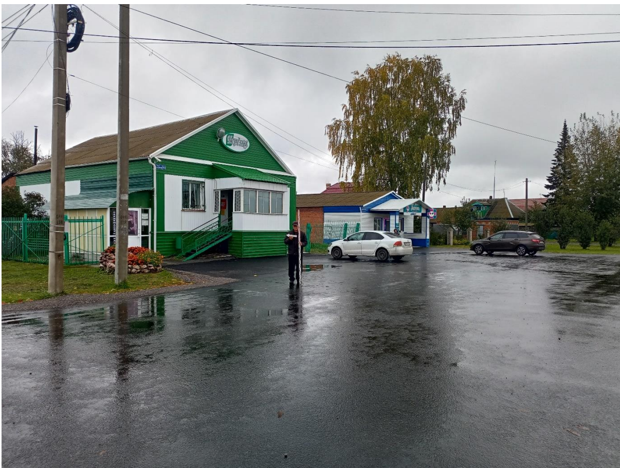
Рис. 139. «Строительство тепловой сети п. Трудармейский». Точка фотофиксации №22 ( 54^{\circ} 7'42.85''\text{С} , 86^{\circ}24'18.30''\text{В} ). Фото с З.
