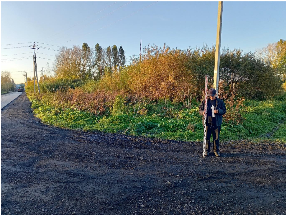
Рис. 66. «Строительство канализационной и тепловой сетей п. Новосафоновский». Точка фотофиксации №13 ( 53^{\circ}50'43.42''\text{С} , 86^{\circ}36'7.85''\text{В} ). Фото с Ю.
