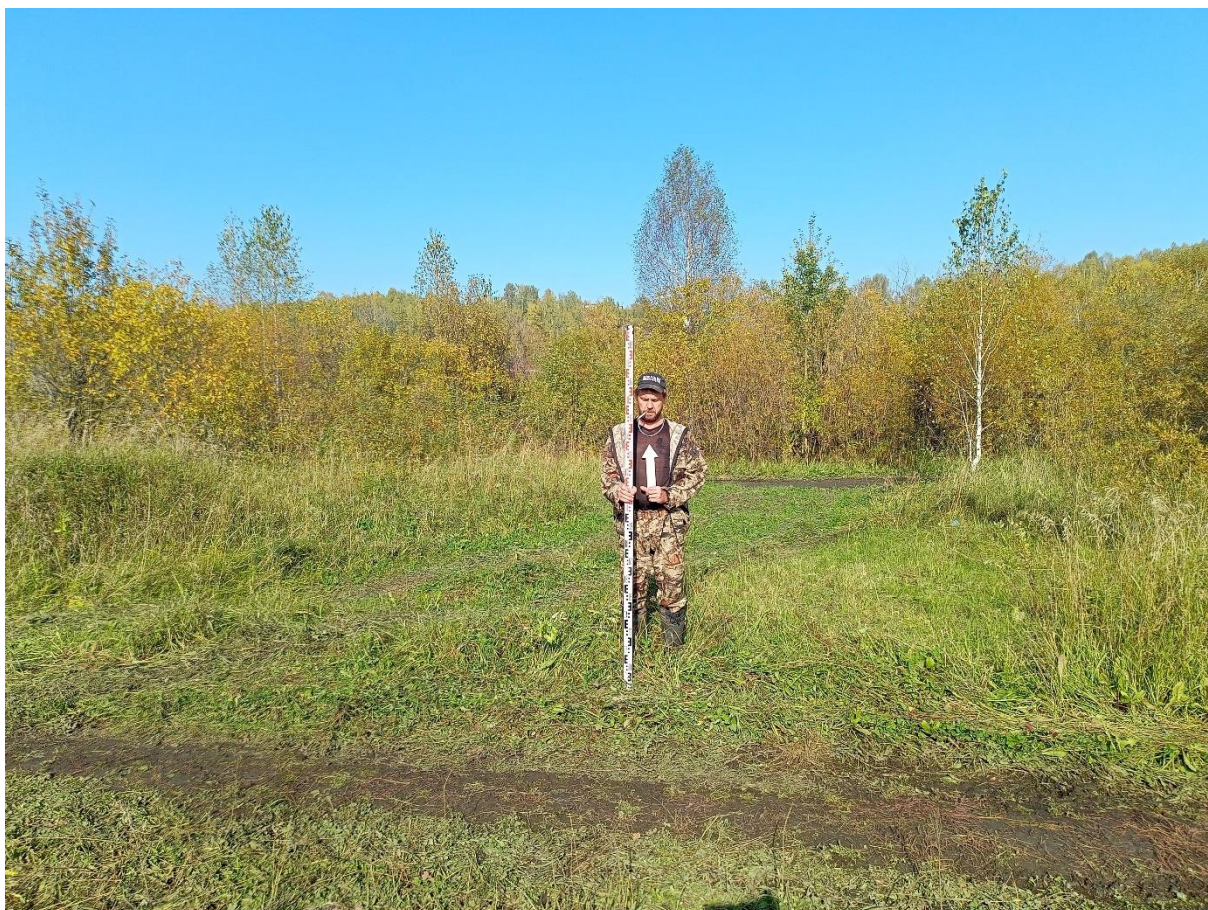
Рис. 23. «Строительство канализационной и тепловой сетей п. Новосафоновский». Точка фотофиксации №2 ( 53^{\circ}51'14.34''\text{C} , 86^{\circ}36'26.98''\text{В} ). Фото с Ю.
