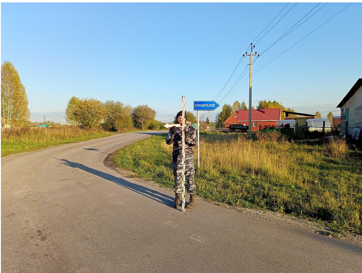
Рис. 59. «Строительство канализационной и тепловой сетей п. Новосафоновский». Точка фотофиксации №11 ( 53^{\circ}51'24.55''\text{C} , 86^{\circ}35'23.85''\text{В} ). Фото с З.
