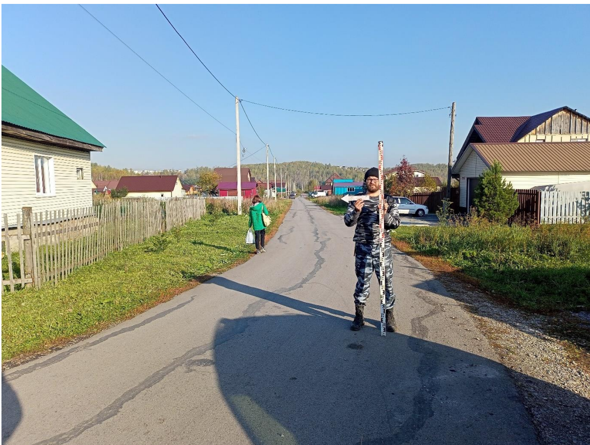
Рис. 39. «Строительство канализационной и тепловой сетей п. Новосафоновский». Точка фотофиксации №6 ( 53^{\circ}51'18.27''\text{С} , 86^{\circ}35'47.14''\text{В} ). Фото с З.
