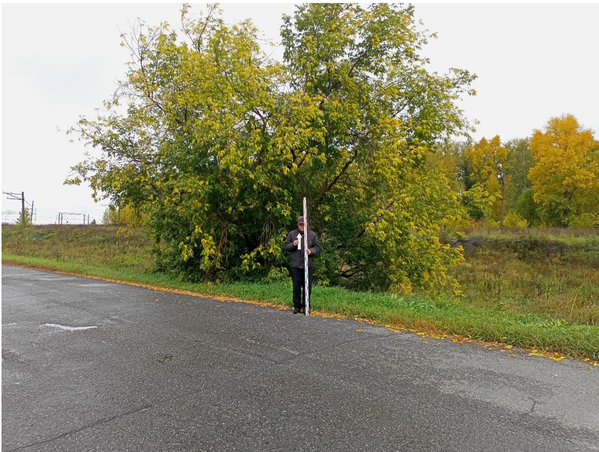
Рис. 136. «Строительство тепловой сети п. Трудармейский». Точка фотофиксации №21 ( 54^{\circ} 7'11.29''\text{С} , 86^{\circ}25'0.04''\text{В} ). Фото с Ю.
