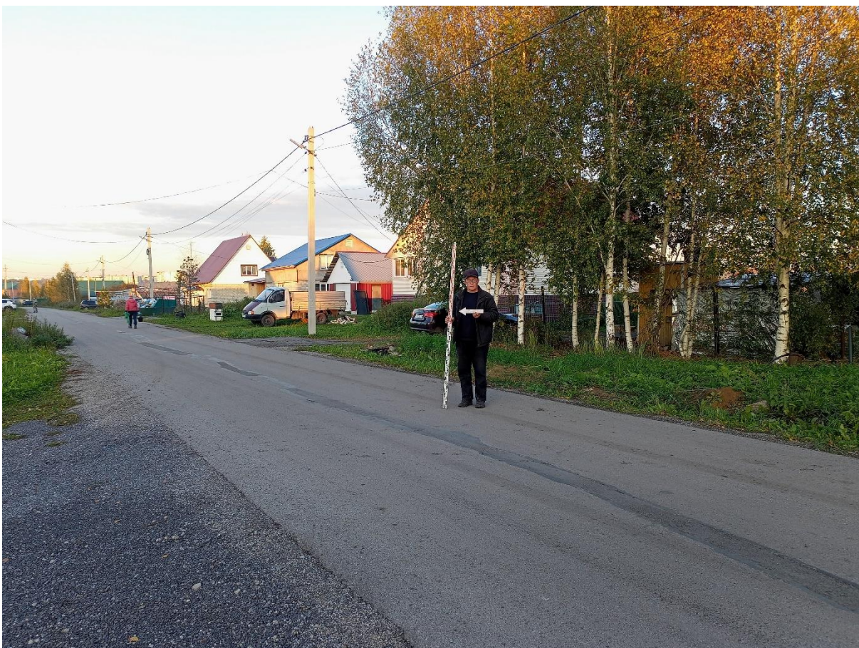
Рис. 79. «Строительство канализационной и тепловой сетей п. Новосафоновский». Точка фотофиксации №16 ( 53^{\circ}51'13.65''\text{С} , 86^{\circ}35'24.31''\text{В} ). Фото с З.
