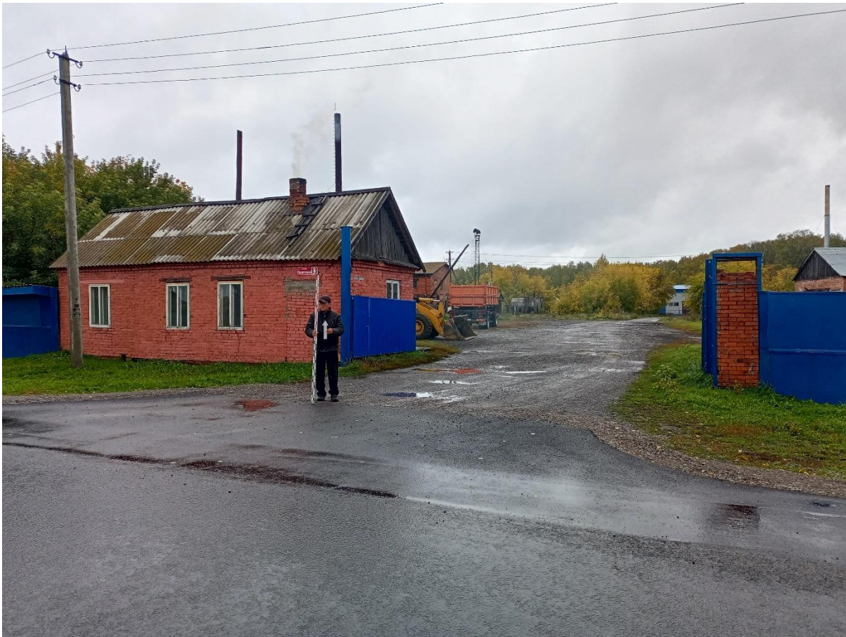
Рис. 162. «Строительство тепловой сети п. Трудармейский». Точка фотофиксации №28 ( 54^{\circ} 7'31.34''\text{C} , 86^{\circ}24'56.70''\text{B} ). Фото с Ю.
