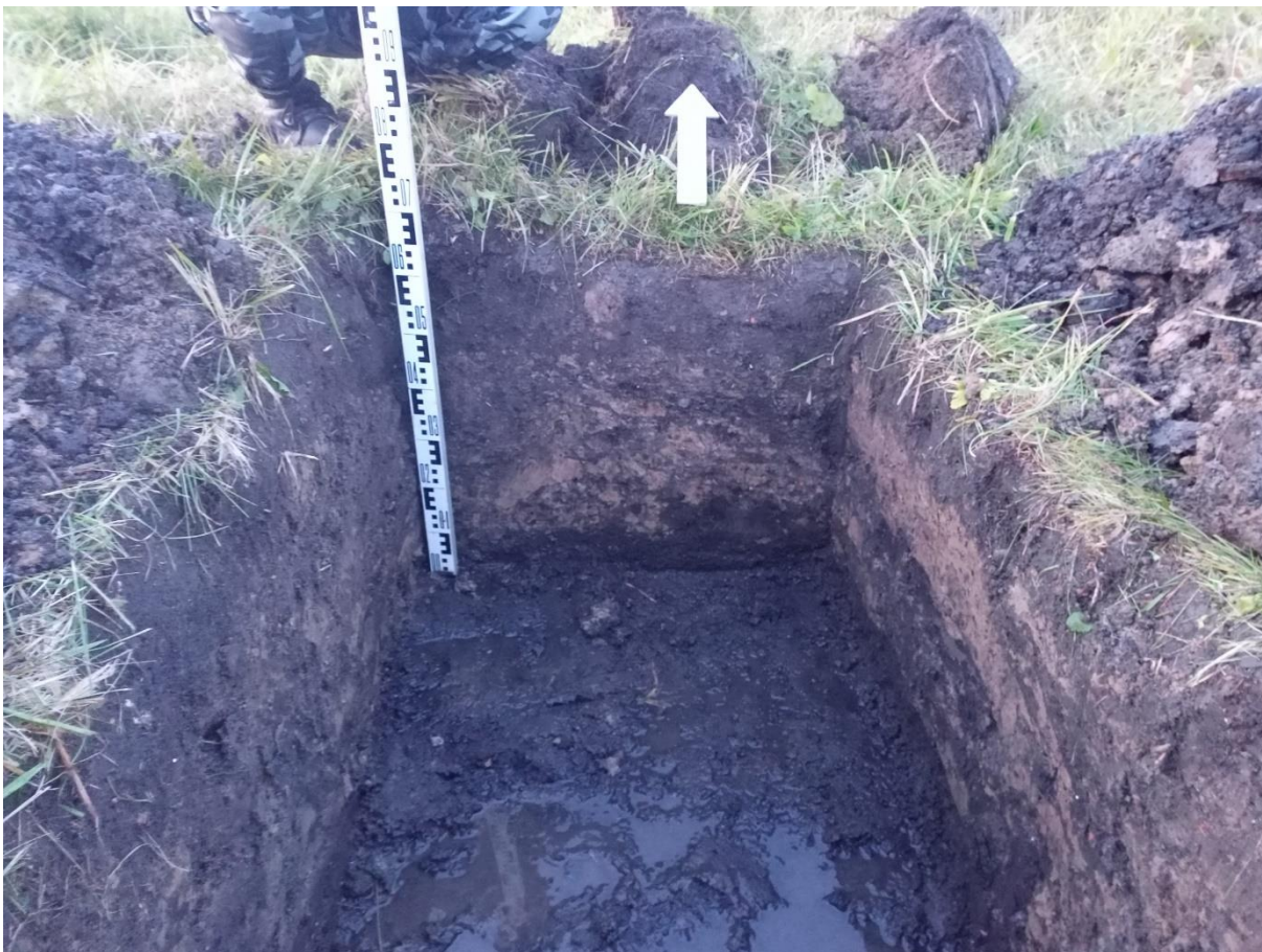
Рис. 116. «Строительство канализационной и тепловой сетей п. Новосафоновский». Шурф №7. Профиль северной стенки. Фото с Ю.
