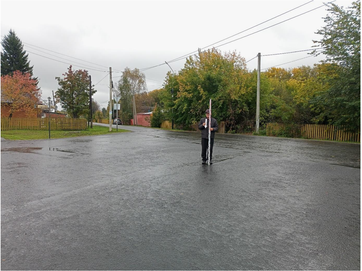
Рис. 154. «Строительство тепловой сети п. Трудармейский». Точка фотофиксации №26 ( 54^{\circ} 7'20.60''\text{С} , 86^{\circ}25'3.95''\text{В} ). Фото с С.
