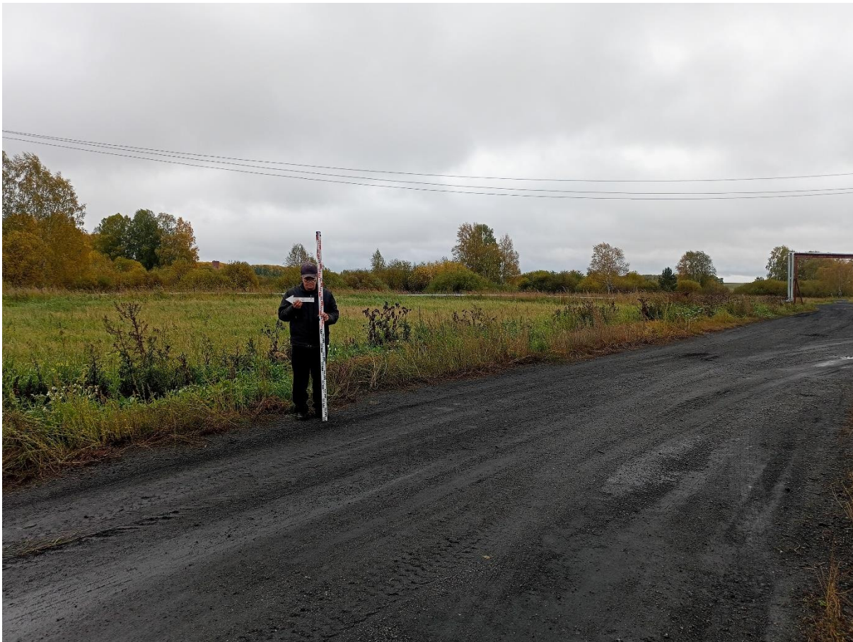
Рис. 130. «Строительство тепловой сети п. Трудармейский». Точка фотофиксации №20 ( 54^{\circ} 7'1.39''\text{C} , 86^{\circ}24'46.71''\text{B} ). Фото с З.
