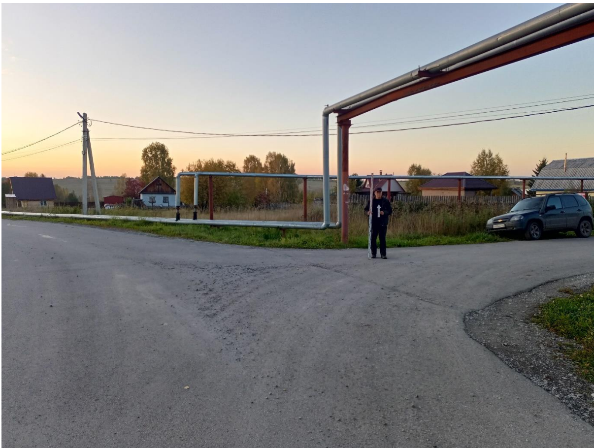
Рис. 86. «Строительство канализационной и тепловой сетей п. Новосафоновский». Точка фотофиксации №18 ( 53^{\circ}50'57.75''\text{С} , 86^{\circ}34'57.56''\text{В} ). Фото с Ю.
