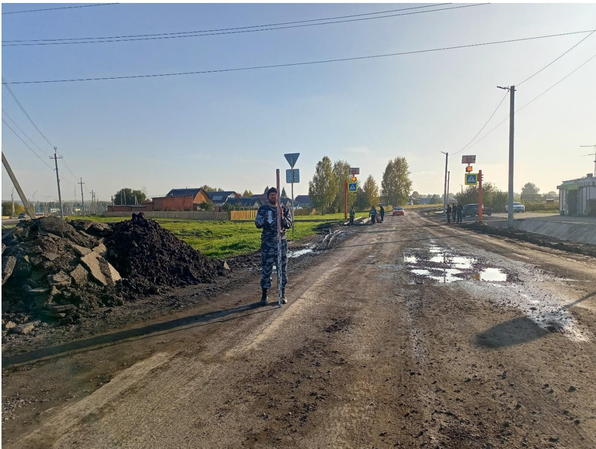
Рис. 52. «Строительство канализационной и тепловой сетей п. Новосафоновский». Точка фотофиксации №9 ( 53^{\circ}51'20.94''\text{C} , 86^{\circ}35'39.37''\text{В} ). Фото с С.
