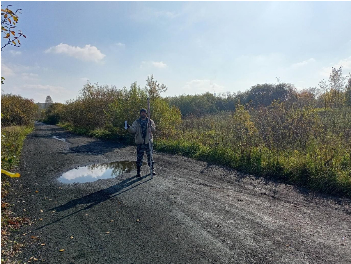
Рис. 20. «Строительство канализационной и тепловой сетей п. Новосафоновский». Точка фотофиксации №1 ( 53^{\circ}51'11.94''\text{C} , 86^{\circ}36'31.57''\text{B} ). Фото с С.
