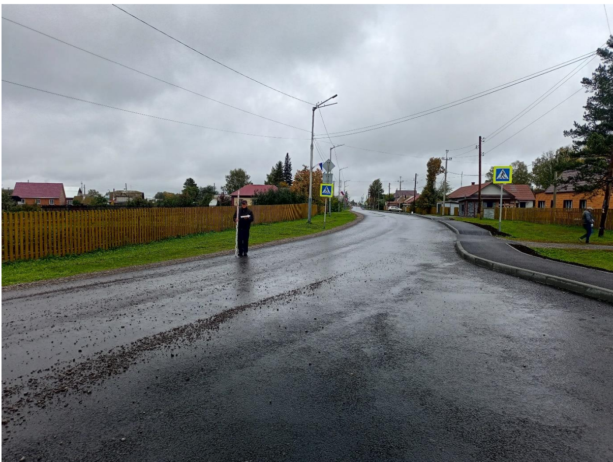
Рис. 161. «Строительство тепловой сети п. Трудармейский». Точка фотофиксации №27 ( 54^{\circ} 7'23.25''\text{С} , 86^{\circ}25'5.34''\text{В} ). Фото с В.
