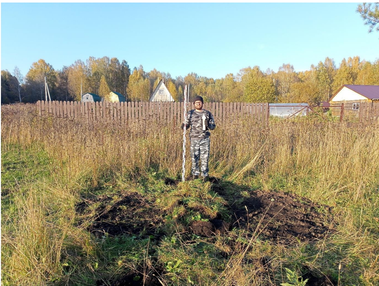
Рис. 109. «Строительство канализационной и тепловой сетей п. Новосафоновский». Шурф №5. Рекультивация. Фото с Ю.
