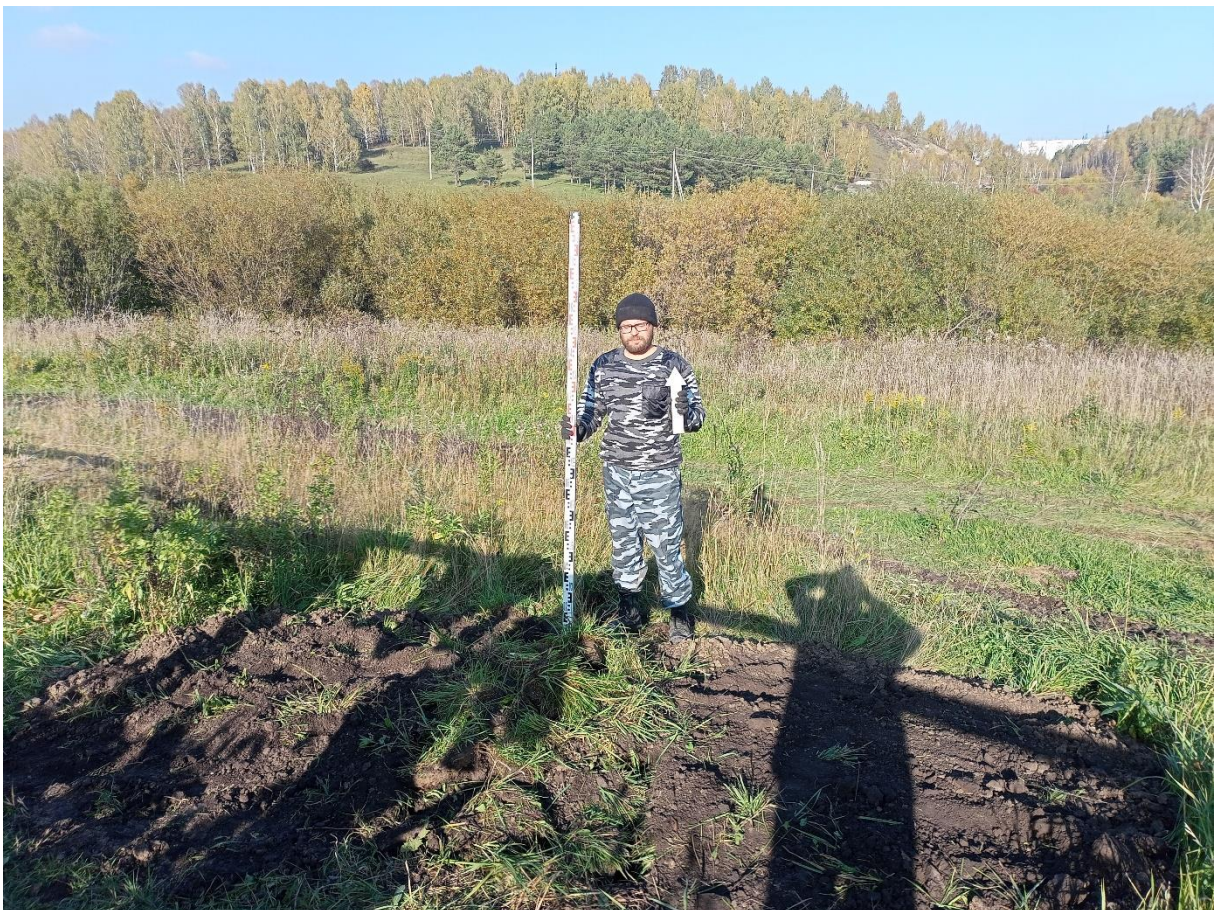
Рис. 105. «Строительство канализационной и тепловой сетей п. Новосафоновский». Шурф №4. Рекультивация. Фото с Ю.
