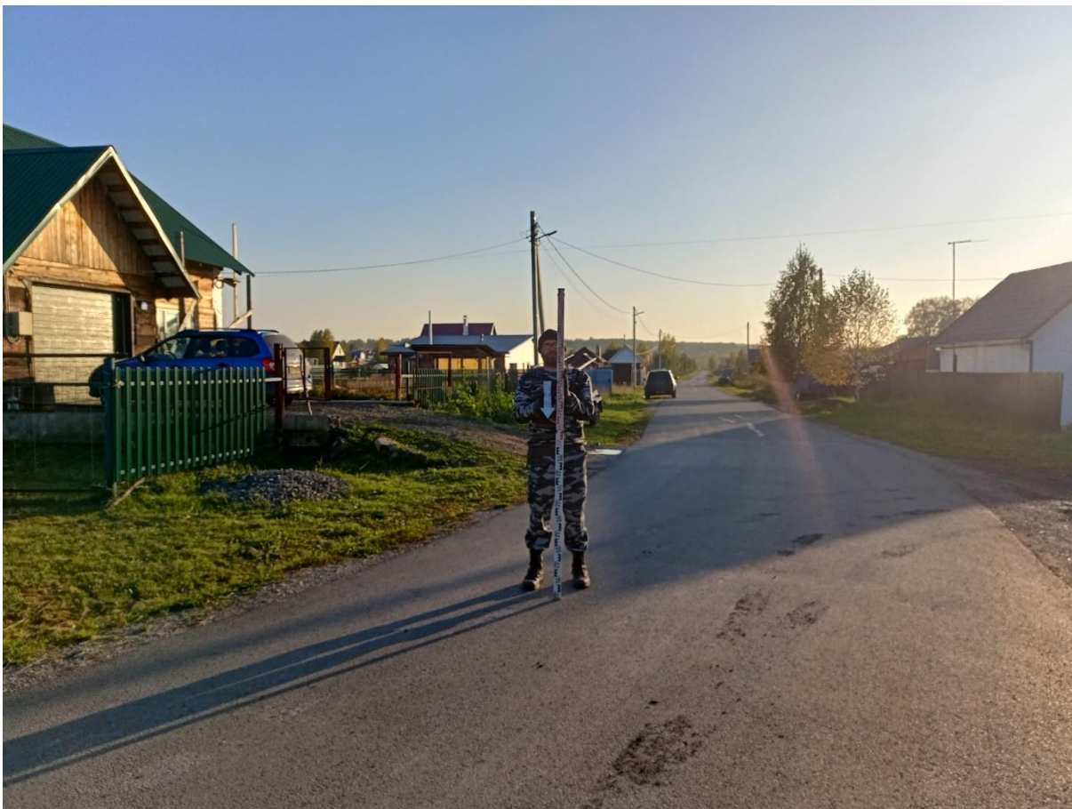
Рис. 60. «Строительство канализационной и тепловой сетей п. Новосафоновский». Точка фотофиксации №11 ( 53^{\circ}51'24.55''\text{С} , 86^{\circ}35'23.85''\text{В} ). Фото с С.
