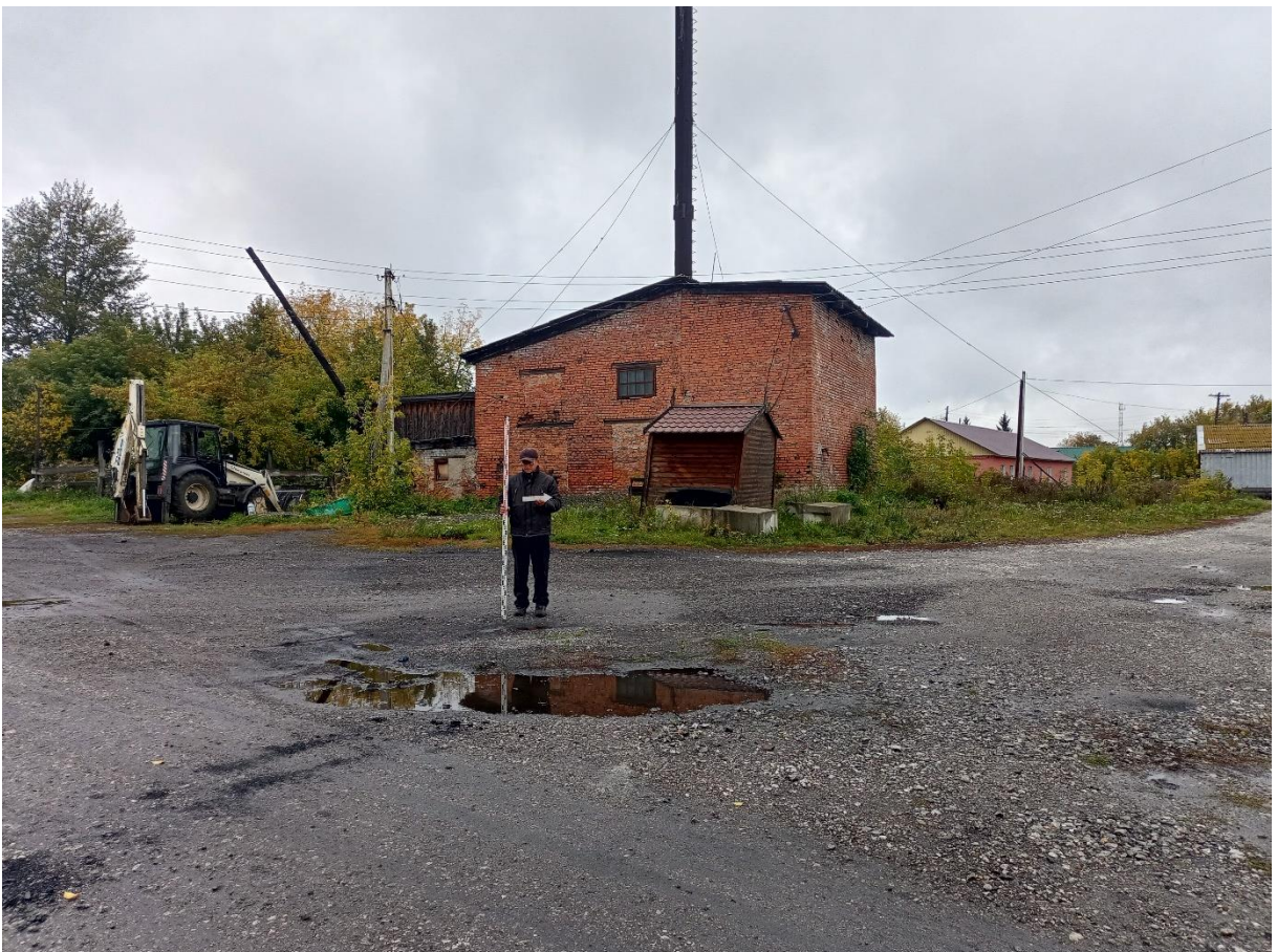
Рис. 169. «Строительство тепловой сети п. Трудармейский». Точка фотофиксации №29 ( 54^{\circ} 7'33.03''\text{С} , 86^{\circ}25'0.34''\text{В} ). Фото с В.
