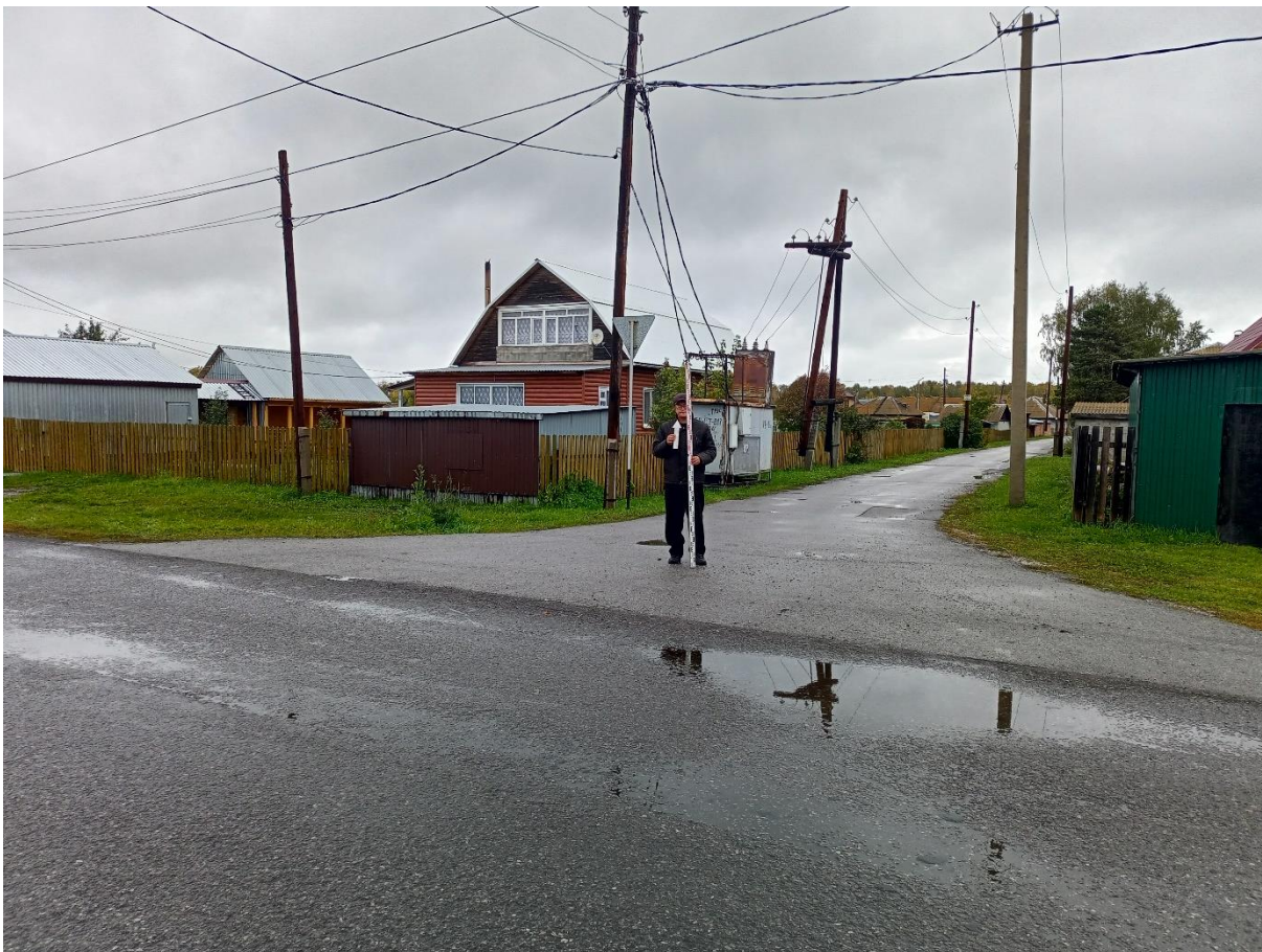
Рис. 150. «Строительство тепловой сети п. Трудармейский». Точка фотофиксации №25 ( 54^{\circ} 7'24.35''\text{С} , 86^{\circ}24'55.17''\text{В} ). Фото с Ю.
