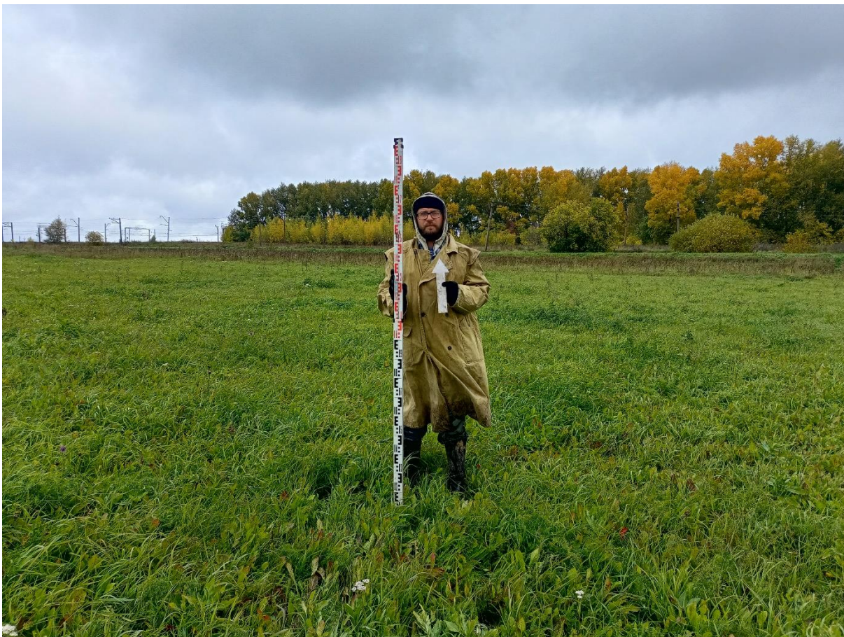
Рис. 178. «Строительство тепловой сети п. Трудармейский». Шурф №10 ( 54^{\circ} 7'9.00''\text{С} , 86^{\circ}24'58.11''\text{В} ). Место закладки. Фото с Ю.
