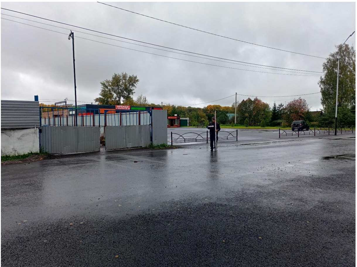
Рис. 145. «Строительство тепловой сети п. Трудармейский». Точка фотофиксации №23 ( 54^{\circ} 7'37.21''\text{С} , 86^{\circ}24'30.34''\text{В} ). Фото с в.
