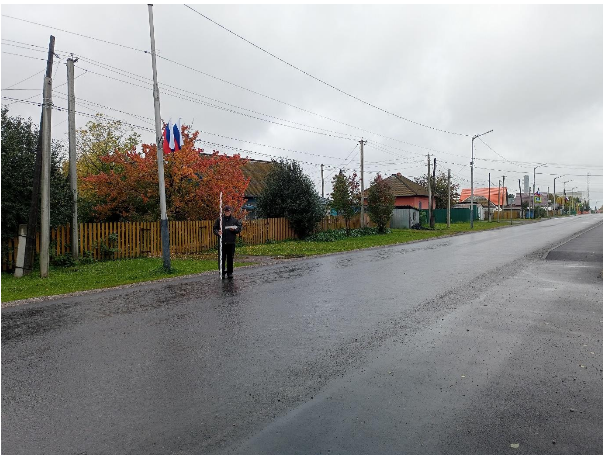
Рис. 165. «Строительство тепловой сети п. Трудармейский». Точка фотофиксации №28 ( 54^{\circ} 7'31.34''\text{С} , 86^{\circ}24'56.70''\text{В} ). Фото с В.
