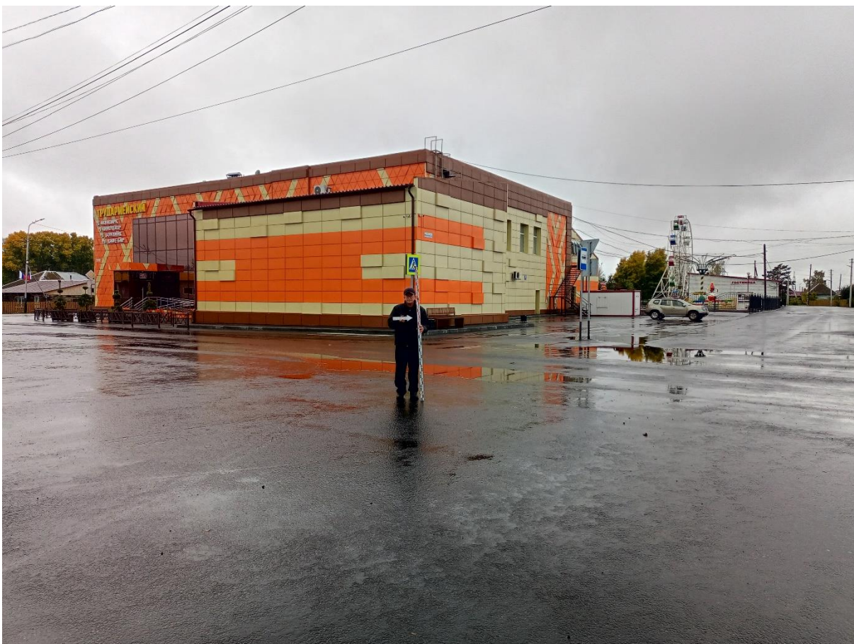
Рис. 141. «Строительство тепловой сети п. Трудармейский». Точка фотофиксации №22 ( 54^{\circ} 7'42.85''\text{С} , 86^{\circ}24'18.30''\text{В} ). Фото с В.
