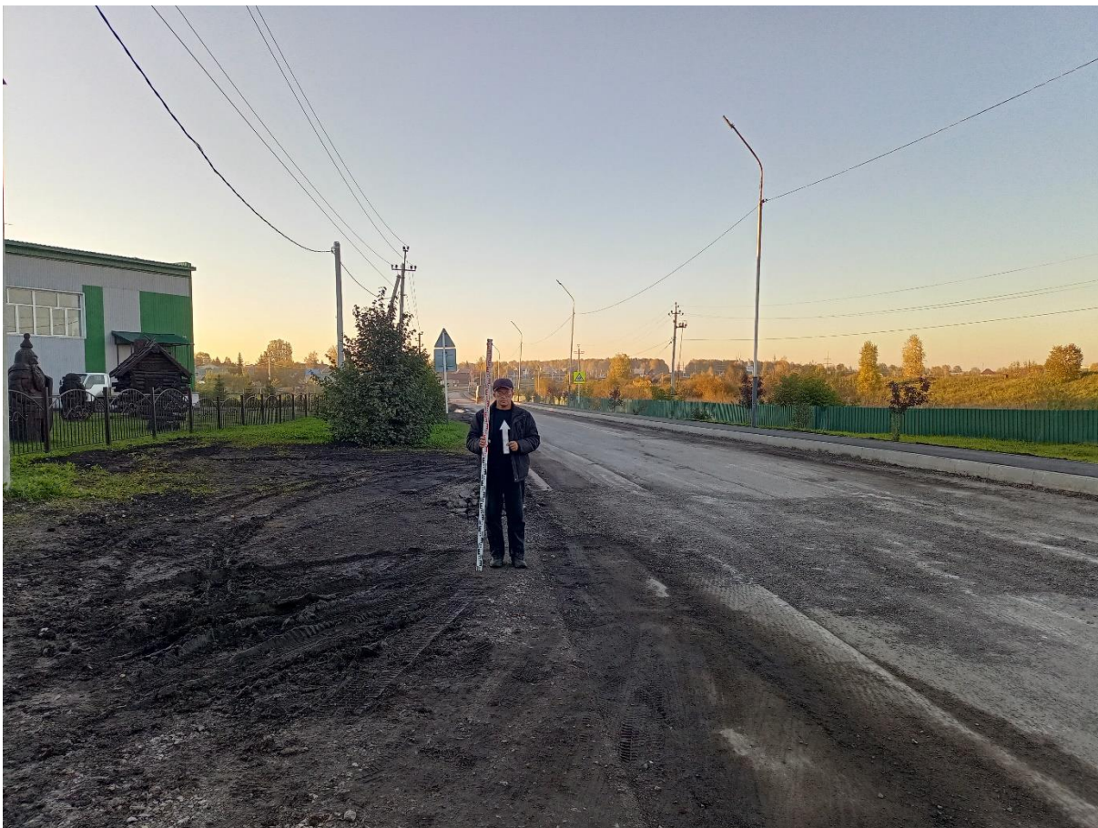
Рис. 70. «Строительство канализационной и тепловой сетей п. Новосафоновский». Точка фотофиксации №14 ( 53^{\circ}50'51.53''\text{С} , 86^{\circ}35'54.25''\text{В} ). Фото с Ю.
