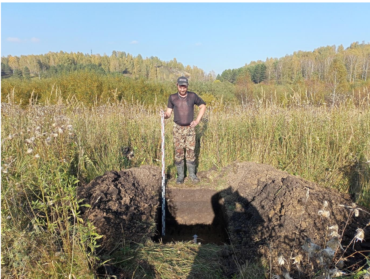
Рис. 99. «Строительство канализационной и тепловой сетей п. Новосафоновский». Шурф №3 после выборки. Фото с Ю.
