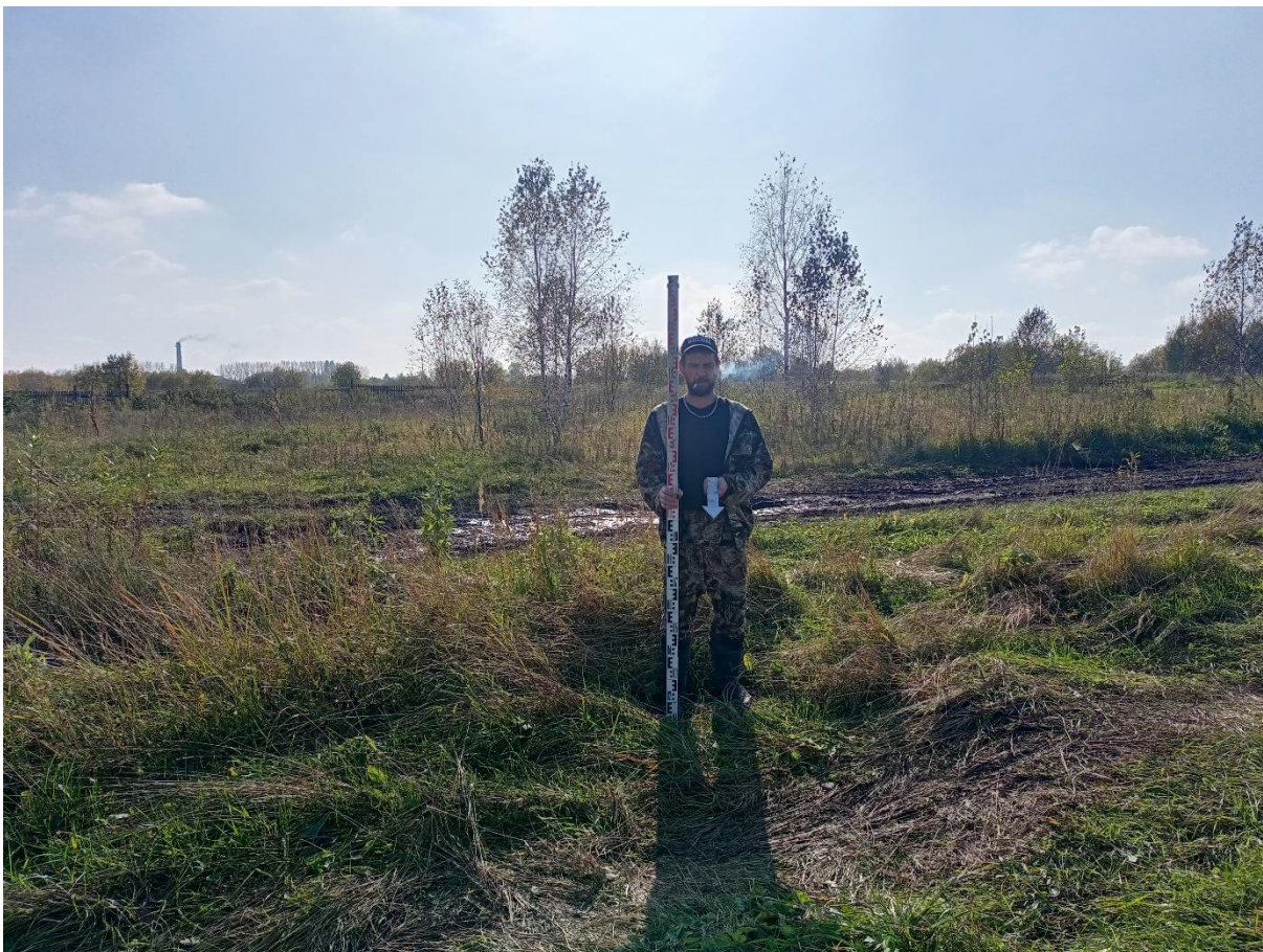
Рис. 28. «Строительство канализационной и тепловой сетей п. Новосафоновский». Точка фотофиксации №3 ( 53^{\circ}51'16.05''\text{C} , 86^{\circ}36'23.51''\text{В} ). Фото с С.
