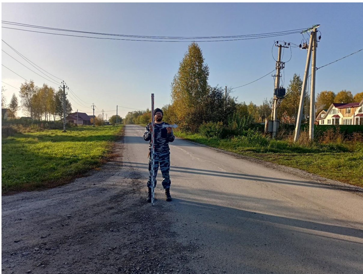
Рис. 55. «Строительство канализационной и тепловой сетей п. Новосафоновский». Точка фотофиксации №10 ( 53^{\circ}51'21.85''\text{С} , 86^{\circ}35'35.65''\text{В} ). Фото с В.
