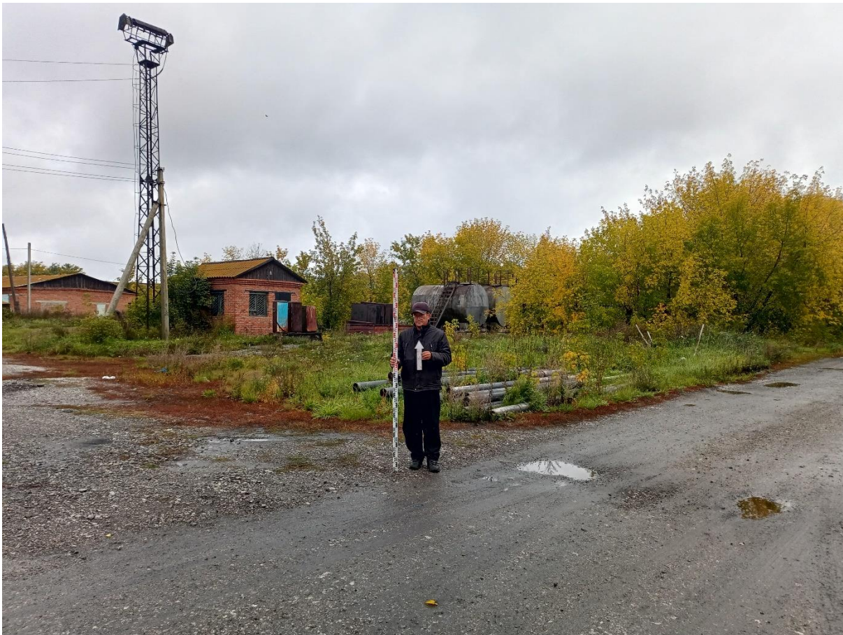
Рис. 166. «Строительство тепловой сети п. Трудармейский». Точка фотофиксации №29 ( 54^{\circ} 7'33.03''\text{С} , 86^{\circ}25'0.34''\text{В} ). Фото с Ю.
