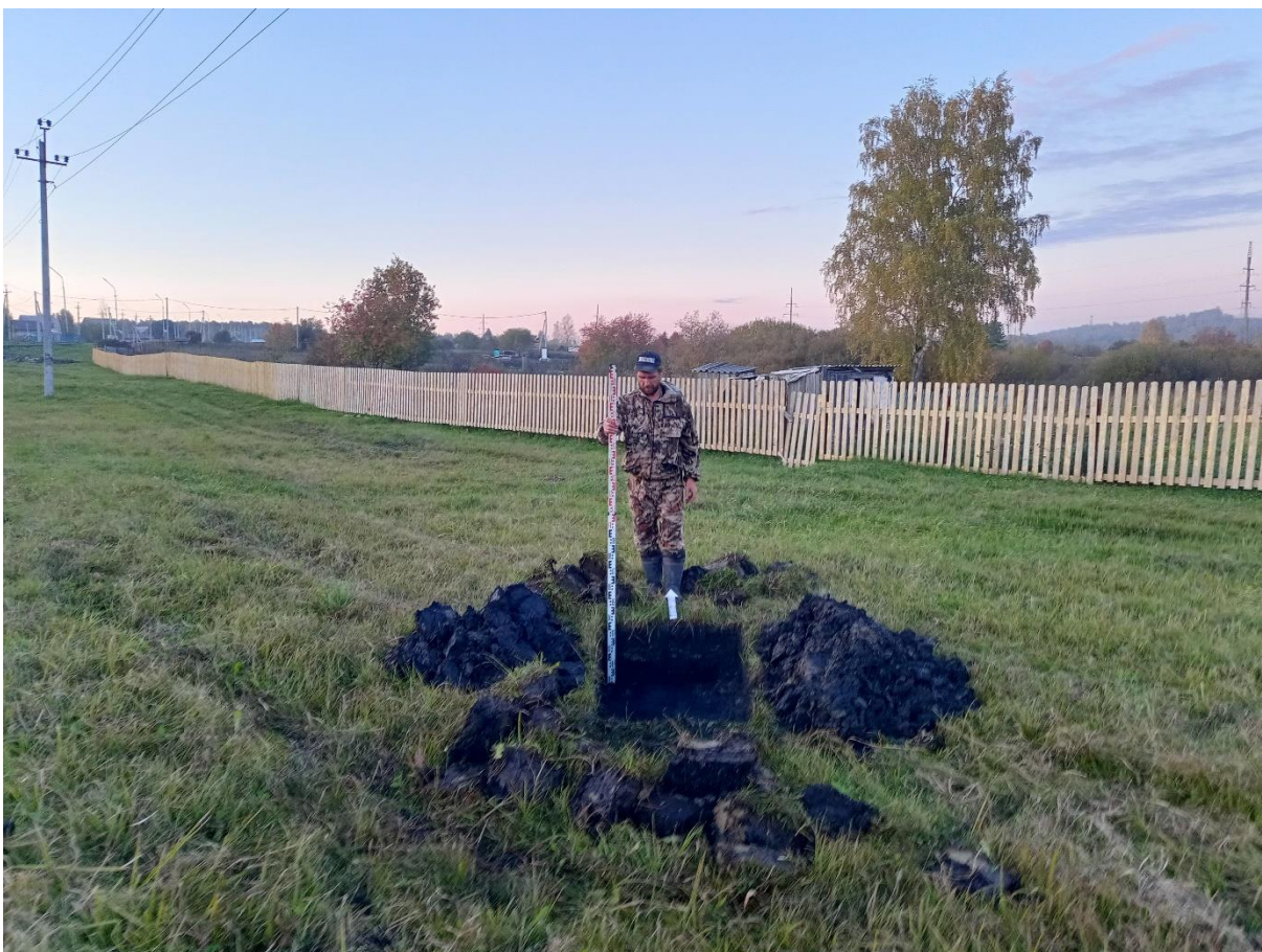
Рис. 111. «Строительство канализационной и тепловой сетей п. Новосафоновский». Шурф №6 после выборки. Фото с Ю.
