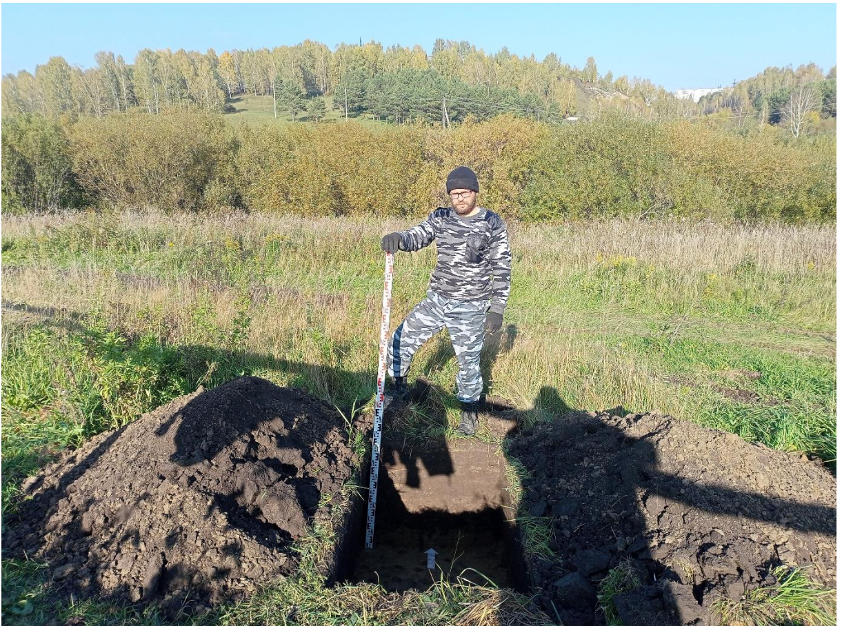
Рис. 103. «Строительство канализационной и тепловой сетей п. Новосафоновский». Шурф №4 после выборки. Фото с Ю.
