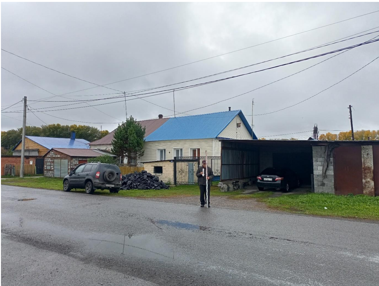
Рис. 152. «Строительство тепловой сети п. Трудармейский». Точка фотофиксации №25 ( 54^{\circ} 7'24.35''\text{С} , 86^{\circ}24'55.17''\text{В} ). Фото с С.
