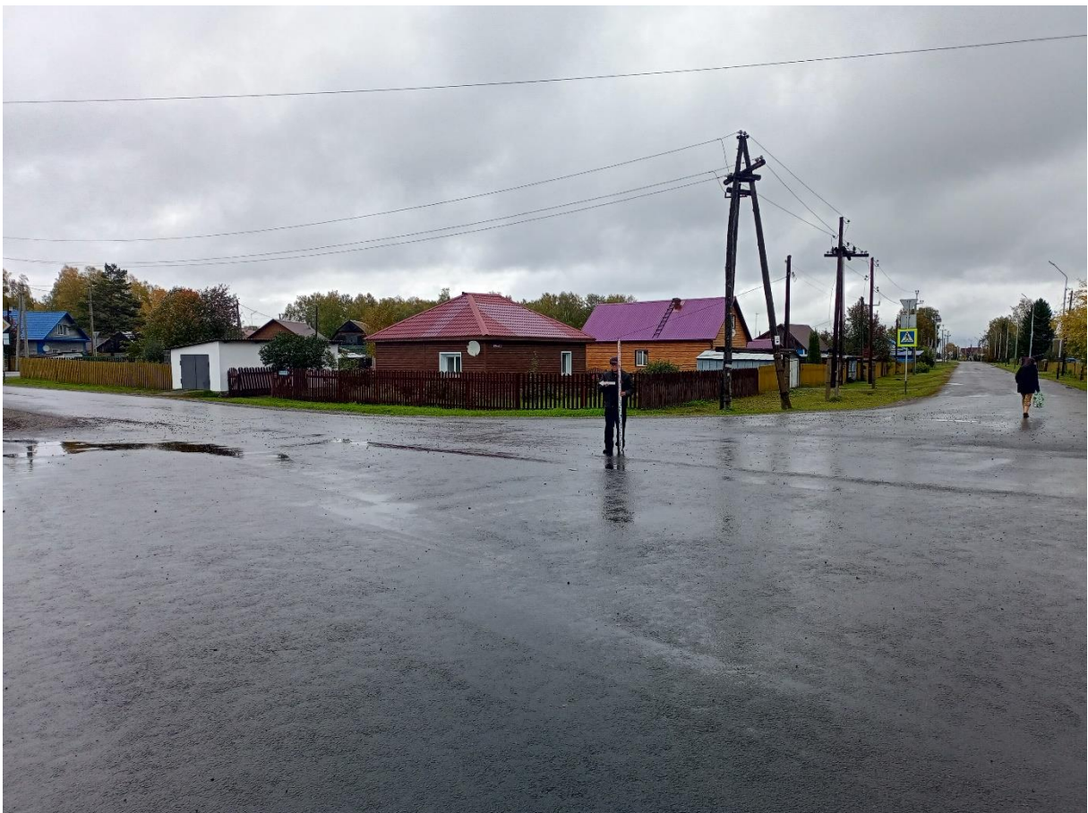
Рис. 157. «Строительство тепловой сети п. Трудармейский». Точка фотофиксации №26 ( 54^{\circ} 7'20.60''\text{С} , 86^{\circ}25'3.95''\text{В} ). Фото с З.
