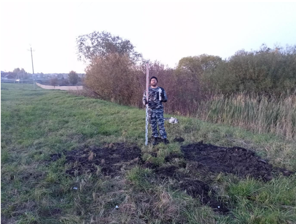
Рис. 117. «Строительство канализационной и тепловой сетей п. Новосафоновский». Шурф №7. Рекультивация. Фото с Ю.
