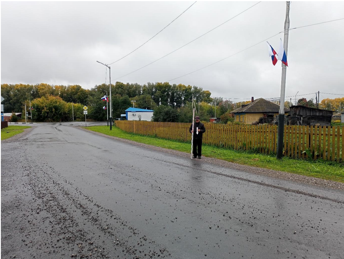
Рис. 160. «Строительство тепловой сети п. Трудармейский». Точка фотофиксации №27 ( 54^{\circ} 7'23.25''\text{С} , 86^{\circ}25'5.34''\text{В} ). Фото с С.
