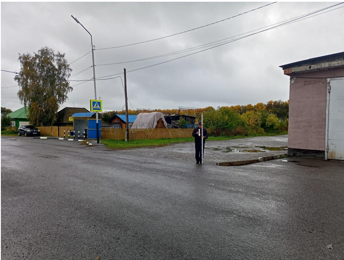
Рис. 148. «Строительство тепловой сети п. Трудармейский». Точка фотофиксации №24 ( 54^{\circ} 7'30.84''\text{С} , 86^{\circ}24'41.70''\text{В} ). Фото с С.
