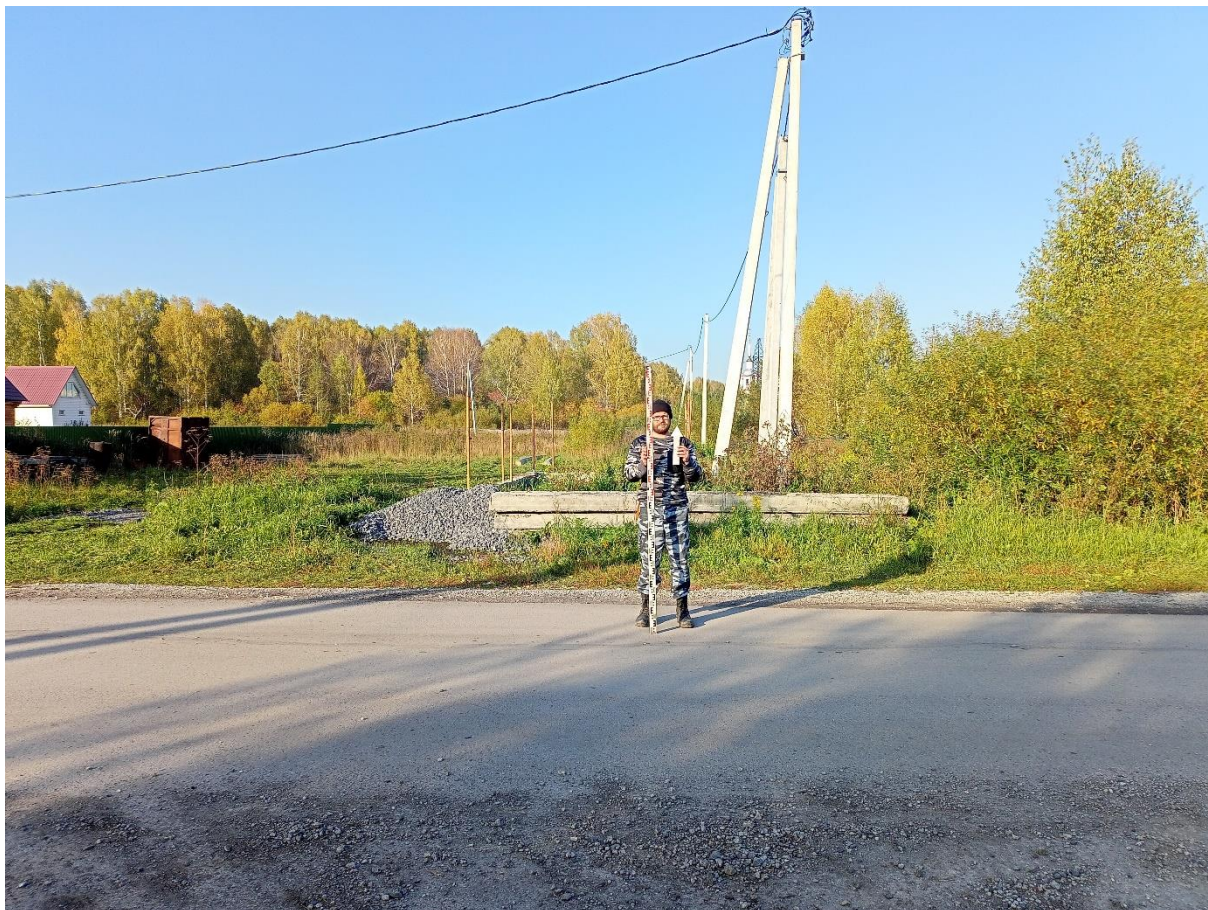
Рис. 56. «Строительство канализационной и тепловой сетей п. Новосафоновский». Точка фотофиксации №10 ( 53^{\circ}51'21.85''\text{С} , 86^{\circ}35'35.65''\text{В} ). Фото с Ю.
