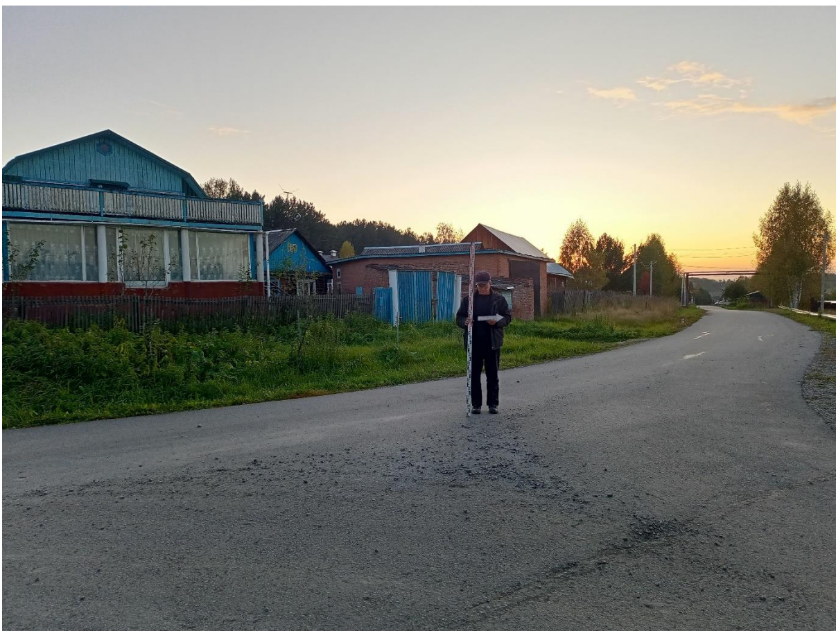
Рис. 89. «Строительство канализационной и тепловой сетей п. Новосафоновский». Точка фотофиксации №18 ( 53^{\circ}50'57.75''\text{С} , 86^{\circ}34'57.56''\text{В} ). Фото с В.
