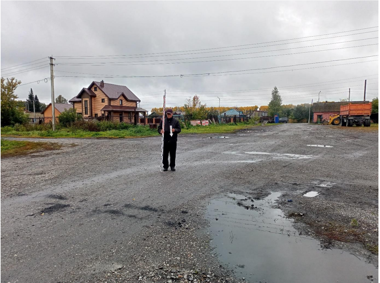
Рис. 168. «Строительство тепловой сети п. Трудармейский». Точка фотофиксации №29 ( 54^{\circ} 7'33.03''\text{С} , 86^{\circ}25'0.34''\text{В} ). Фото с С.
