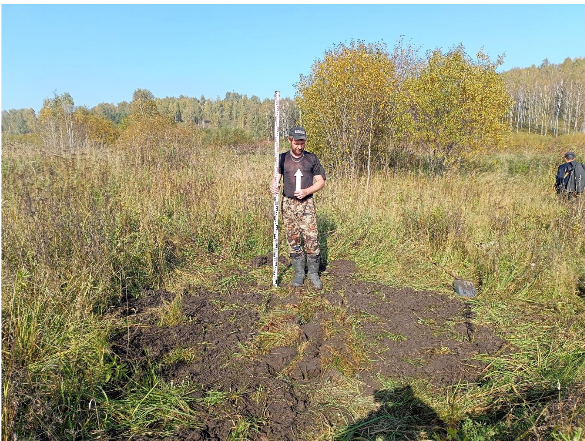
Рис. 93. «Строительство канализационной и тепловой сетей п. Новосафоновский». Шурф №1. Рекультивация. Фото с Ю.
