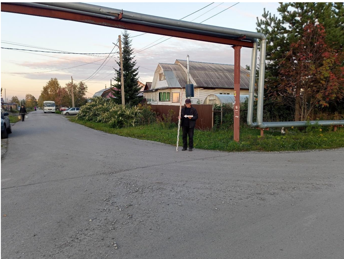
Рис. 87. «Строительство канализационной и тепловой сетей п. Новосафоновский». Точка фотофиксации №18 ( 53^{\circ}50'57.75''\text{С} , 86^{\circ}34'57.56''\text{В} ). Фото с З.
