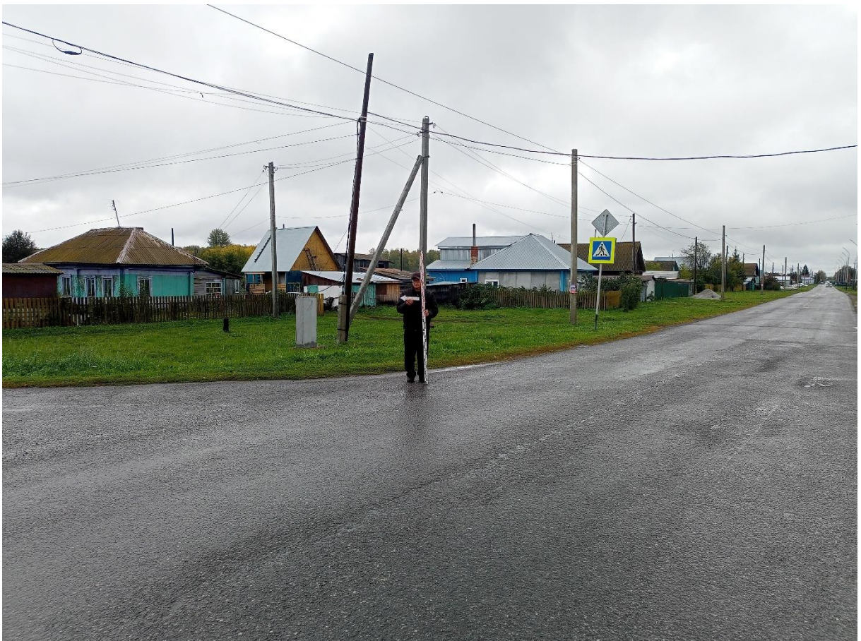
Рис. 147. «Строительство тепловой сети п. Трудармейский». Точка фотофиксации №24 ( 54^{\circ} 7'30.84''\text{С} , 86^{\circ}24'41.70''\text{В} ). Фото с З.
