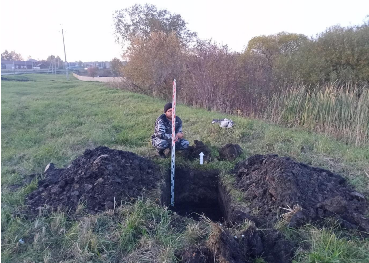
Рис. 115. «Строительство канализационной и тепловой сетей п. Новосафоновский». Шурф №7 после выборки. Фото с Ю.
