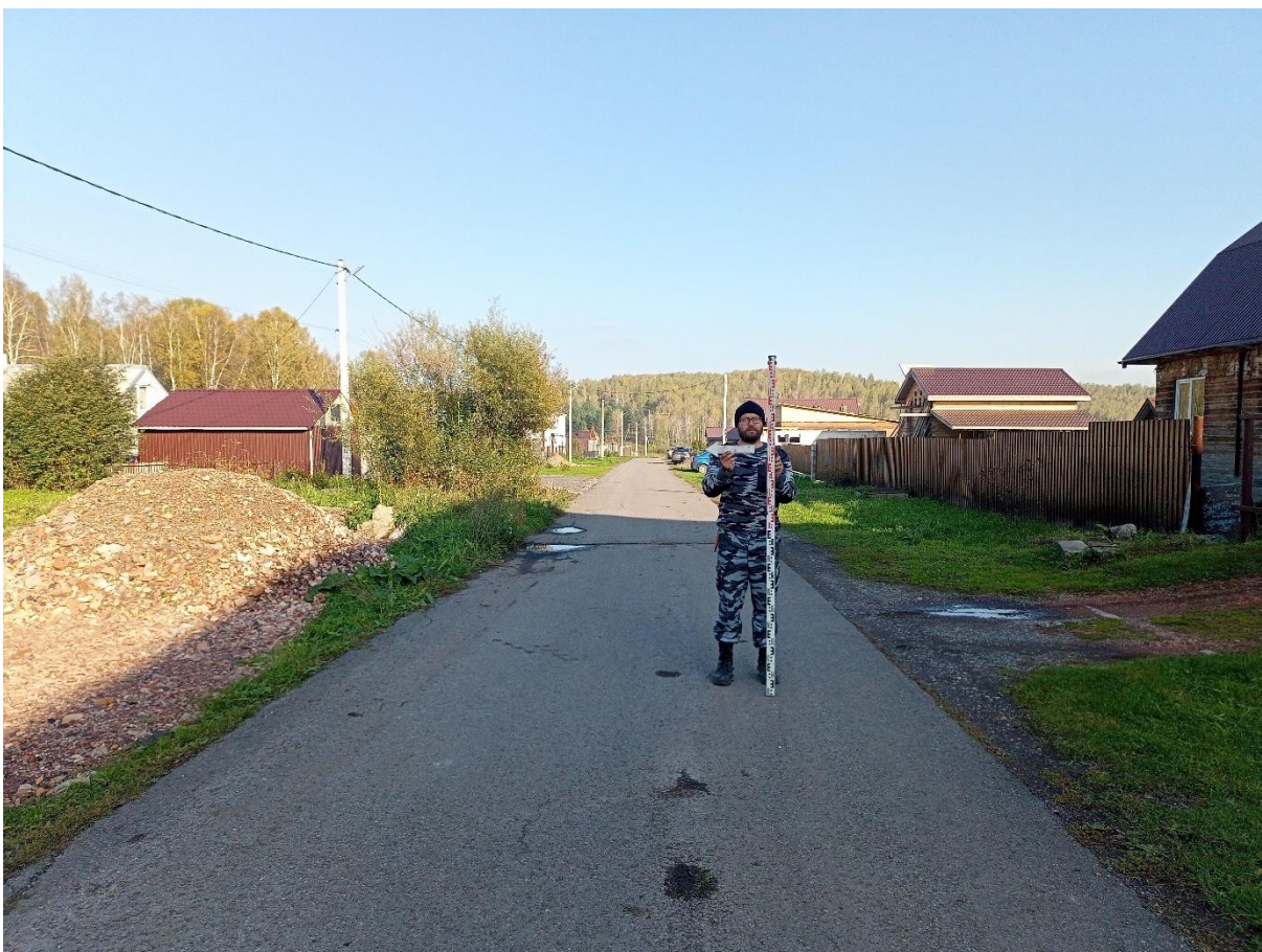
Рис. 47. «Строительство канализационной и тепловой сетей п. Новосафоновский». Точка фотофиксации №8 ( 53^{\circ}51'20.66''\text{С} , 86^{\circ}36'2.76''\text{В} ). Фото с З.
