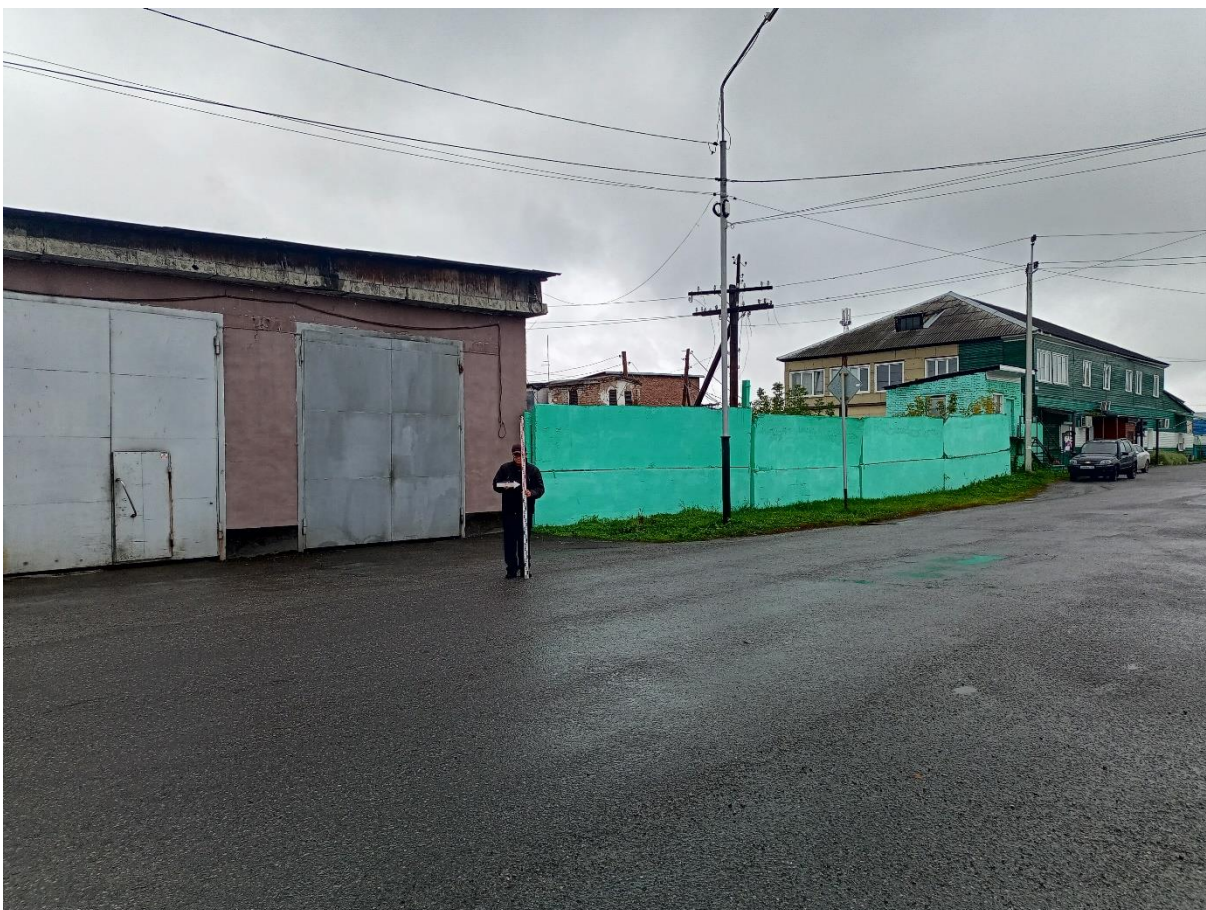
Рис. 149. «Строительство тепловой сети п. Трудармейский». Точка фотофиксации №24 ( 54^{\circ} 7'30.84''\text{С} , 86^{\circ}24'41.70''\text{В} ). Фото с В.
