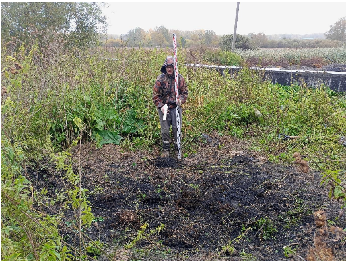
Рис. 173. «Строительство тепловой сети п. Трудармейский». Шурф №8. Рекультивация. Фото с Ю.
