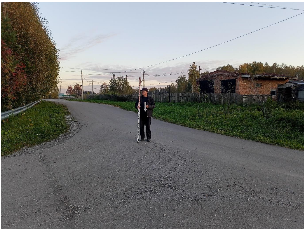
Рис. 88. «Строительство канализационной и тепловой сетей п. Новосафоновский». Точка фотофиксации №18 ( 53^{\circ}50'57.75''\text{С} , 86^{\circ}34'57.56''\text{В} ). Фото с С.
