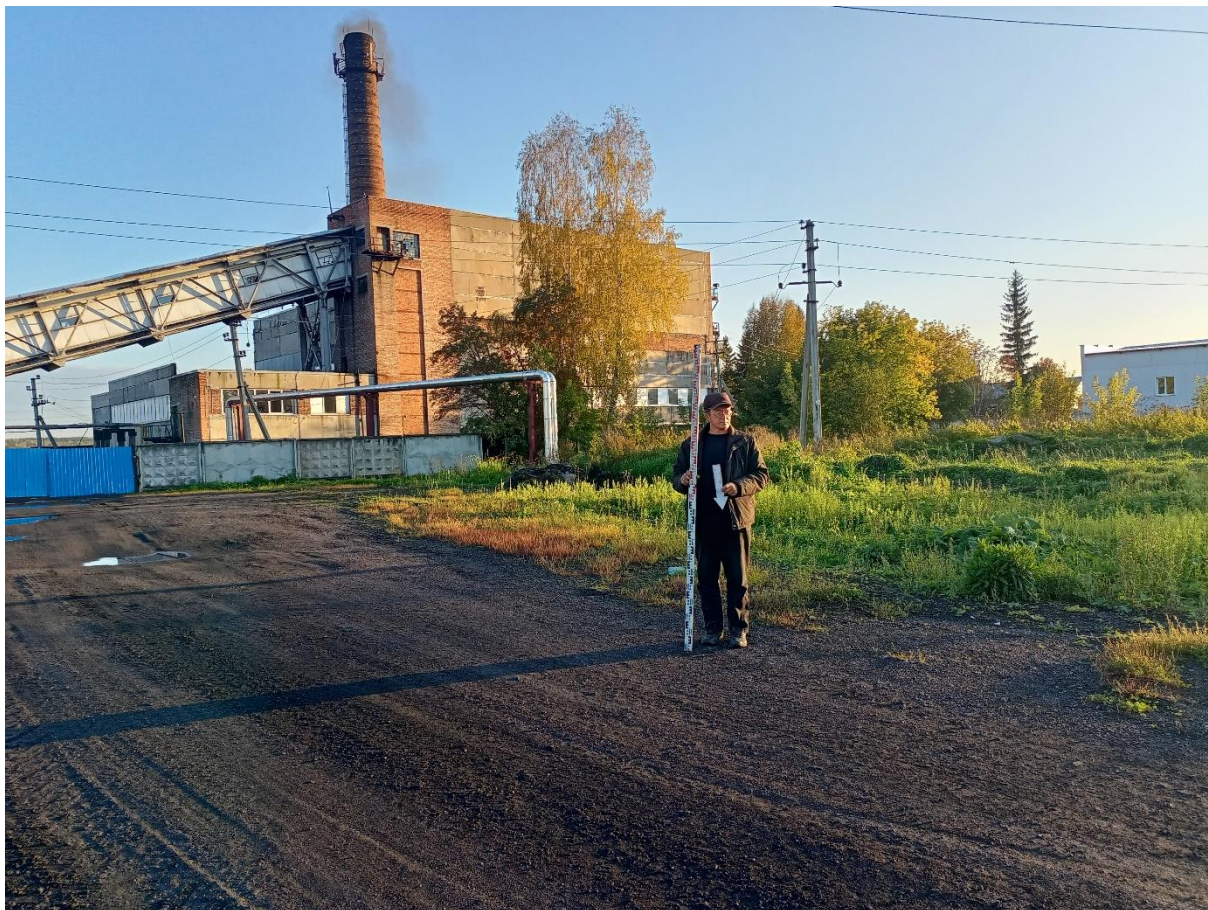
Рис. 62. «Строительство канализационной и тепловой сетей п. Новосафоновский». Точка фотофиксации №12 ( 53^{\circ}50'44.20''\text{С} , 86^{\circ}36'15.38''\text{В} ). Фото с С.
