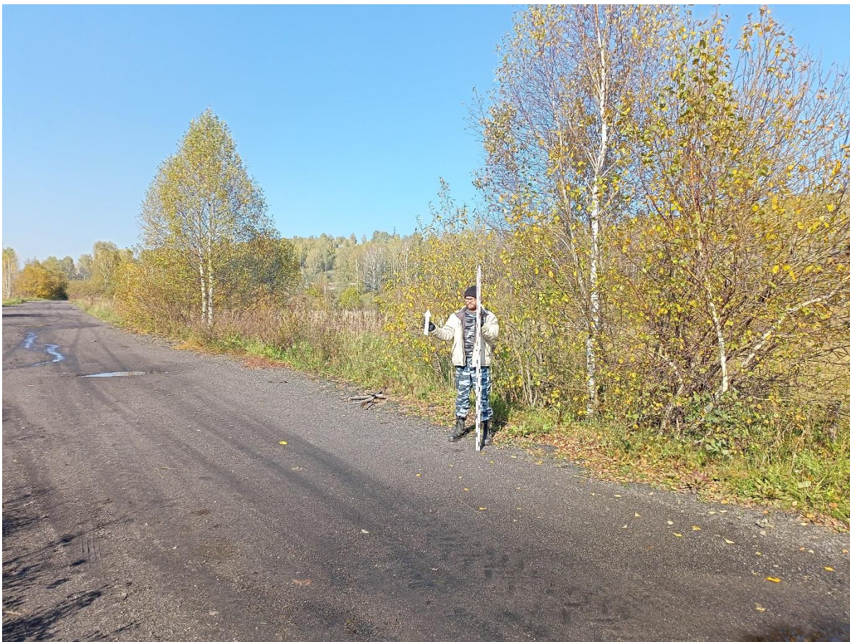
Рис. 18. «Строительство канализационной и тепловой сетей п. Новосафоновский». Точка фотофиксации №1 ( 53^{\circ}51'11.94''\text{C} , 86^{\circ}36'31.57''\text{В} ). Фото с Ю.
