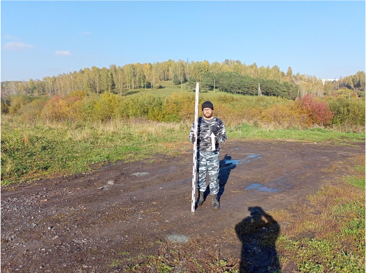
Рис. 30. «Строительство канализационной и тепловой сетей п. Новосафоновский». Точка фотофиксации №4 ( 53^{\circ}51'19.76''\text{C} , 86^{\circ}36'19.52''\text{B} ). Фото с Ю.
