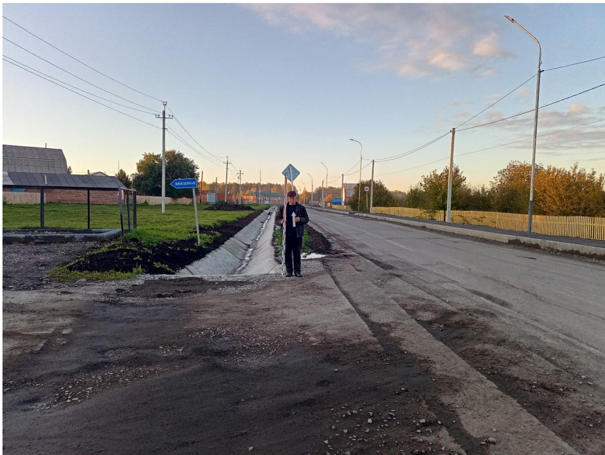
Рис. 74. «Строительство канализационной и тепловой сетей п. Новосафоновский». Точка фотофиксации №15 ( 53^{\circ}51'11.63''\text{С} , 86^{\circ}35'42.88''\text{В} ). Фото с Ю.
