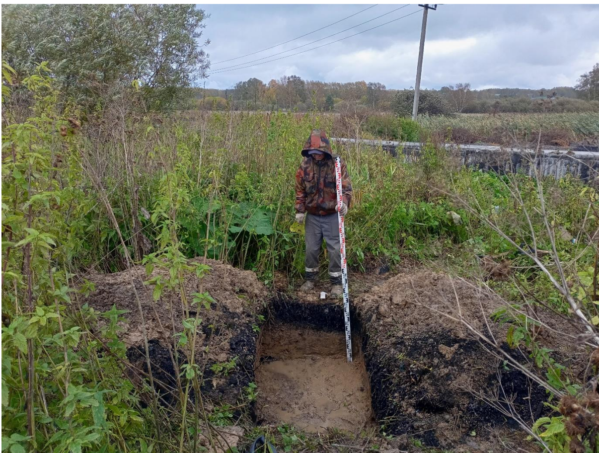
Рис. 171. «Строительство тепловой сети п. Трудармейский». Шурф №8 после выборки. Фото с Ю.
