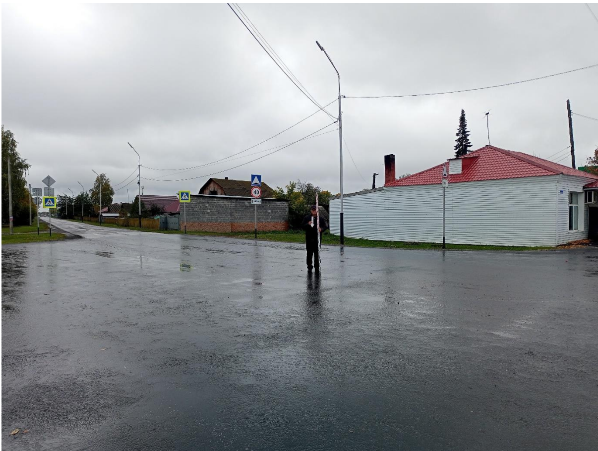
Рис. 140. «Строительство тепловой сети п. Трудармейский». Точка фотофиксации №22 ( 54^{\circ} 7'42.85''\text{С} , 86^{\circ}24'18.30''\text{В} ). Фото с С.
