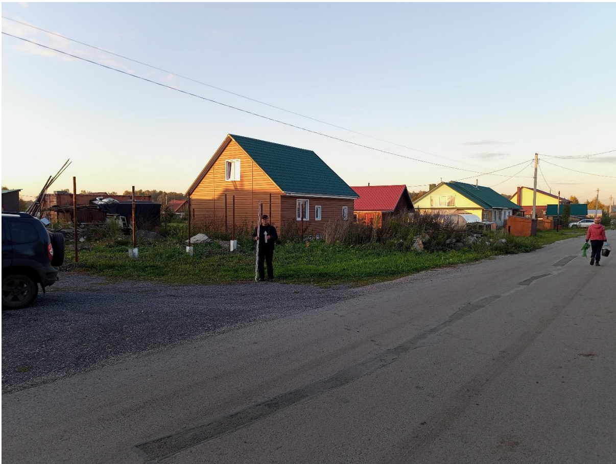
Рис. 78. «Строительство канализационной и тепловой сетей п. Новосафоновский». Точка фотофиксации №16 ( 53^{\circ}51'13.65''\text{С} , 86^{\circ}35'24.31''\text{В} ). Фото с Ю.
