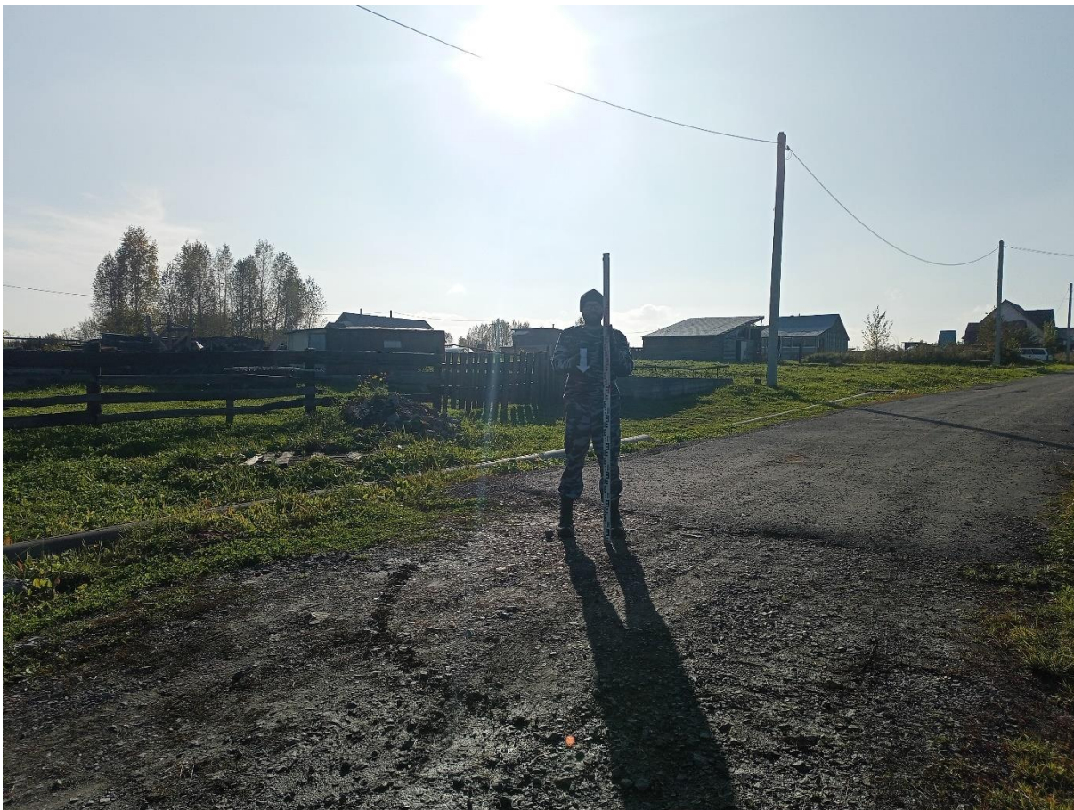
Рис. 32. «Строительство канализационной и тепловой сетей п. Новосафоновский». Точка фотофиксации №4 ( 53^{\circ}51'19.76''\text{С} , 86^{\circ}36'19.52''\text{В} ). Фото с С.
