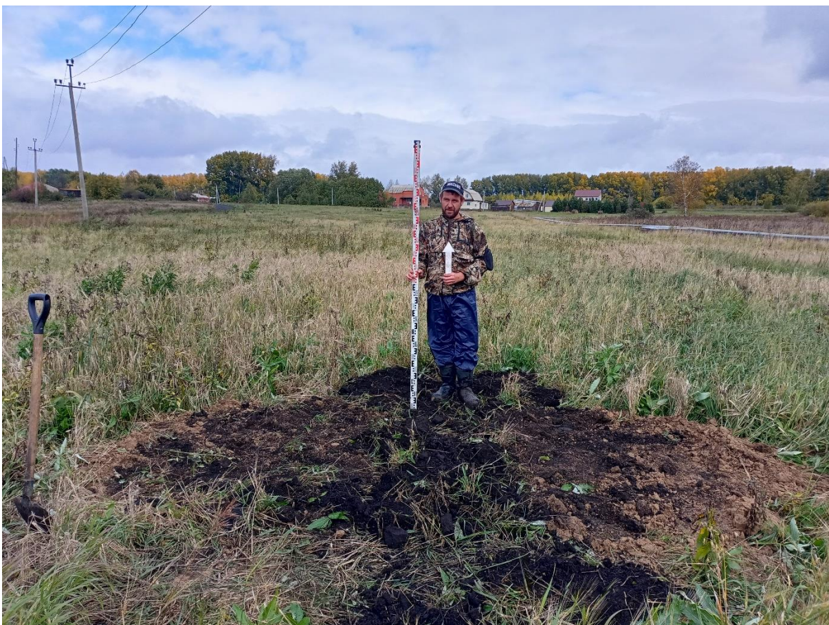
Рис. 177. «Строительство тепловой сети п. Трудармейский». Шурф №9. Рекультивация. Фото с Ю.
