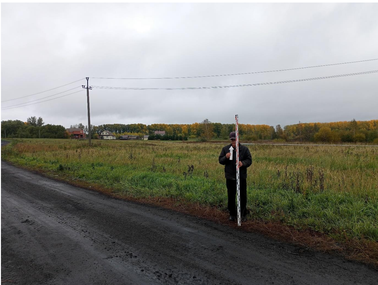
Рис. 133. «Строительство тепловой сети п. Трудармейский». Точка фотофиксации №20 ( 54^{\circ} 7'1.39''\text{С} , 86^{\circ}24'46.71''\text{В} ). Фото с Ю.
