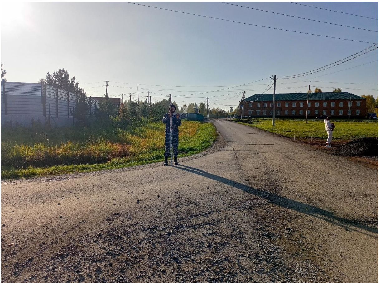
Рис. 45. «Строительство канализационной и тепловой сетей п. Новосафоновский». Точка фотофиксации №7 ( 53^{\circ}51'21.33''\text{С} , 86^{\circ}35'45.61''\text{В} ). Фото с В.
