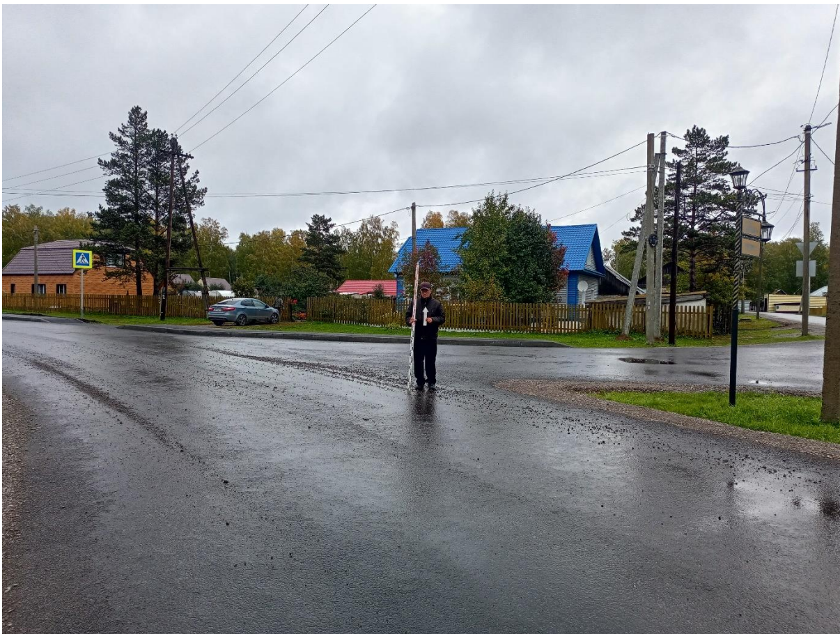
Рис. 158. «Строительство тепловой сети п. Трудармейский». Точка фотофиксации №27 ( 54^{\circ} 7'23.25''\text{С} , 86^{\circ}25'5.34''\text{В} ). Фото с Ю.
