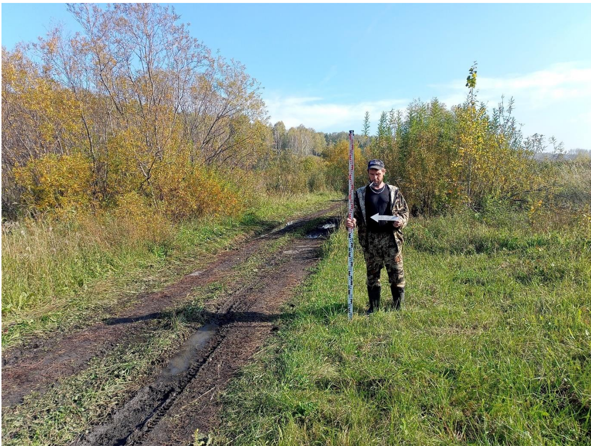
Рис. 24. «Строительство канализационной и тепловой сетей п. Новосафоновский». Точка фотофиксации №2 ( 53^{\circ}51'14.34''\text{С} , 86^{\circ}36'26.98''\text{В} ). Фото с З.
