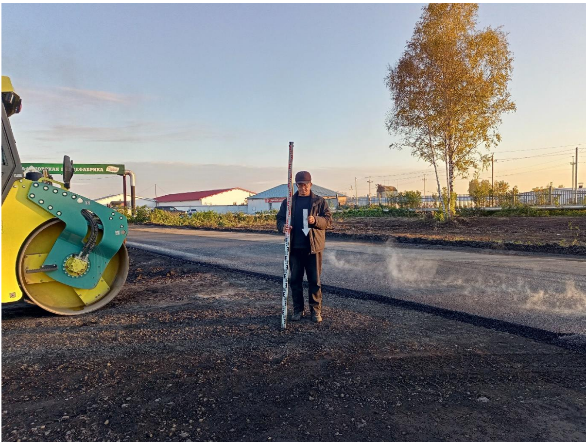
Рис. 68. «Строительство канализационной и тепловой сетей п. Новосафоновский». Точка фотофиксации №13 ( 53^{\circ}50'43.42''\text{С} , 86^{\circ}36'7.85''\text{В} ). Фото с С.
