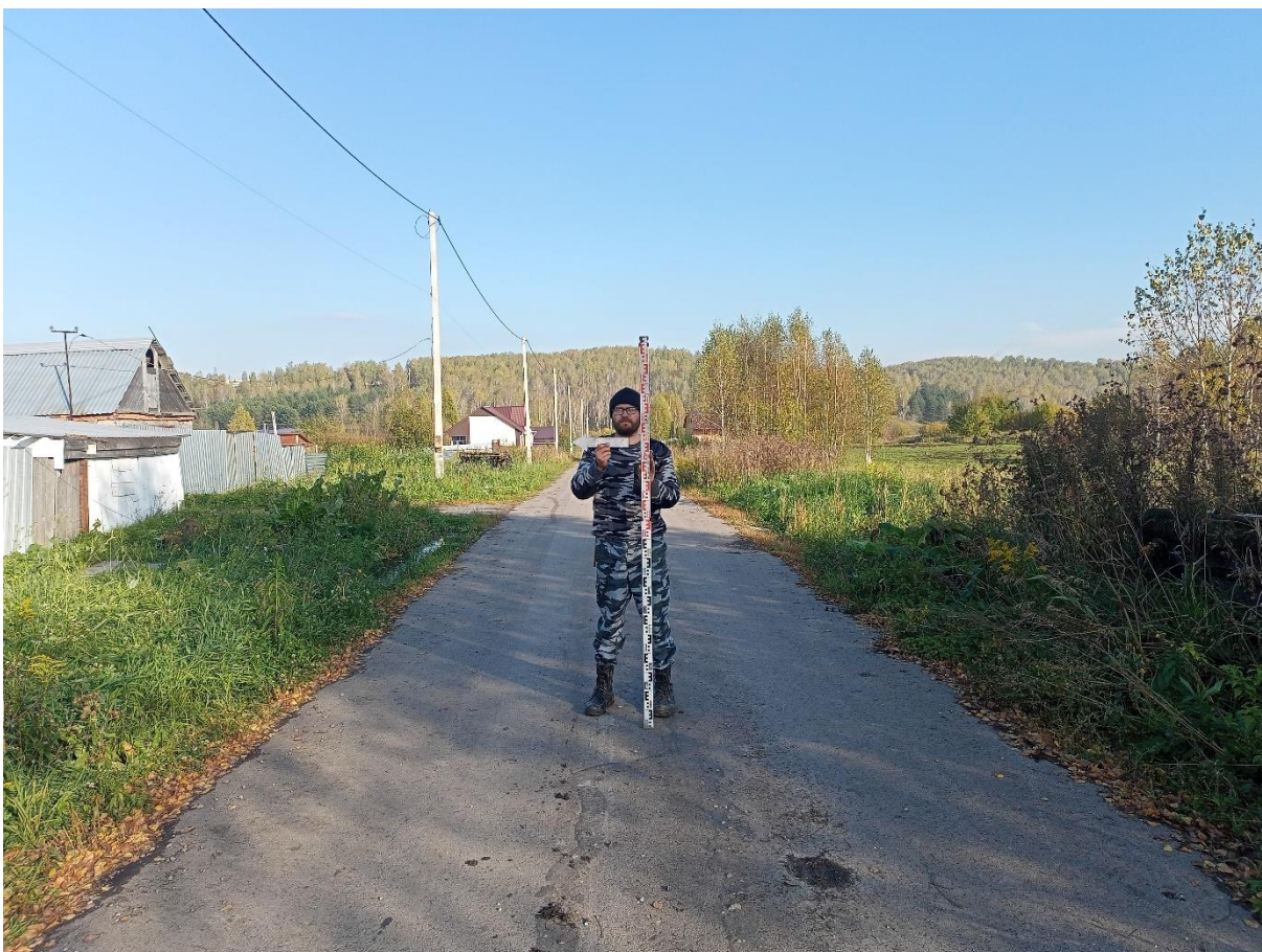
Рис. 35. «Строительство канализационной и тепловой сетей п. Новосафоновский». Точка фотофиксации №5 ( 53^{\circ}51'16.99''\text{С} , 86^{\circ}36'7.21''\text{В} ). Фото с З.
