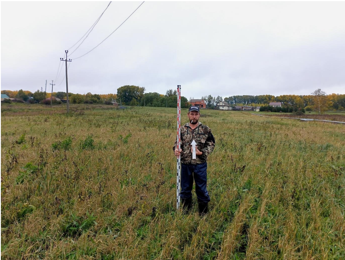
Рис. 174. «Строительство тепловой сети п. Трудармейский». Шурф №9 ( 54^{\circ} 7'1.51''\text{С} , 86^{\circ}24'47.99''\text{В} ). Место закладки. Фото с Ю.
