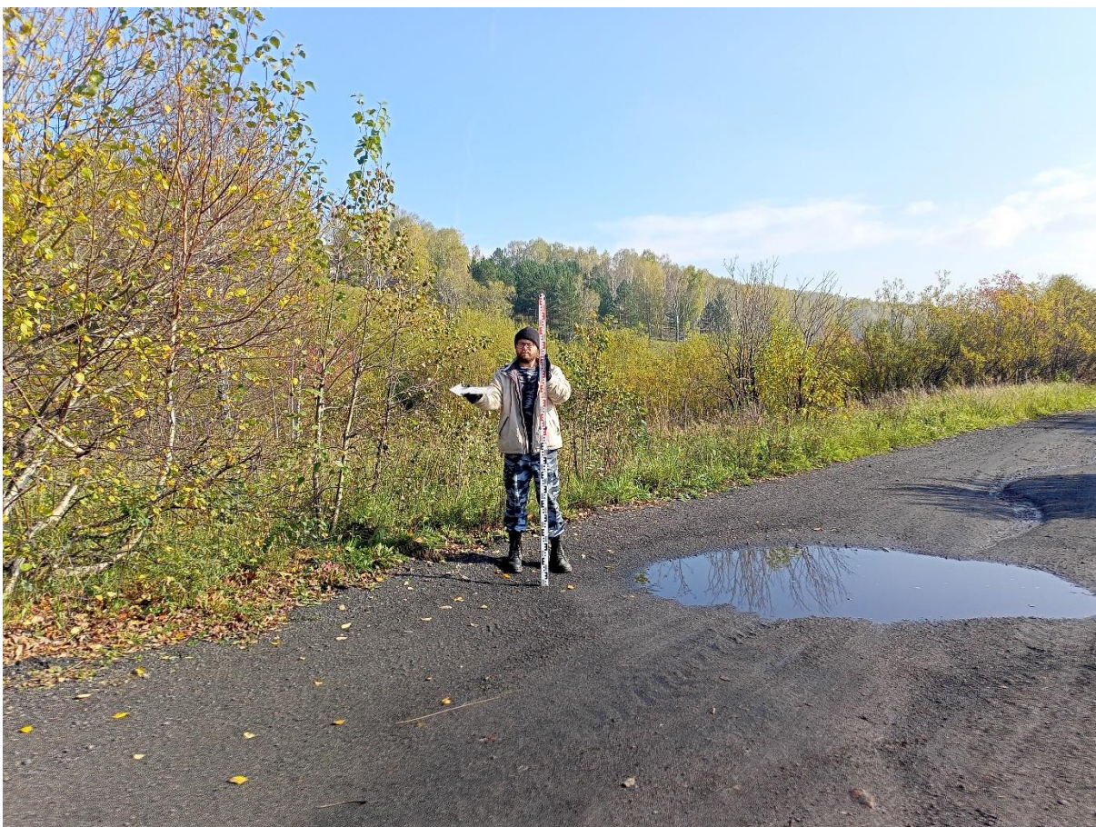
Рис. 19. «Строительство канализационной и тепловой сетей п. Новосафоновский». Точка фотофиксации №1 ( 53^{\circ}51'11.94''\text{C} , 86^{\circ}36'31.57''\text{В} ). Фото с З.
