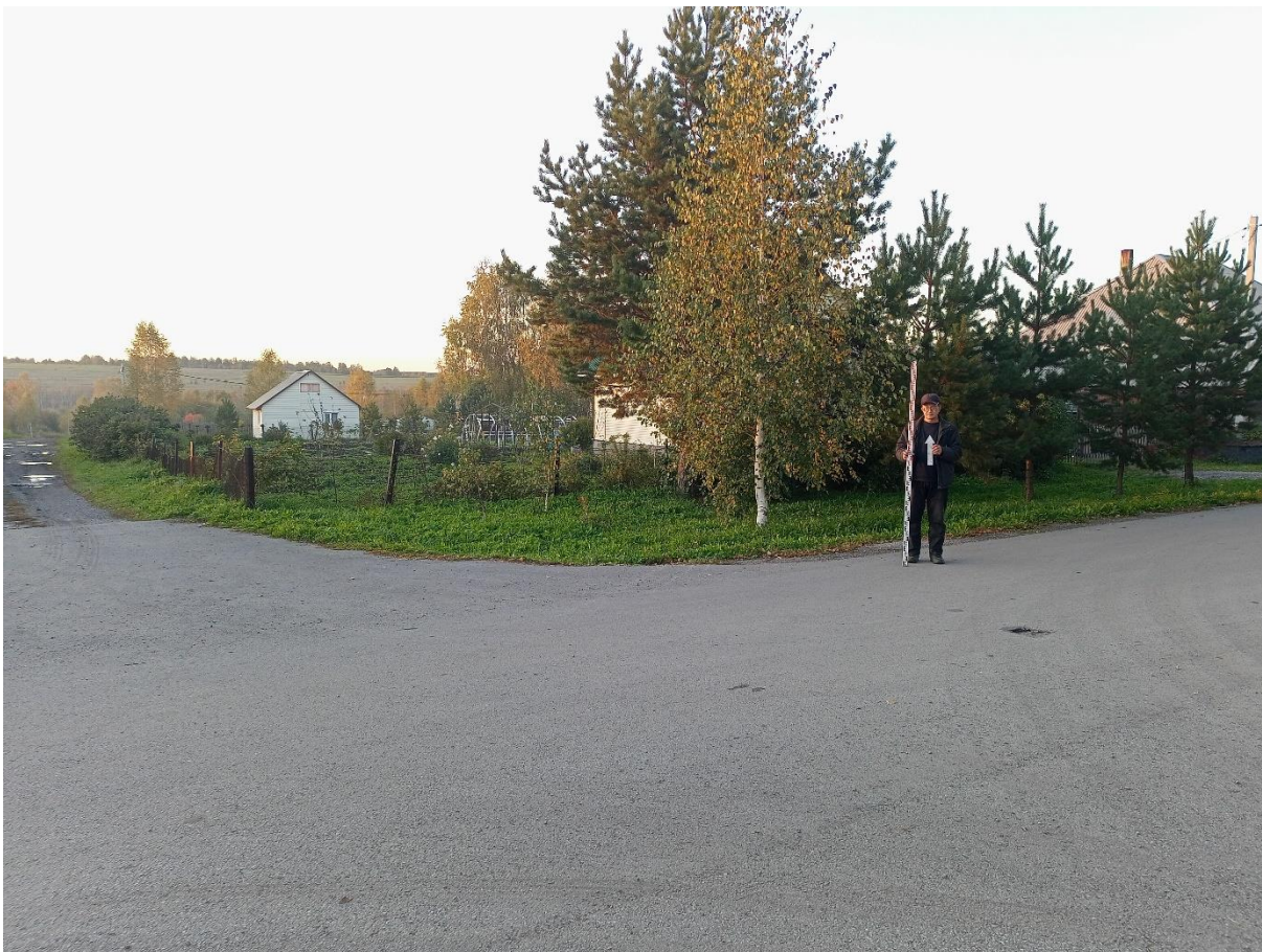
Рис. 82. «Строительство канализационной и тепловой сетей п. Новосафоновский». Точка фотофиксации №17 ( 53^{\circ}51'3.36''\text{С} , 86^{\circ}35'7.41''\text{В} ). Фото с Ю.
