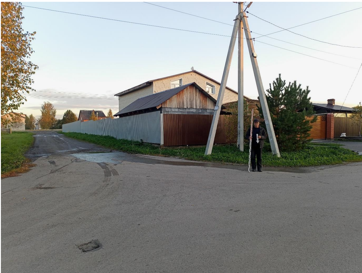
Рис. 84. «Строительство канализационной и тепловой сетей п. Новосафоновский». Точка фотофиксации №17 ( 53^{\circ}51'3.36''\text{С} , 86^{\circ}35'7.41''\text{В} ). Фото с С.
