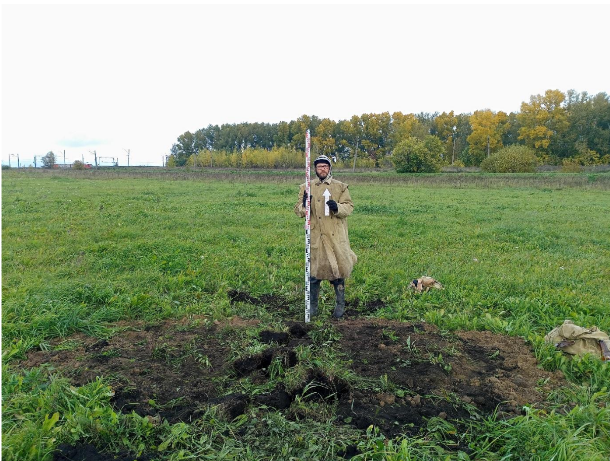
Рис. 181. «Строительство тепловой сети п. Трудармейский». Шурф №10. Рекультивация. Фото с Ю.
