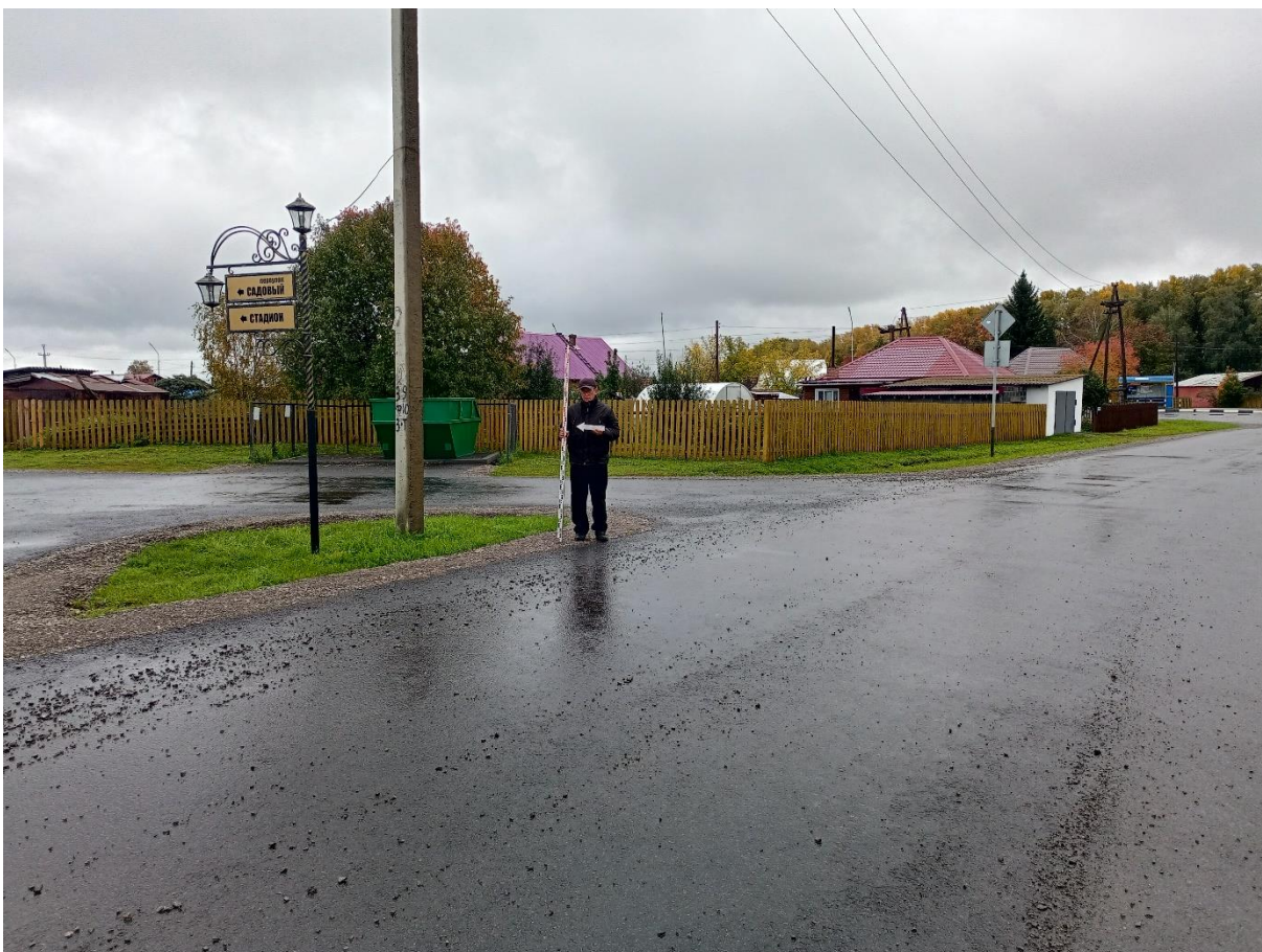
Рис. 159. «Строительство тепловой сети п. Трудармейский». Точка фотофиксации №27 ( 54^{\circ} 7'23.25''\text{С} , 86^{\circ}25'5.34''\text{В} ). Фото с З.
