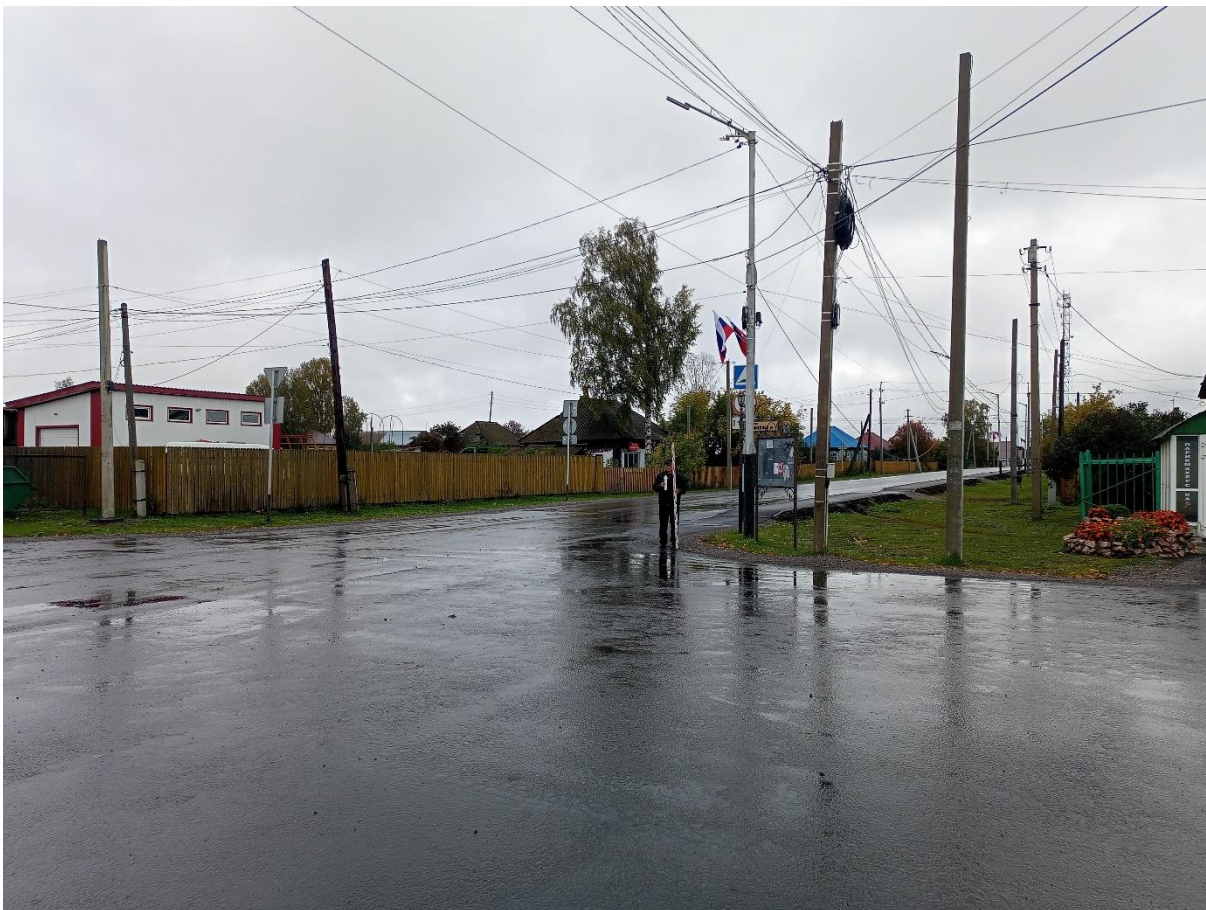
Рис. 138. «Строительство тепловой сети п. Трудармейский». Точка фотофиксации №22 ( 54^{\circ} 7'42.85''\text{С} , 86^{\circ}24'18.30''\text{В} ). Фото с Ю.
