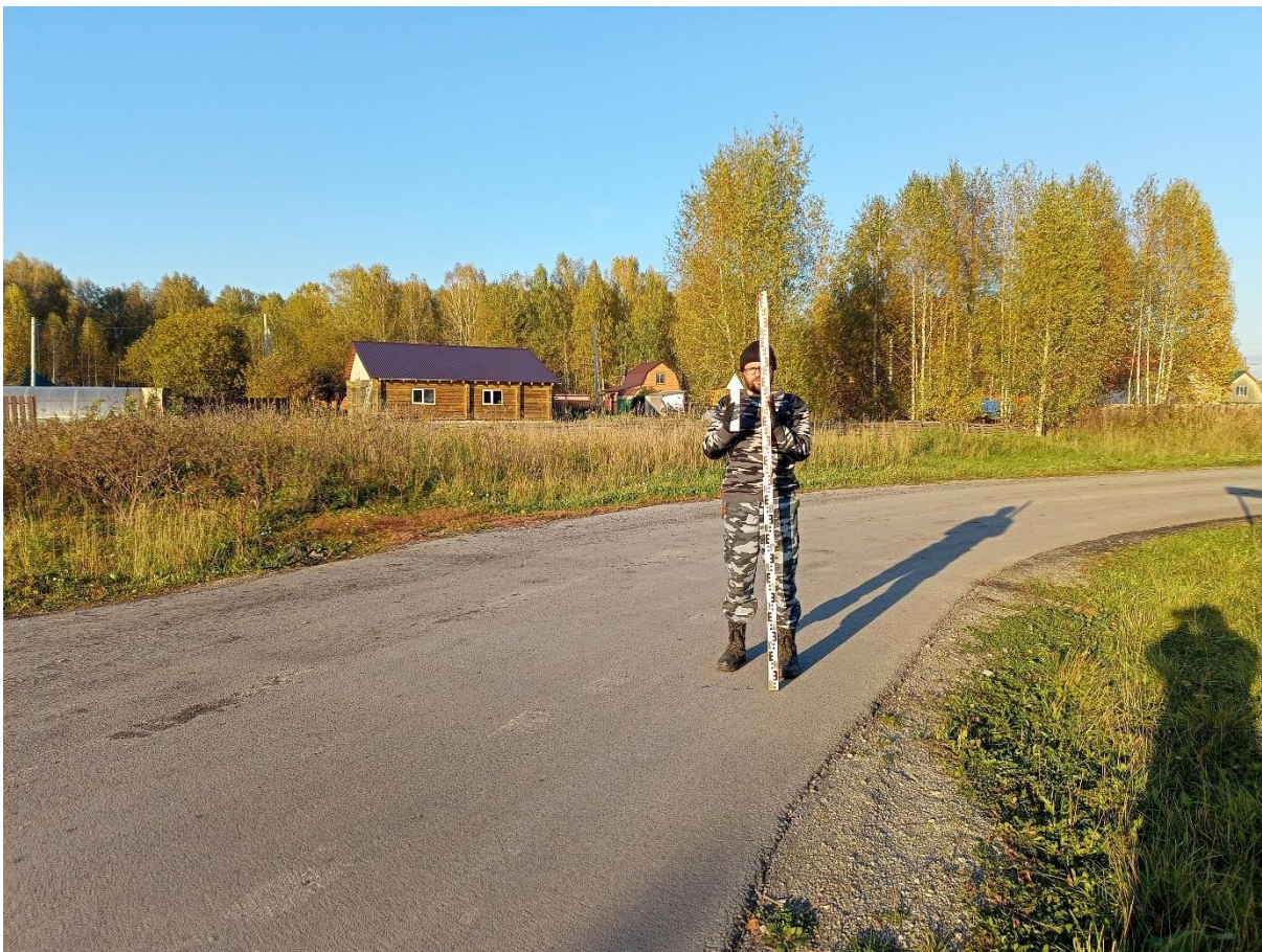
Рис. 58. «Строительство канализационной и тепловой сетей п. Новосафоновский». Точка фотофиксации №11 ( 53^{\circ}51'24.55''\text{C} , 86^{\circ}35'23.85''\text{В} ). Фото с Ю.
