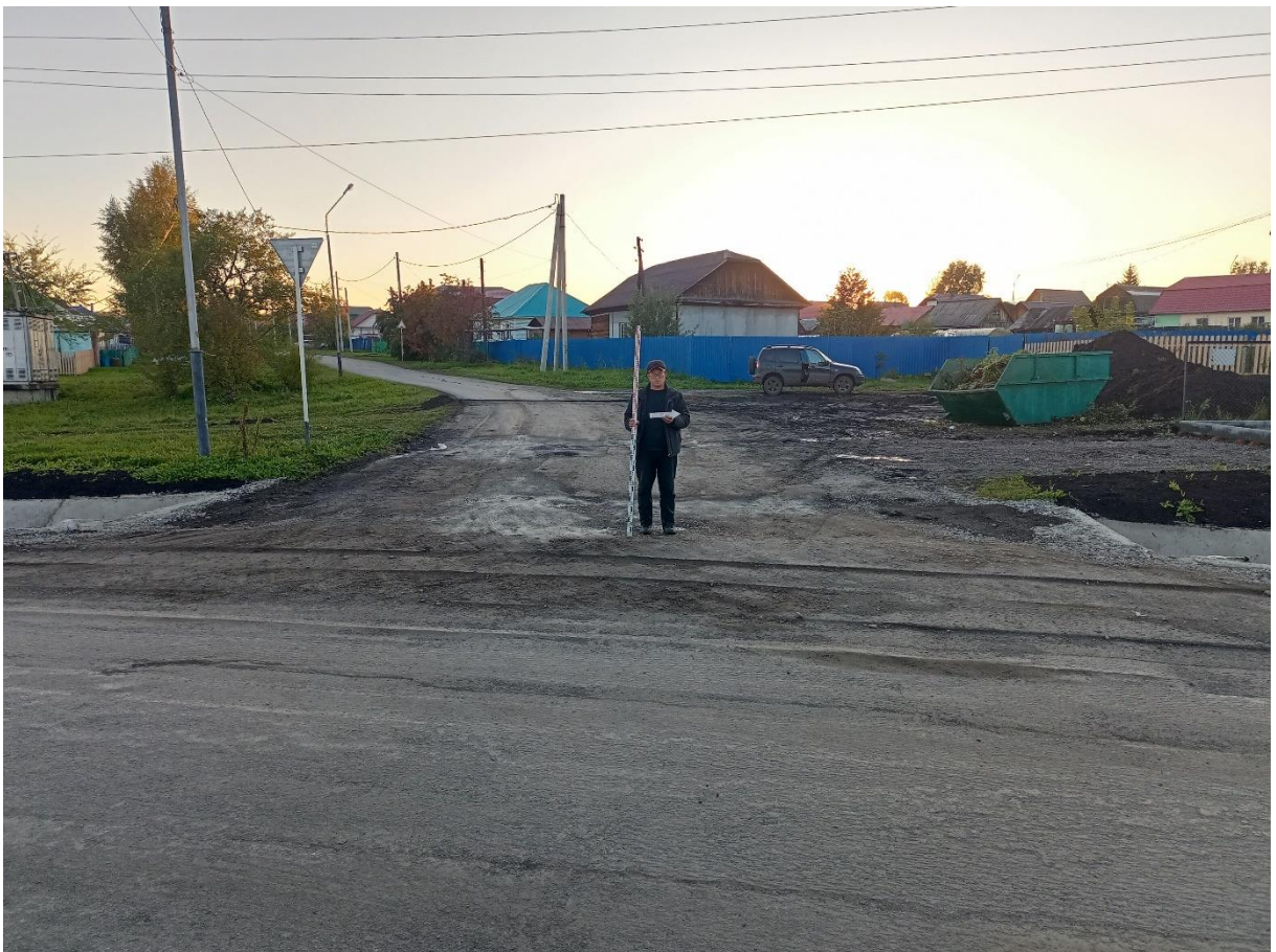
Рис. 77. «Строительство канализационной и тепловой сетей п. Новосафоновский». Точка фотофиксации №15 ( 53^{\circ}51'11.63''\text{С} , 86^{\circ}35'42.88''\text{В} ). Фото с В.
