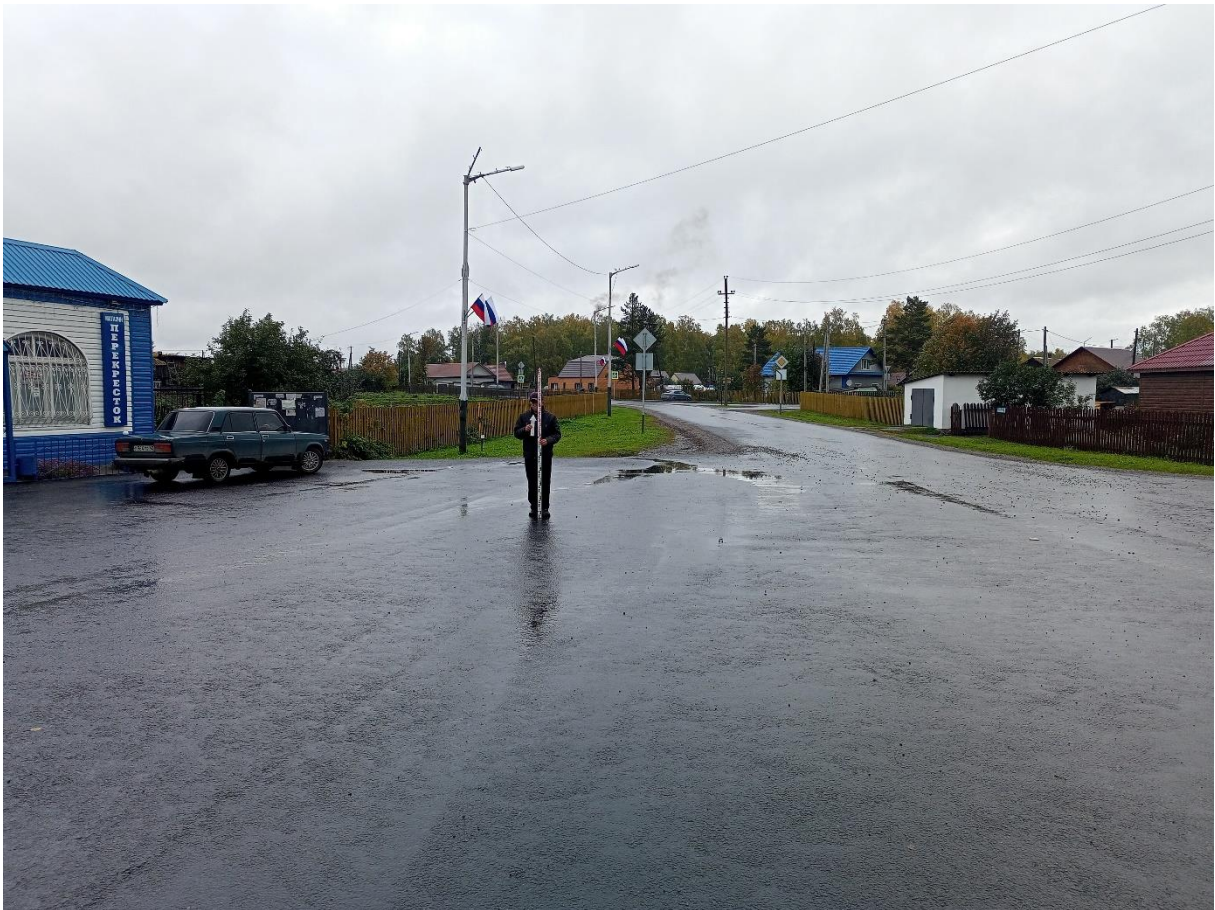
Рис. 156. «Строительство тепловой сети п. Трудармейский». Точка фотофиксации №26 ( 54^{\circ} 7'20.60''\text{С} , 86^{\circ}25'3.95''\text{В} ). Фото с Ю.
