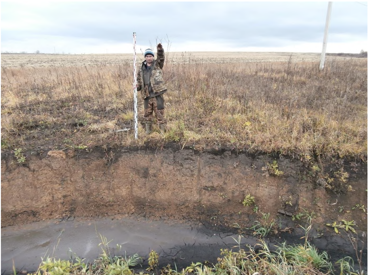
Рис. 277. «Строительство одной двухцепной отпайки .... КеНоТЭК». Место производства зачистки №6 ( 54^{\circ}24'53.57''\text{C} , 86^{\circ}42'4.48''\text{B} ). Фото с С.
