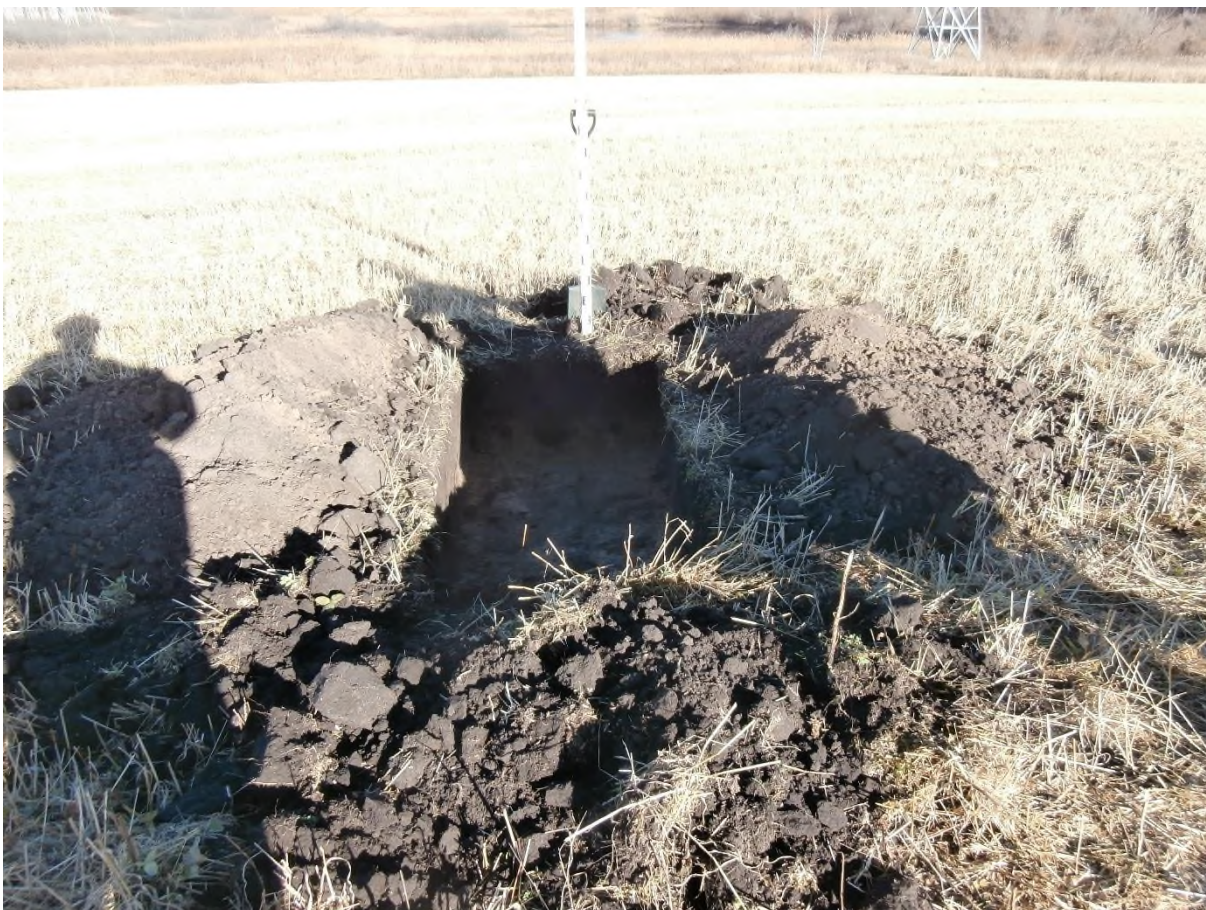
Рис. 189. «Строительство одной двухцепной отпайки .... КеНоТЭК». Шурф №20 после выборки. Фото с Ю.
