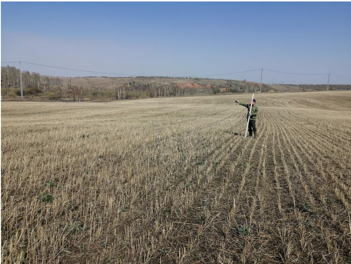
Рис. 97. «Строительство одной двухцепной отпайки .... КеНоТЭК». Точка фотофиксации №29 ( 54^{\circ}25'16.64''\text{С} , 86^{\circ}42'7.00''\text{В} ). Фото с 3.
