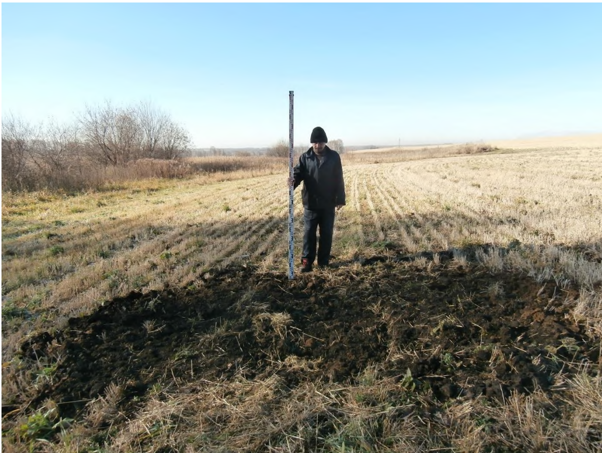
Рис. 218. «Строительство одной двухцепной отпайки .... КеНоТЭК». Шурф №27. Рекультивация. Фото с В.
