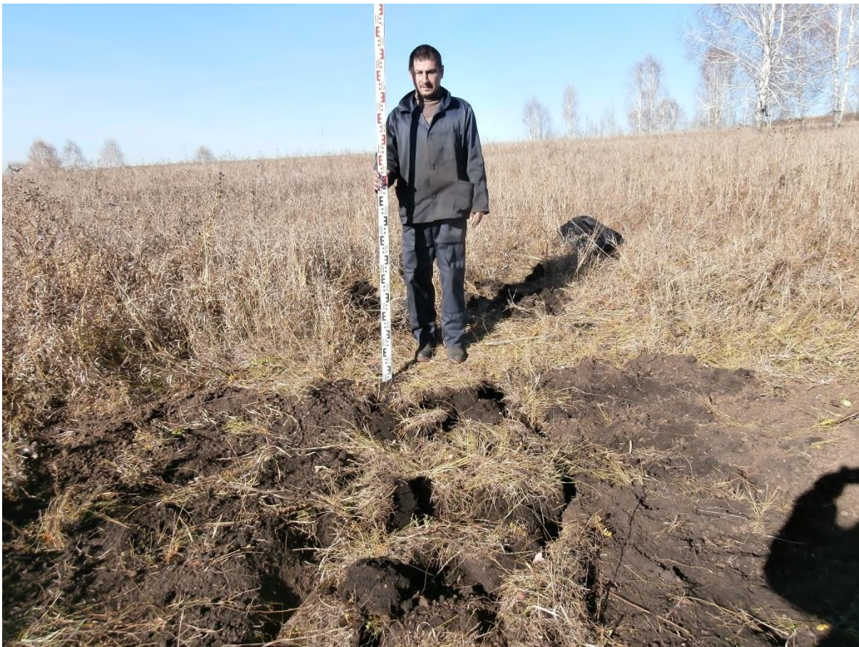
Рис. 230. «Строительство одной двухцепной отпайки .... КеНоТЭК». Шурф №30. Рекультивация. Фото с Ю.
