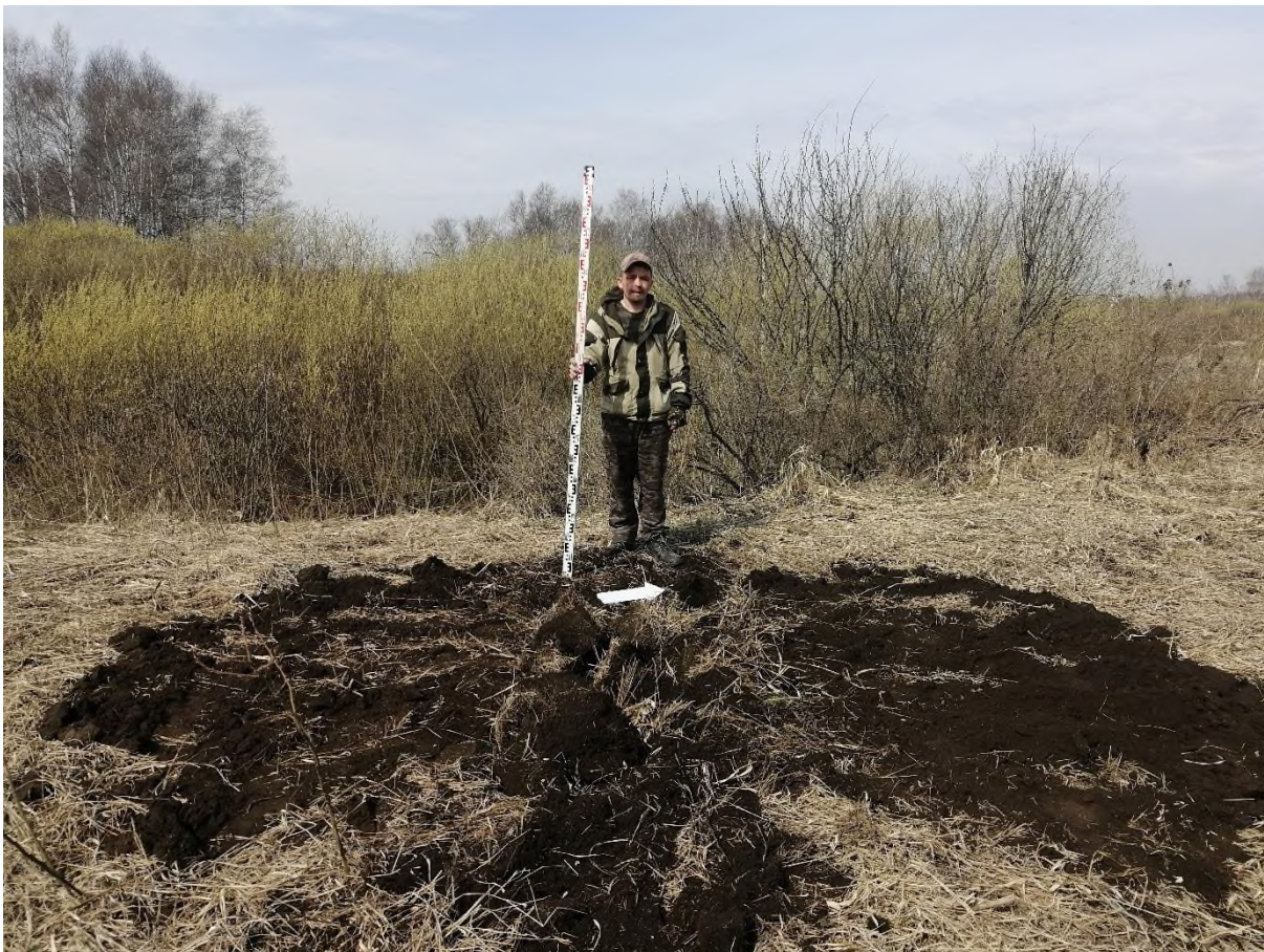
Рис. 254. «Строительство одной двухцепной отпайки .... КеНоТЭК». Шурф №36. Рекультивация. Фото с В.
