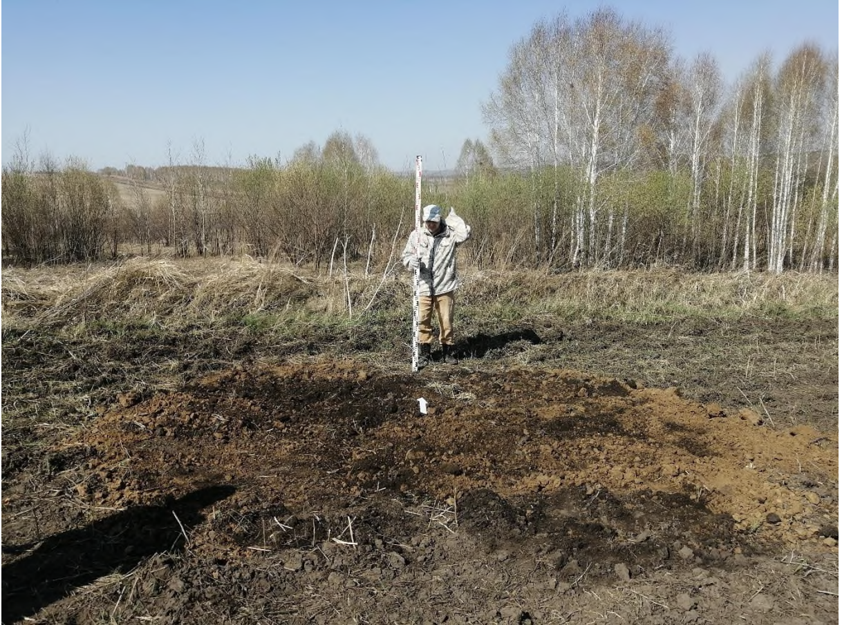
Рис. 238. «Строительство одной двухцепной отпайки .... КеНоТЭК». Шурф №32. Рекультивация. Фото с Ю.
