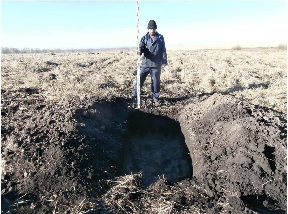
Рис. 212. «Строительство одной двухцепной отпайки .... КеНоТЭК». Шурф №26 после выборки. Фото с В.
