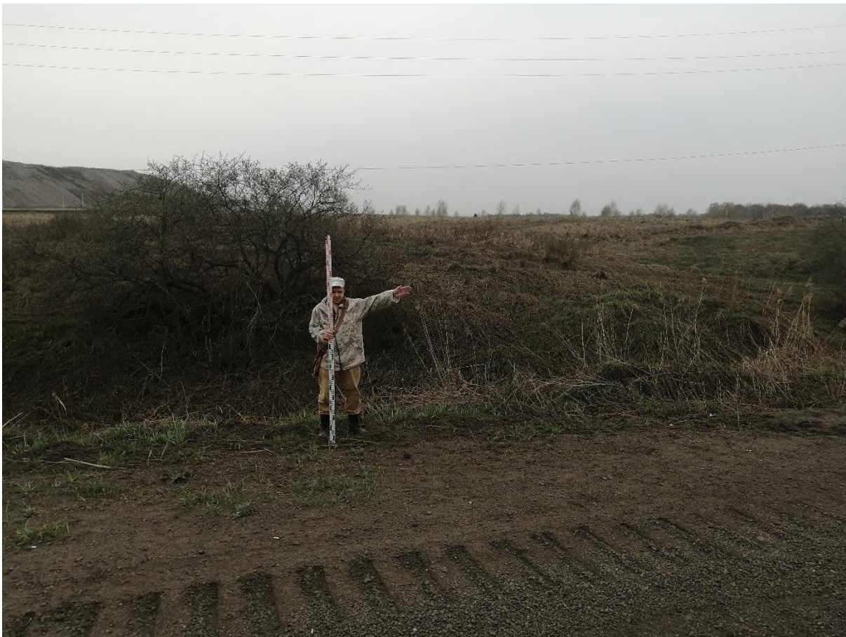
Рис. 109. «Строительство одной двухцепной отпайки .... КеНоТЭК». Точка фотофиксации №35 ( 54^{\circ}22'41.84''\text{С} , 86^{\circ}45'20.55''\text{В} ). Фото с СВ.
