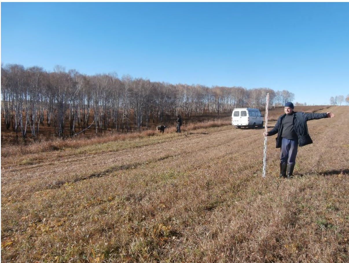
Рис. 86. «Строительство одной двухцепной отпайки .... КеНоТЭК». Точка фотофиксации №24 ( 54^{\circ}27'0.43''\text{C} , 86^{\circ}39'40.20''\text{B} ). Фото с ВЮВ.
