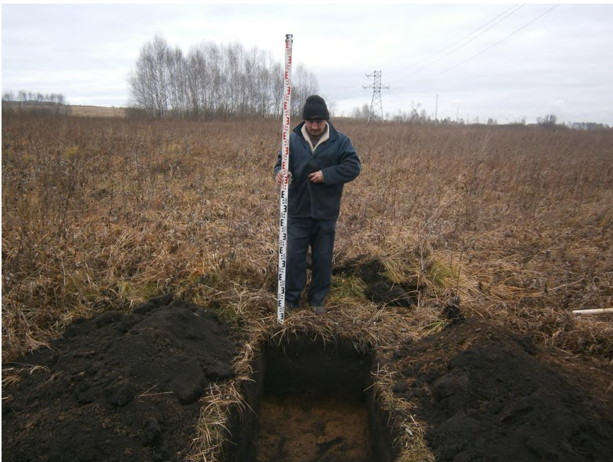
Рис. 168. «Строительство одной двухцепной отпайки .... КеНоТЭК». Шурф №15 после выборки. Фото с Ю.
