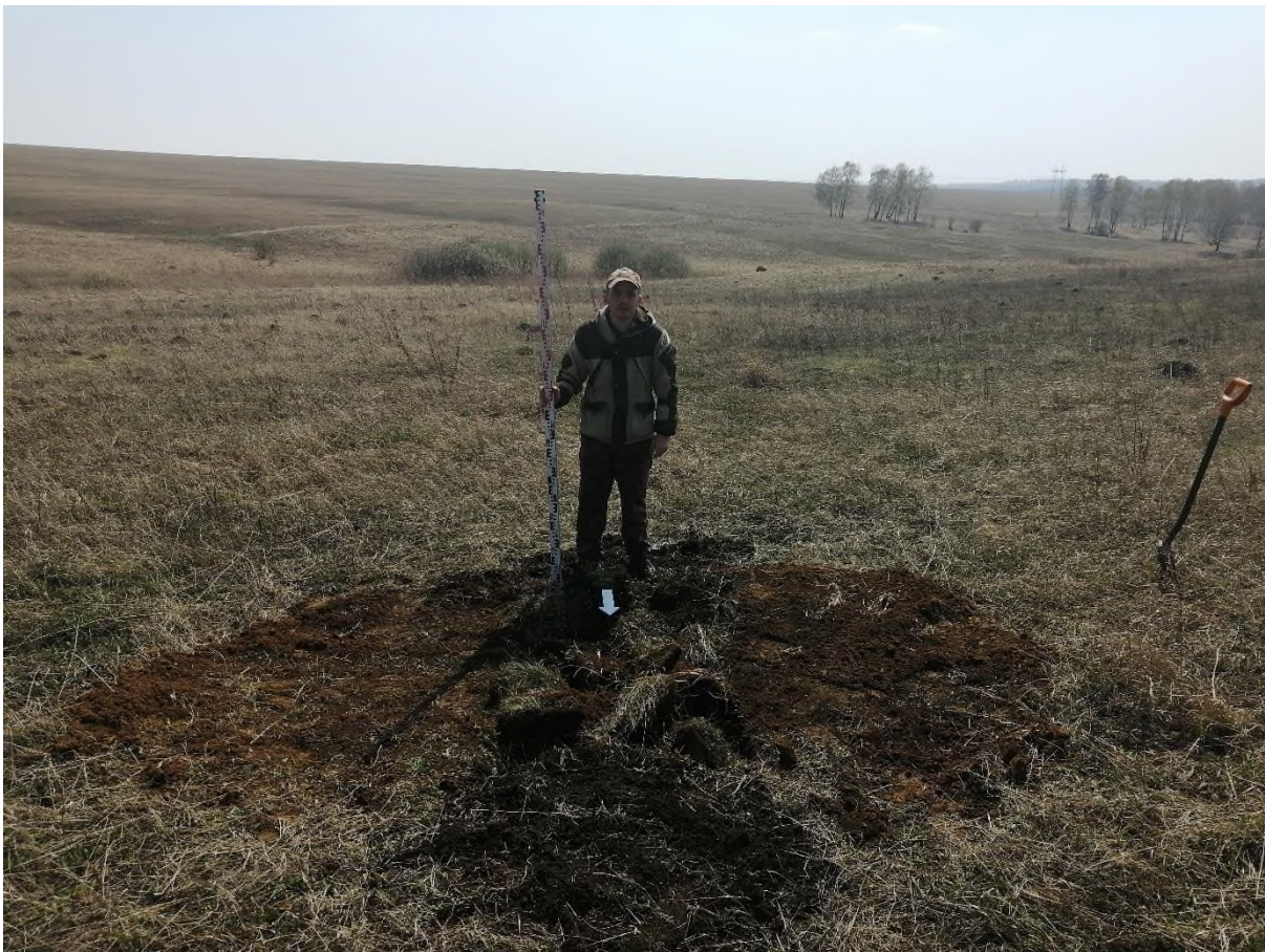
Рис. 234. «Строительство одной двухцепной отпайки .... КеНоТЭК». Шурф №31. Рекультивация. Фото с С.
