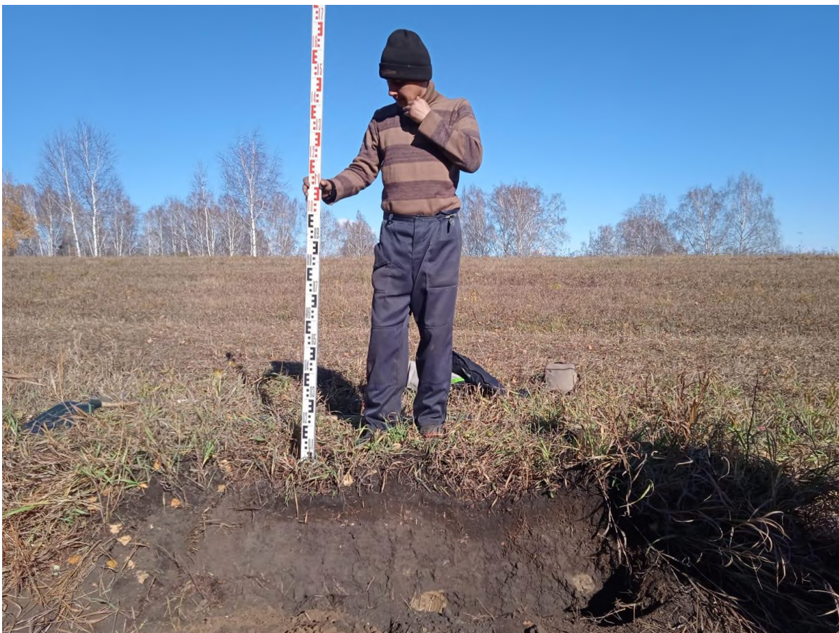
Рис. 197. «Строительство одной двухцепной отпайки .... КеНоТЭК». Шурф-врезка №22 после выборки. Фото с Ю.
