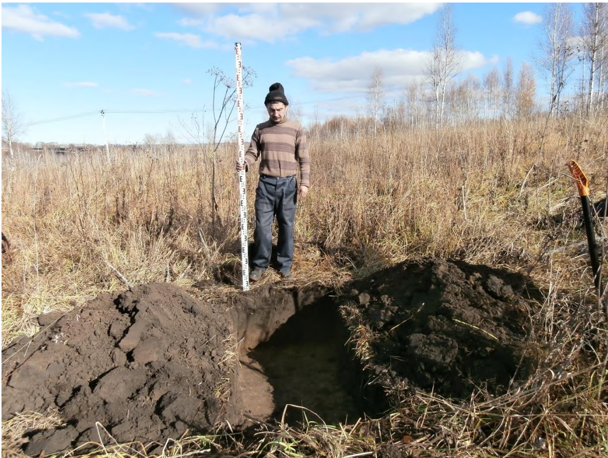
Рис. 204. «Строительство одной двухцепной отпайки .... КеНоТЭК». Шурф №24 после выборки. Фото с 3.
