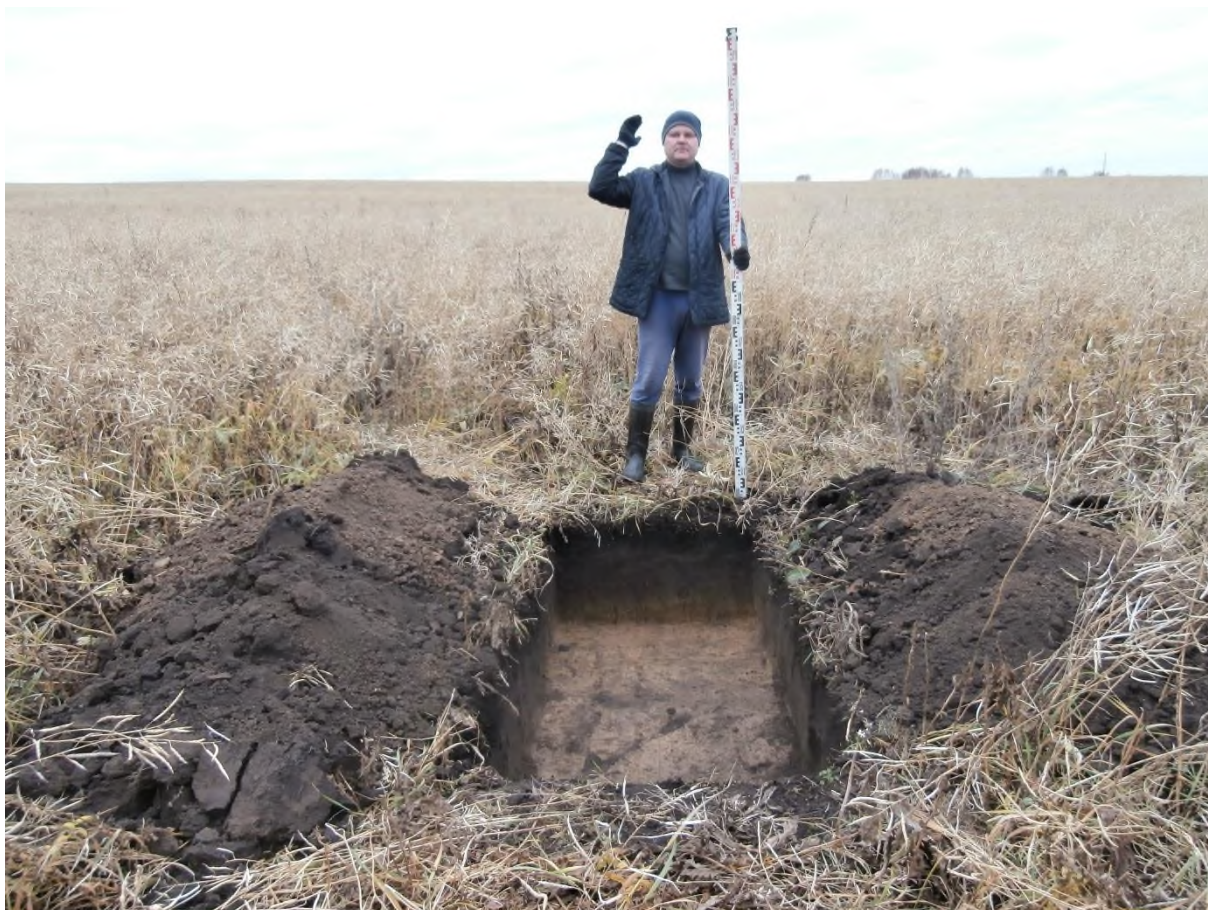
Рис. 181. «Строительство одной двухцепной отпайки .... КеНоТЭК». Шурф №18 после выборки. Фото с Ю.
