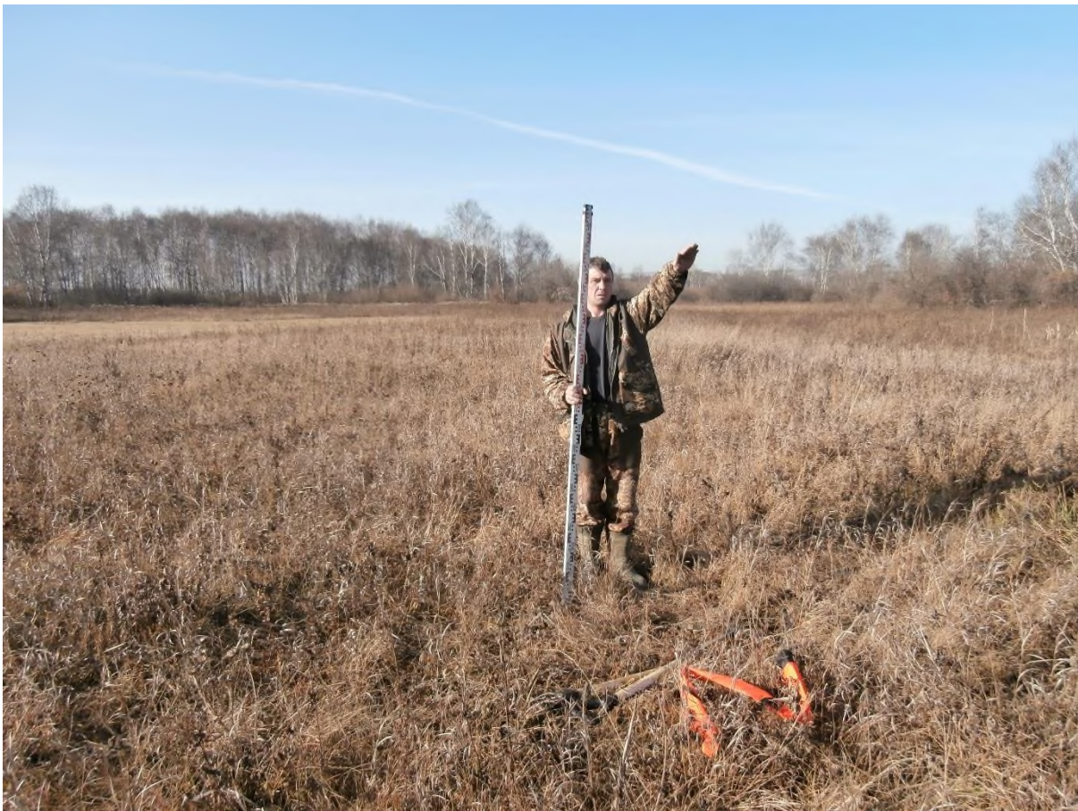
Рис. 117. «Строительство одной двухцепной отпайки .... КеНоТЭК». Шурф №2 (54°22'54.87"С, 86°44'24.77"В). Место закладки. Фото с С.
