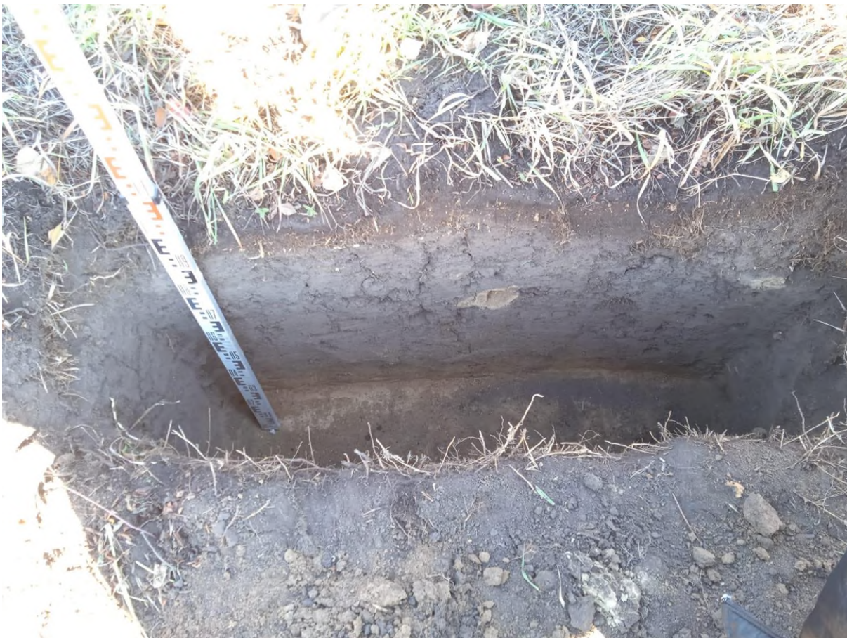
Рис. 198. «Строительство одной двухцепной отпайки .... КеНоТЭК». Шурф-врезка №22. Профиль северной стенки. Фото с Ю.
