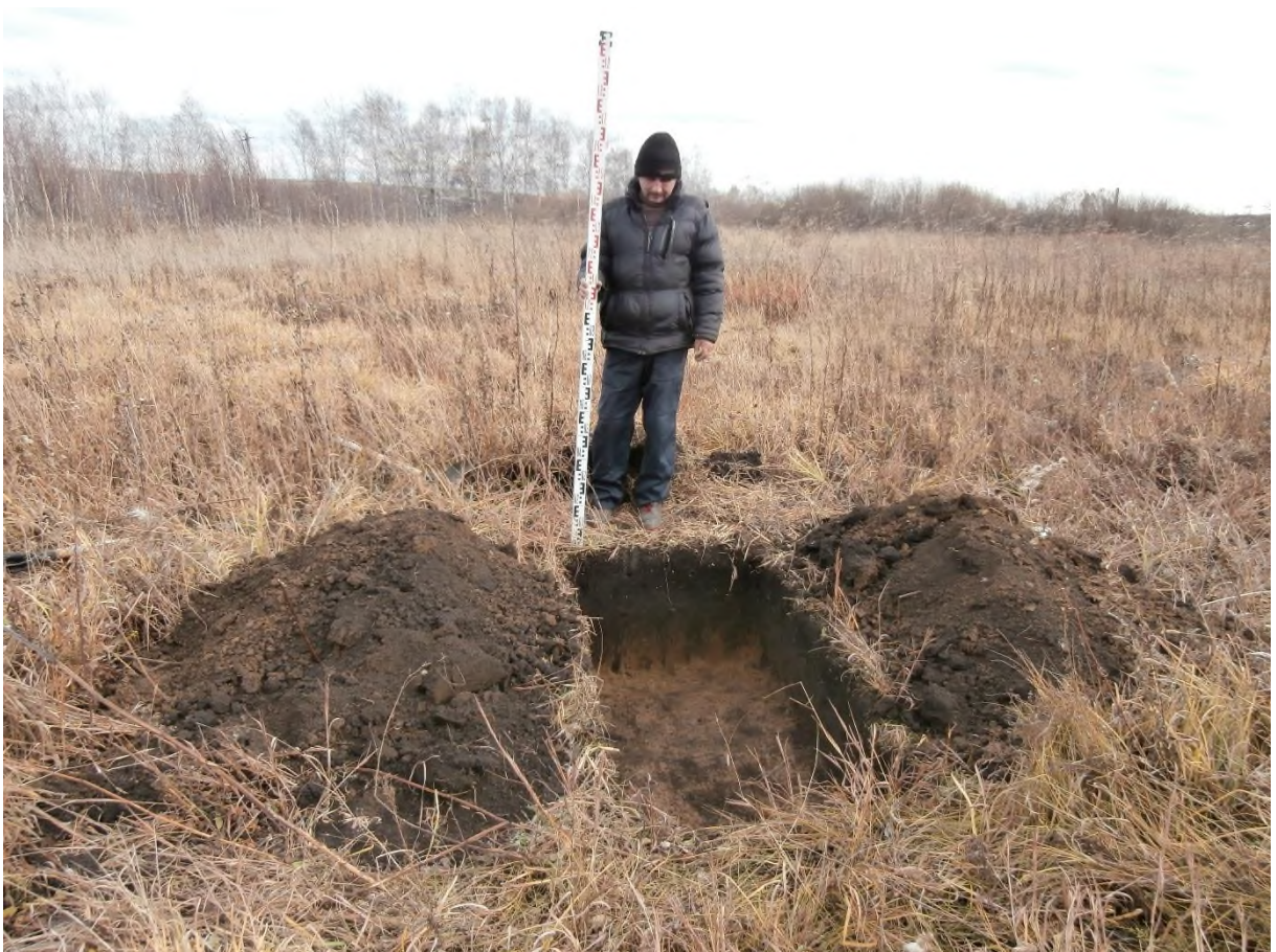
Рис. 126. «Строительство одной двухцепной отпайки .... КеНоТЭК». Шурф №4 после выборки. Фото с 3.
