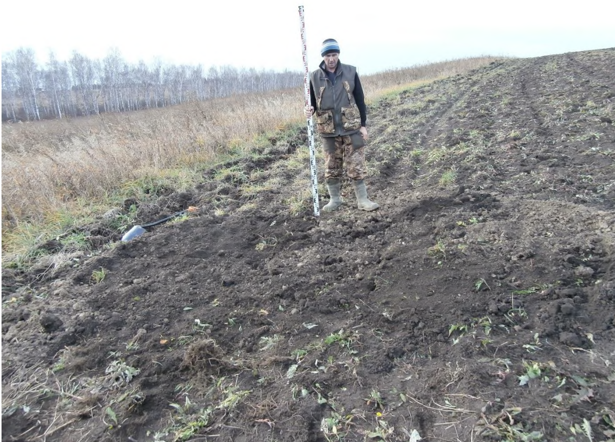
Рис. 134. «Строительство одной двухцепной отпайки .... КеНоТЭК». Шурф №6. Рекультивация. Фото с С.
