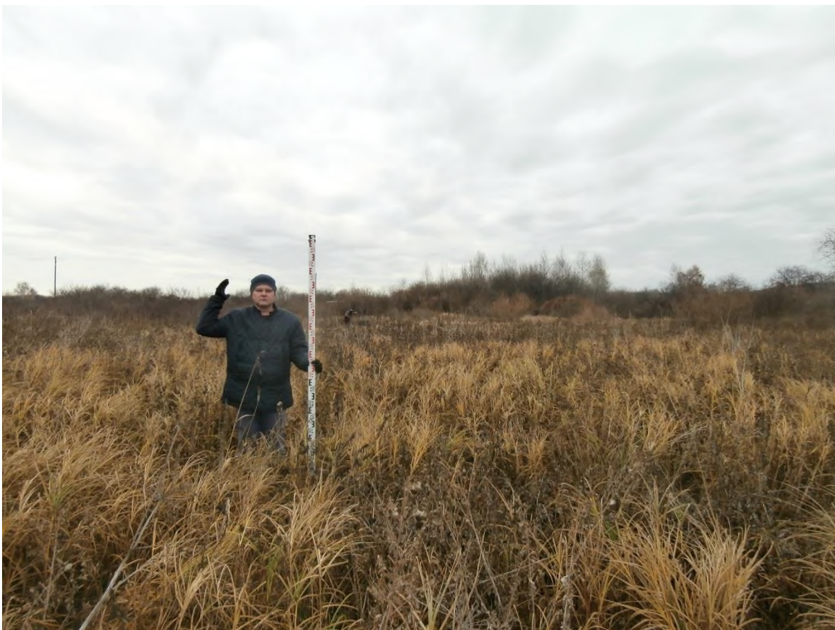
Рис. 48. «Строительство одной двухцепной отпайки .... КеНоТЭК». Точка фотофиксации №5 ( 54^{\circ}22'56.80''\text{С} , 86^{\circ}46'24.58''\text{В} ). Фото с ЮЗ.
