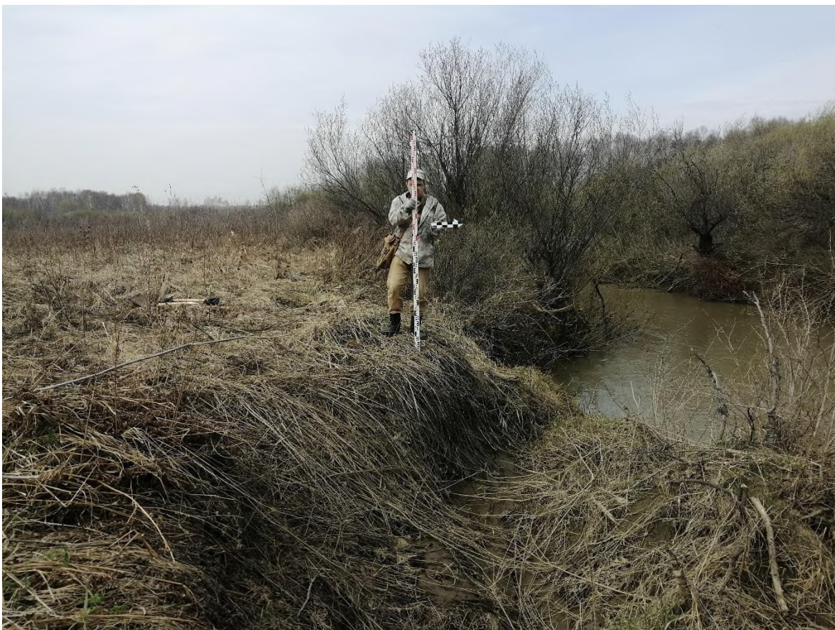
Рис. 283. «Строительство одной двухцепной отпайки .... КеНоТЭК». Место производства зачистки №8 ( 54^{\circ}24'54.94''\text{C} , 86^{\circ}42'43.13''\text{B} ). Фото с В.
