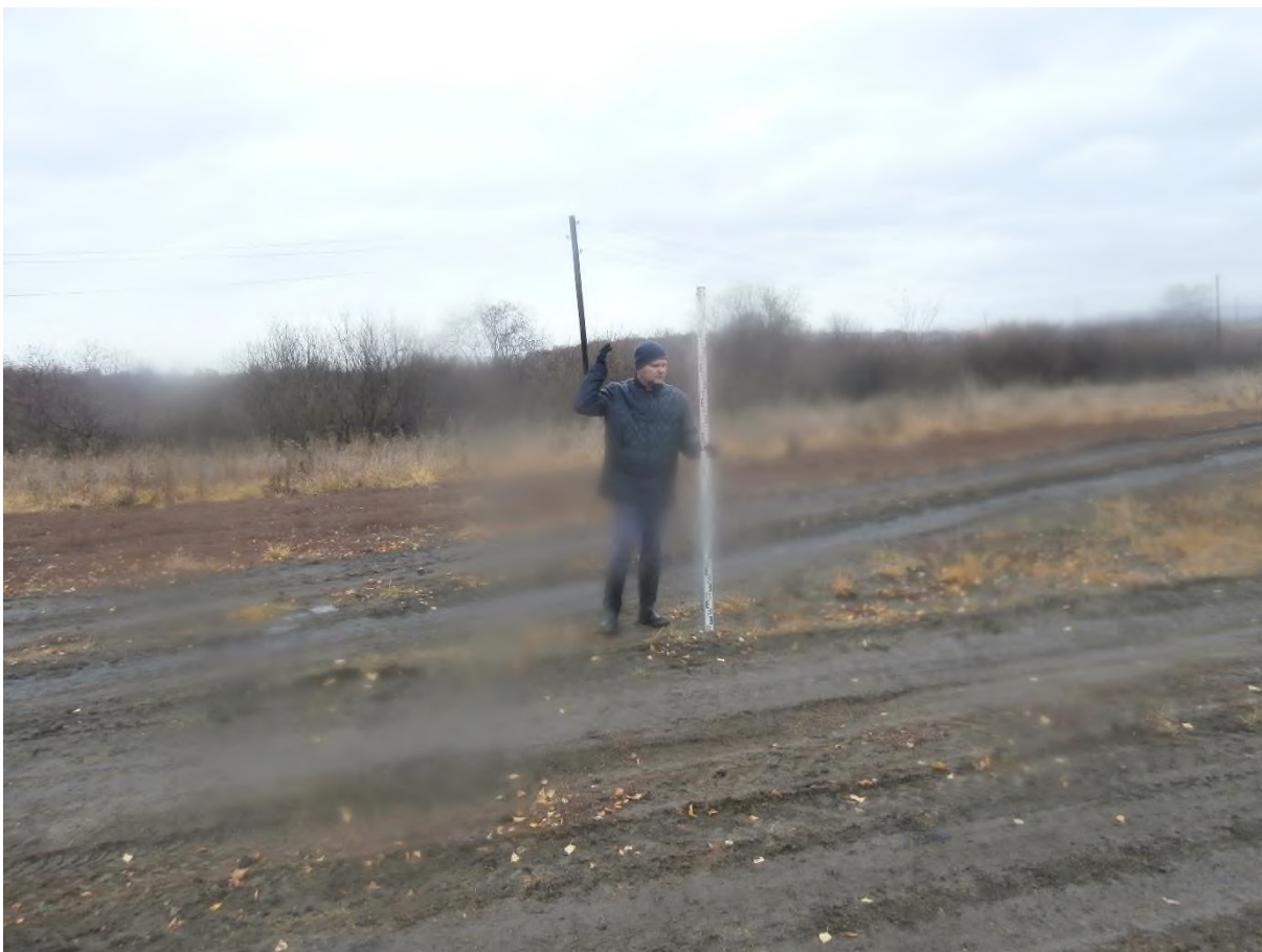
Рис. 46. «Строительство одной двухцепной отпайки .... КеНоТЭК». Точка фотофиксации №4 ( 54^{\circ}23'0.61''\text{С} , 86^{\circ}46'28.14''\text{В} ). Фото с ЮЗ.
