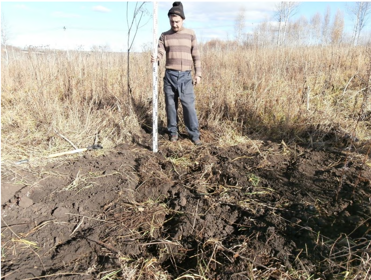
Рис. 206. «Строительство одной двухцепной отпайки .... КеНоТЭК». Шурф №24. Рекультивация. Фото с 3.
