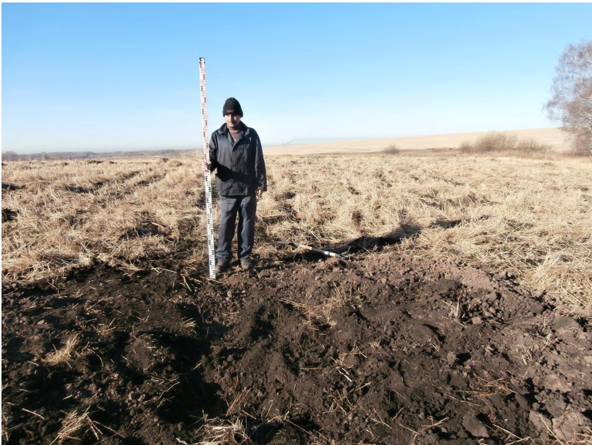
Рис. 214. «Строительство одной двухцепной отпайки .... КеНоТЭК». Шурф №26. Рекультивация. Фото с В.
