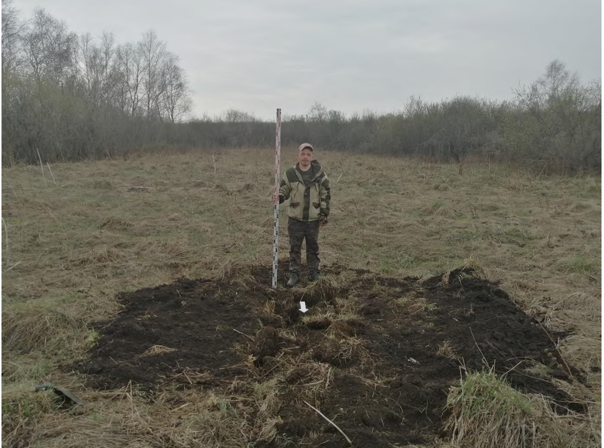
Рис. 258. «Строительство одной двухцепной отпайки .... КеНоТЭК». Шурф №37. Рекультивация. Фото с С.
