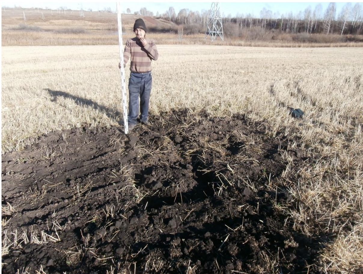
Рис. 191. «Строительство одной двухцепной отпайки .... КеНоТЭК». Шурф №20. Рекультивация. Фото с Ю.
