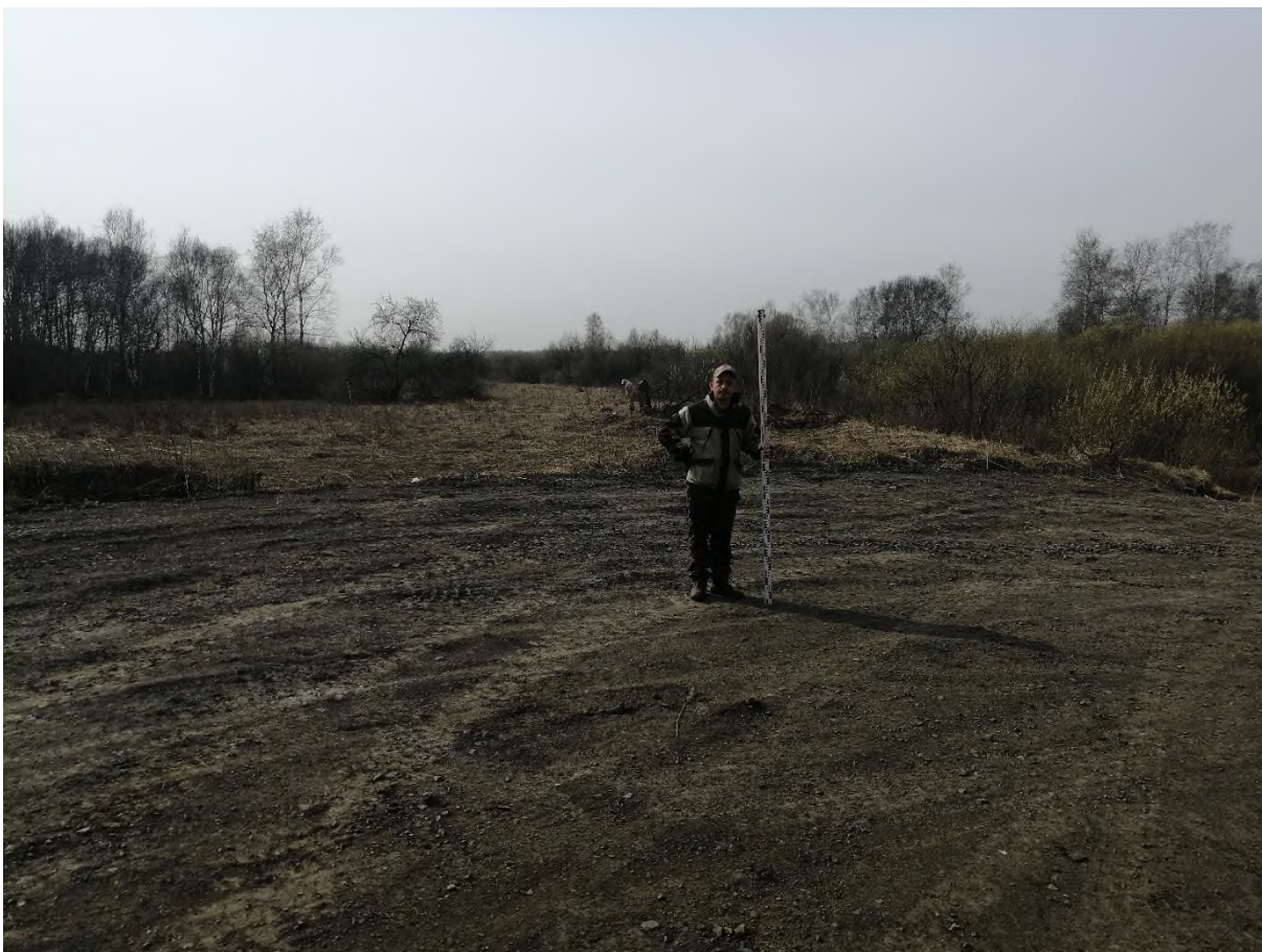
Рис. 100. «Строительство одной двухцепной отпайки .... КеНоТЭК». Точка фотофиксации №31 ( 54^{\circ}24'46.67''\text{С} , 86^{\circ}42'50.41''\text{В} ). Фото с ССВ.
