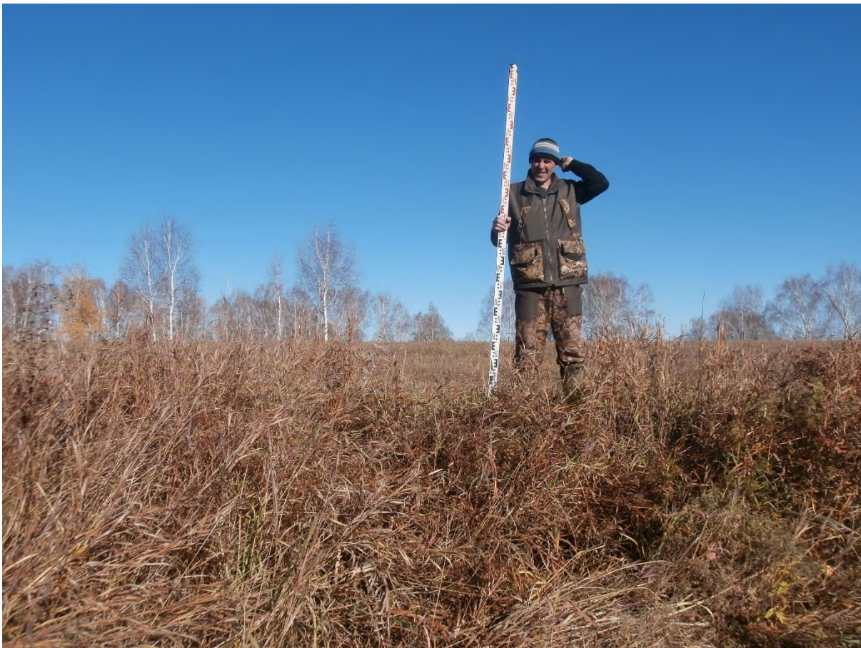
Рис. 196. «Строительство одной двухцепной отпайки .... КеНоТЭК». Шурф-врезка №22 ( 54^{\circ}27'0.32''\text{С} , 86^{\circ}39'39.61''\text{В} ). Место закладки. Фото с Ю.
