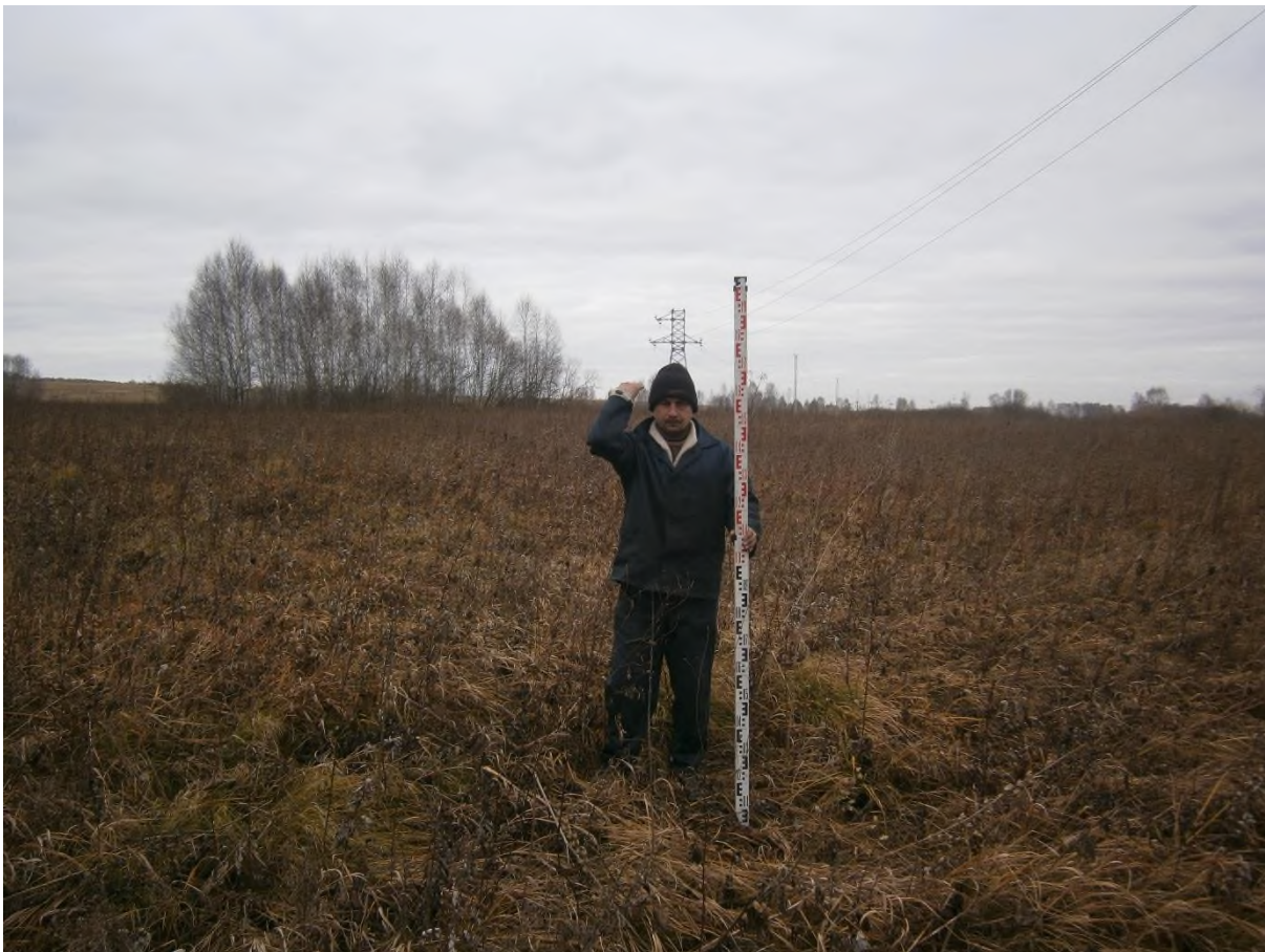
Рис. 167. «Строительство одной двухцепной отпайки .... КеНоТЭК». Шурф №15 ( 54^{\circ}25'43.14''\text{С} , 86^{\circ}41'29.35''\text{В} ). Место закладки. Фото с Ю.
