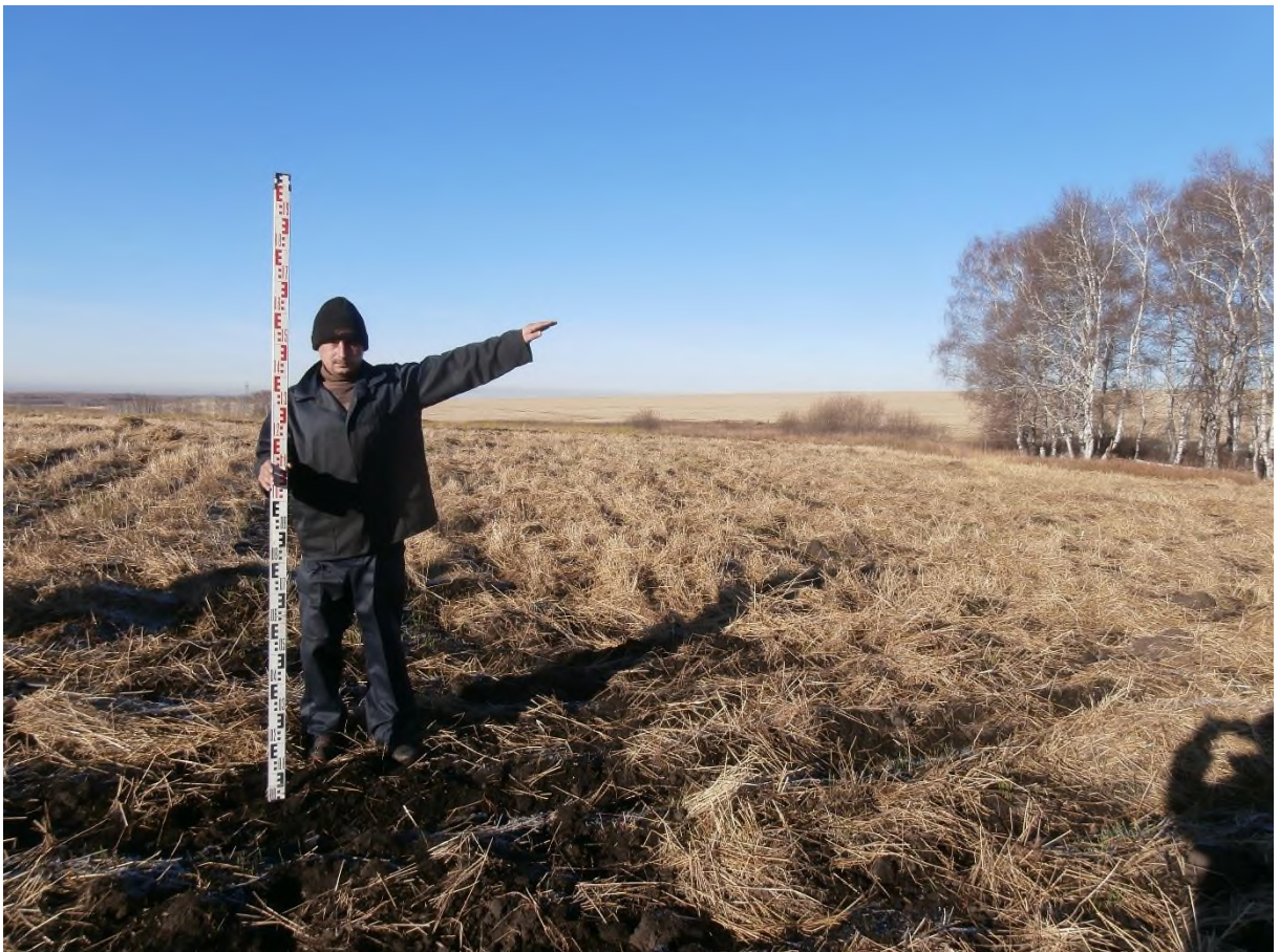
Рис. 211. «Строительство одной двухцепной отпайки .... КеНоТЭК». Шурф №26 ( 54^{\circ}27'17.86''\text{С} , 86^{\circ}37'35.35''\text{В} ). Место закладки. Фото с В.
