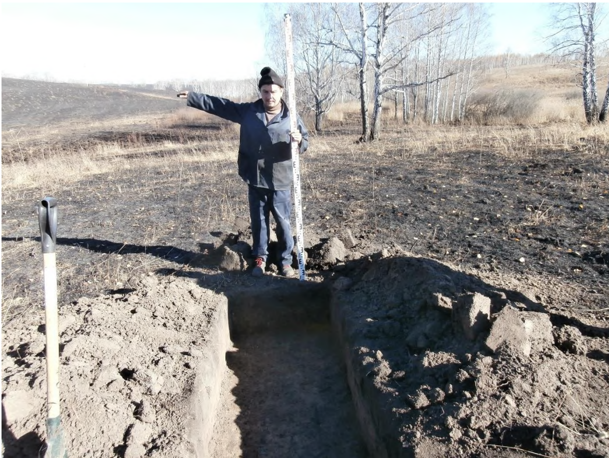
Рис. 208. «Строительство одной двухцепной отпайки .... КеНоТЭК». Шурф №25 после выборки. Фото с 3.
