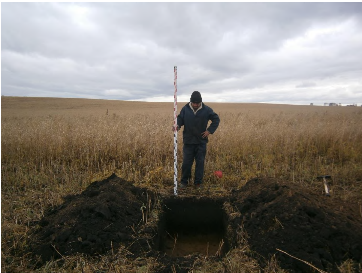
Рис. 173. «Строительство одной двухцепной отпайки .... КеНоТЭК». Шурф №16 после выборки. Фото с Ю.
