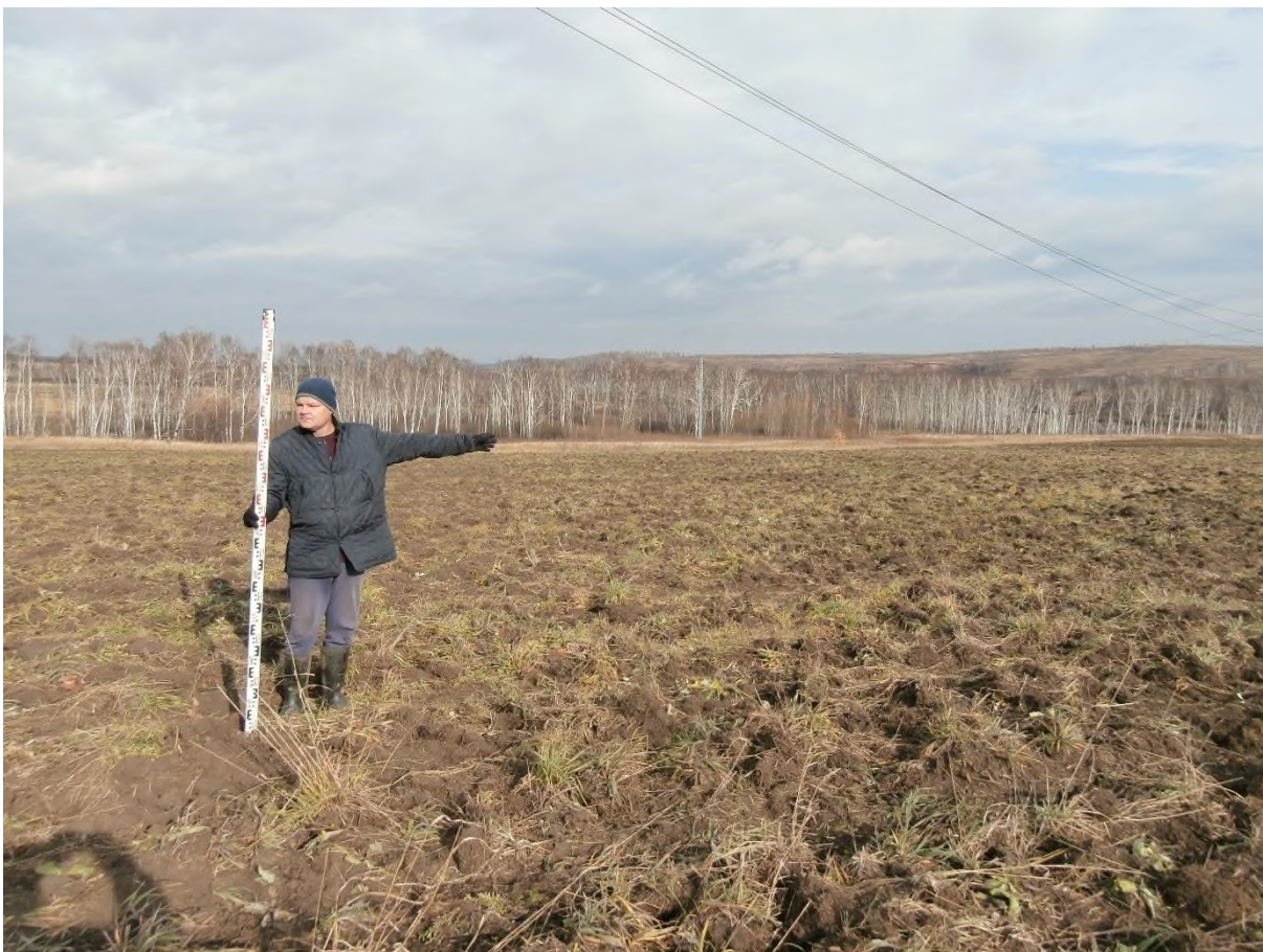
Рис. 68. «Строительство одной двухцепной отпайки .... КеНоТЭК». Точка фотофиксации №15 ( 54^{\circ}24'32.31''\text{С} , 86^{\circ}42'23.98''\text{В} ). Фото с ЮВ.
