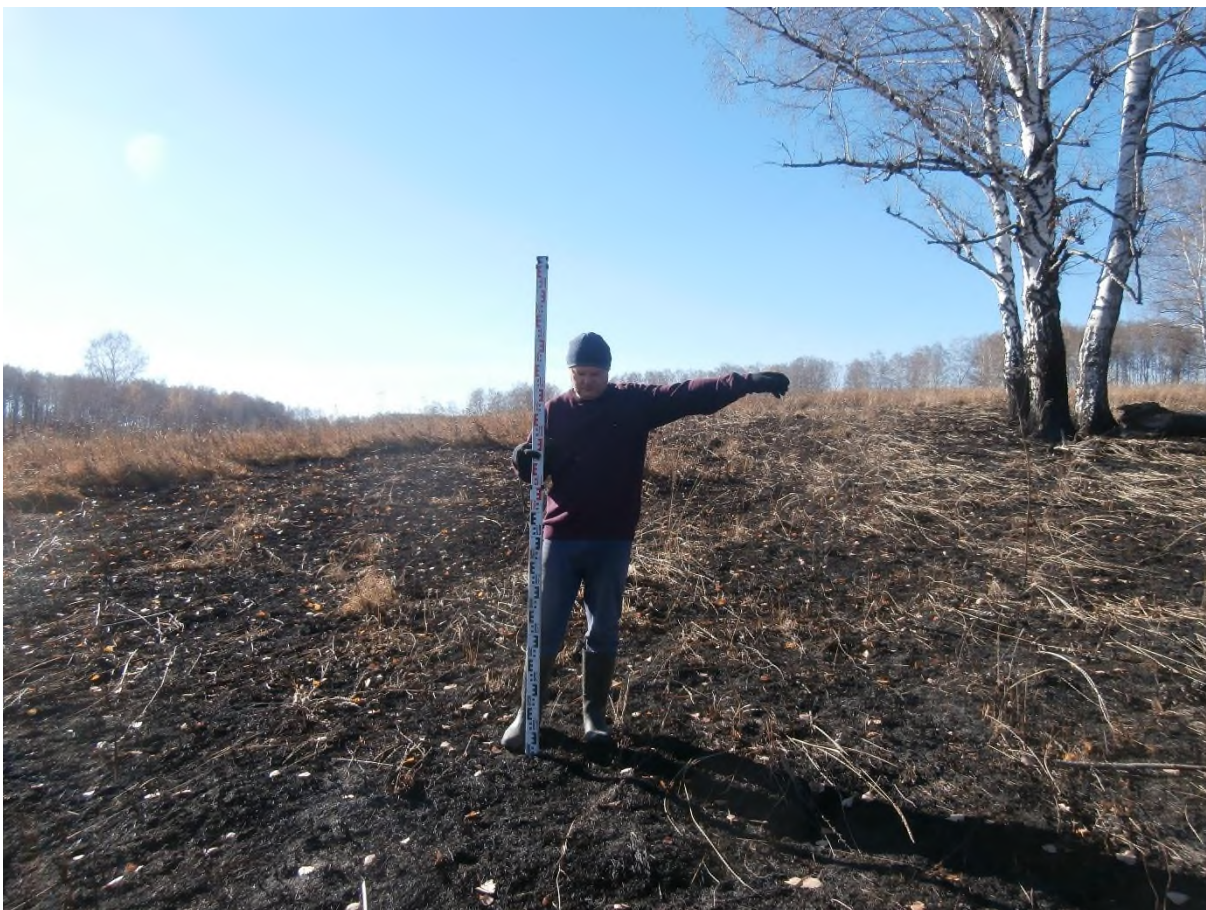
Рис. 207. «Строительство одной двухцепной отпайки .... КеНоТЭК». Шурф №25 (54°27'13.97"С, 86°38'9.89"В). Место закладки. Фото с В.
