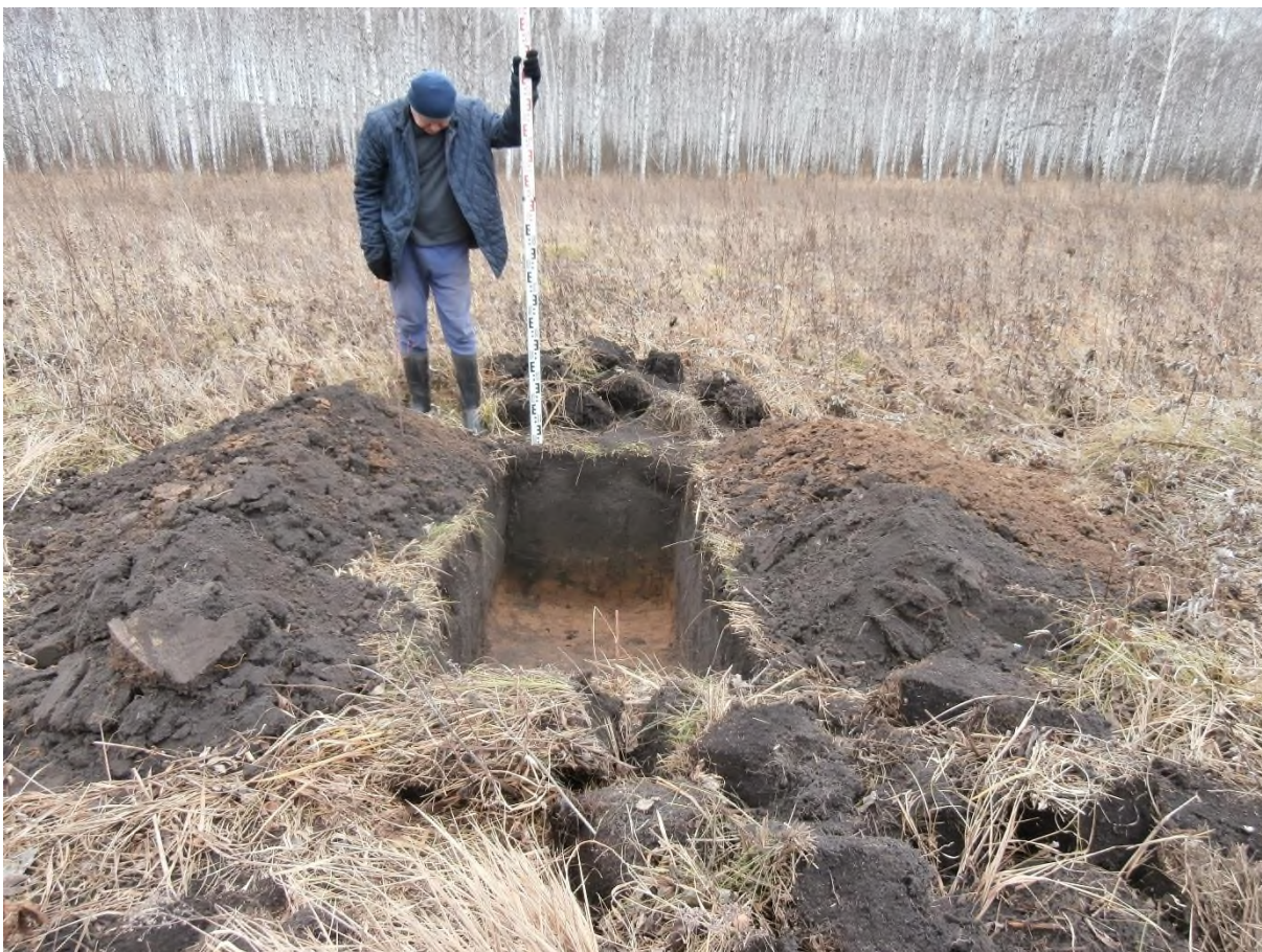
Рис. 164. «Строительство одной двухцепной отпайки .... КеНоТЭК». Шурф №14 после выборки. Фото с С.
