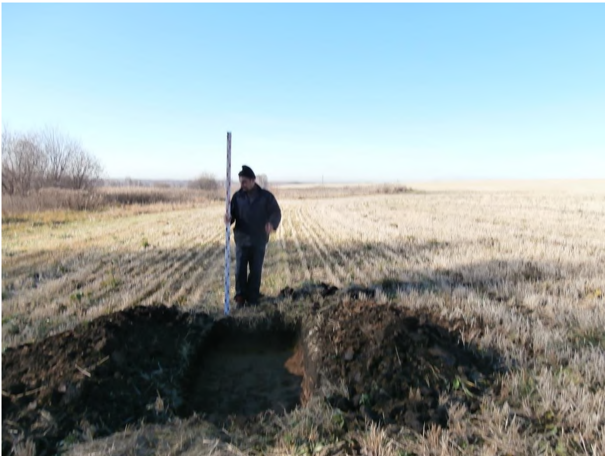
Рис. 216. «Строительство одной двухцепной отпайки .... КеНоТЭК». Шурф №27 после выборки. Фото с В.
