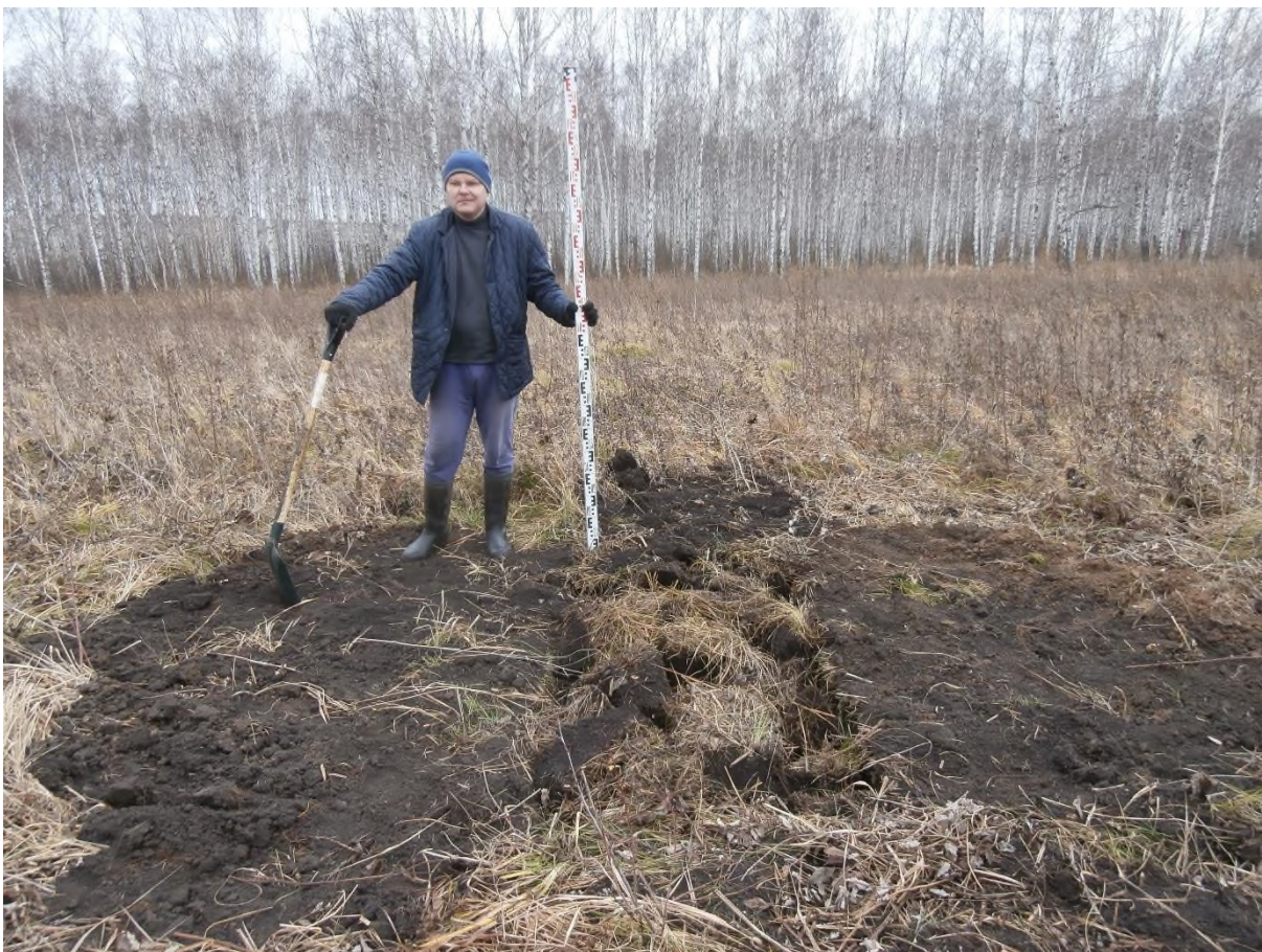
Рис. 166. «Строительство одной двухцепной отпайки .... КеНоТЭК». Шурф №14. Рекультивация. Фото с С.
