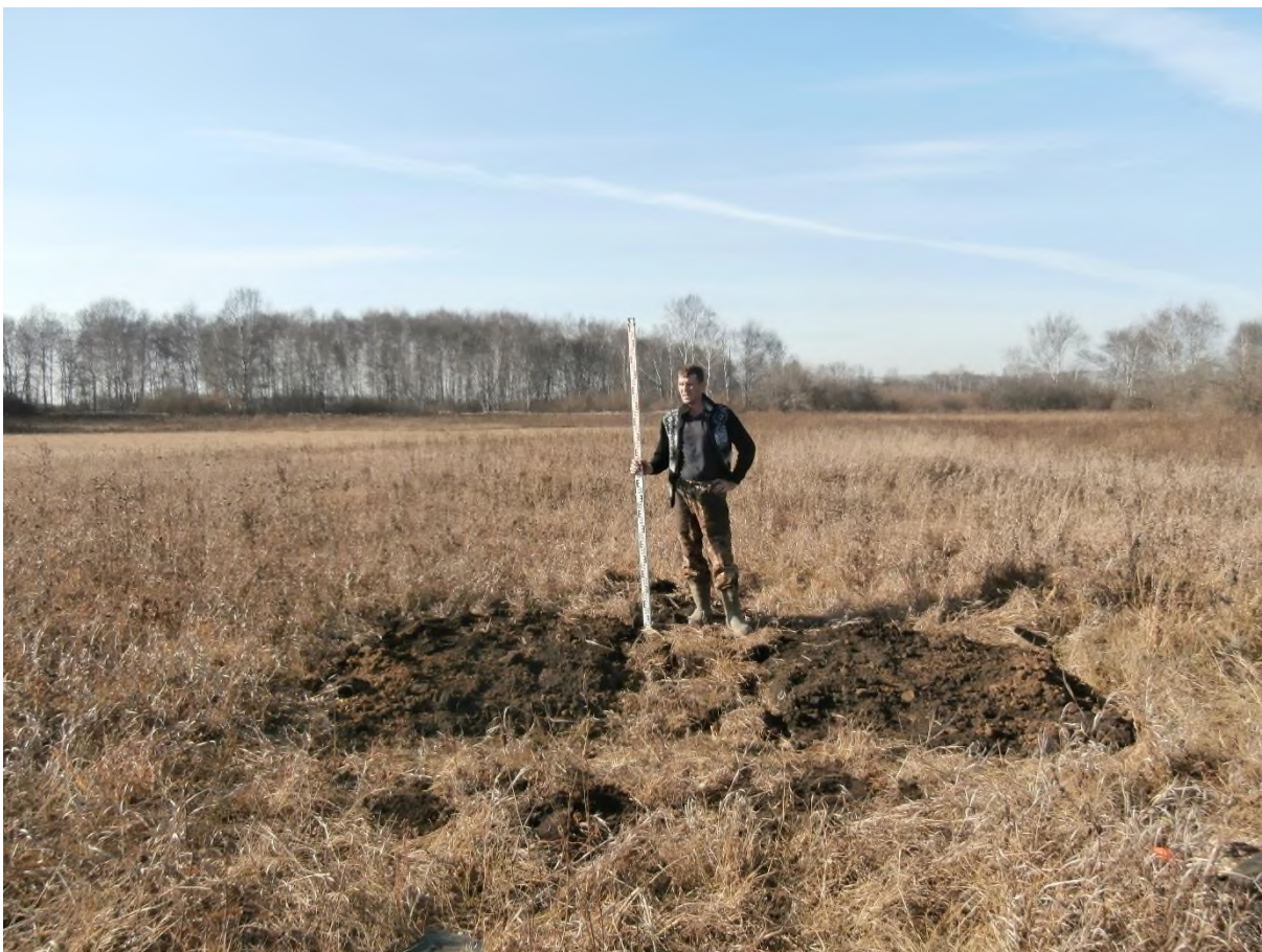
Рис. 120. «Строительство одной двухцепной отпайки .... КеНоТЭК». Шурф №2. Рекультивация. Фото с С.
