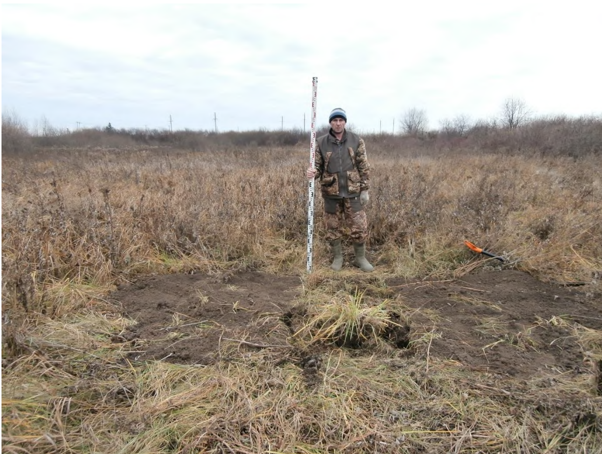
Рис. 116. «Строительство одной двухцепной отпайки .... КеНоТЭК». Шурф №1. Рекультивация. Фото с В.
