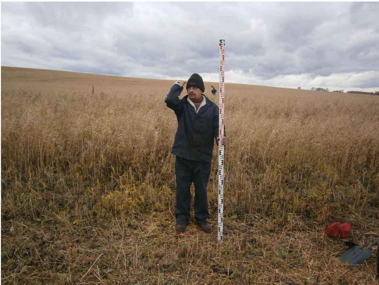
Рис. 172. «Строительство одной двухцепной отпайки .... КеНоТЭК». Шурф №16 ( 54^{\circ}25'52.48''\text{С} , 86^{\circ}41'10.29''\text{В} ). Место закладки. Фото с Ю.
