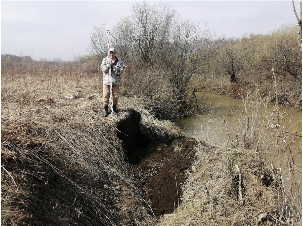
Рис. 284. «Строительство одной двухцепной отпайки .... КеНоТЭК». Зачистка №8 после производства работ. Фото с В.
