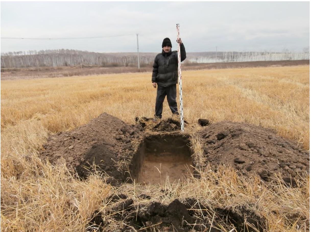
Рис. 156. «Строительство одной двухцепной отпайки .... КеНоТЭК». Шурф №12 после выборки. Фото с С.
