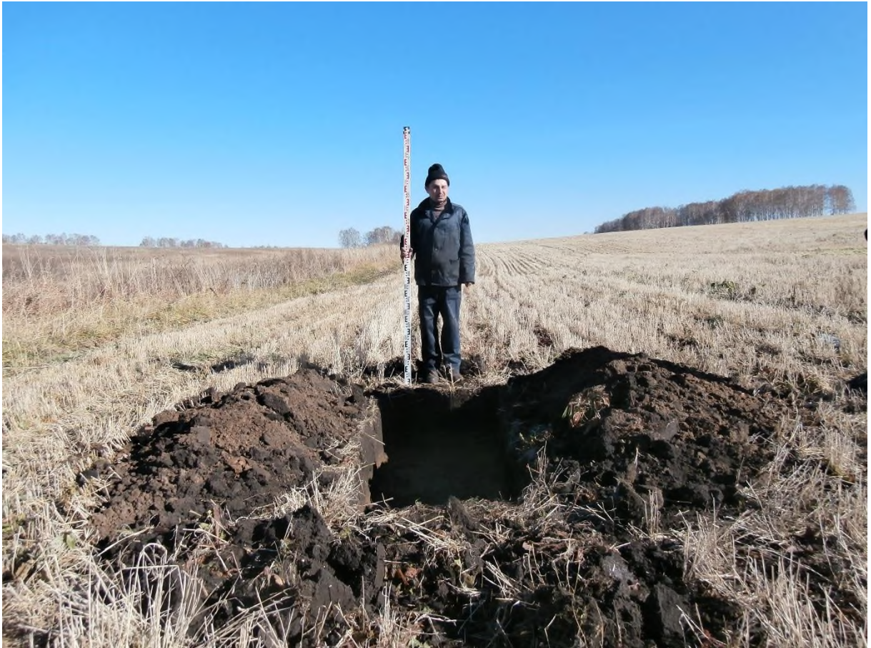
Рис. 220. «Строительство одной двухцепной отпайки .... КеНоТЭК». Шурф №28 после выборки. Фото с Ю.
