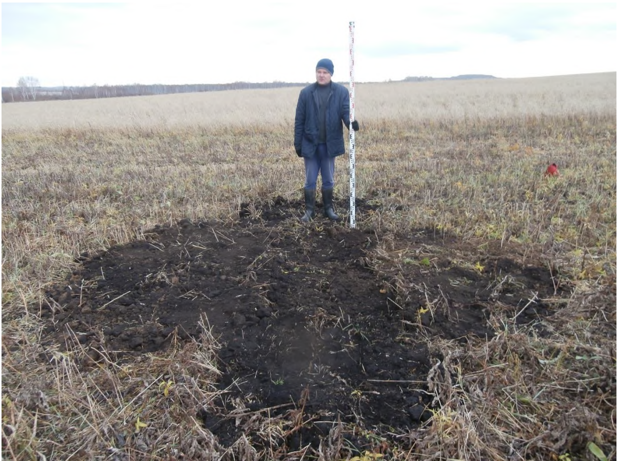
Рис. 179. «Строительство одной двухцепной отпайки .... КеНоТЭК». Шурф №17. Рекультивация. Фото с С.
