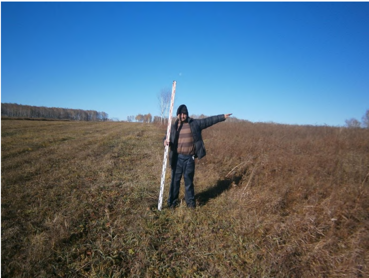
Рис. 192. «Строительство одной двухцепной отпайки .... КеНоТЭК». Шурф №21 ( 54^{\circ}26'58.26''\text{С} , 86^{\circ}39'57.12''\text{В} ). Место закладки. Фото с В.
