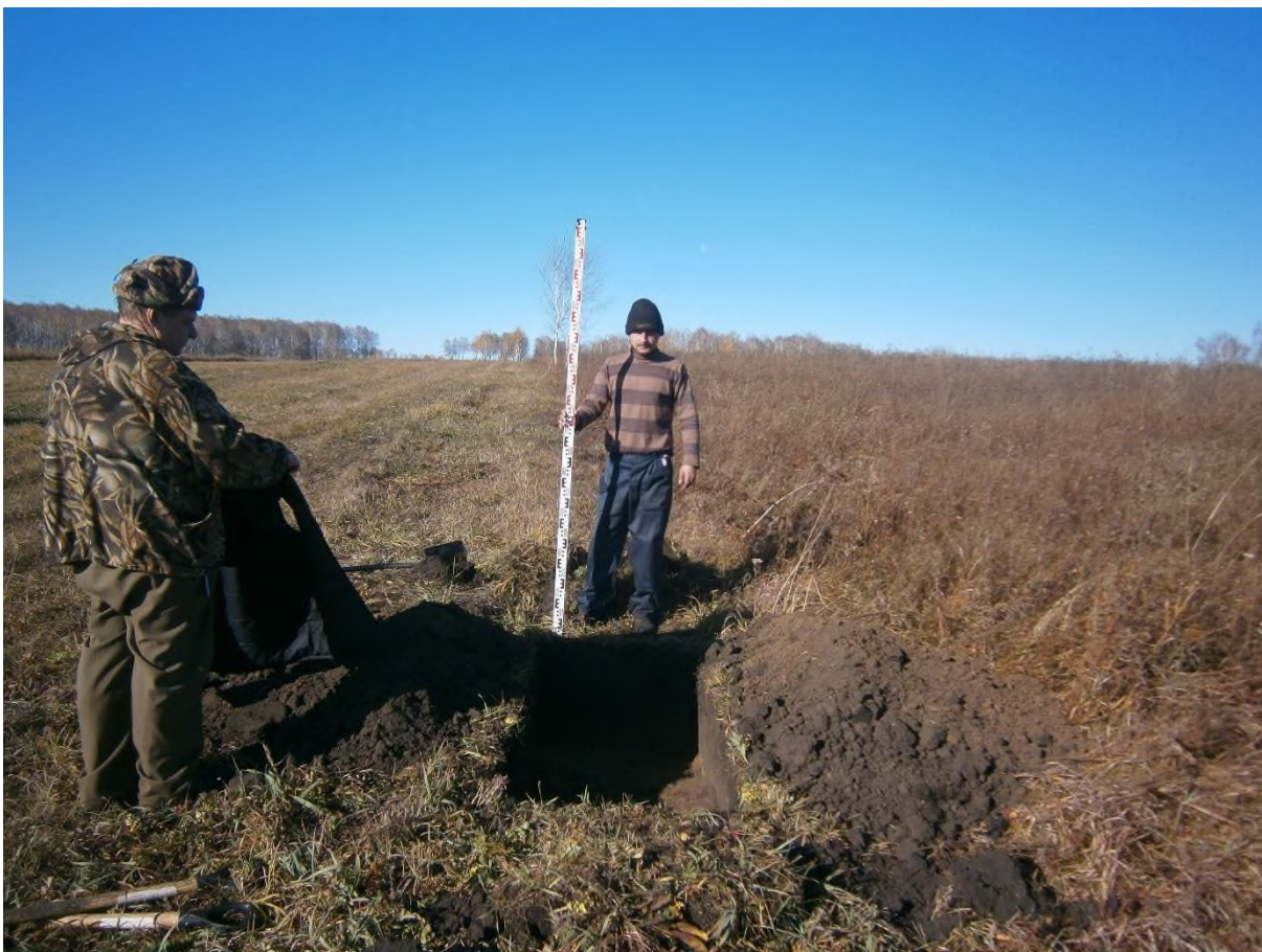
Рис. 193. «Строительство одной двухцепной отпайки .... КеНоТЭК». Шурф №21 после выборки. Фото с В.
