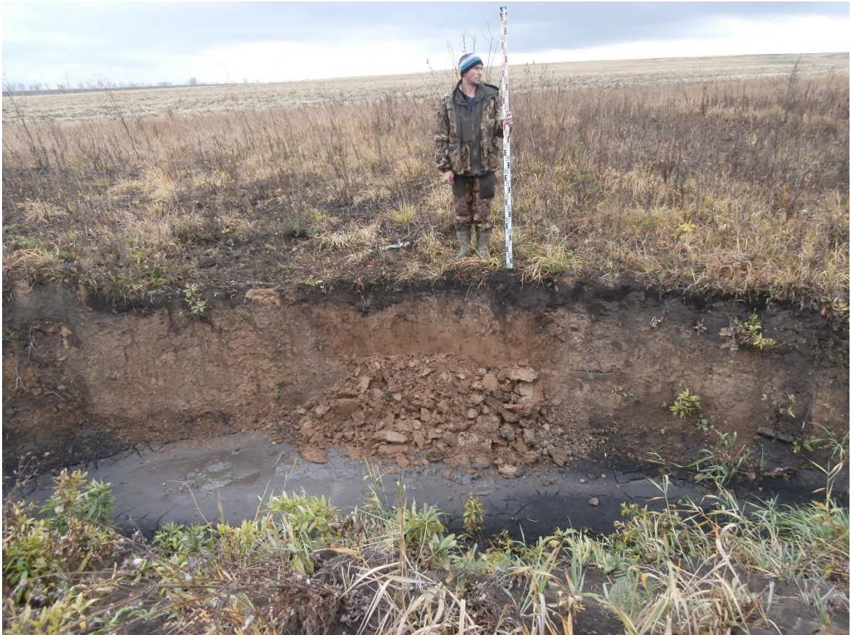
Рис. 278. «Строительство одной двухцепной отпайки .... КеНоТЭК». Зачистка №6 после производства работ. Фото с С.
