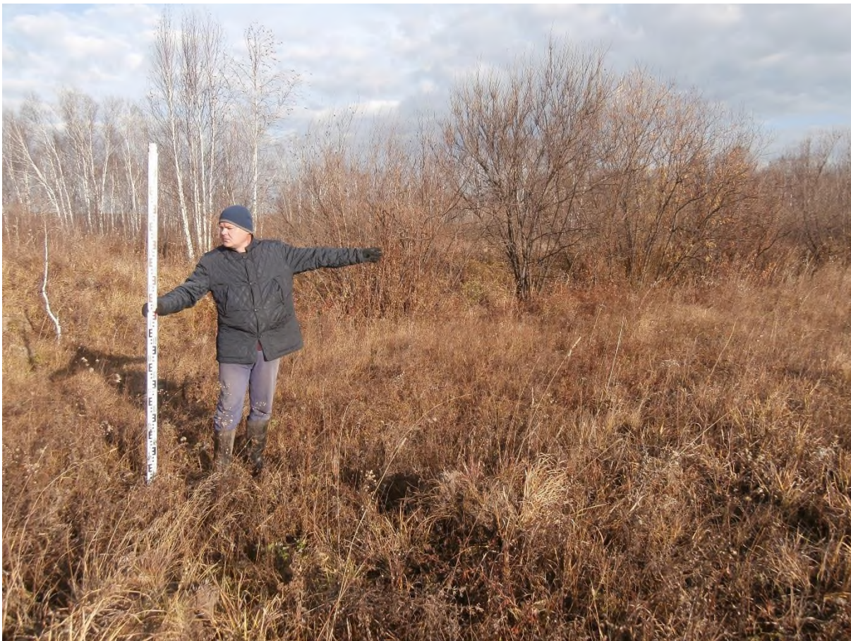
Рис. 59. «Строительство одной двухцепной отпайки .... КеНоТЭК». Точка фотофиксации №11 ( 54^{\circ}23'24.93''\text{С} , 86^{\circ}43'26.56''\text{В} ). Фото с ССЗ.
