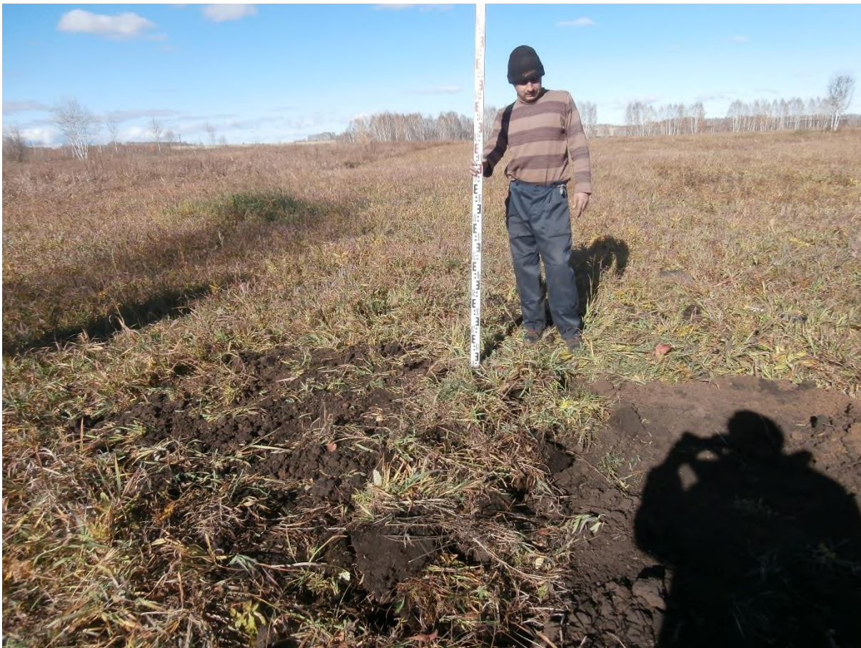
Рис. 202. «Строительство одной двухцепной отпайки .... КеНоТЭК». Шурф №23. Рекультивация. Фото с Ю.
