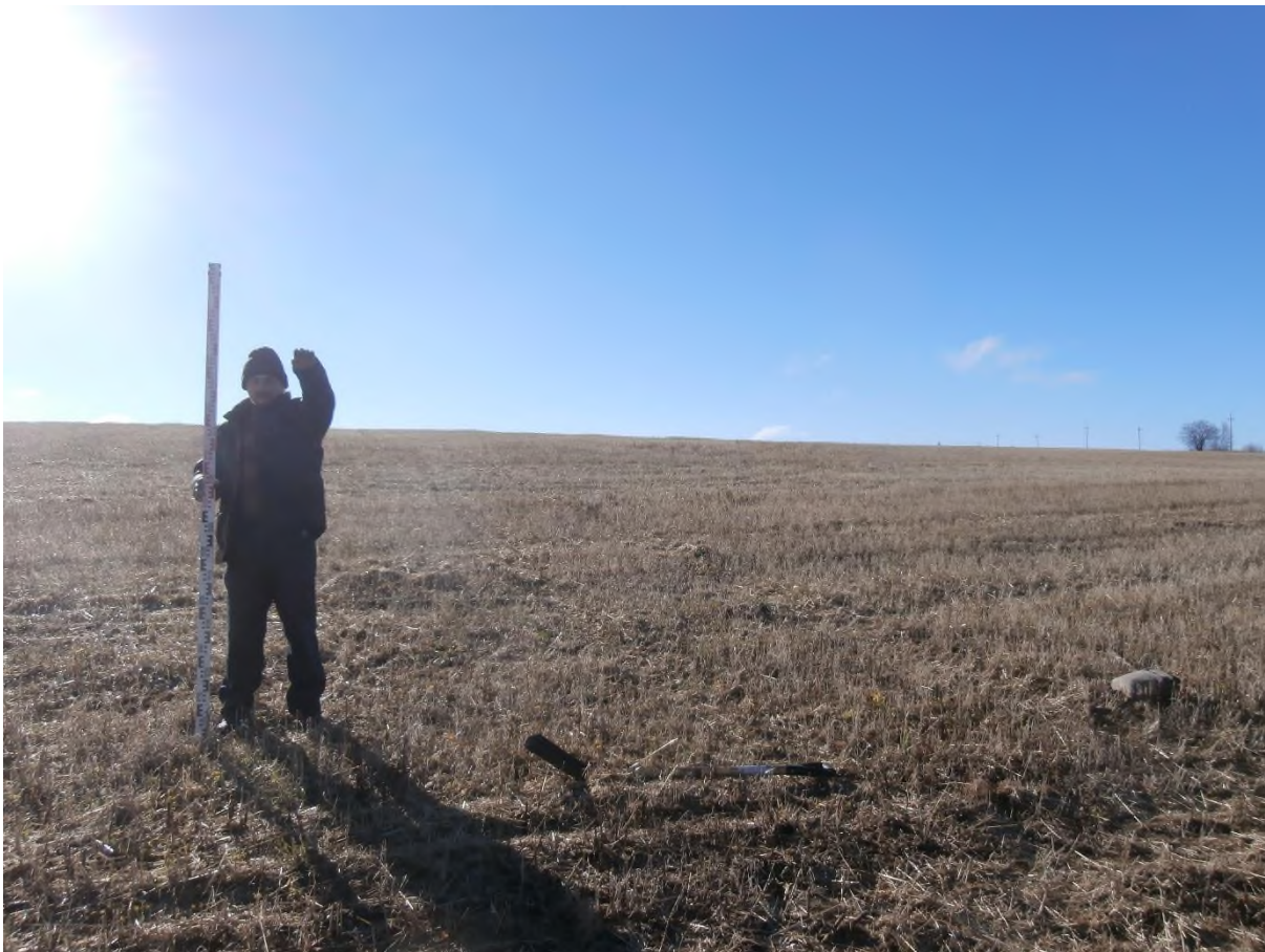
Рис. 81. «Строительство одной двухцепной отпайки .... КеНоТЭК». Точка фотофиксации №22 ( 54^{\circ}26'51.53''\text{С} , 86^{\circ}40'31.64''\text{В} ). Фото с С.
