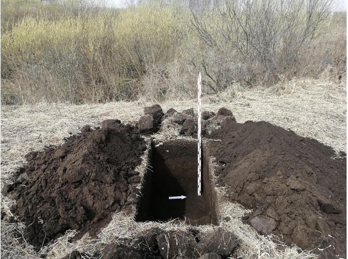
Рис. 252. «Строительство одной двухцепной отпайки .... КеНоТЭК». Шурф №36 после выборки. Фото с В.
