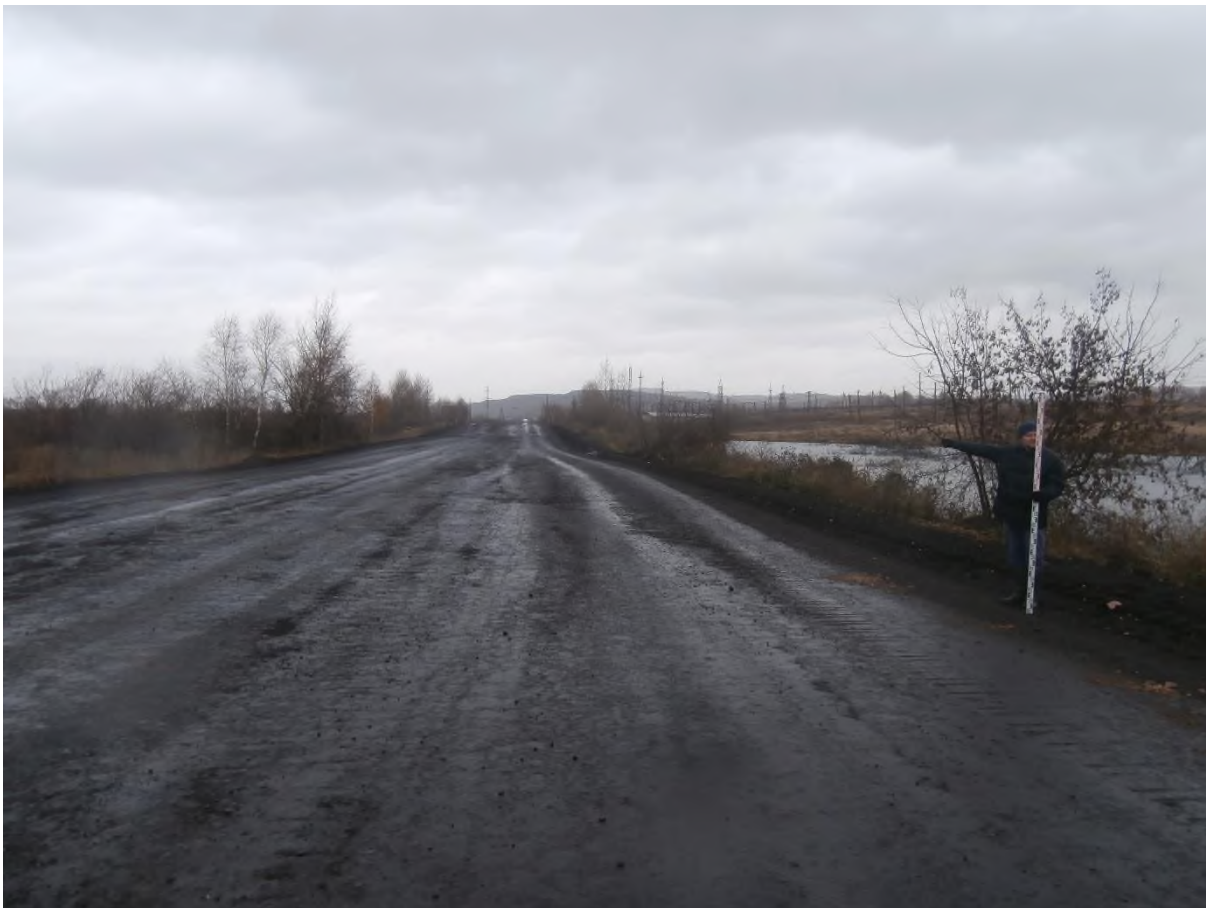
Рис. 41. «Строительство одной двухцепной отпайки .... КеНоТЭК». Точка фотофиксации №2 ( 54^{\circ}23'32.21''\text{С} , 86^{\circ}46'51.17''\text{В} ). Фото с З.
