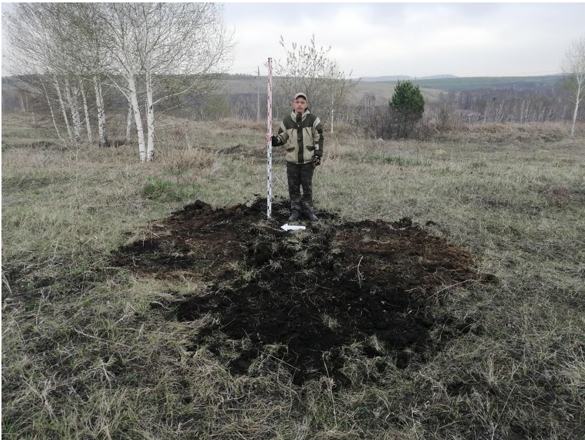
Рис. 262. «Строительство одной двухцепной отпайки .... КеНоТЭК». Шурф №38. Рекультивация. Фото с 3.
