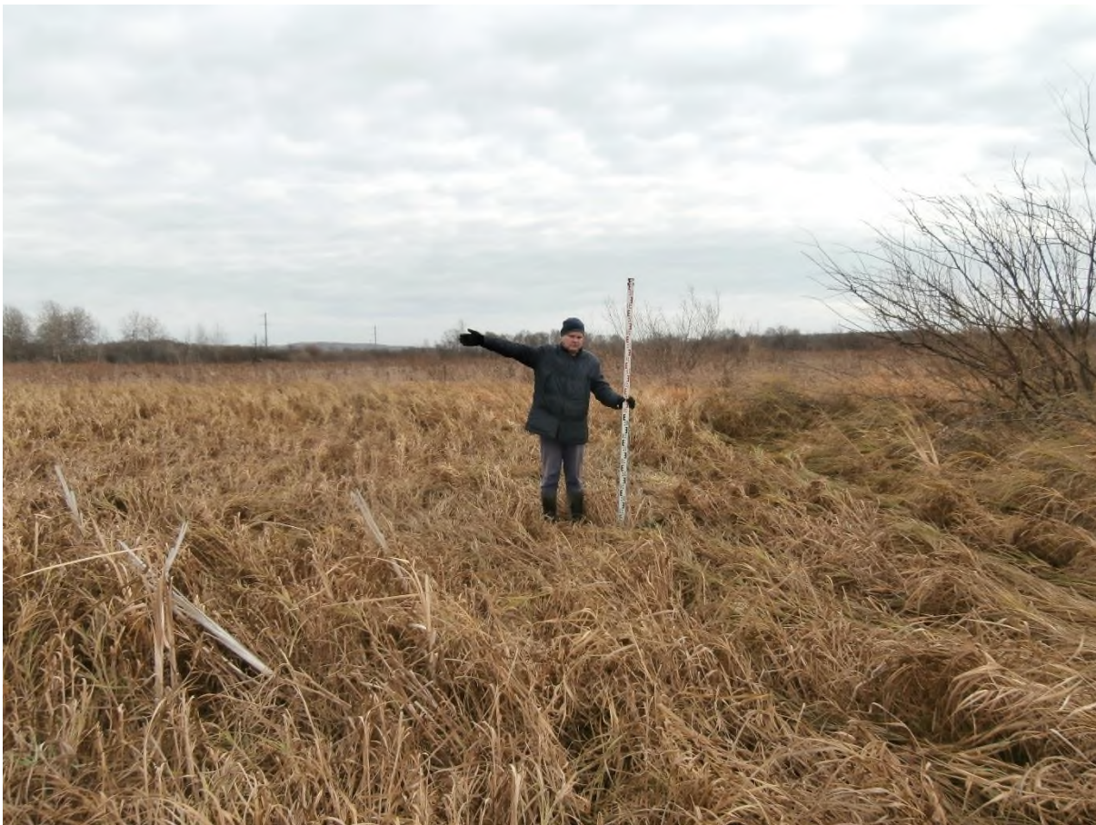
Рис. 57. «Строительство одной двухцепной отпайки .... КеНоТЭК». Точка фотофиксации №10 ( 54^{\circ}23'12.29''\text{С} , 86^{\circ}43'40.98''\text{В} ). Фото с СЗ.
