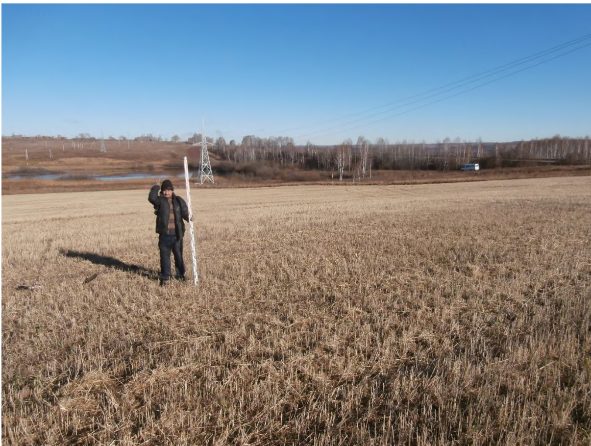
Рис. 82. «Строительство одной двухцепной отпайки .... КеНоТЭК». Точка фотофиксации №22 ( 54^{\circ}26'51.53''\text{С} , 86^{\circ}40'31.64''\text{В} ). Фото с Ю.
