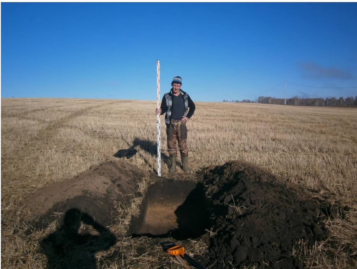
Рис. 185. «Строительство одной двухцепной отпайки .... КеНоТЭК». Шурф №19 после выборки. Фото с Ю.
