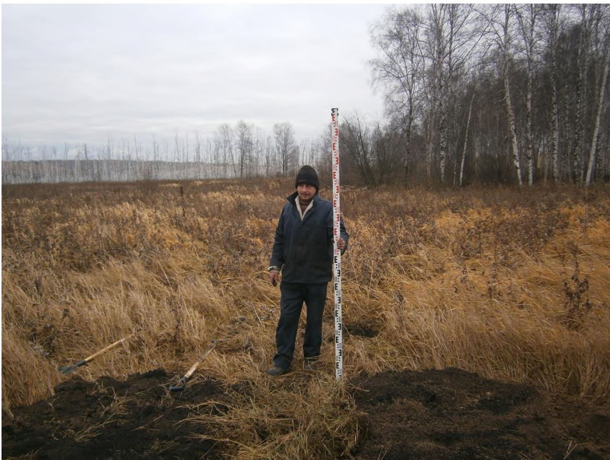
Рис. 154. «Строительство одной двухцепной отпайки .... КеНоТЭК». Шурф №11. Рекультивация. Фото с С.
