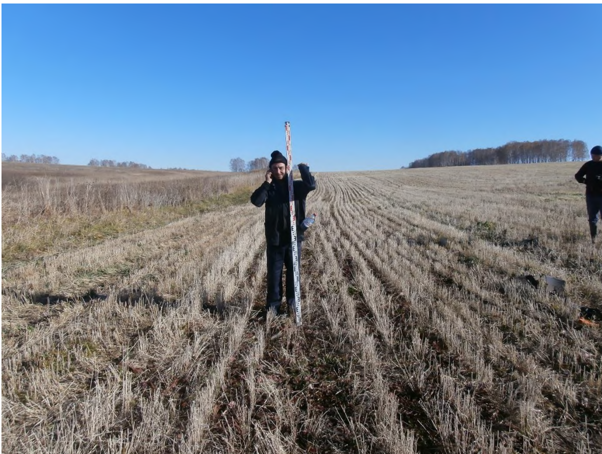
Рис. 219. «Строительство одной двухцепной отпайки .... КеНоТЭК». Шурф №28 (54°27'39.04"С, 86°36'50.38"В). Место закладки. Фото с Ю.
