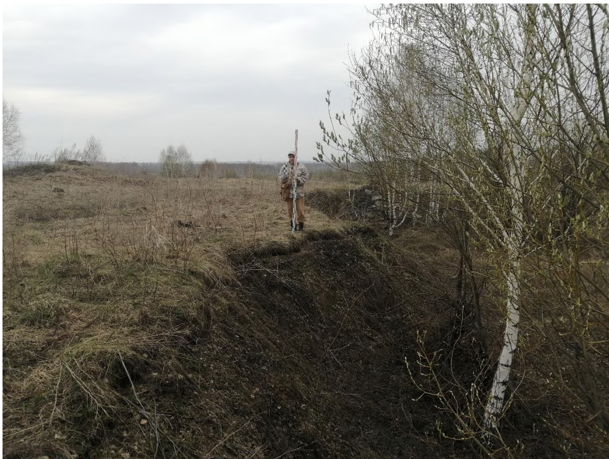
Рис. 289. «Строительство одной двухцепной отпайки .... КеНоТЭК». Место производства зачистки №10 (54°24'28.05"С, 86°42'47.00"В). Фото с ЮВ.
