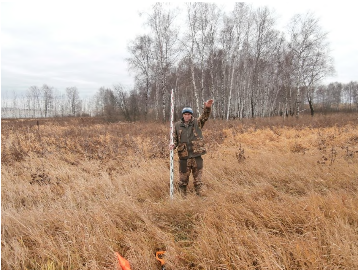
Рис. 151. «Строительство одной двухцепной отпайки .... КеНоТЭК». Шурф №11 ( 54^{\circ}25'29.18''\text{С} , 86^{\circ}41'47.17''\text{В} ). Место закладки. Фото с С.
