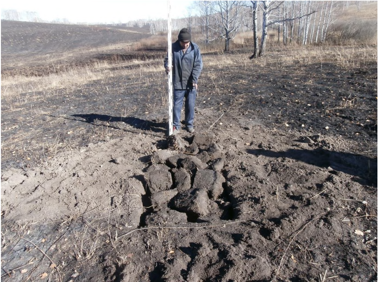
Рис. 210. «Строительство одной двухцепной отпайки .... КеНоТЭК». Шурф №25. Рекультивация. Фото с 3.
