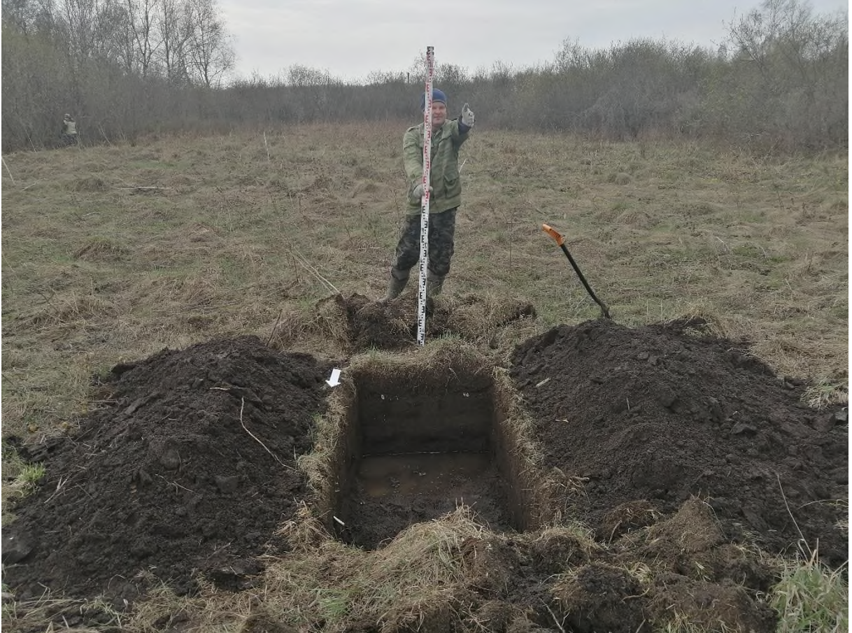
Рис. 256. «Строительство одной двухцепной отпайки .... КеНоТЭК». Шурф №37 после выборки. Фото с С.
