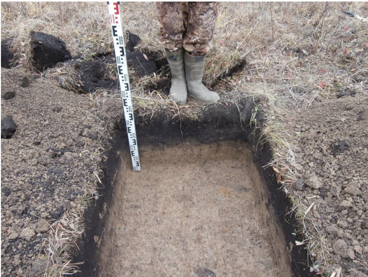
Рис. 149. «Строительство одной двухцепной отпайки .... КеНоТЭК». Шурф №10. Профиль западной стенки. Фото с В.
