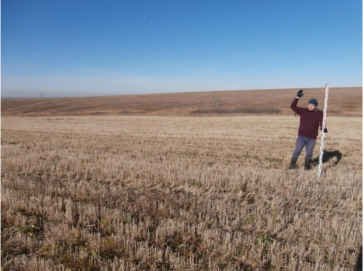
Рис. 93. «Строительство одной двухцепной отпайки .... КеНоТЭК». Точка фотофиксации №27 ( 54^{\circ}27'36.86''\text{С} , 86^{\circ}36'53.26''\text{В} ). Фото с ЮВ.
