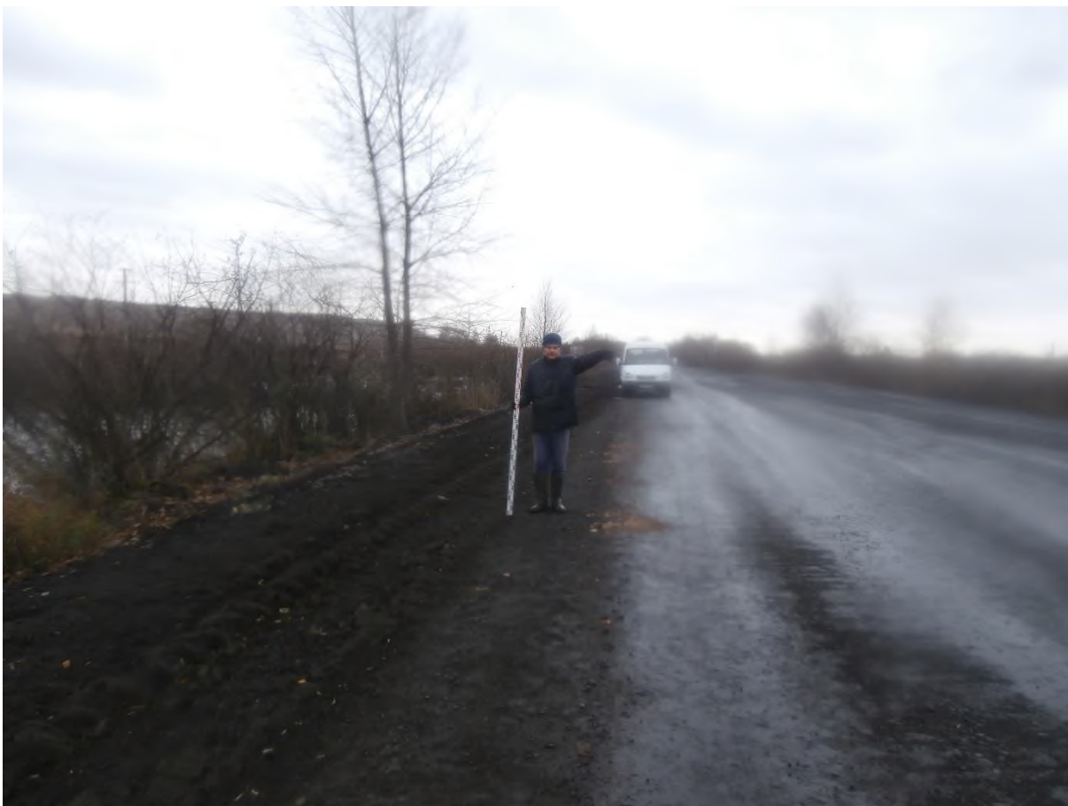
Рис. 42. «Строительство одной двухцепной отпайки .... КеНоТЭК». Точка фотофиксации №2 ( 54^{\circ}23'32.21''\text{С} , 86^{\circ}46'51.17''\text{В} ). Фото с В.
