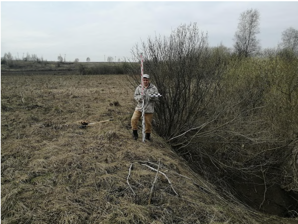
Рис. 286. «Строительство одной двухцепной отпайки .... КеНоТЭК». Место производства зачистки №9 ( 54^{\circ}24'39.33''\text{С} , 86^{\circ}42'53.68''\text{В} ). Фото с В.
