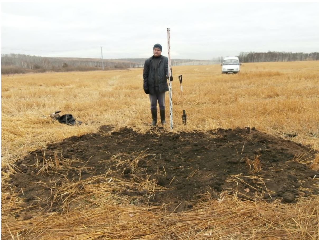
Рис. 162. «Строительство одной двухцепной отпайки .... КеНоТЭК». Шурф №13. Рекультивация. Фото с С.
