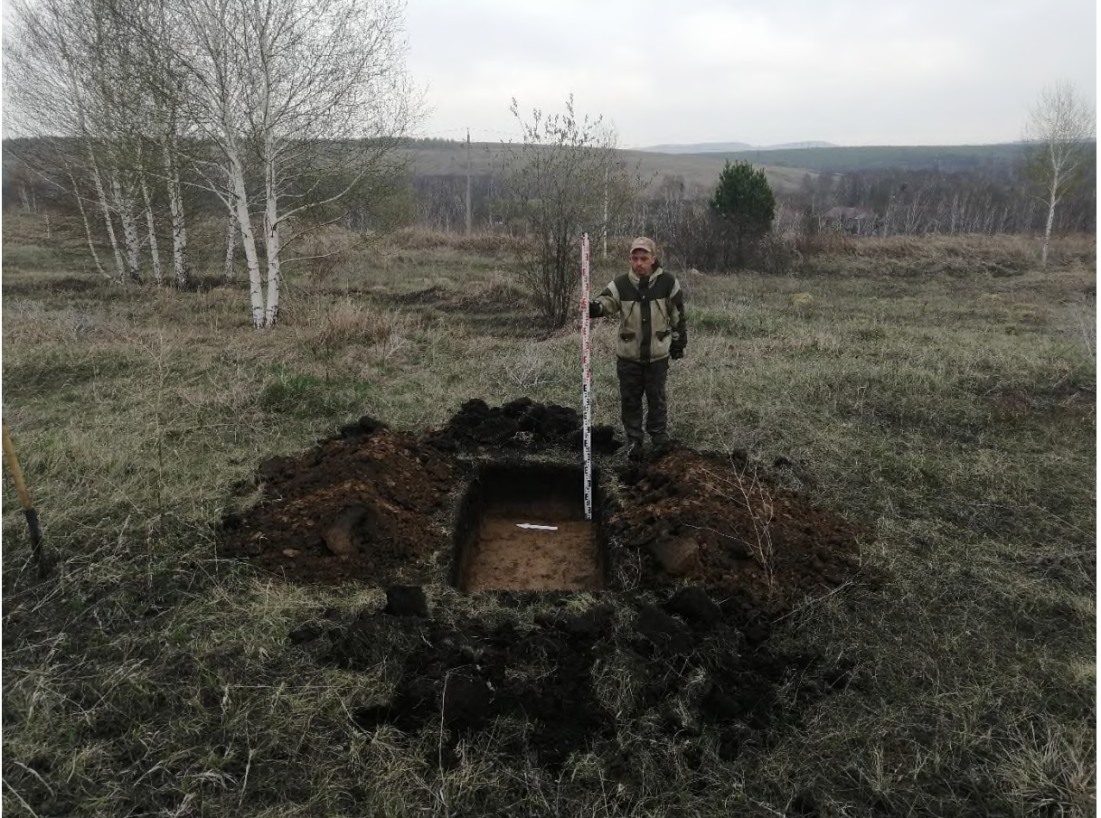
Рис. 260. «Строительство одной двухцепной отпайки .... КеНоТЭК». Шурф №38 после выборки. Фото с 3.
