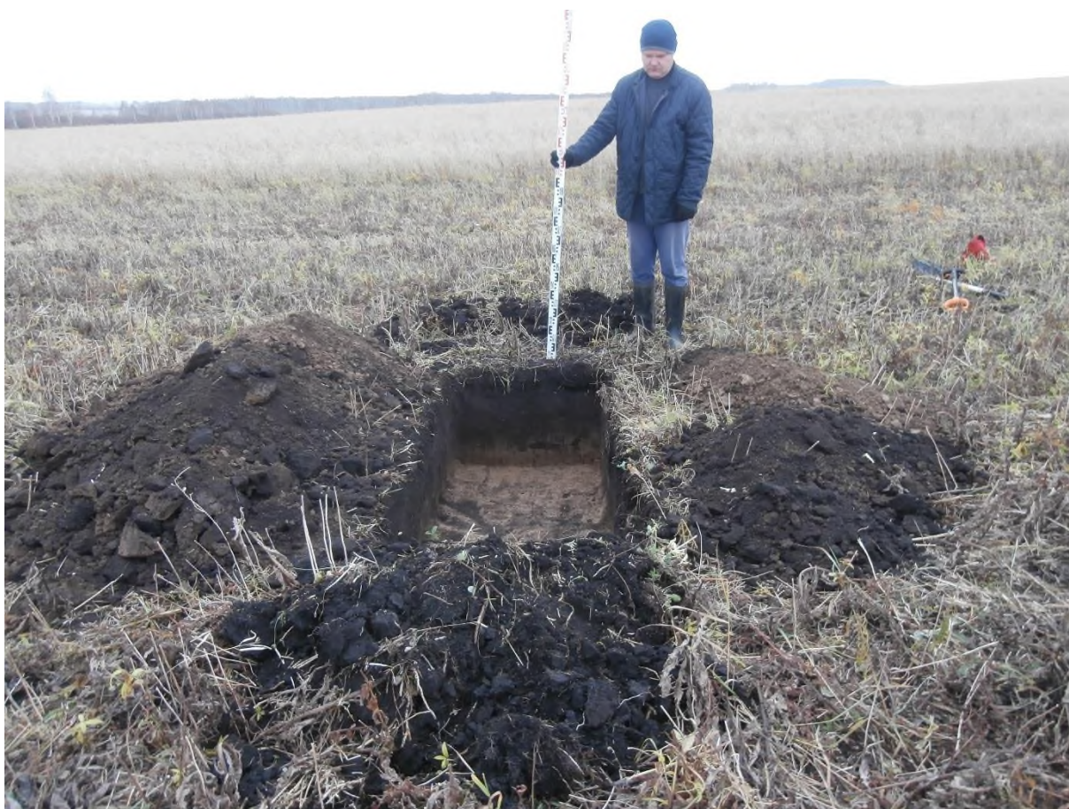
Рис. 177. «Строительство одной двухцепной отпайки .... КеНоТЭК». Шурф №17 после выборки. Фото с С.
