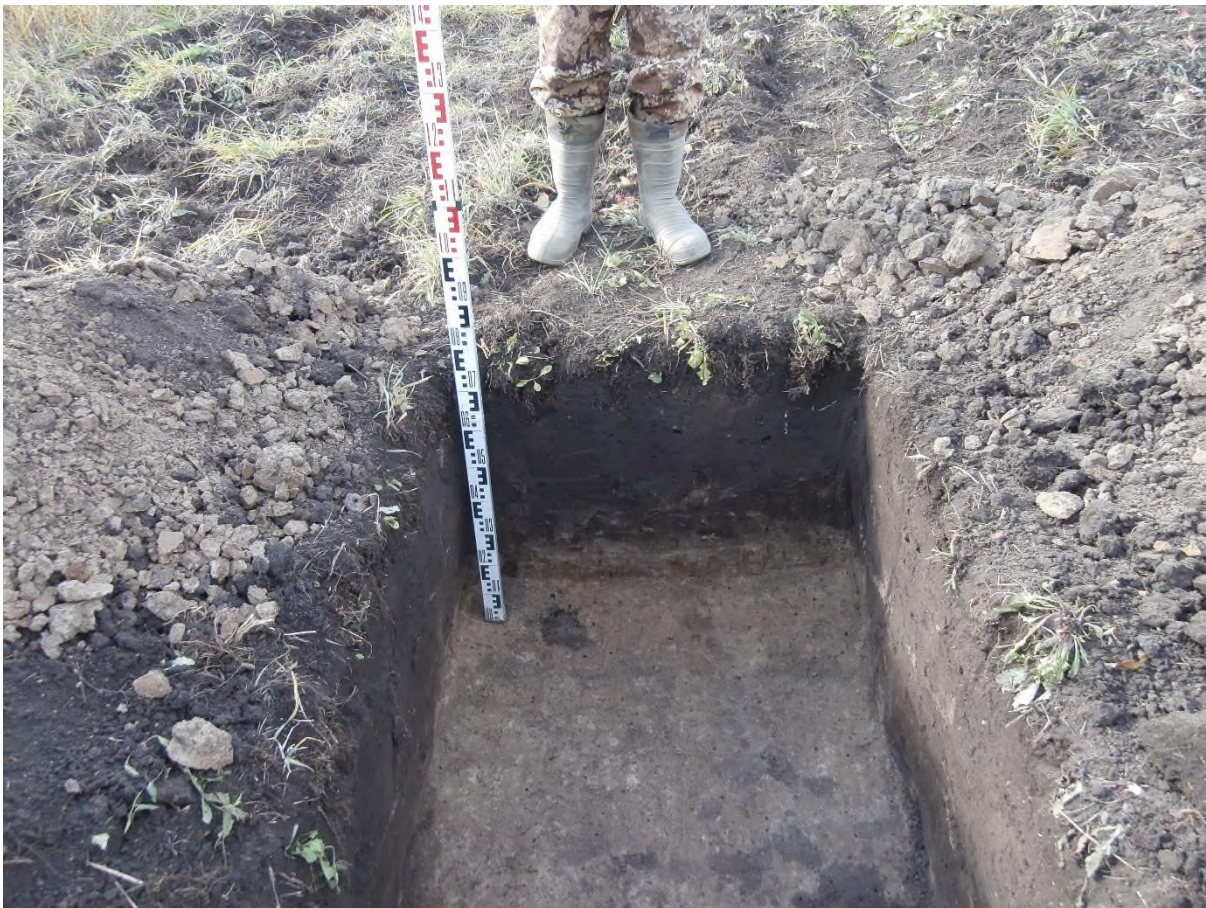
Рис. 133. «Строительство одной двухцепной отпайки .... КеНоТЭК». Шурф №6. Профиль южной стенки. Фото с С.
