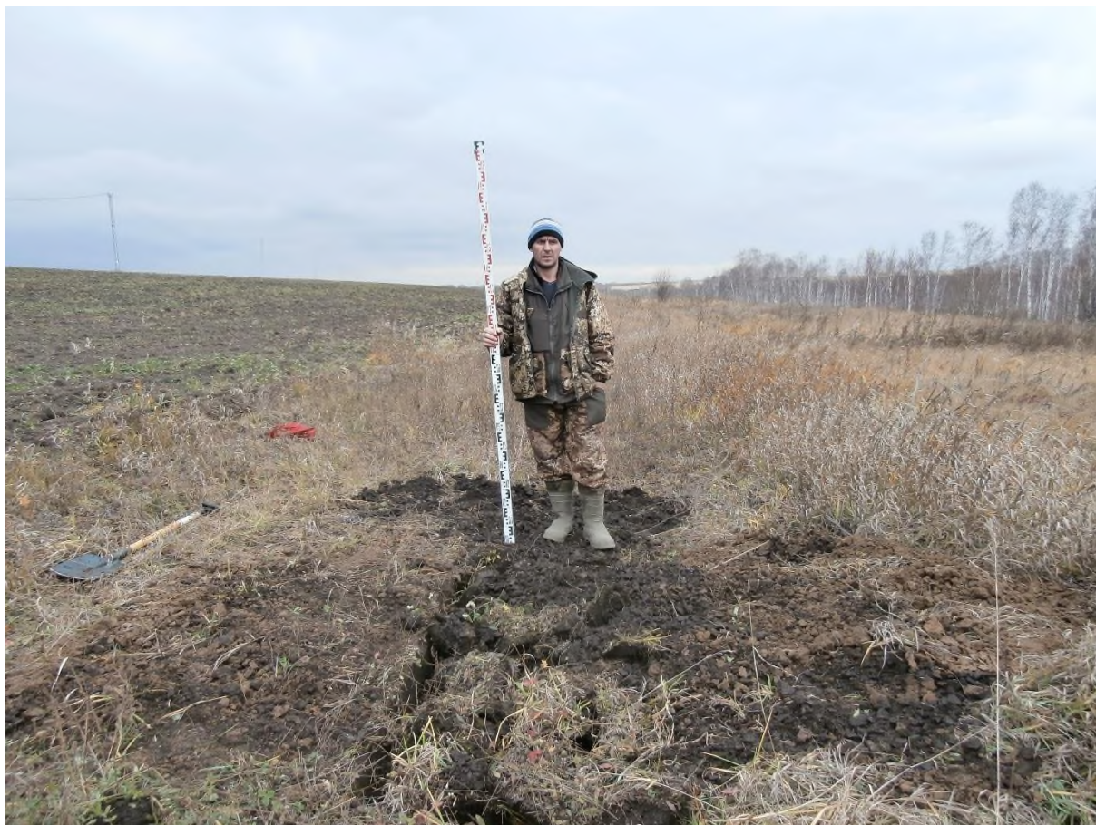
Рис. 138. «Строительство одной двухцепной отпайки .... КеНоТЭК». Шурф №7. Рекультивация. Фото с В.
