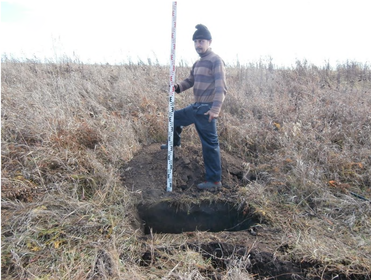
Рис. 224. «Строительство одной двухцепной отпайки .... КеНоТЭК». Шурф-врезка №29 после выборки. Фото с С.
