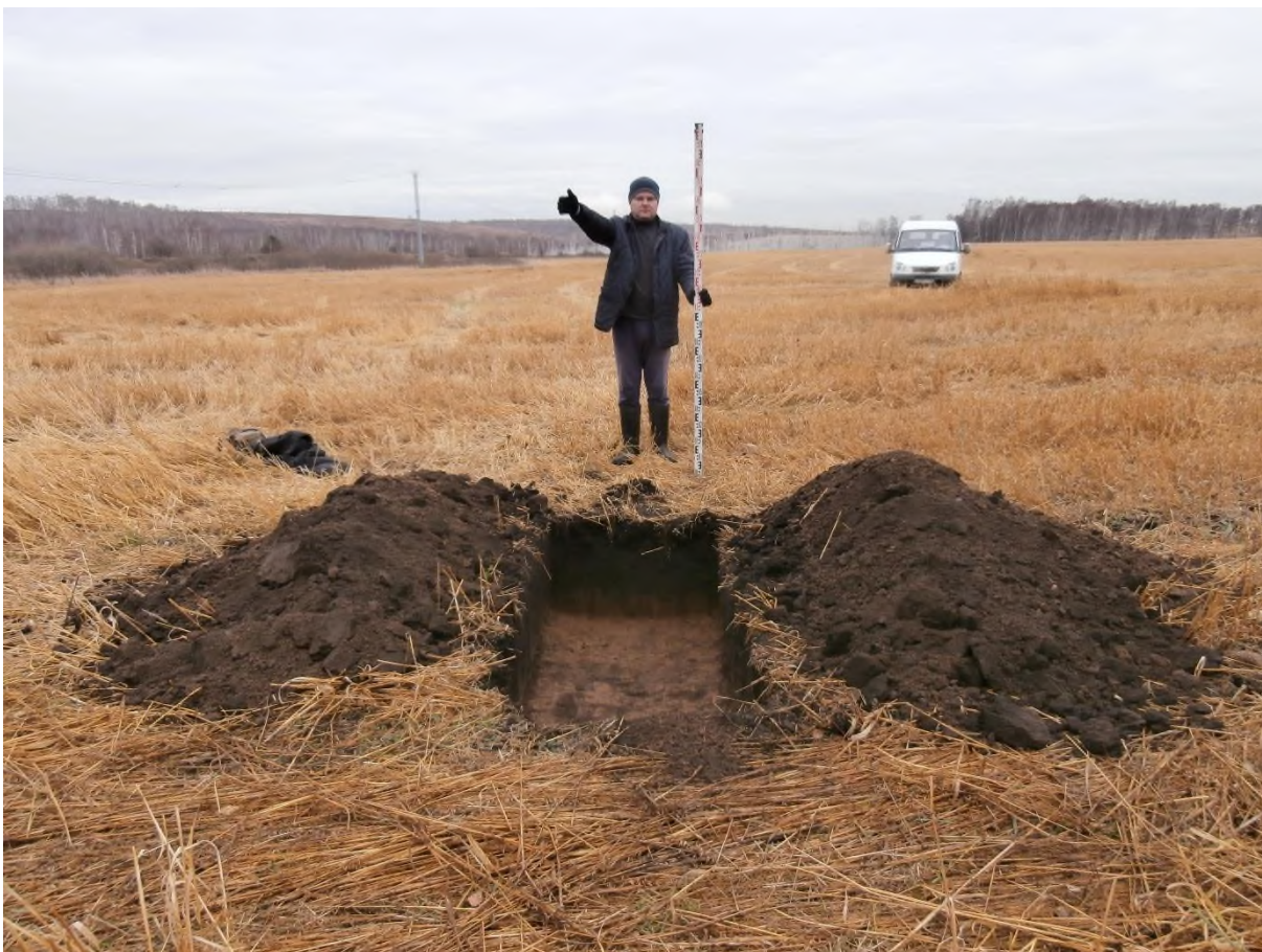
Рис. 160. «Строительство одной двухцепной отпайки .... КеНоТЭК». Шурф №13 после выборки. Фото с С.
