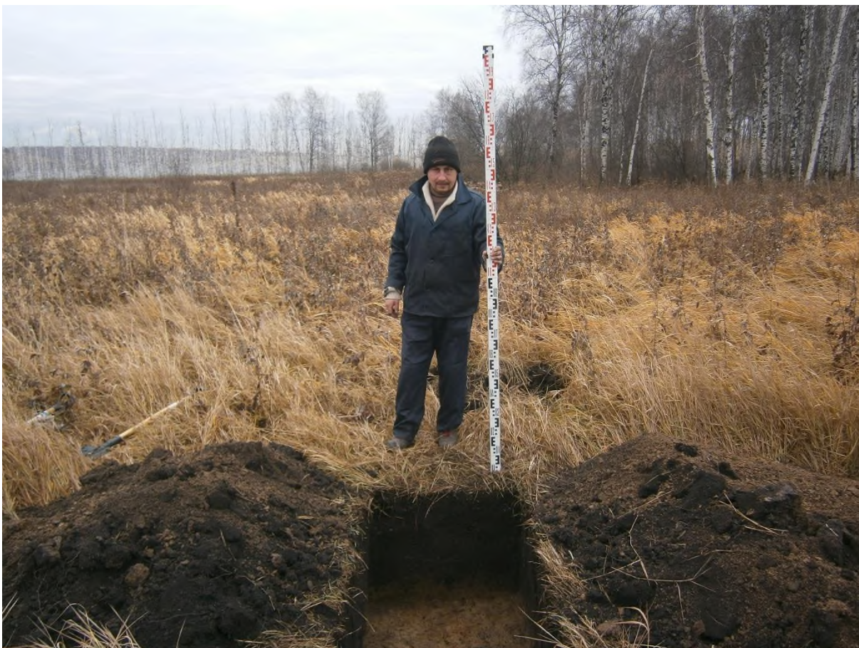
Рис. 152. «Строительство одной двухцепной отпайки .... КеНоТЭК». Шурф №11 после выборки. Фото с С.
