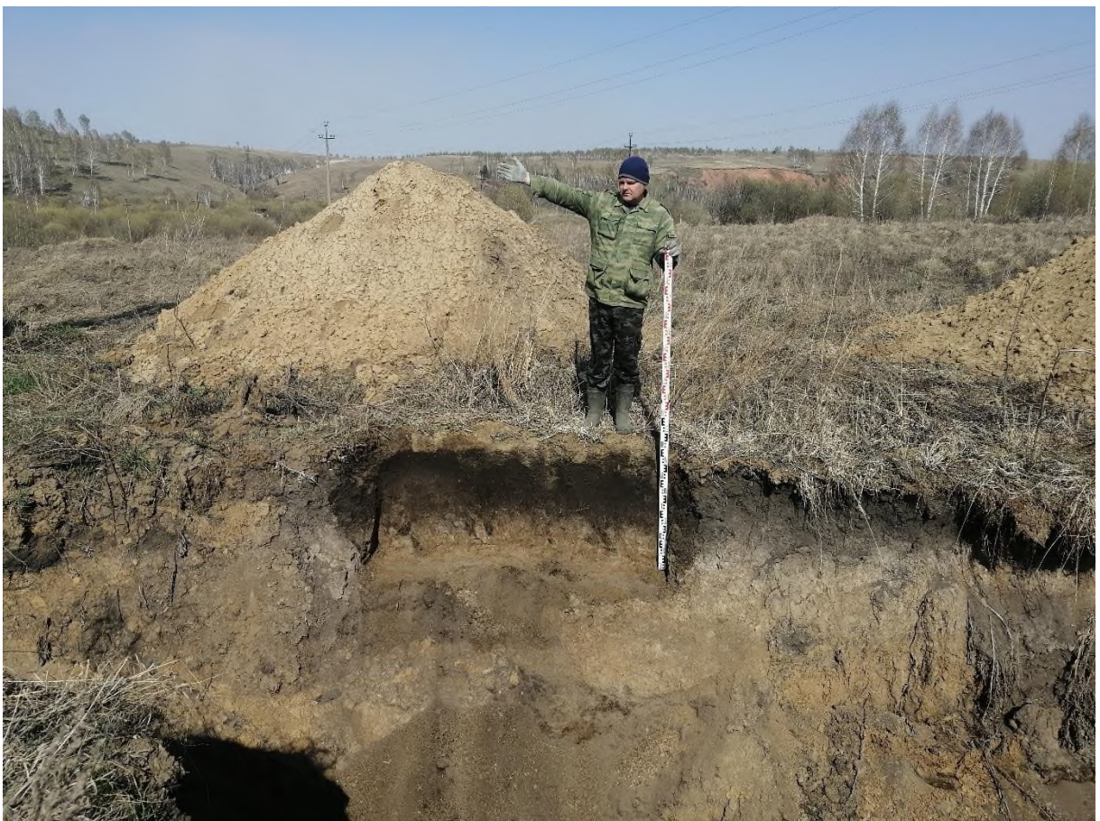
Рис. 281. «Строительство одной двухцепной отпайки .... КеНоТЭК». Зачистка №7 после производства работ. Фото с 3.
