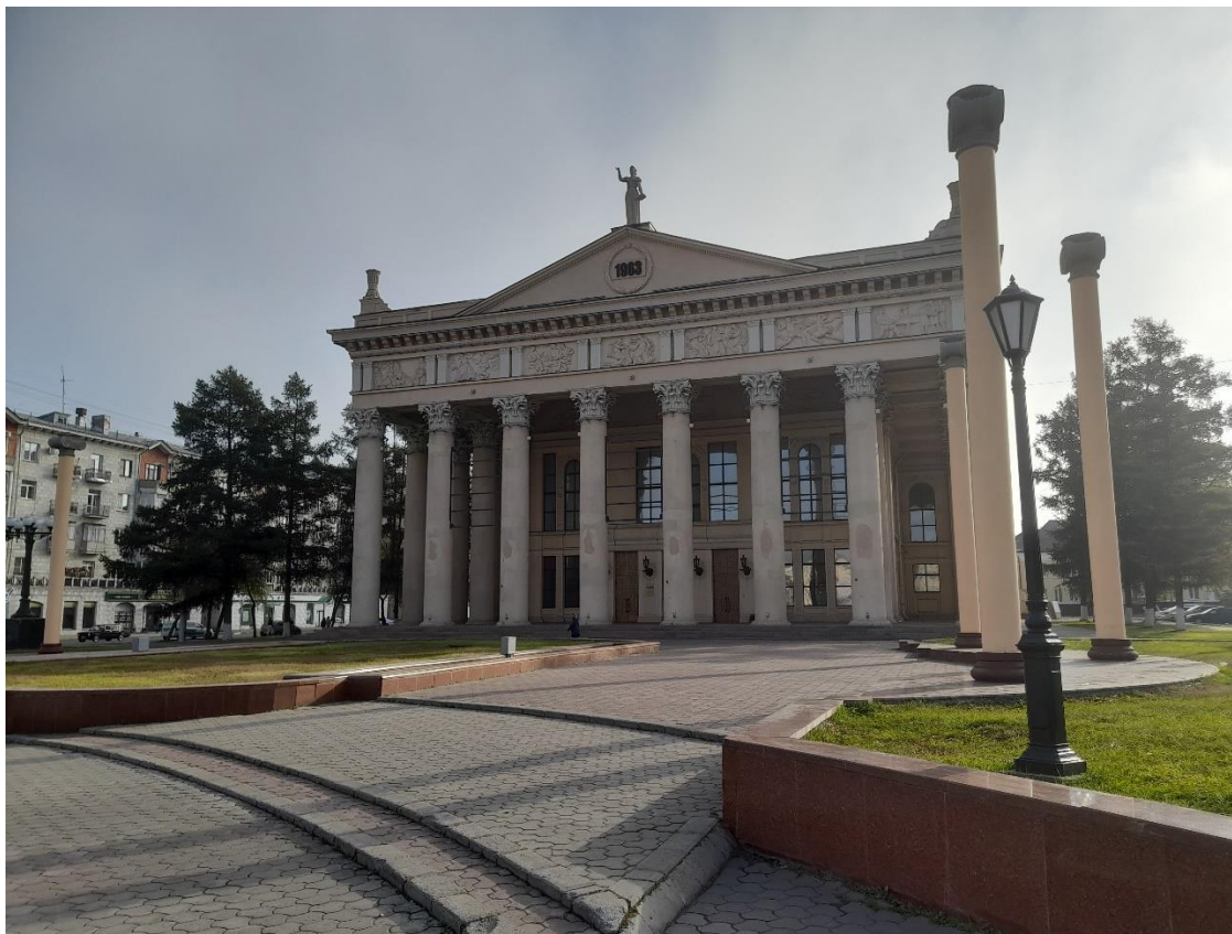
Фото 1. Общий вид главного фасада. 2022 г.
