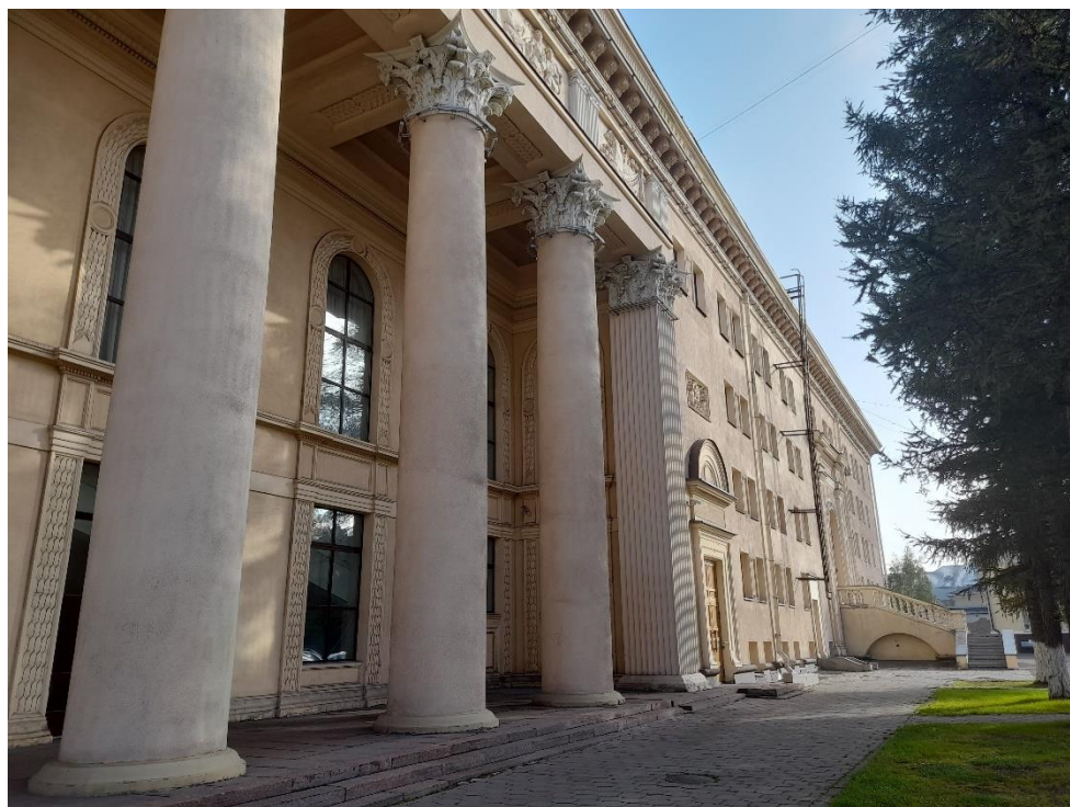
Фото 9. Боковой южный фасад. Фрагмент. 2022 г.
