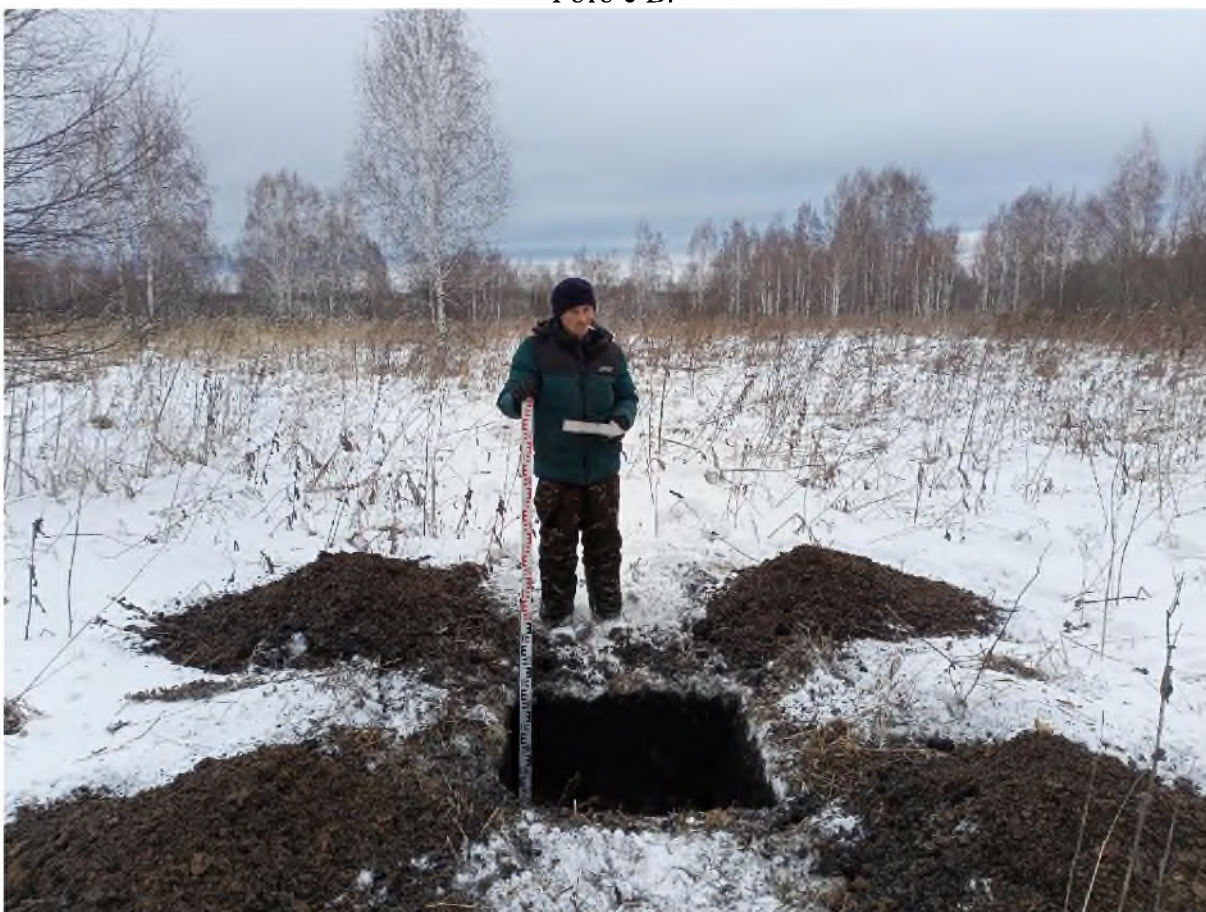
Рис. 1131. «Технический проект разработки Анжерского каменноугольного месторождения...». Шурф №165 после выборки. Фото с В.
