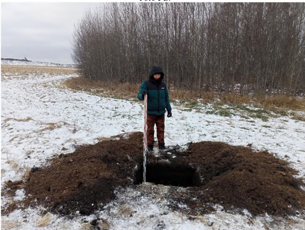
Рис. 559. «Технический проект разработки Анжерского каменноугольного месторождения...». Шурф №22 после выборки. Фото с В.
