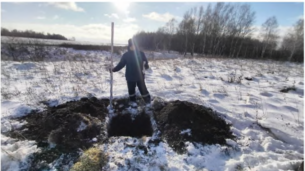
Рис. 875. «Технический проект разработки Анжерского каменноугольного месторождения...». Шурф №101 после выборки. Фото с С.
