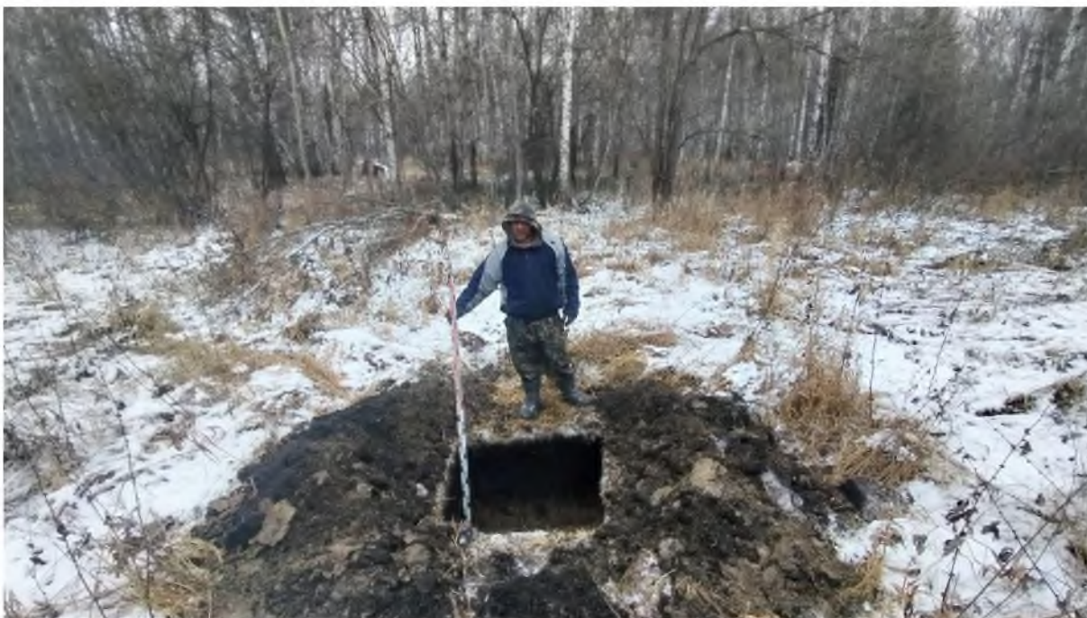
Рис. 587. «Технический проект разработки Анжерского каменноугольного месторождения...». Шурф №29 после выборки. Фото с В.
