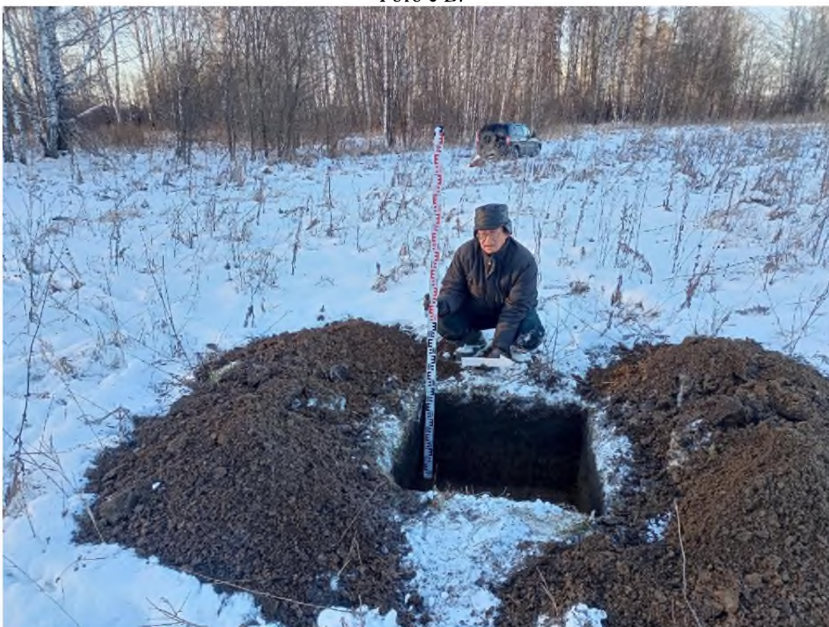
Рис. 1015. «Технический проект разработки Анжерского каменноугольного месторождения...». Шурф №136 после выборки. Фото с В.
