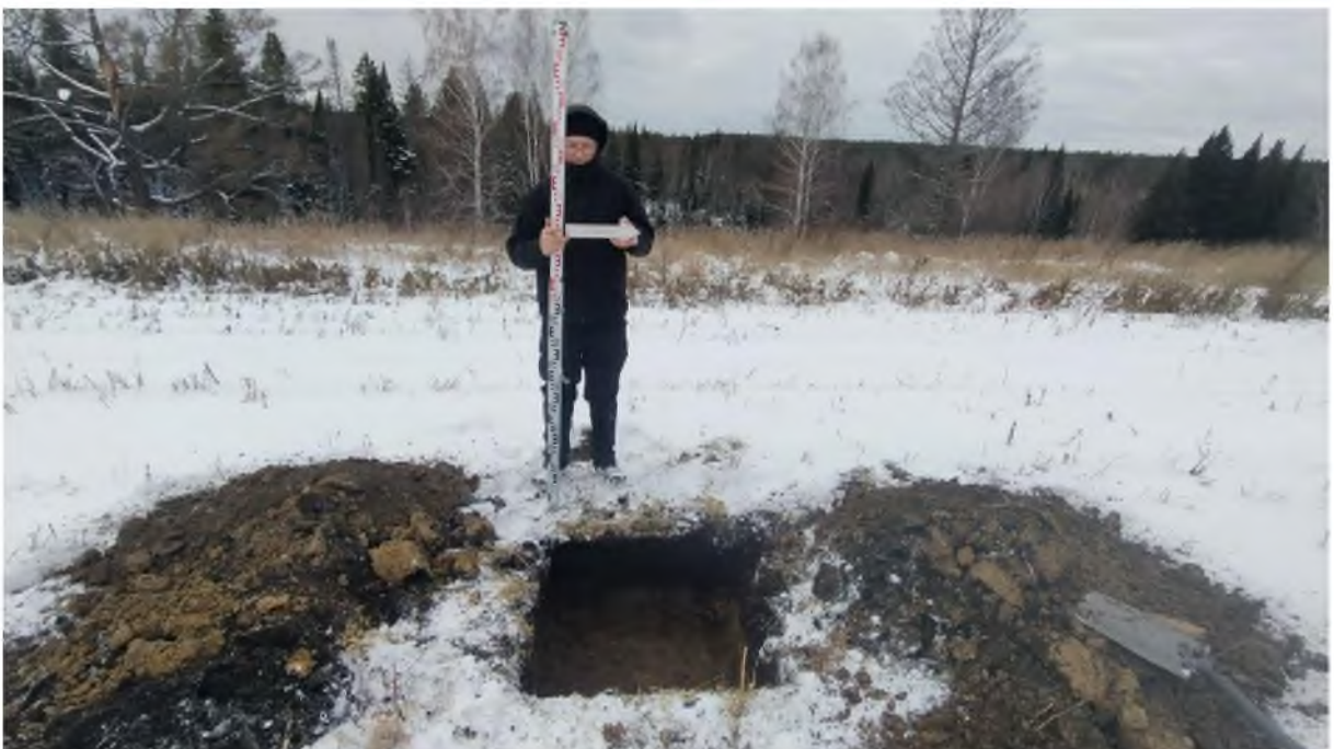
Рис. 899. «Технический проект разработки Анжерского каменноугольного месторождения...». Шурф №107 после выборки. Фото с В.
