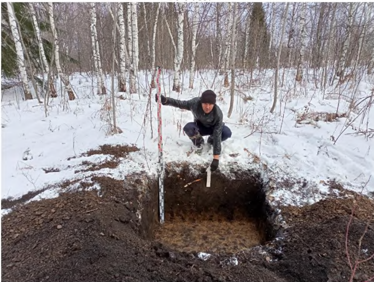
Рис. 1119. «Технический проект разработки Анжерского каменноугольного месторождения...». Шурф №162 после выборки. Фото с Ю.
