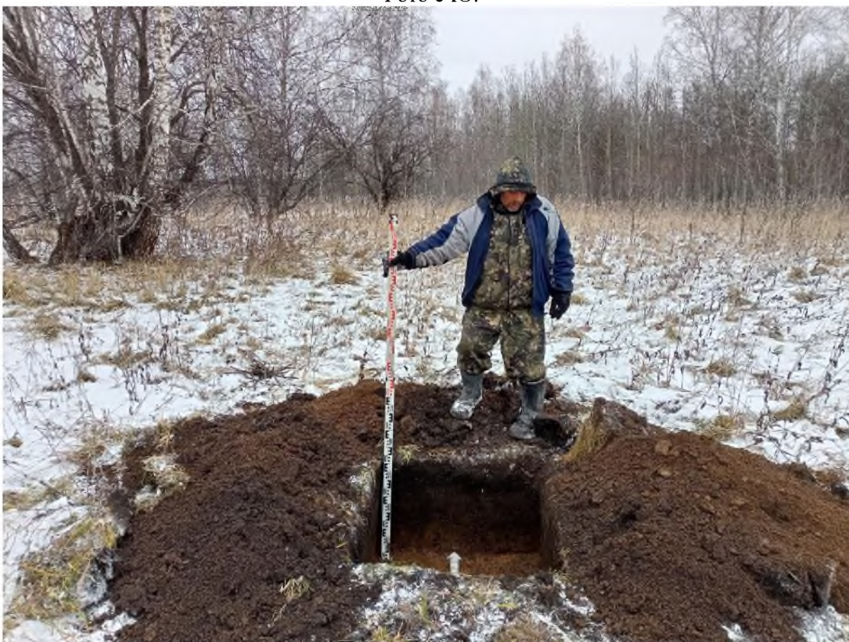
Рис. 547. «Технический проект разработки Анжерского каменноугольного месторождения...». Шурф №19 после выборки. Фото с Ю.
