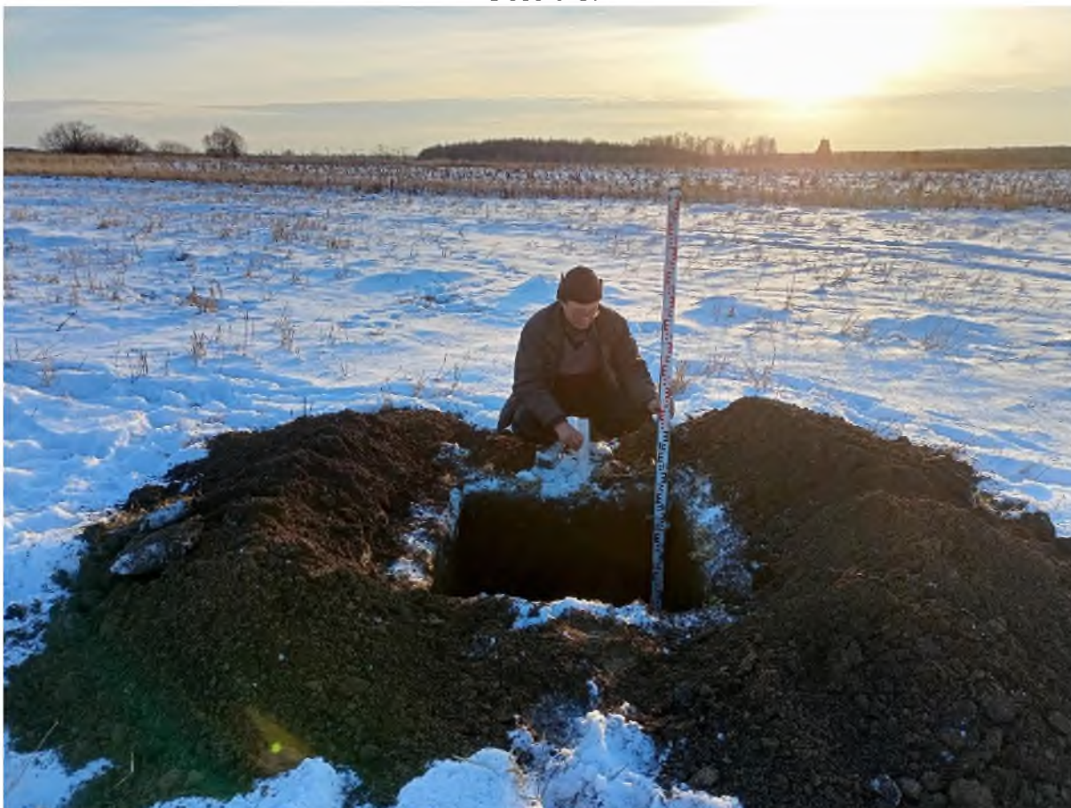
Рис. 1055. «Технический проект разработки Анжерского каменноугольного месторождения...». Шурф №146 после выборки. Фото с С.
