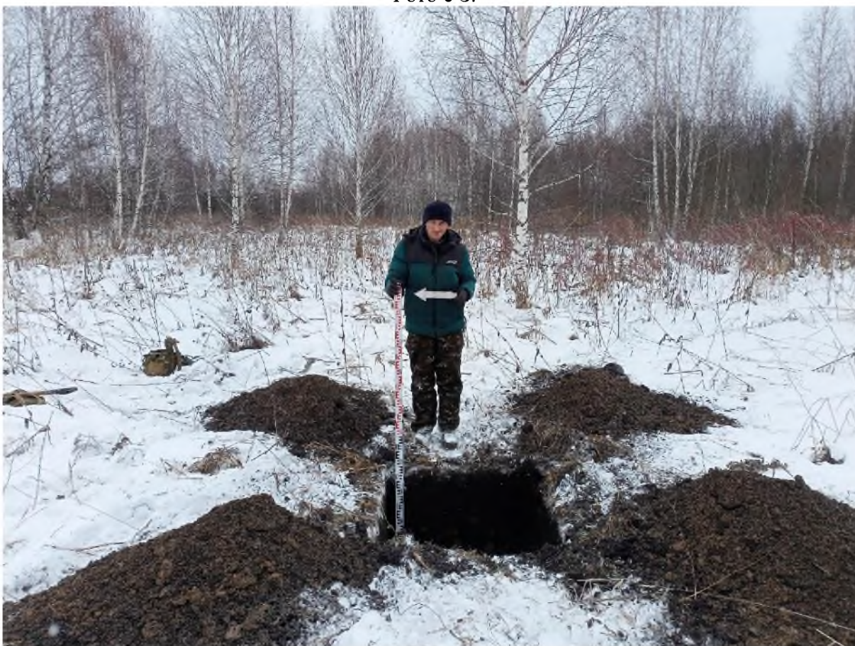
Рис. 1135. «Технический проект разработки Анжерского каменноугольного месторождения...». Шурф №166 после выборки. Фото с 3.
