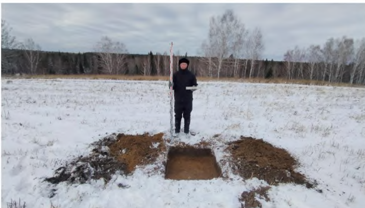
Рис. 903. «Технический проект разработки Анжерского каменноугольного месторождения...». Шурф №108 после выборки. Фото с В.
