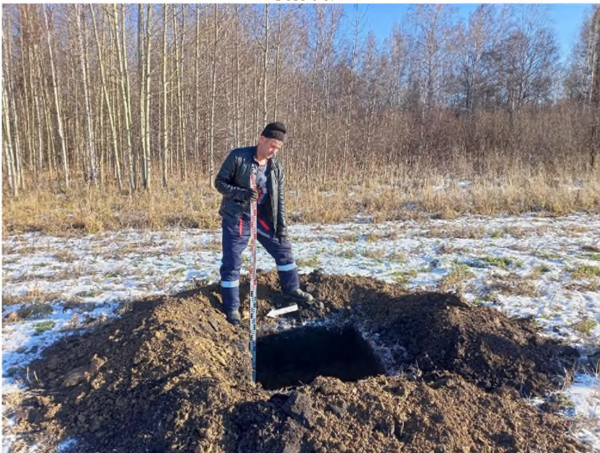
Рис. 623. «Технический проект разработки Анжерского каменноугольного месторождения...». Шурф №38 после выборки. Фото с 3.
