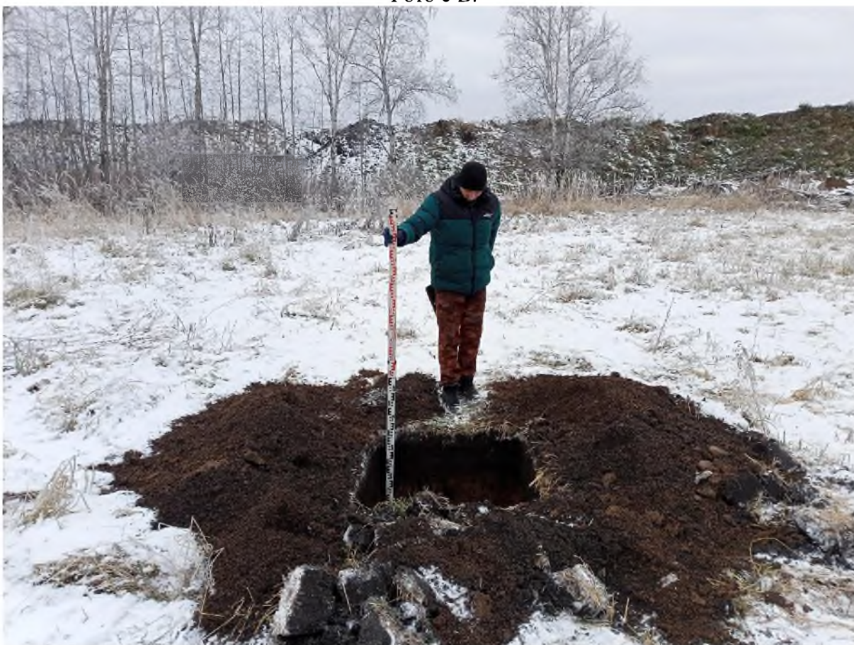
Рис. 531. «Технический проект разработки Анжерского каменноугольного месторождения...». Шурф №15 после выборки. Фото с В.
