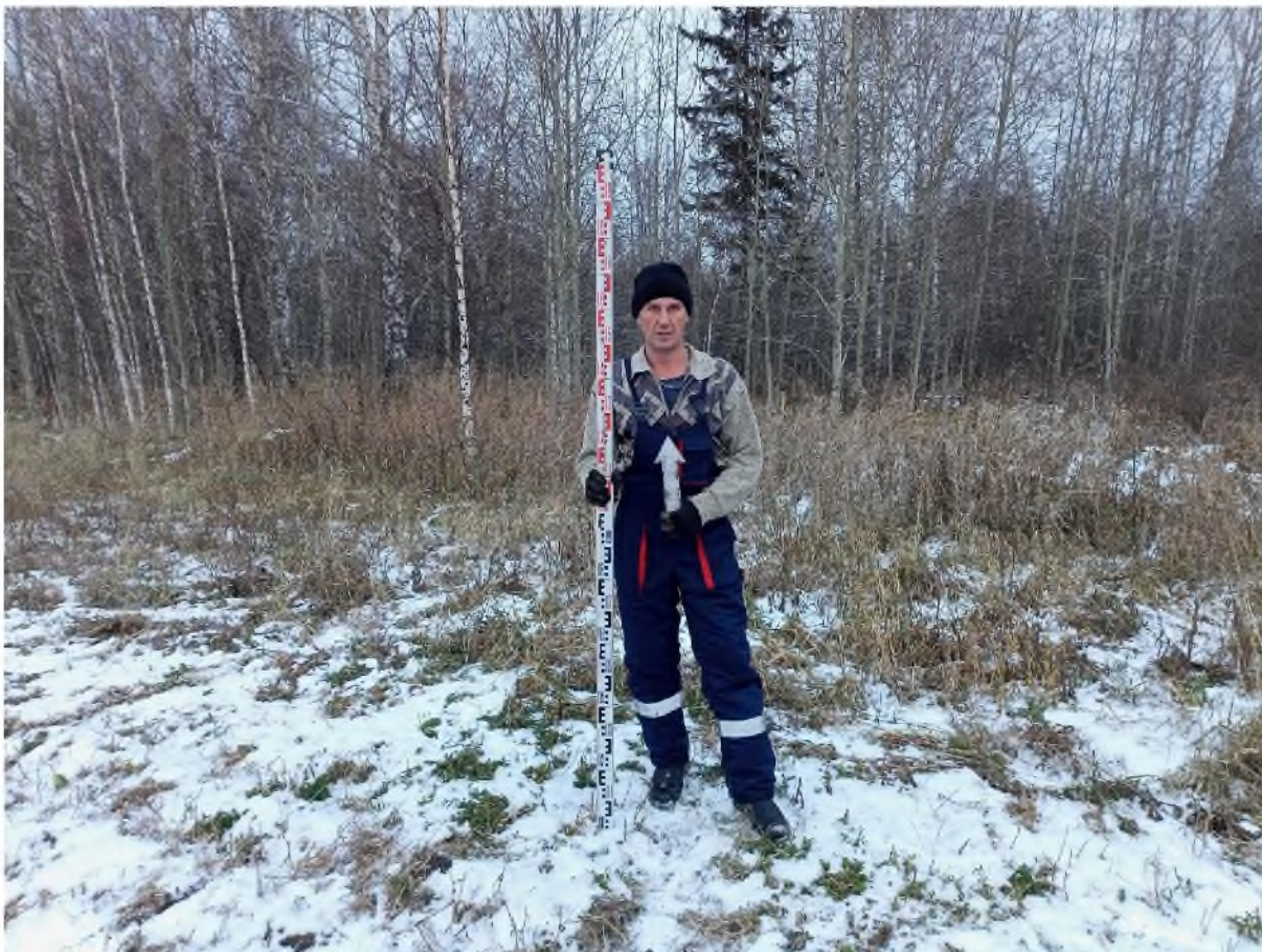
Рис. 606. «Технический проект разработки Анжерского каменноугольного месторождения...». Шурф №34 ( 56^{\circ}11'2.56''\text{C} , 86^{\circ}0'21.25''\text{B} ). Место закладки. Фото с Ю.
