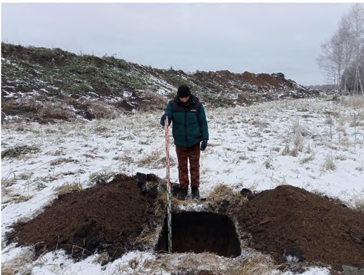
Рис. 535. «Технический проект разработки Анжерского каменноугольного месторождения...». Шурф №16 после выборки. Фото с Ю.
