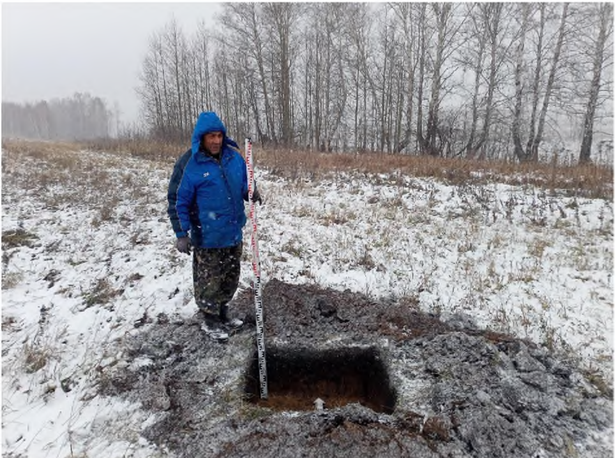
Рис. 475. «Технический проект разработки Анжерского каменноугольного месторождения...». Шурф №1 после выборки. Фото с Ю.
