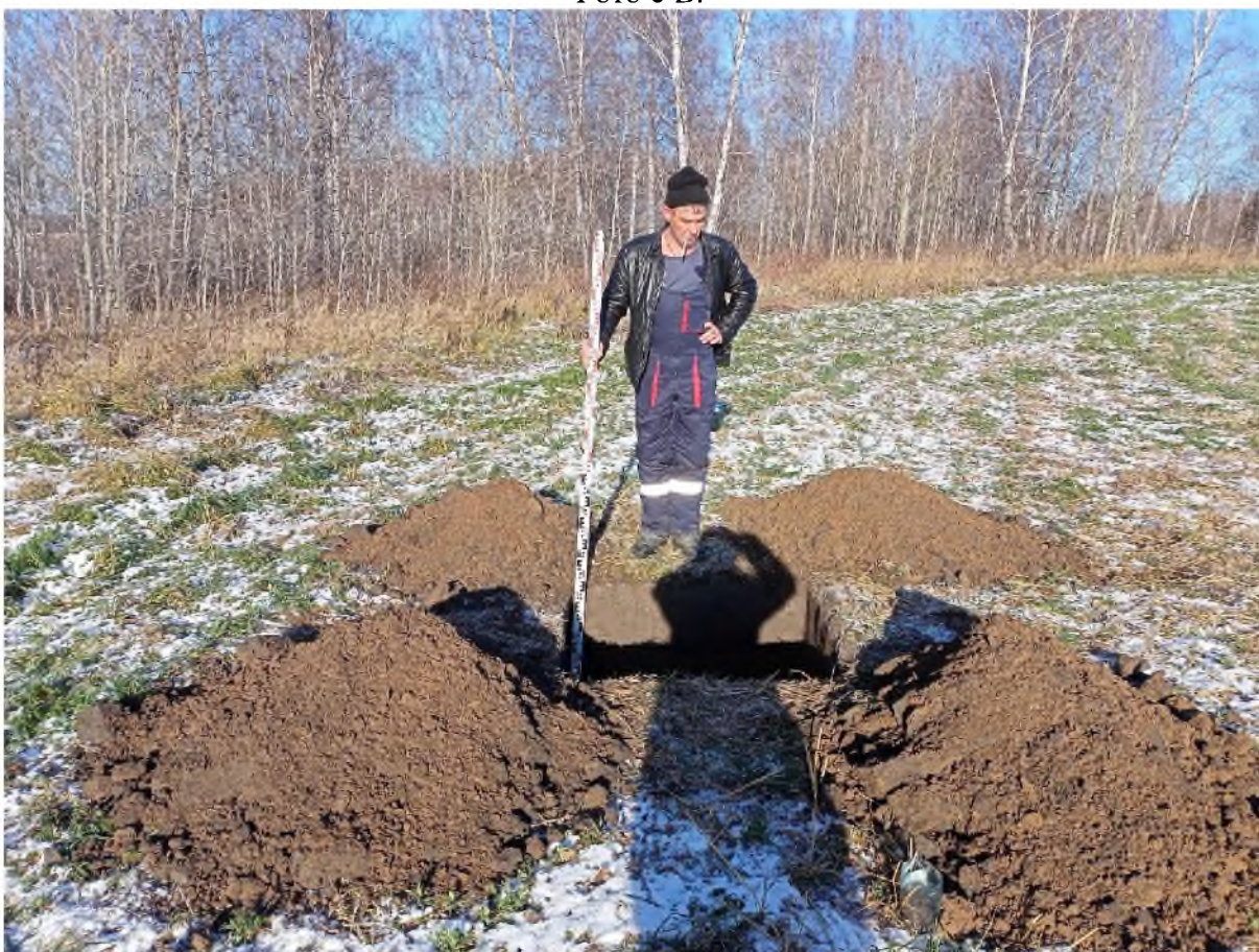
Рис. 631. «Технический проект разработки Анжерского каменноугольного месторождения...». Шурф №40 после выборки. Фото с В.
