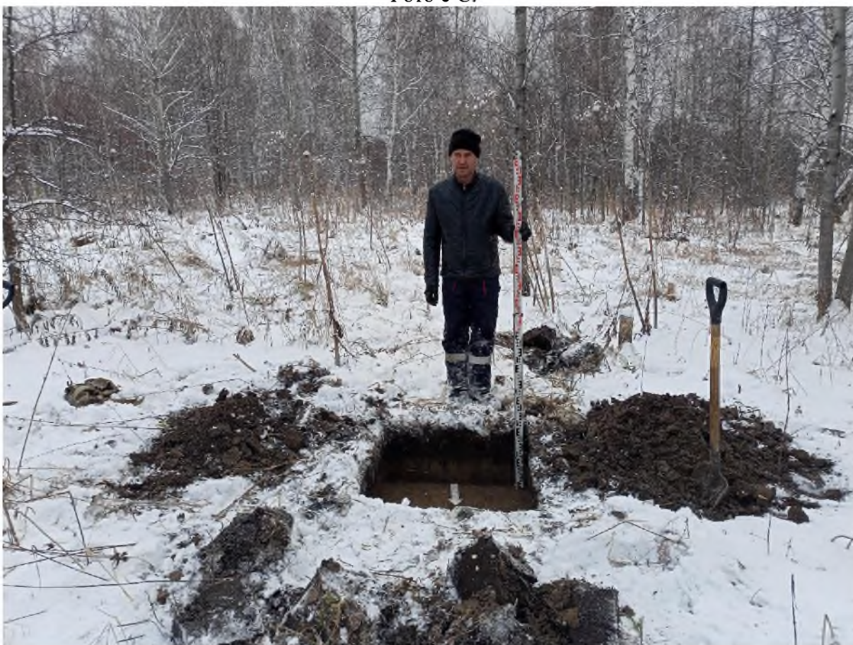
Рис. 727. «Технический проект разработки Анжерского каменноугольного месторождения...». Шурф №64 после выборки. Фото с С.
