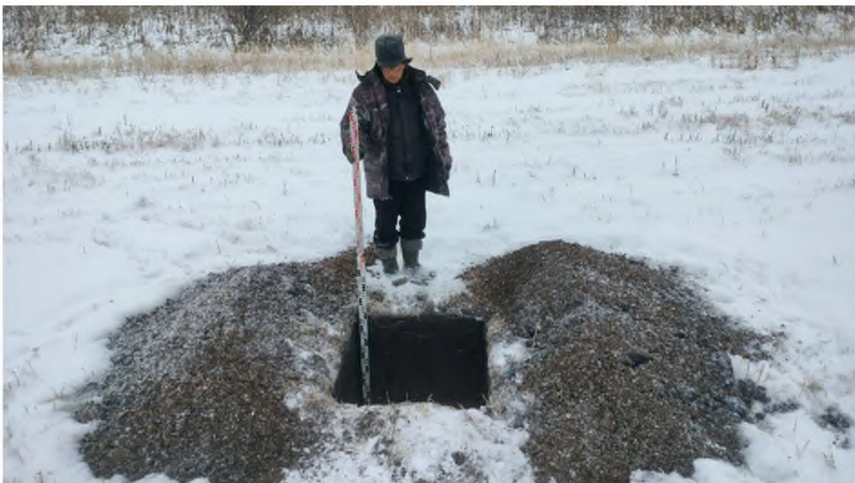
Рис. 747. «Технический проект разработки Анжерского каменноугольного месторождения...». Шурф №69 после выборки. Фото с 3.
