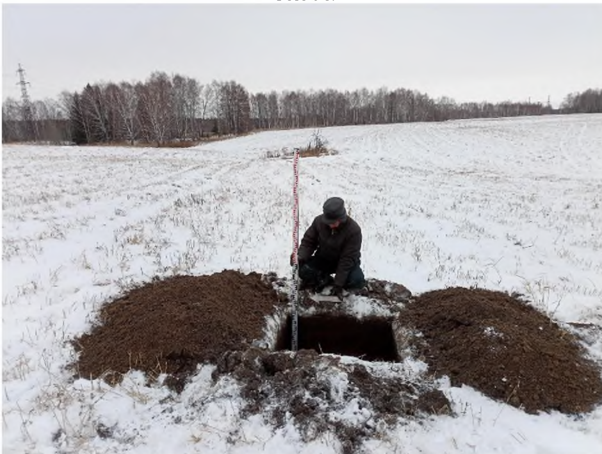
Рис. 955. «Технический проект разработки Анжерского каменноугольного месторождения...». Шурф №121 после выборки. Фото с 3.
