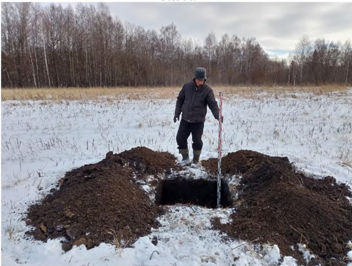
Рис. 775. «Технический проект разработки Анжерского каменноугольного месторождения...». Шурф №76 после выборки. Фото с 3.
