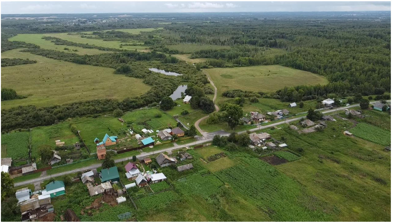
Фото 44. Вид на Объект культурного наследия, исследуемую территорию с высоты птичьего полета.
