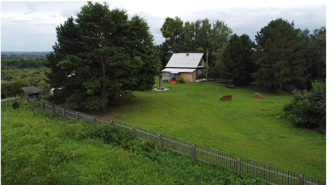
Фото 49. Вид на Объект культурного наследия с высоты птичьего полета.
