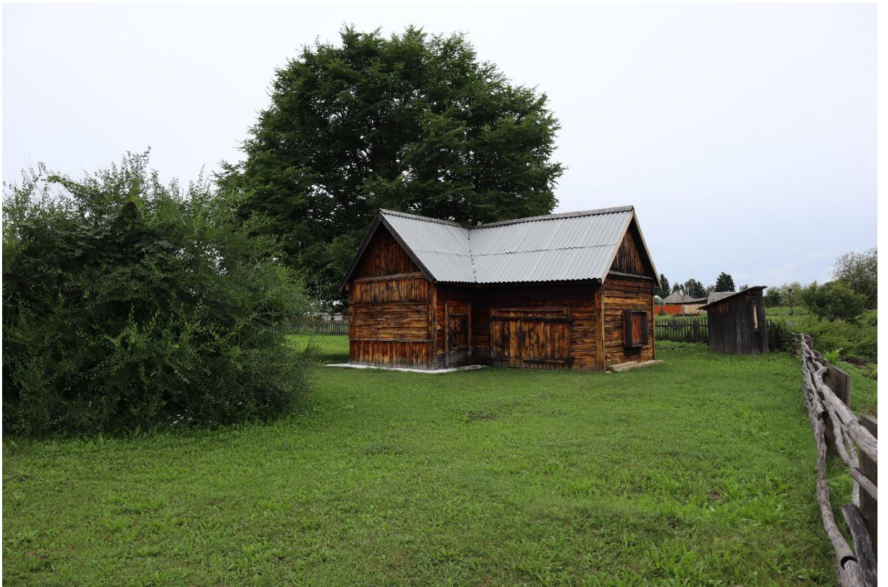
Фото 8. Вид на хозяйственные постройки в границах территории Объекта культурного наследия.
