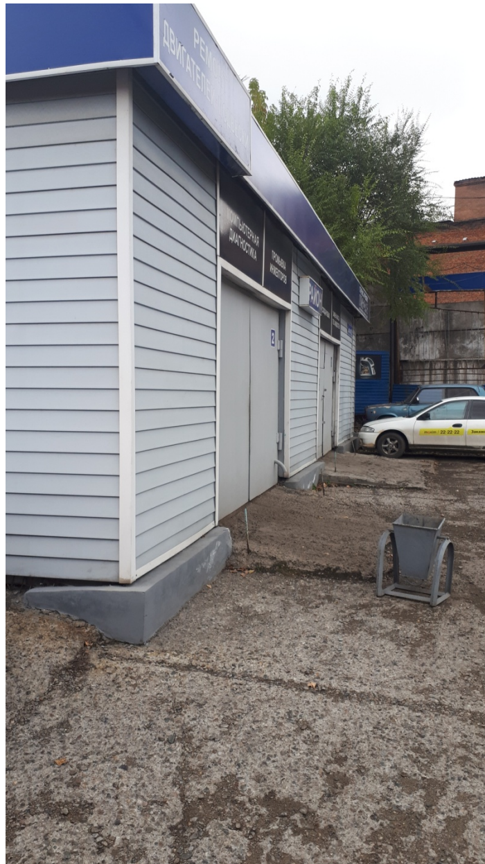
Рис. 18. Ангары СТО на участке проектируемых работ, установленные без углубления фундаментов, поверх бетонированного покрытия.
