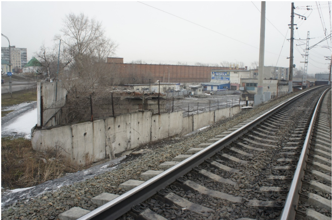
Рис. 14. насыпь железной дороги вдоль западной границы участка проектируемых работ. Снято с СЗ-3.
