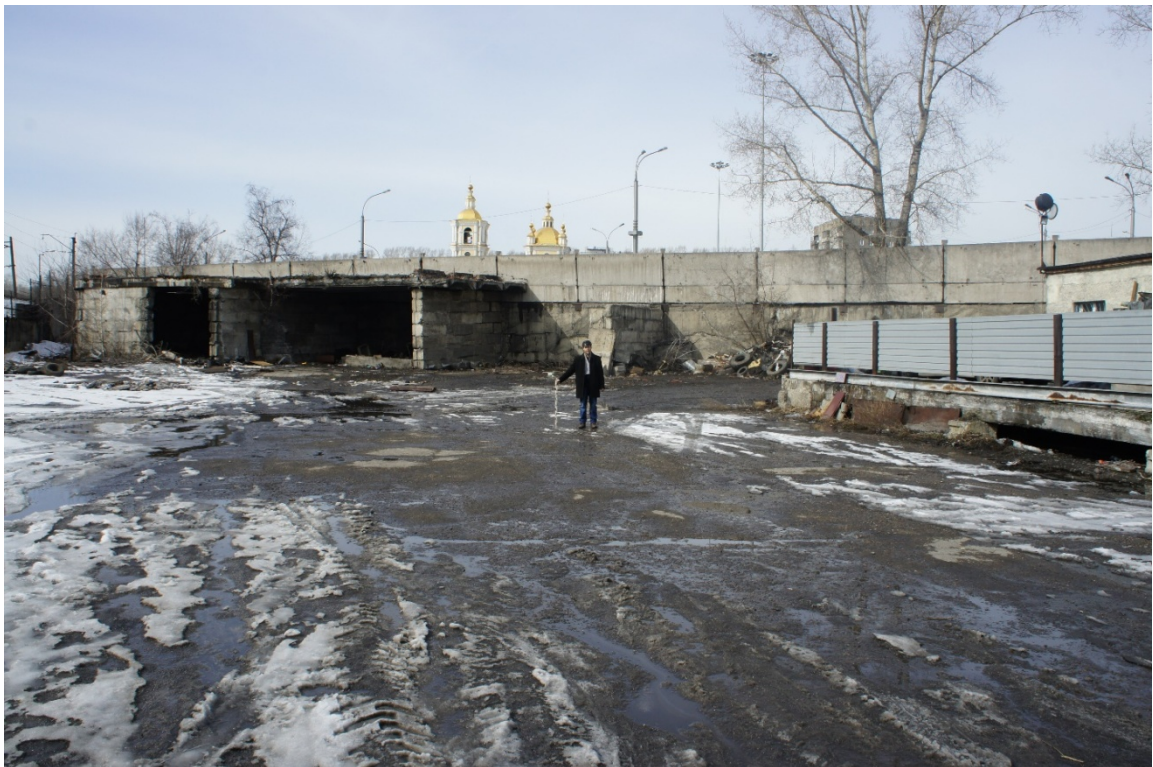
Рис. 10. Центральная часть площадки с бетонированным покрытием. Снято с ЮВ.
