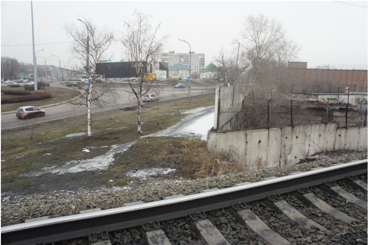
Рис. 13. Бетонный забор вдоль северной границы участка и кольцевая дорога. Снято с 3.
