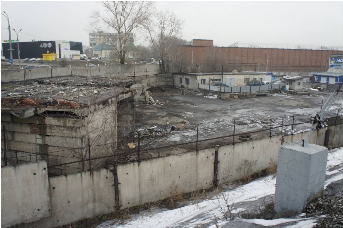
Рис. 11. Бетонные сооружения гаражного типа на площади участка. Снято с 3.
