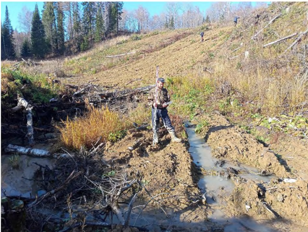
Рис. 20. «Технический проект разработки Увального каменноугольного месторождения». Участок 1. Точка фотофиксации №4 ( 54^{\circ} 6'6.47''\text{C} , 87^{\circ}39'41.64''\text{B} ). Фото с В.
