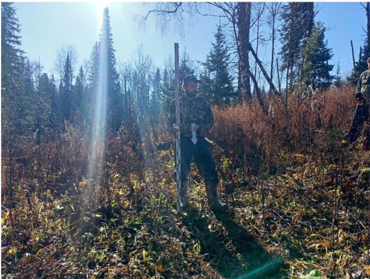
Рис. 159. «Технический проект разработки Увального каменноугольного месторождения». Участок 2. Шурф №9 ( 54^{\circ} 5'18.06''\text{С} , 87^{\circ}35'46.40''\text{В} ). Место закладки. Фото с С.
