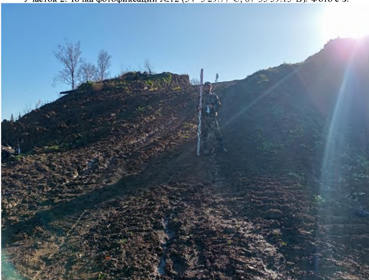
Рис. 100. «Технический проект разработки Увального каменноугольного месторождения». Участок 2. Точка фотофиксации №12 ( 54^{\circ} 5'29.77''\text{С} , 87^{\circ}35'59.15''\text{В} ). Фото с С.
