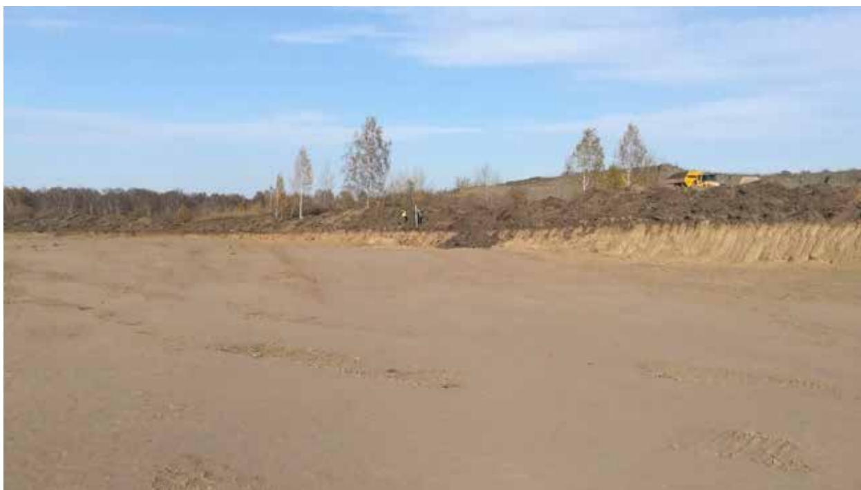
Рис. 197. Объект «Строительство железнодорожных путей ООО «Шахта Сибирская». Зачистка 14 после завершения работ. Вид на СЗ.
