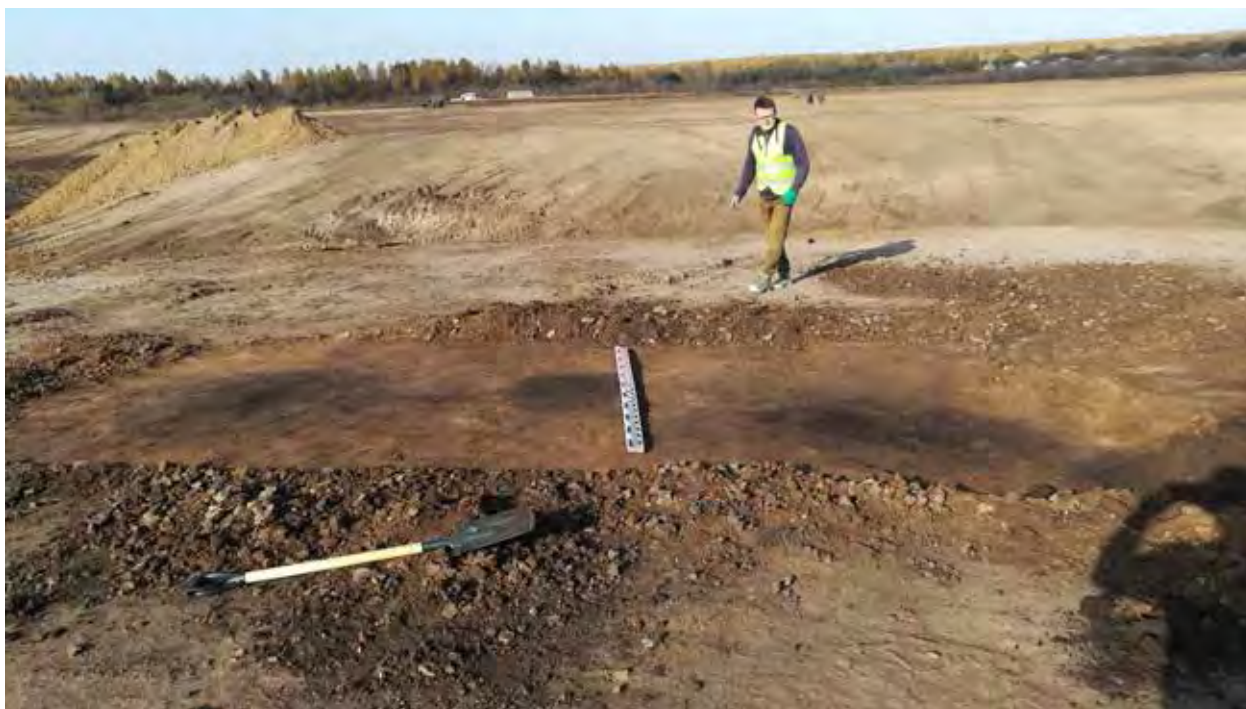
Рис. 136. Объект «Обогатительная фабрика «Шахта Сибирская». Юго-восточная часть земельного отвода. Ямы 10, 11, 12. Вид на С.
