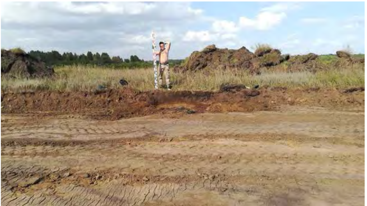
Рис. 68. Объект «Обогатительная фабрика «Шахта Сибирская». Зачистка 5 после завершения работ. Вид на С.
