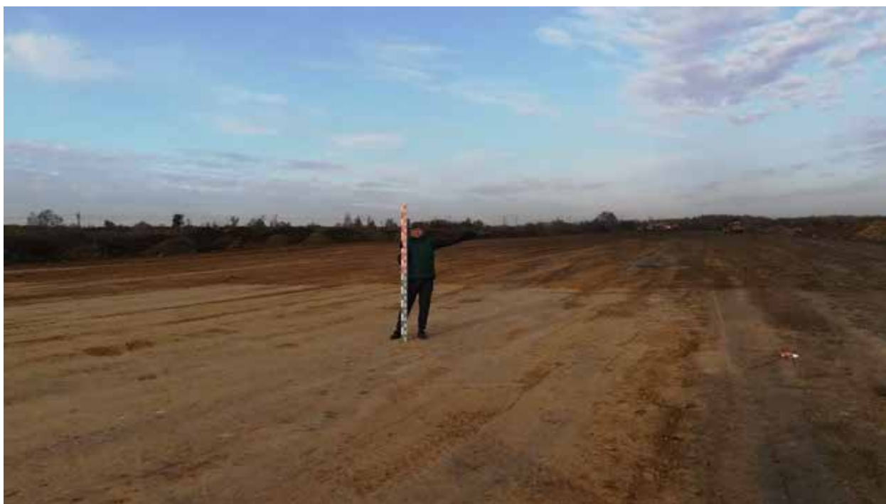
Рис. 147. Объект «Строительство железнодорожных путей ООО «Шахта Сибирская». Точка фотофиксации 13. Координаты 54^{\circ}31'19.36''\text{С} 86^{\circ}16'20.85''\text{В} . Вид на З.
