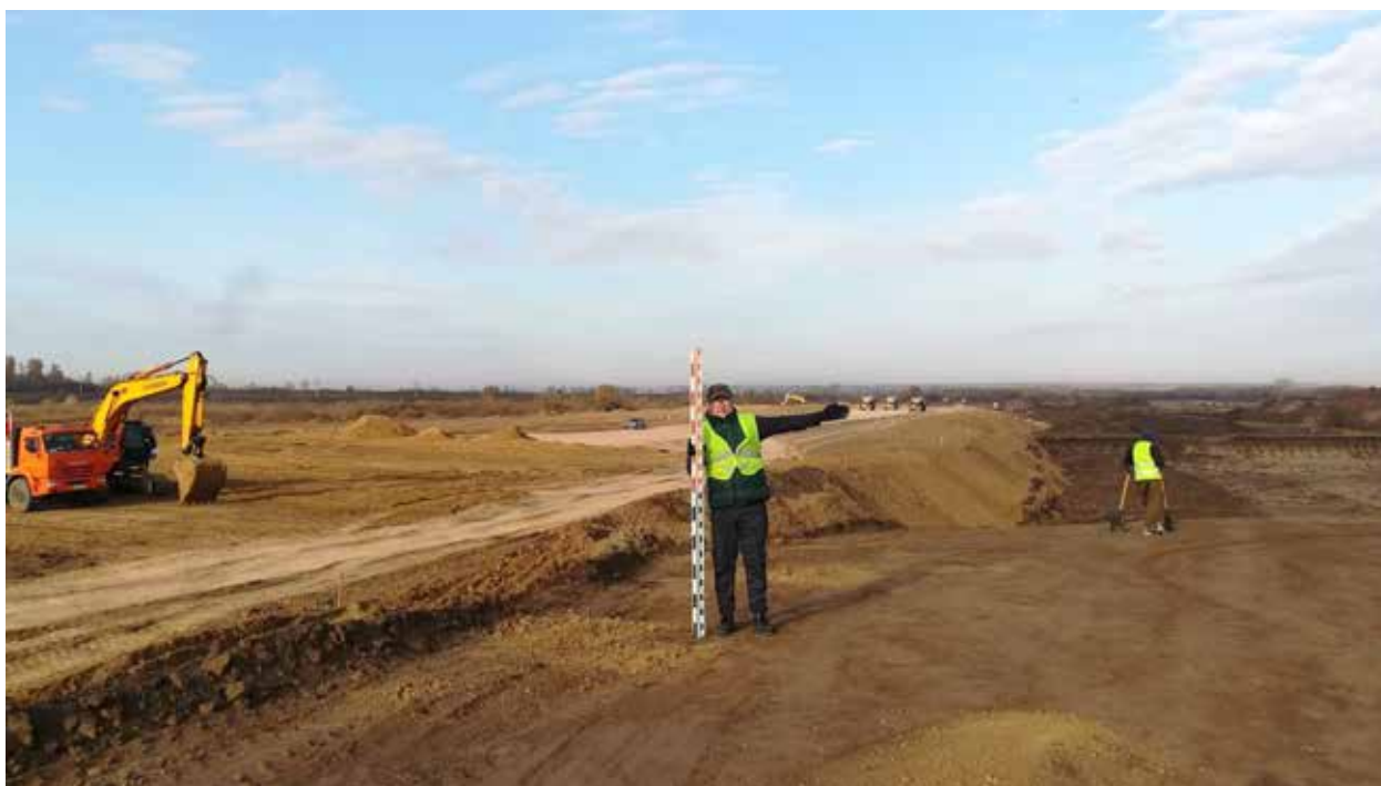
Рис. 153. Объект «Строительство железнодорожных путей ООО «Шахта Сибирская». Точка фотофиксации 15. Координаты 54°31'14.22"С 86°16'45.61"В. Вид на З.
