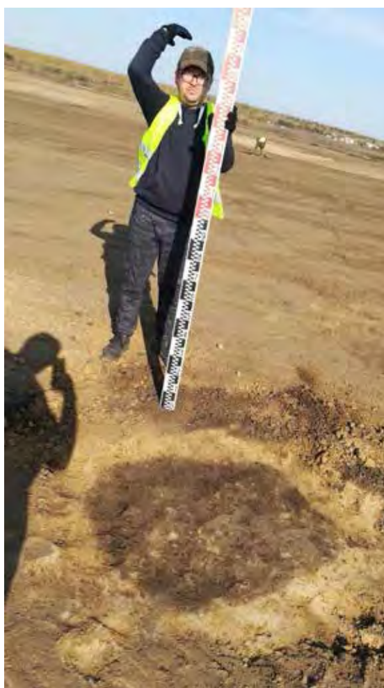
Рис. 129. Объект «Обогатительная фабрика «Шахта Сибирская». Юго-восточная часть земельного отвода. Яма 5. Вид на С.
