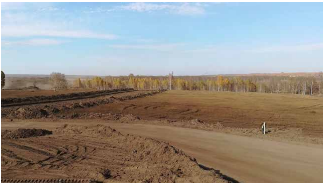
Рис. 167. Объект «Строительство железнодорожных путей ООО «Шахта Сибирская». Точка фотофиксации 20. Координаты 54°30'46.98"С 86°17'40.35"В. Вид на СЗ.
