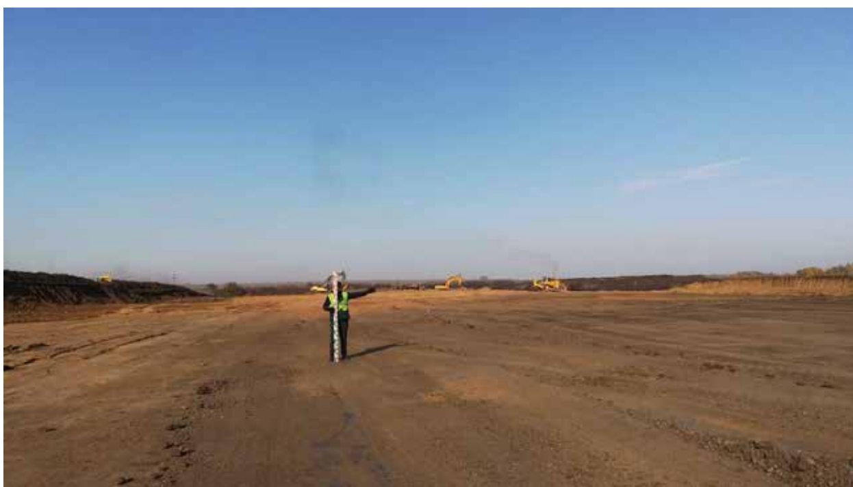
Рис. 157. Объект «Строительство железнодорожных путей ООО «Шахта Сибирская». Точка фотофиксации 16. Координаты 54°31'10.33"С 86°16'50.98"В. Вид на З.
