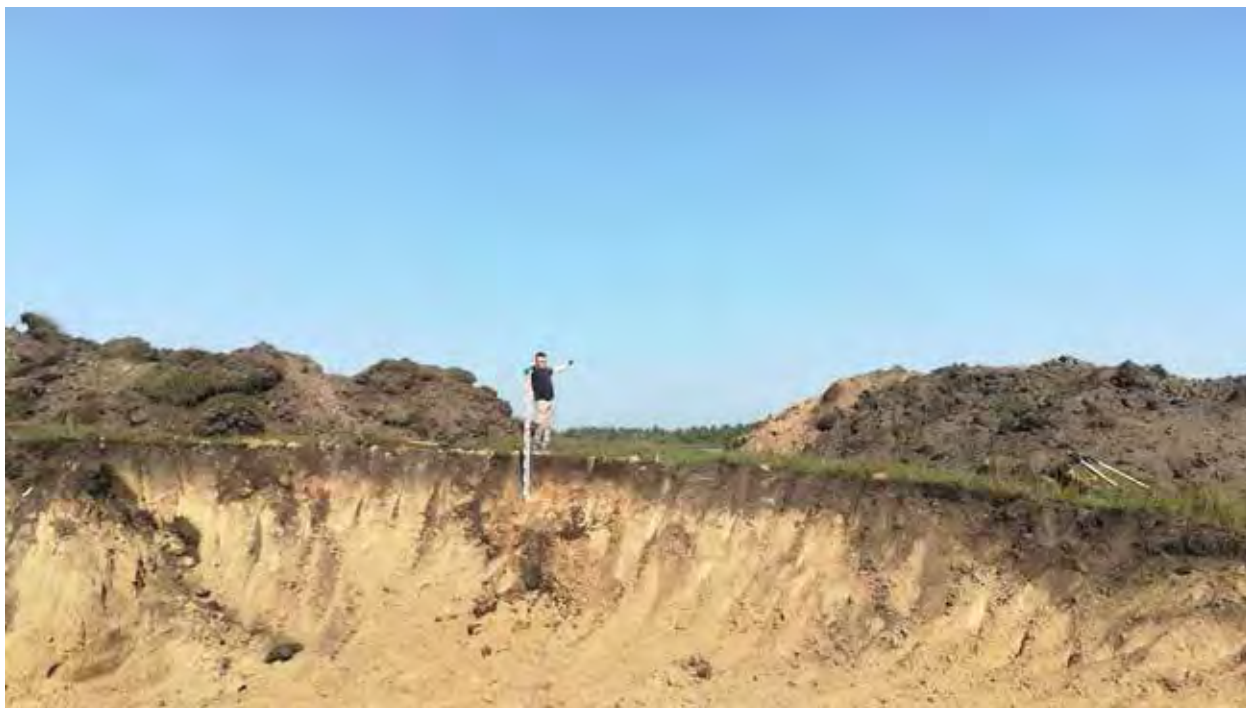
Рис. 39. Объект «Обогатительная фабрика «Шахта Сибирская». Зачистка 2 после завершения работ. Вид на С.
