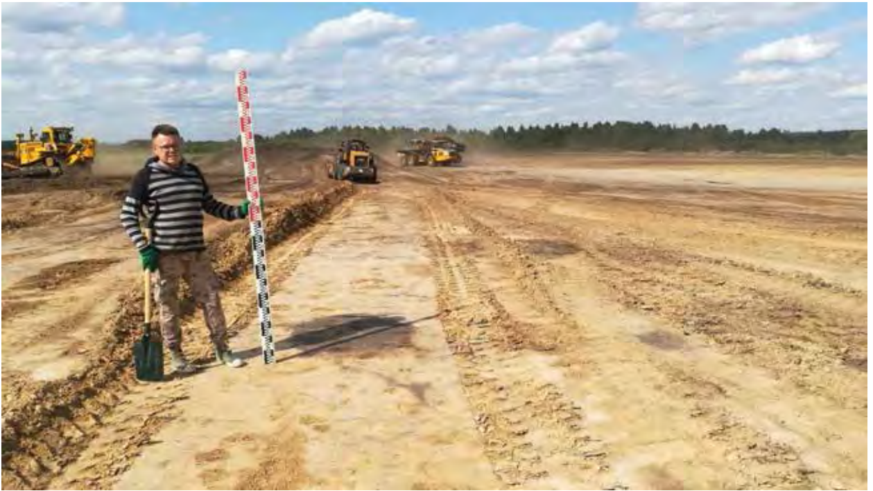
Рис. 27. Объект «Обогатительная фабрика «Шахта Сибирская». Точка фотофиксации 9. Координаты 54^{\circ}31'18.07''\text{С} 86^{\circ}16'49.62''\text{В} . Вид на С.
