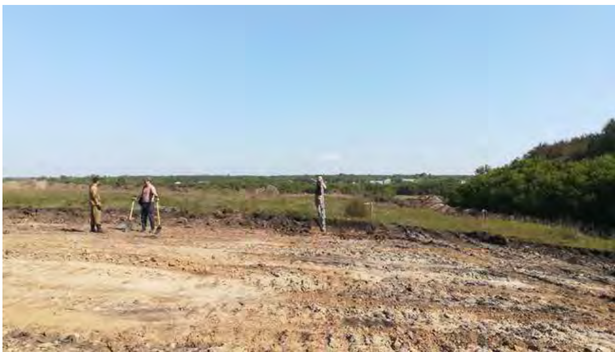
Рис. 42. Объект «Обогатительная фабрика «Шахта Сибирская». Зачистка 3 после завершения работ. Вид на С.
