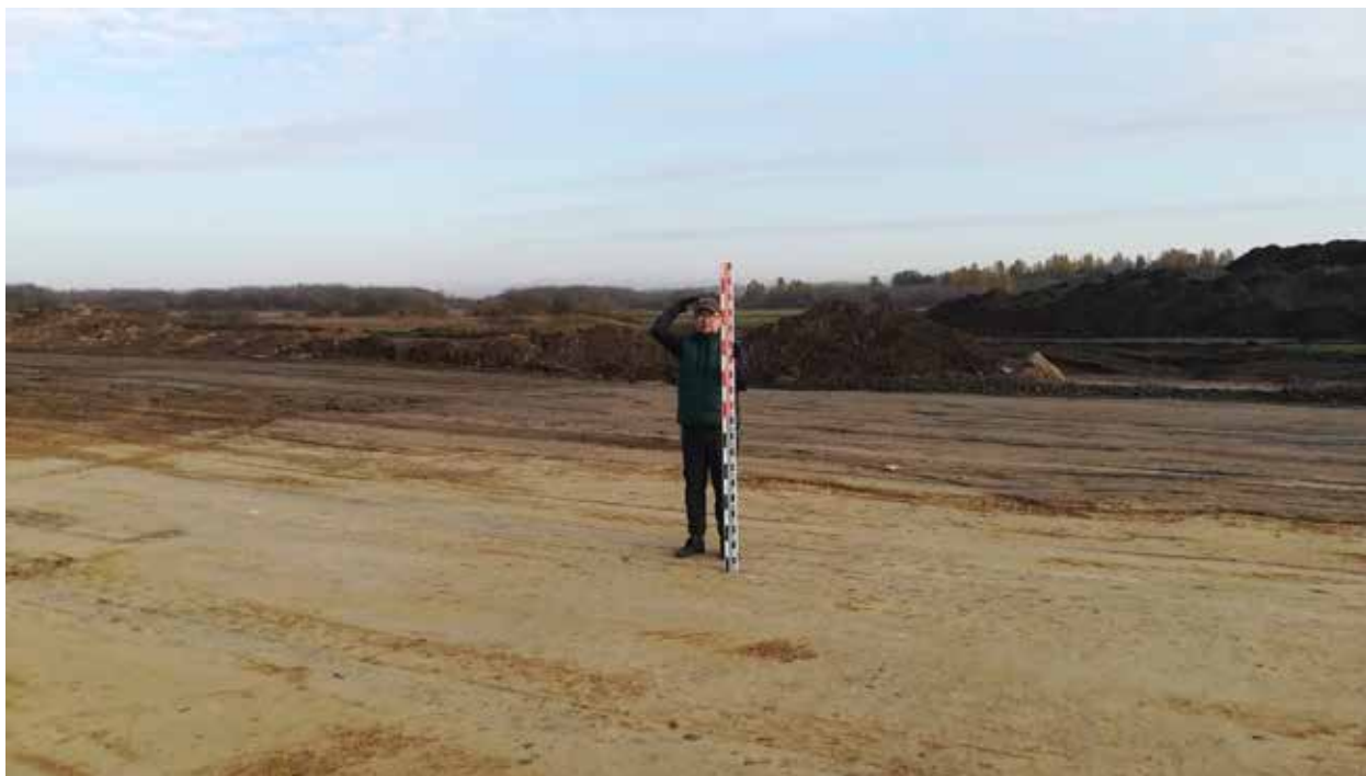
Рис. 144. Объект «Строительство железнодорожных путей ООО «Шахта Сибирская». Точка фотофиксации 13. Координаты 54°31'19.36"С 86°16'20.85"В. Вид на С.
