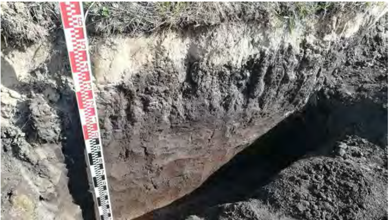
Рис. 36. Объект «Обогатительная фабрика «Шахта Сибирская». Профиль шурфа-зачистки 1. Вид на В.
