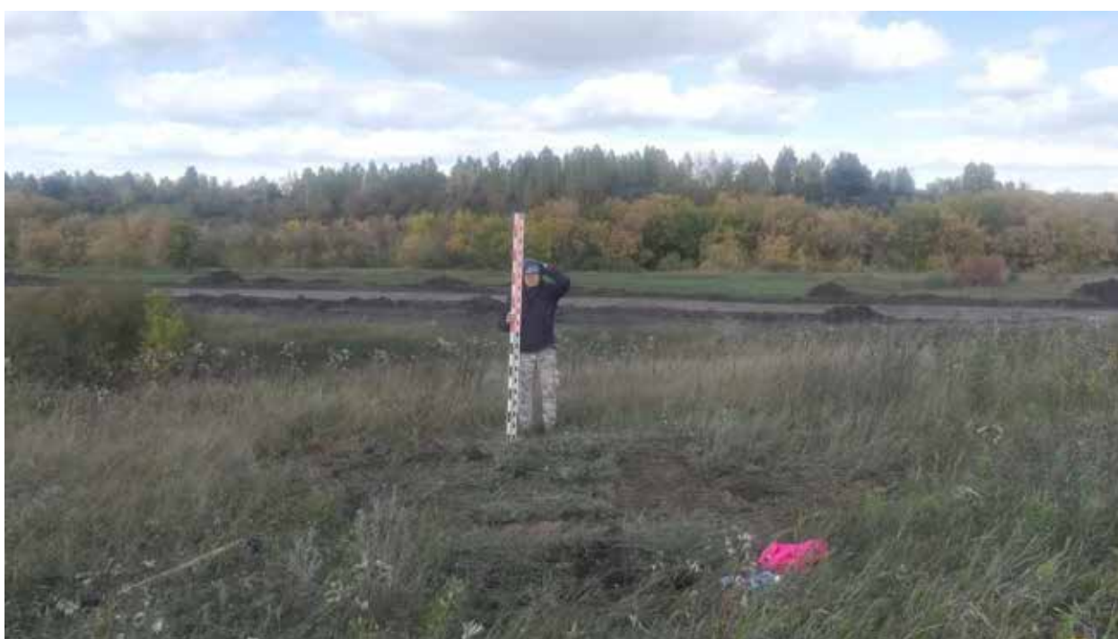
Рис.116. Объект «Обогатительная фабрика «Шахта Сибирская». Шурф 9, рекультивация. Вид на С.
