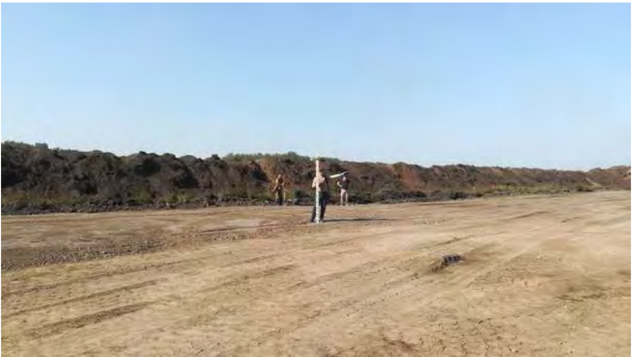
Рис. 10. Объект «Обогатительная фабрика «Шахта Сибирская». Точка фотофиксации 1. Координаты 54°31'1.36"С 86°17'15.32"В. Вид на З.
