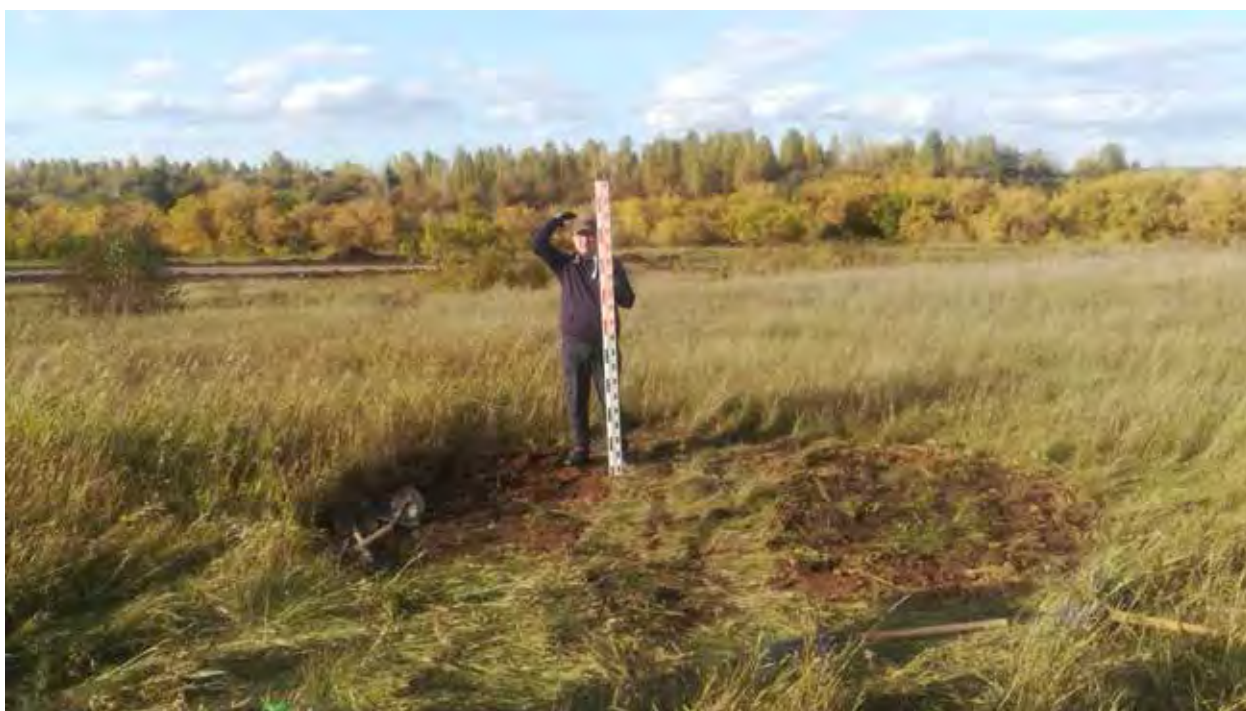
Рис. 99. Объект «Обогатительная фабрика «Шахта Сибирская». Шурф 7, рекультивация. Вид на С.
