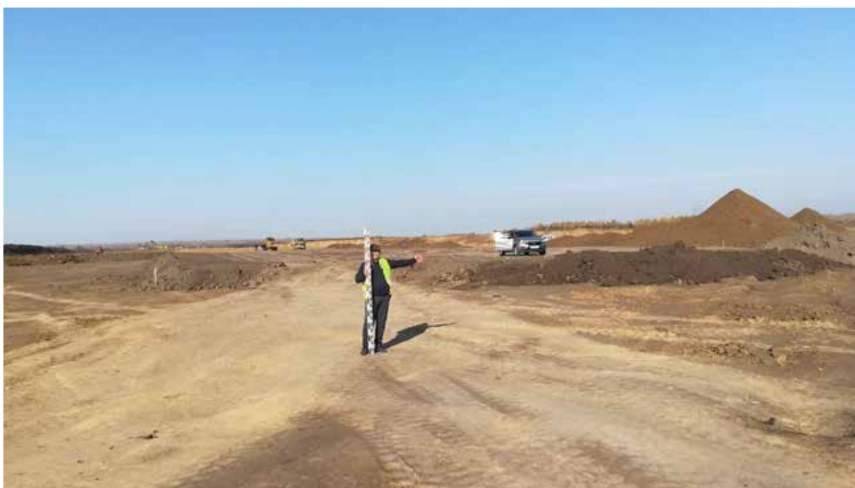
Рис. 161. Объект «Строительство железнодорожных путей ООО «Шахта Сибирская». Точка фотофиксации 17. Координаты 54°31'5.36"С 86°17'6.12"В. Вид на З.
