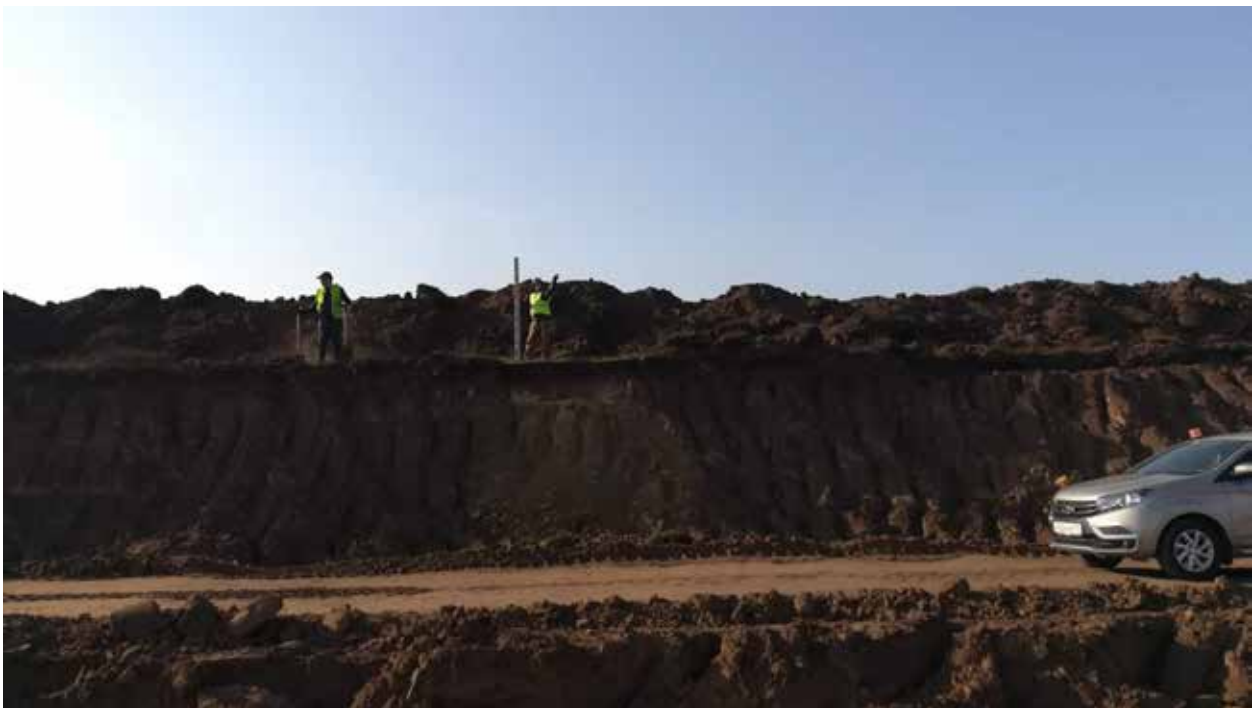
Рис. 183. Объект «Строительство железнодорожных путей ООО «Шахта Сибирская». Зачистка 11 после завершения работ. Вид на Ю.
