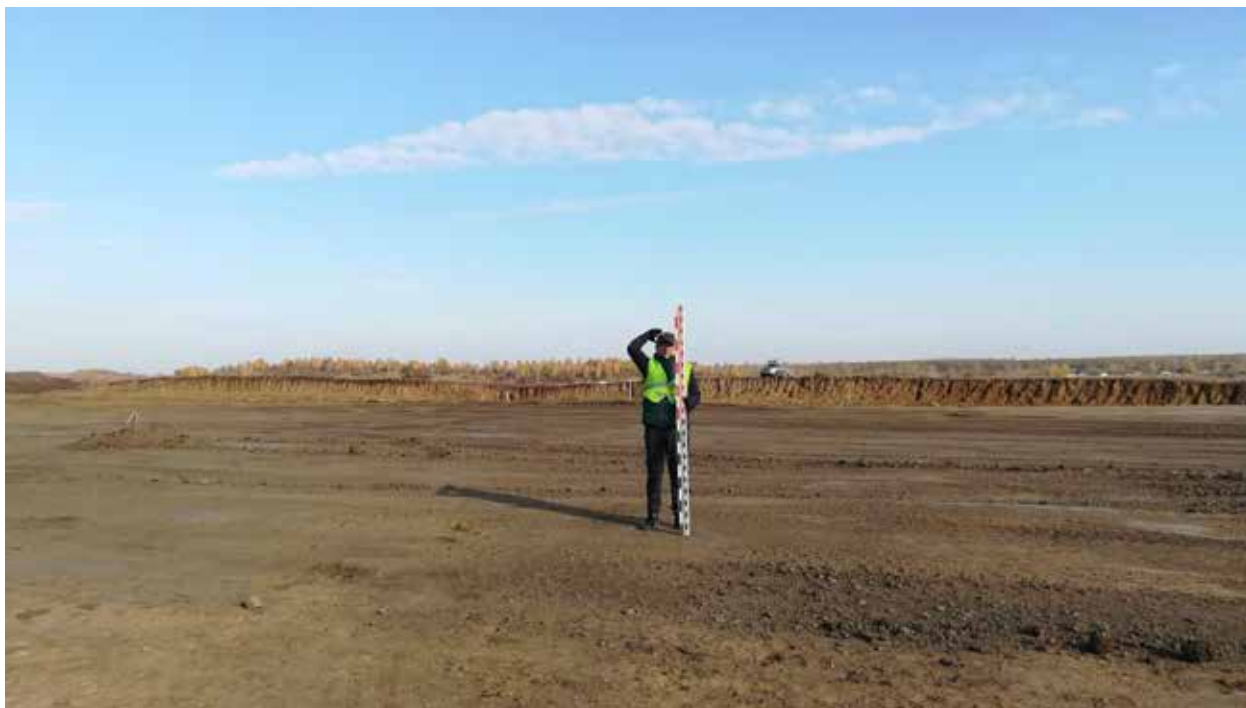
Рис. 154. Объект «Строительство железнодорожных путей ООО «Шахта Сибирская». Точка фотофиксации 16. Координаты 54^{\circ}31'10.33''\text{С} 86^{\circ}16'50.98''\text{В} . Вид на С.
