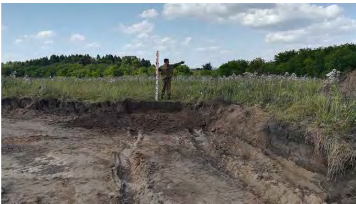
Рис. 60. Объект «Обогатительная фабрика «Шахта Сибирская». Зачистка 4 после завершения работ. Вид на З.
