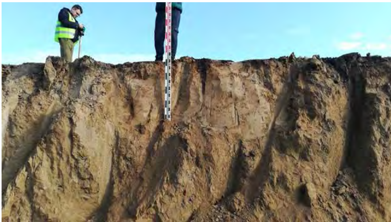
Рис. 178. Объект «Строительство железнодорожных путей ООО «Шахта Сибирская». Профиль зачистки 9. Вид на С.
