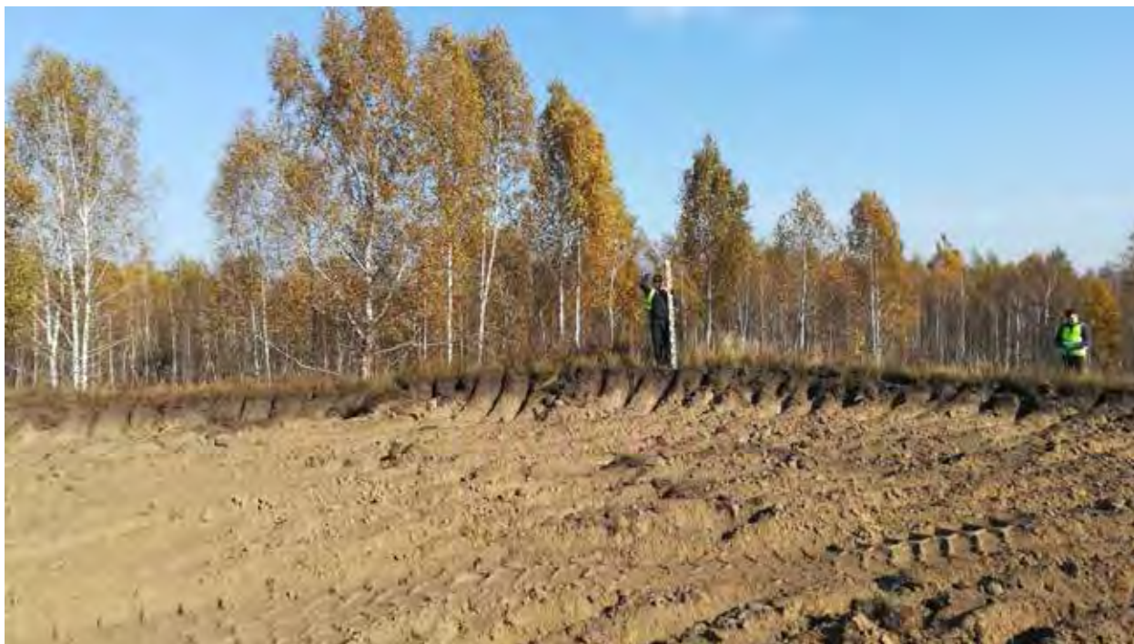
Рис. 188. Объект «Строительство железнодорожных путей ООО «Шахта Сибирская». Место зачистки 13. Координаты 54°30'52.40"С 86°17'30.60"В. Вид на С.
