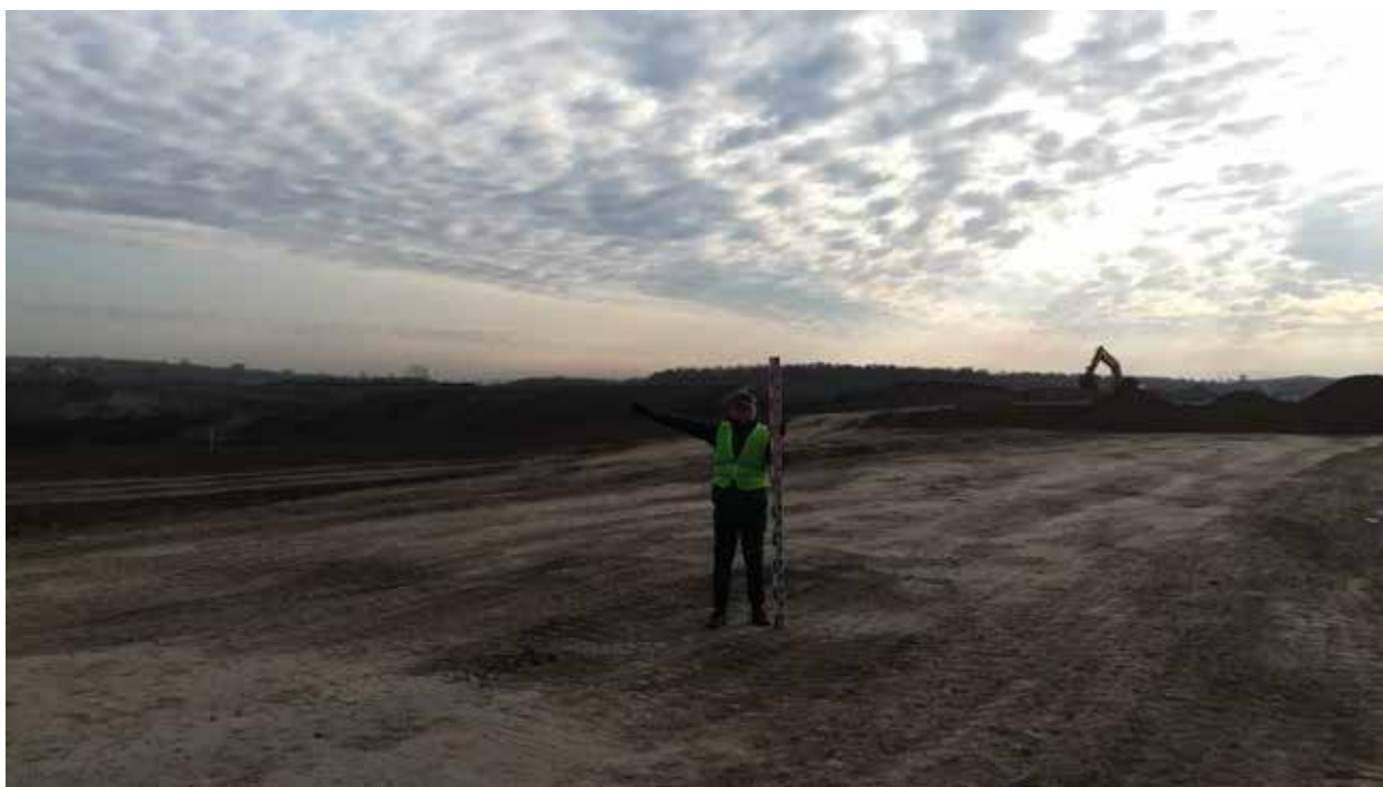
Рис. 149. Объект «Строительство железнодорожных путей ООО «Шахта Сибирская». Точка фотофиксации 14. Координаты 54^{\circ}31'15.01''\text{С} 86^{\circ}16'37.97''\text{В} . Вид на В.
