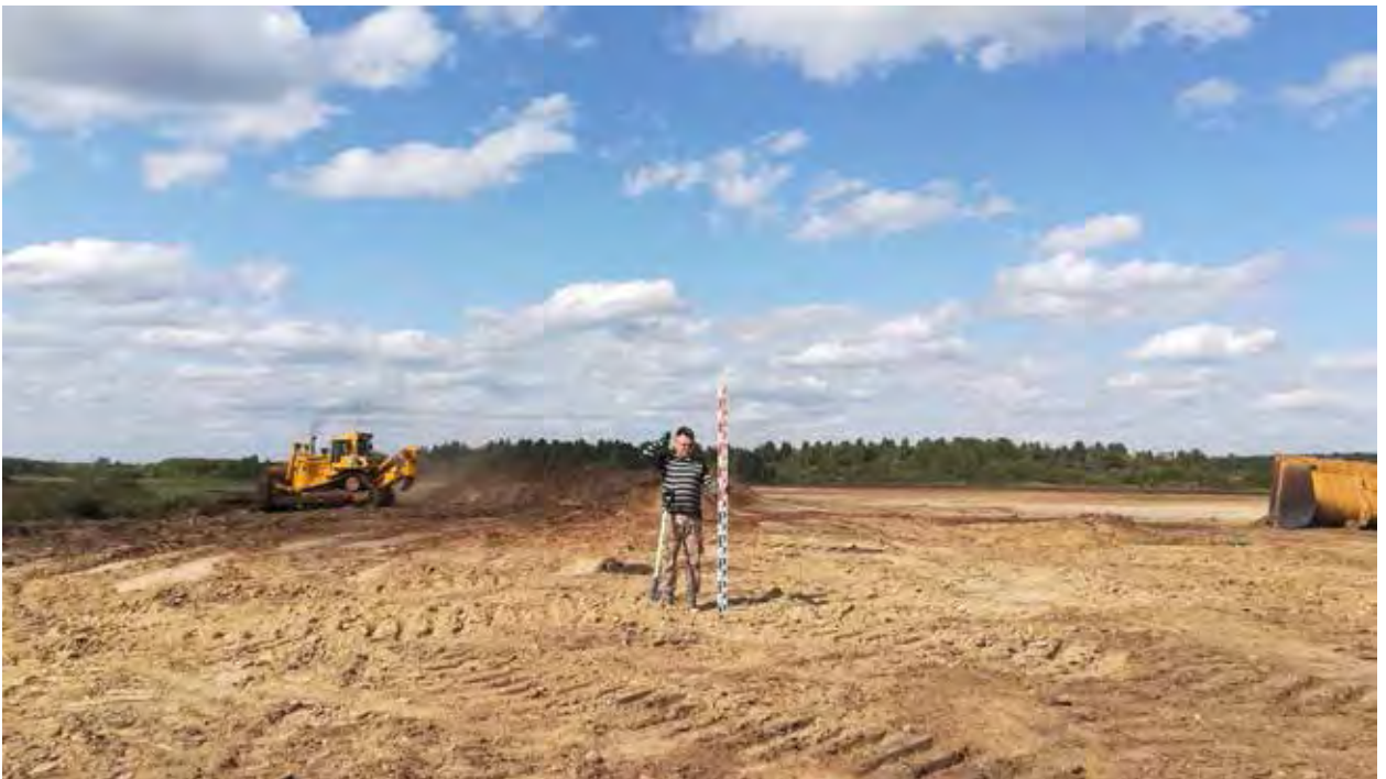
Рис. 28. Объект «Обогатительная фабрика «Шахта Сибирская». Точка фотофиксации 10. Координаты 54^{\circ}31'16.70''\text{С} 86^{\circ}16'48.41''\text{В} . Вид на С.
