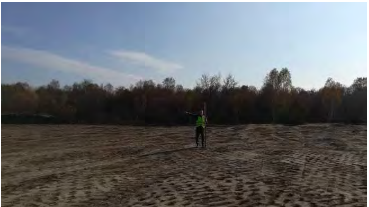
Рис. 163. Объект «Строительство железнодорожных путей ООО «Шахта Сибирская». Точка фотофиксации 18. Координаты 54^{\circ}31'1.77''\text{С} 86^{\circ}17'18.27''\text{В} . Вид на В.
