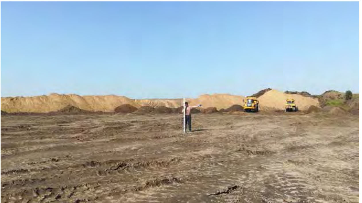
Рис. 14. Объект «Обогатительная фабрика «Шахта Сибирская». Точка фотофиксации 2. Координаты 54°31'6.92"С 86°17'10.40"В. Вид на З.
