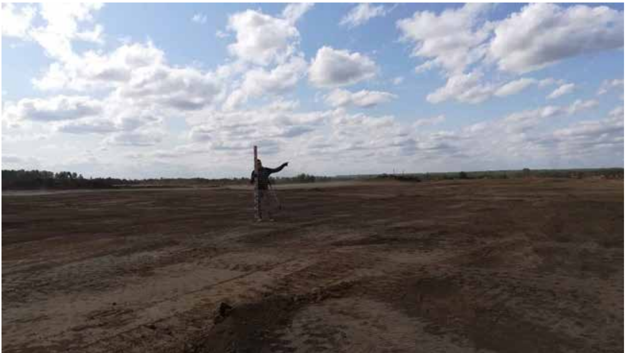
Рис. 34. Объект «Обогатительная фабрика «Шахта Сибирская». Точка фотофиксации 11. Координаты 54°31'16.04"С 86°16'57.48"В. Вид на З.
