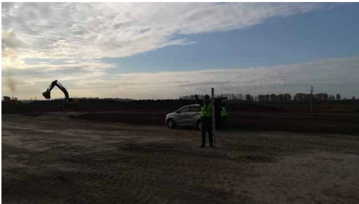
Рис. 150. Объект «Строительство железнодорожных путей ООО «Шахта Сибирская». Точка фотофиксации 14. Координаты 54^{\circ}31'15.01''\text{С} 86^{\circ}16'37.97''\text{В} . Вид на Ю.
