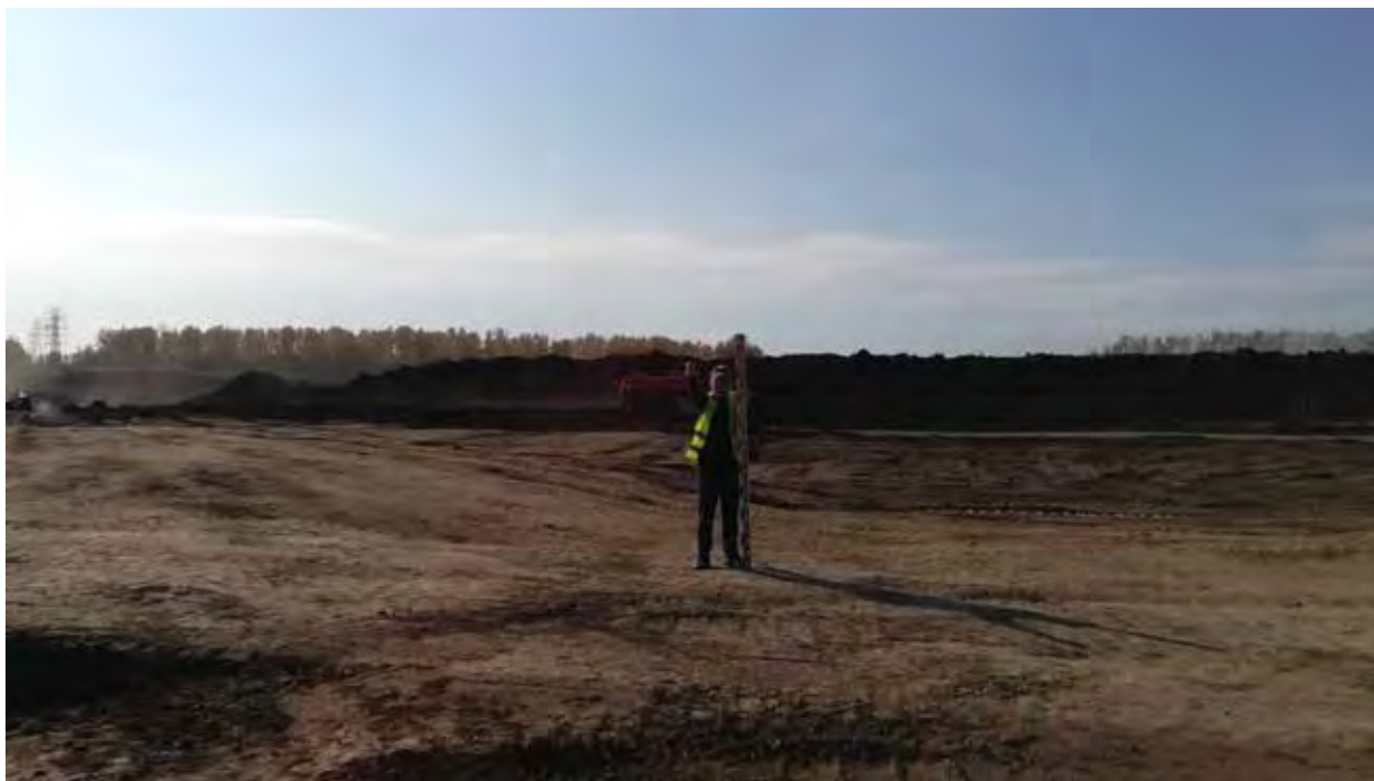
Рис. 160. Объект «Строительство железнодорожных путей ООО «Шахта Сибирская». Точка фотофиксации 17. Координаты 54°31'5.36"С 86°17'6.12"В. Вид на Ю.
