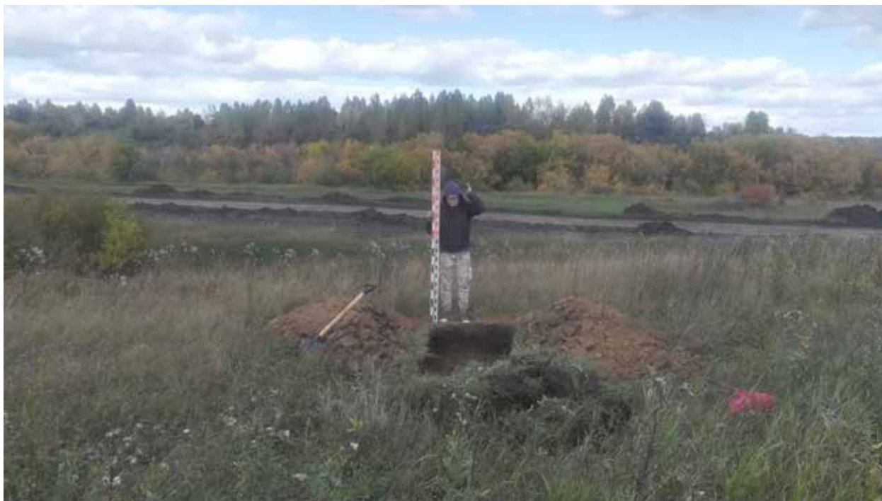
Рис. 113. Объект «Обогатительная фабрика «Шахта Сибирская». Шурф 9 после выборки. Вид на С.
