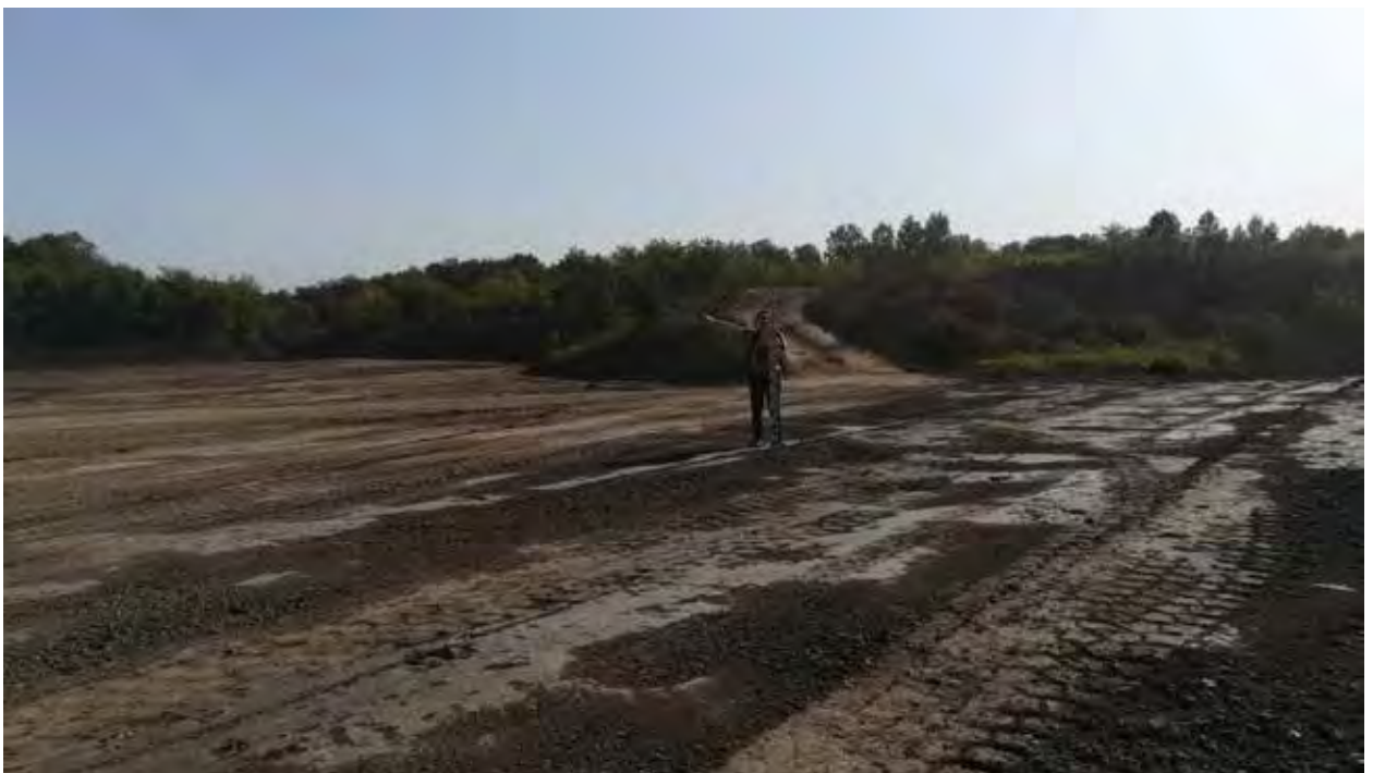
Рис. 8. Объект «Обогатительная фабрика «Шахта Сибирская». Точка фотофиксации 1. Координаты 54°31'1.36"С 86°17'15.32"В. Вид на В.
