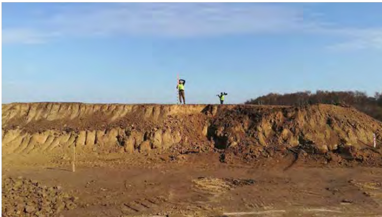
Рис. 186. Объект «Строительство железнодорожных путей ООО «Шахта Сибирская». Зачистка 12 после завершения работ. Вид на С.
