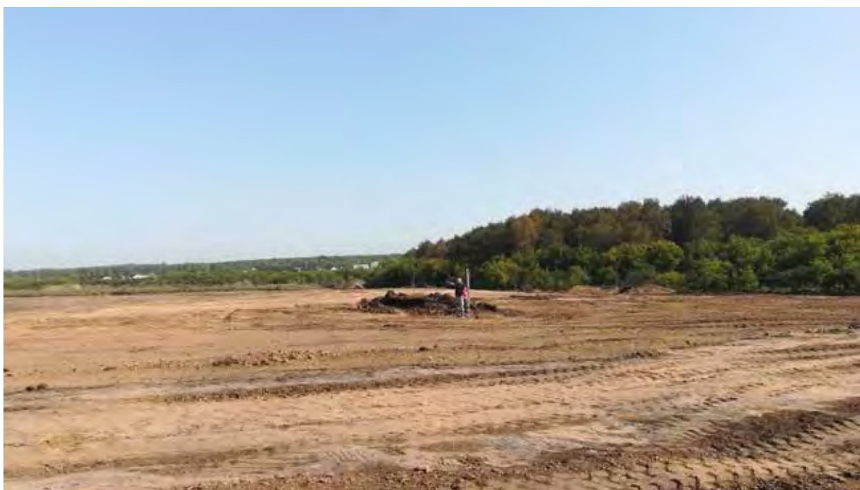
Рис. 16. Объект «Обогатительная фабрика «Шахта Сибирская». Точка фотофиксации 3. Координаты 54°31'10.47"С 86°17'4.42"В. Вид на В.
