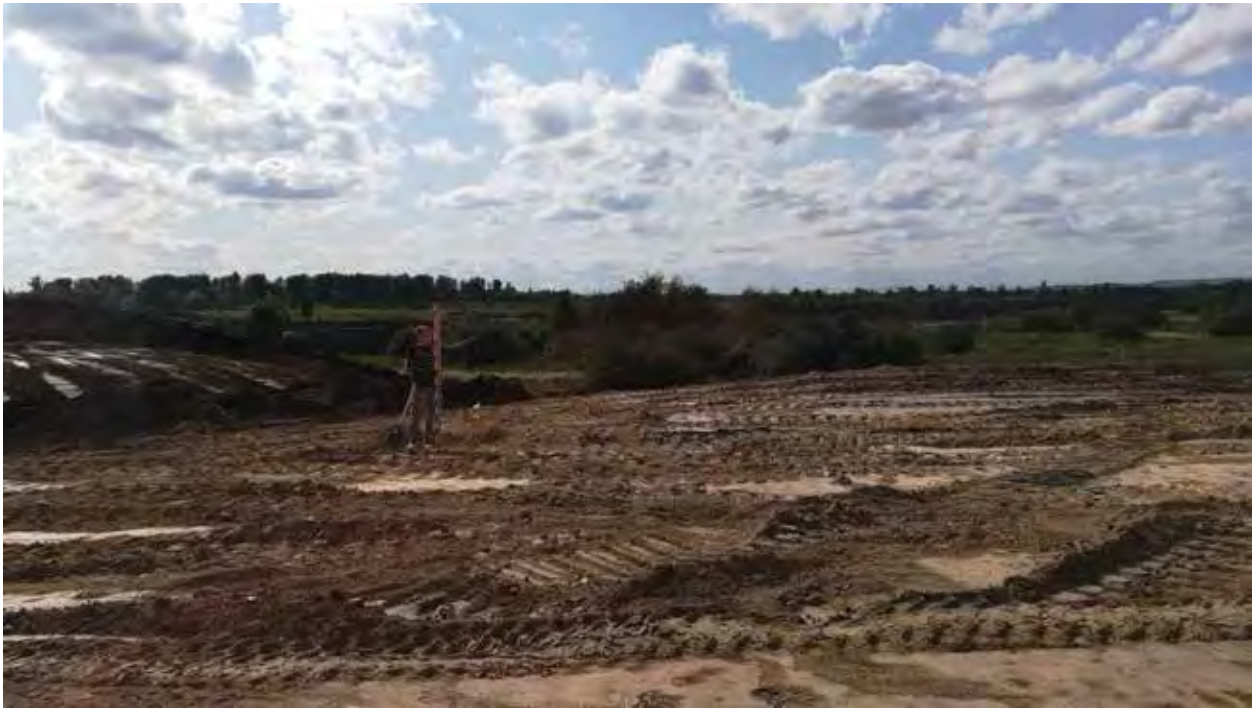
Рис. 31. Объект «Обогатительная фабрика «Шахта Сибирская». Точка фотофиксации 10. Координаты 54°31'16.70"С 86°16'48.41"В. Вид на З.
