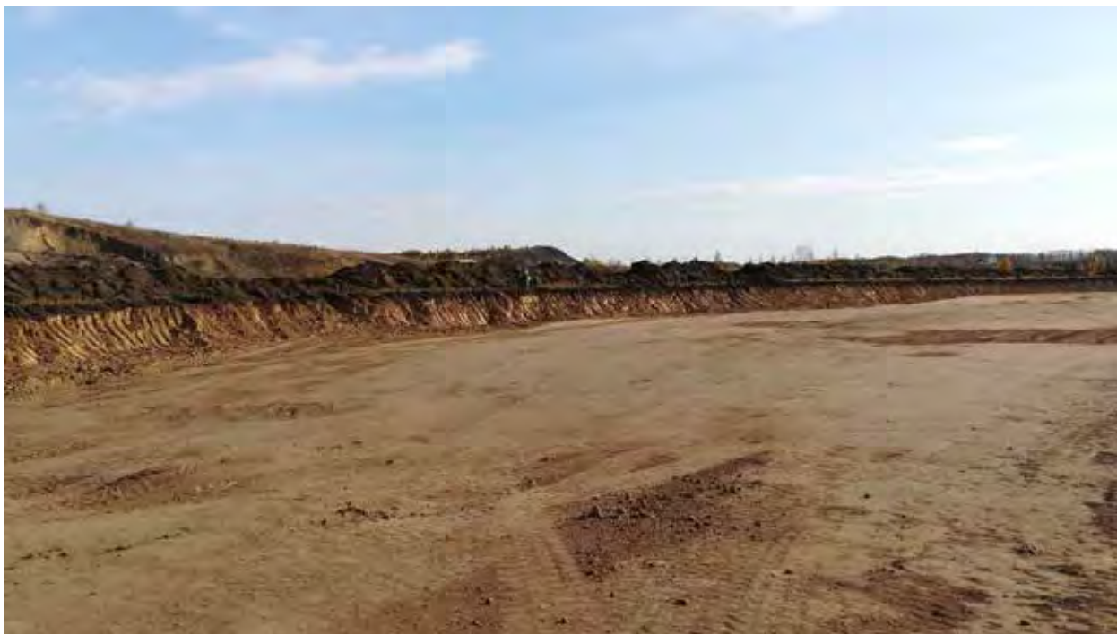
Рис. 200. Объект «Строительство железнодорожных путей ООО «Шахта Сибирская». Зачистка 15 после завершения работ. Вид на СВ.
