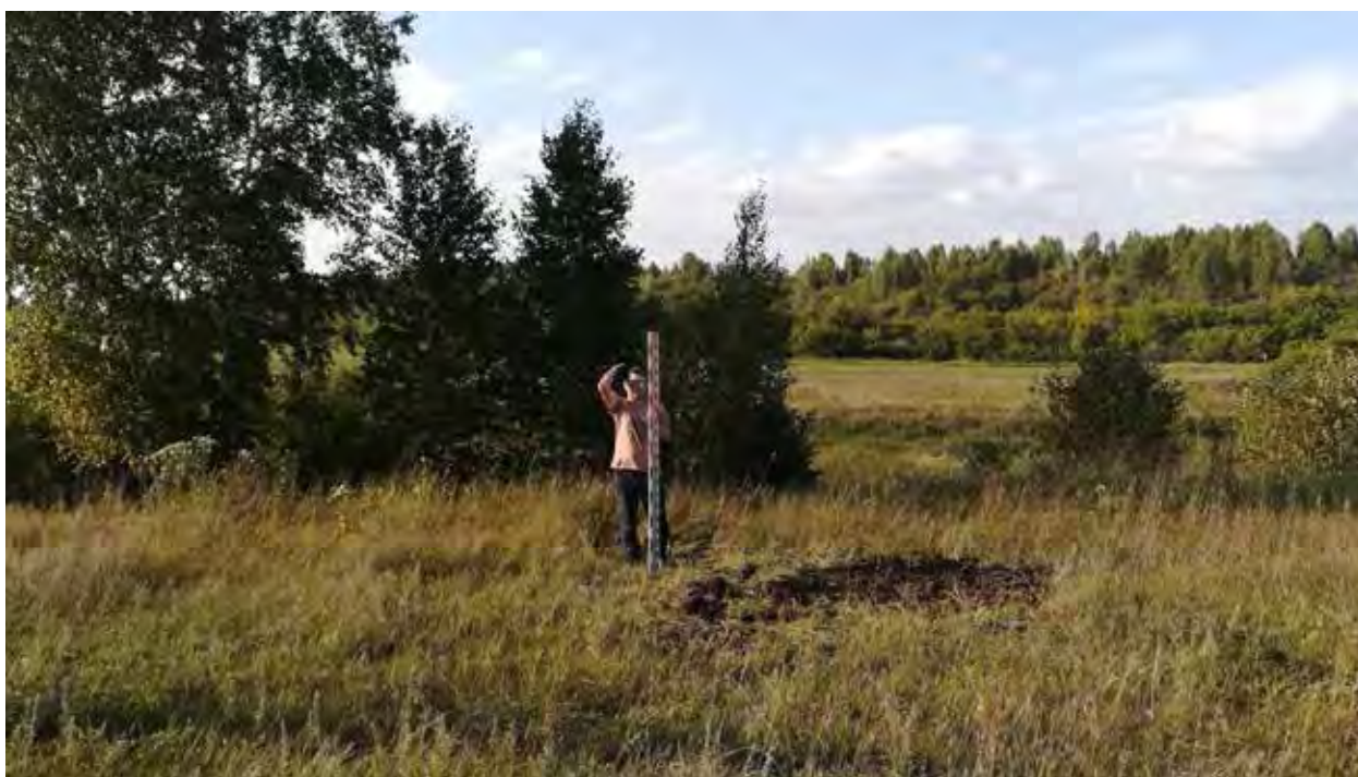
Рис. 74. Объект «Обогатительная фабрика «Шахта Сибирская». Шурф 5, рекультивация. Вид на С.
