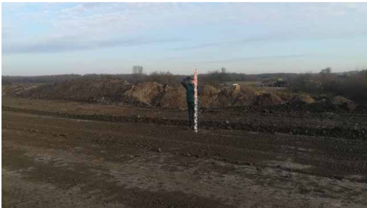
Рис. 140. Объект «Строительство железнодорожных путей ООО «Шахта Сибирская». Точка фотофиксации 12. Координаты 54°31'23.70"С 86°16'11.25"В. Вид на С.
