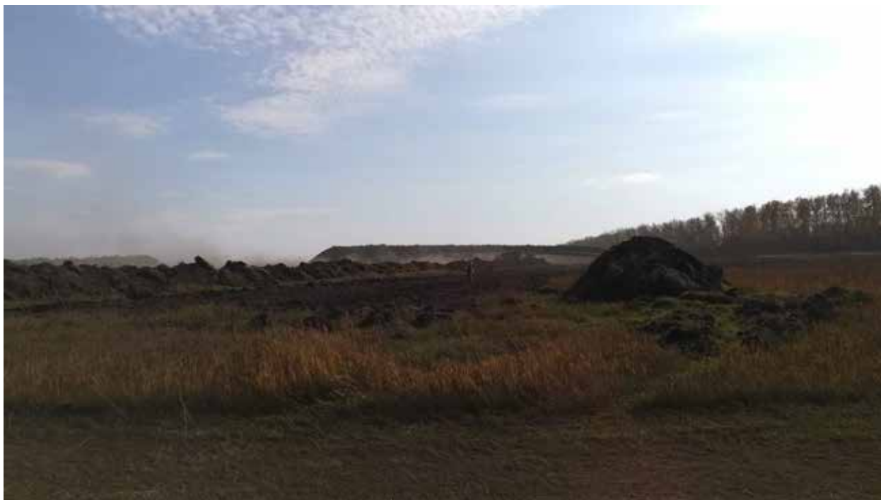
Рис. 166. Объект «Строительство железнодорожных путей ООО «Шахта Сибирская». Точка фотофиксации 19. Координаты 54°30'48.69"С 86°17'34.52"В. Вид на В.
