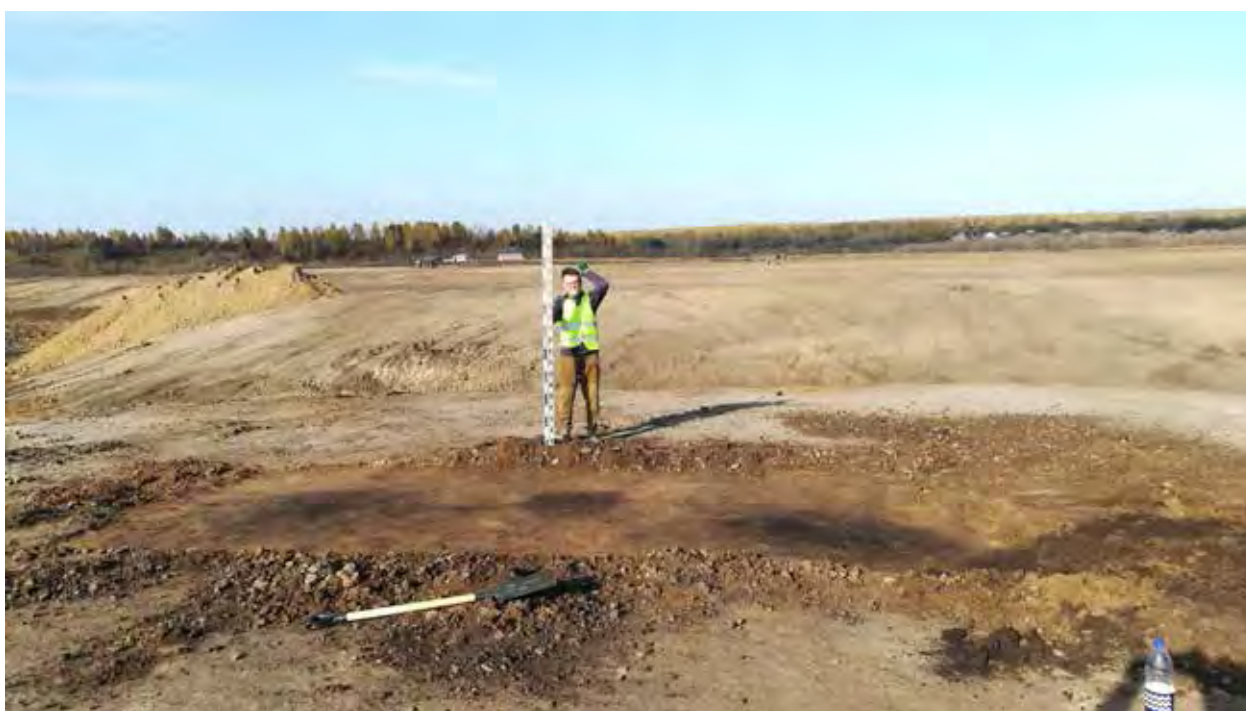
Рис. 135. Объект «Обогащительная фабрика «Шахта Сибирская». Юго-восточная часть земельного отвода. Общий вид «пятен» на уровне желтого суглинка. Ямы 10, 11, 12. Вид на С.
