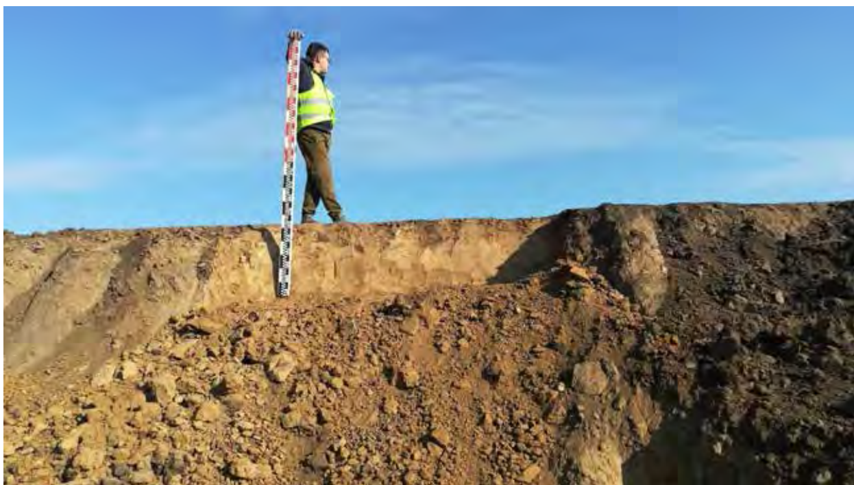
Рис. 187. Объект «Строительство железнодорожных путей ООО «Шахта Сибирская». Профиль зачистки 12. Вид на С.
