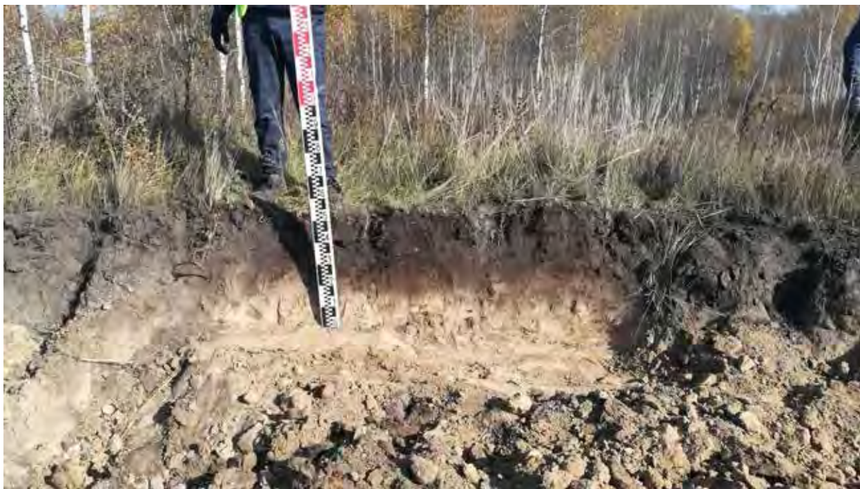
Рис. 190. Объект «Строительство железнодорожных путей ООО «Шахта Сибирская». Профиль зачистки 13. Вид на С.
