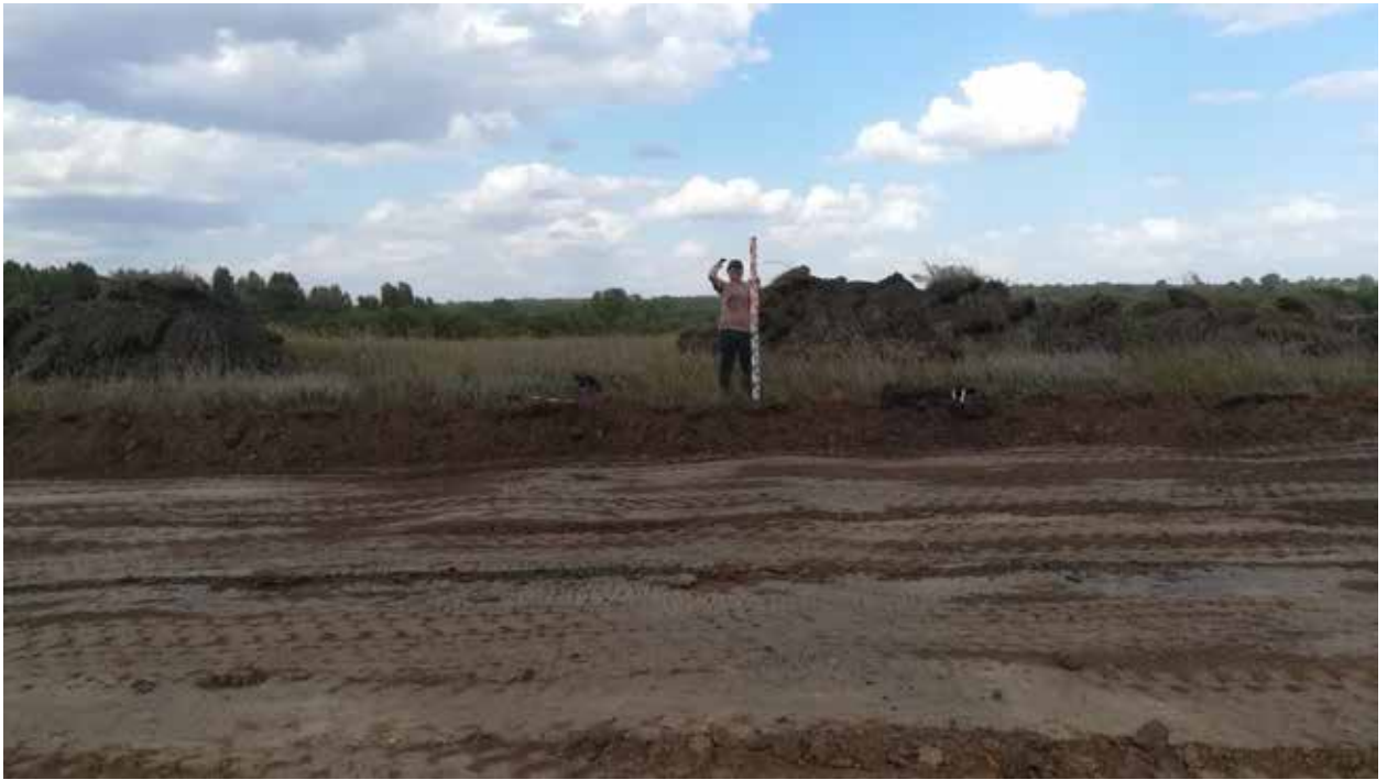
Рис. 67. Объект «Обогатительная фабрика «Шахта Сибирская». Место зачистки 5. Координаты 54°31'24.28"С 86°16'50.09"В. Вид на С.
