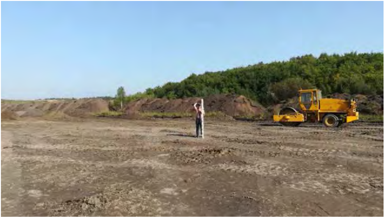
Рис. 11. Объект «Обогатительная фабрика «Шахта Сибирская». Точка фотофиксации 2. Координаты 54°31'6.92"С 86°17'10.40"В. Вид на С.
