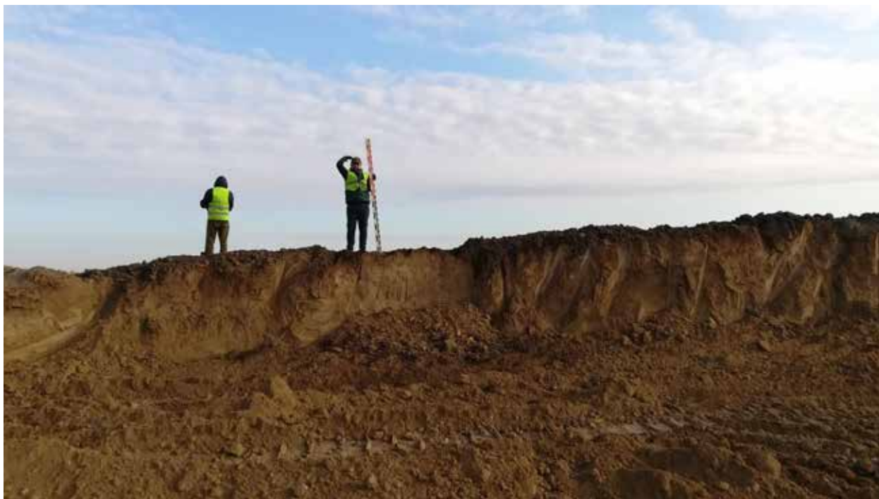
Рис. 174. Объект «Строительство железнодорожных путей ООО «Шахта Сибирская». Зачистка 8 после завершения работ. Вид на С.
