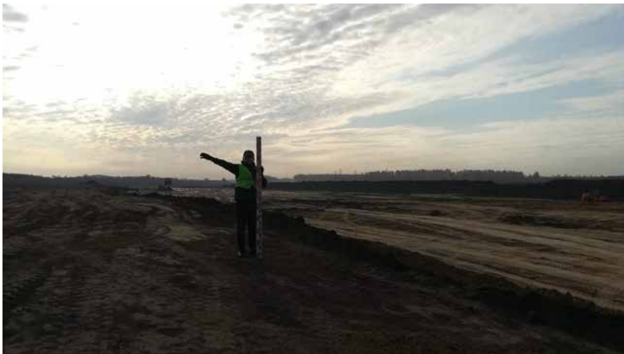
Рис. 152. Объект «Строительство железнодорожных путей ООО «Шахта Сибирская». Точка фотофиксации 15. Координаты 54°31'14.22"С 86°16'45.61"В. Вид на В.
