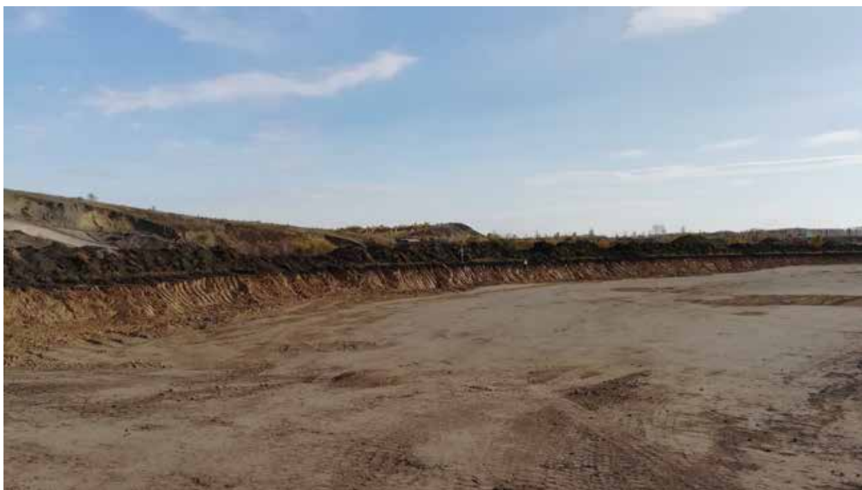
Рис. 199. Объект «Строительство железнодорожных путей ООО «Шахта Сибирская». Место зачистки 15. Координаты 54^{\circ}30'43.59''\text{C} 86^{\circ}17'51.61''\text{В} . Вид на СВ.
