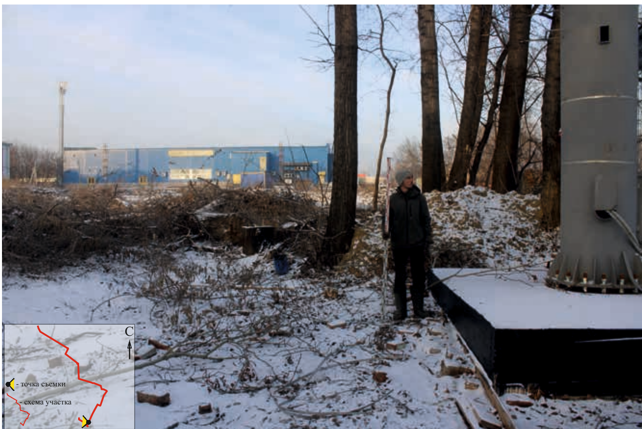
Приложение № 27. Археологическая разведка земель, отводимых под объект: «Реконструкция участков ВЛ 35 кВ Б-19, ВЛ 35 кВ Б-20 с заменой существующего провода на провод большим сечением, 16,5 км в рамках исполнения договора ТП с ОАО "РЖД" по д. №20.4200.1024.20» в Беловском районе, Кемеровская область - Кузбасс в 2023 г. Общие виды объекта: 1 - вид с З; 2 - вид с В.
