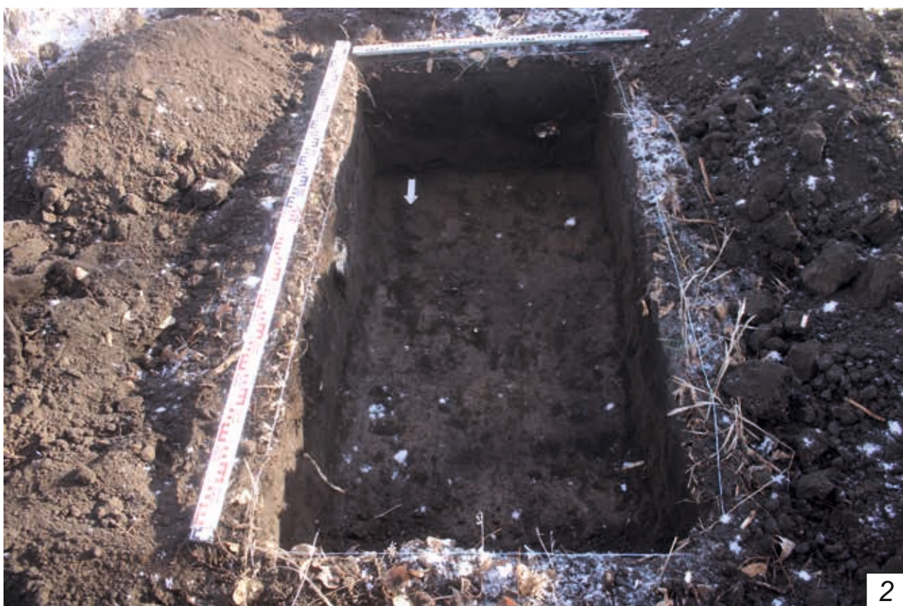
Археологическая разведка земель, отводимых под объект: «Реконструкция участков ВЛ 35 кВ Б-19, ВЛ 35 кВ Б-20 с заменой существующего провода на провод большим сечением, 16,5 км в рамках исполнения договора ТП с ОАО "РЖД" по д. №20.4200.1024.20» в Беловском районе, Кемеровская область - Кузбасс в 2023 г. Шурф №6, общий вид шурфа после раскопок: 1, 2 - вид с С.
