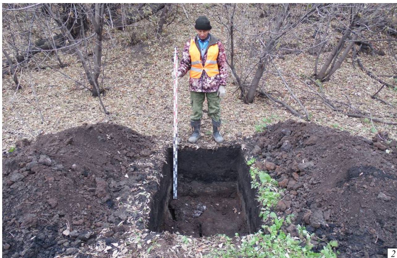
Рис. 59. Археологическое обследование земельного участка, подлежащего воздействию земельных, строительных, хозяйственных и иных работ для разработки раздела проектной документации по титулу «Трубопровод подачи осветленной воды с ЦОС на ОФ ш. им. Кирова АО «СУЭК-Кузбасс» в Ленинск-Кузнецком городском округе Кемеровской области – Кузбасса. Шурф №6. 1 - общий вид до начала работ. 2 - общий вид после выборки. Везде вид на север.
