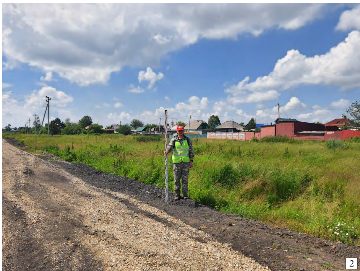
Рис. 29. Археологическое обследование земельного участка, подлежащего воздействию земляных, строительных, хозяйственных и иных работ для разработки раздела проектной документации по объекту «Строительство централизованной сети водоснабжения микрорайона «Прибрежный» Орджоникидзевского района г. Новокузнецка. 1 очередь» (Новокузнецкий городской округ, г. Новокузнецк, Кемеровская область – Кузбасс). Точка фотофиксации №10: 1 - вид на юг; 2 - вид на запад.
