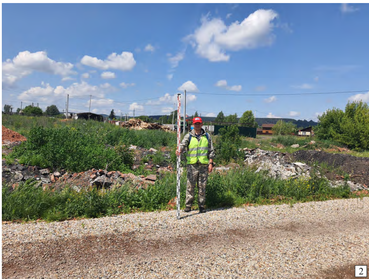
Рис. 13. Археологическое обследование земельного участка, подлежащего воздействию земляных, строительных, хозяйственных и иных работ для разработки раздела проектной документации по объекту «Строительство централизованной сети водоснабжения микрорайона «Прибрежный» Орджоникидзевского района г. Новокузнецка. 1 очередь» (Новокузнецкий городской округ, г. Новокузнецк, Кемеровская область – Кузбасс). Точка фотофиксации №2: 1 - вид на юг; 2 - вид на запад.
