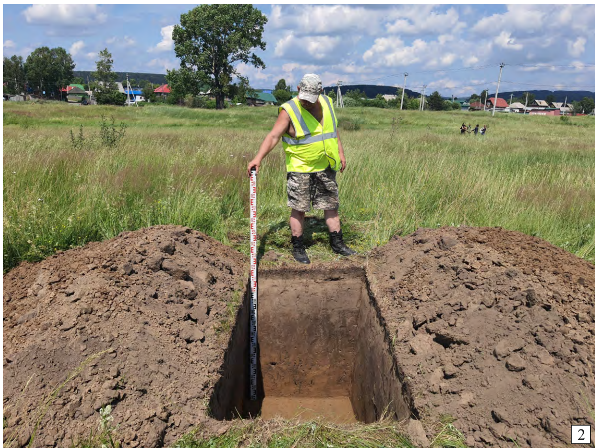
Рис. 80. Археологическое обследование земельного участка, подлежащего воздействию земляных, строительных, хозяйственных и иных работ для разработки раздела проектной документации по объекту «Строительство централизованной сети водоснабжения микрорайона «Прибрежный» Орджоникидзевского района г. Новокузнецка. 1 очередь» (Новокузнецкий городской округ, г. Новокузнецк, Кемеровская область – Кузбасс). Шурф №3: 1 - общий вид до начала работ; 2 - общий вид после выборки. Везде вид на север.
