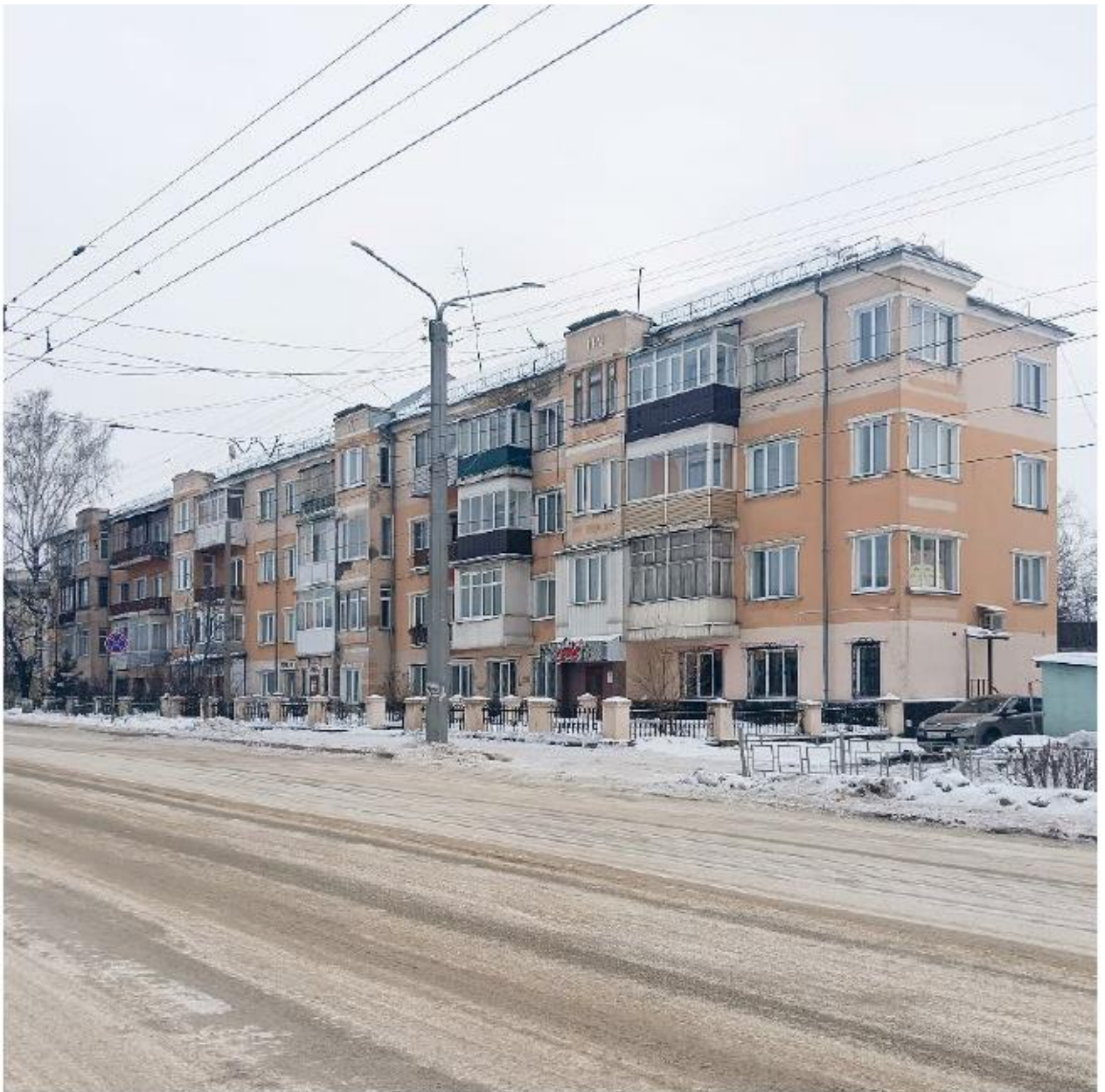
Общий вид на здание
