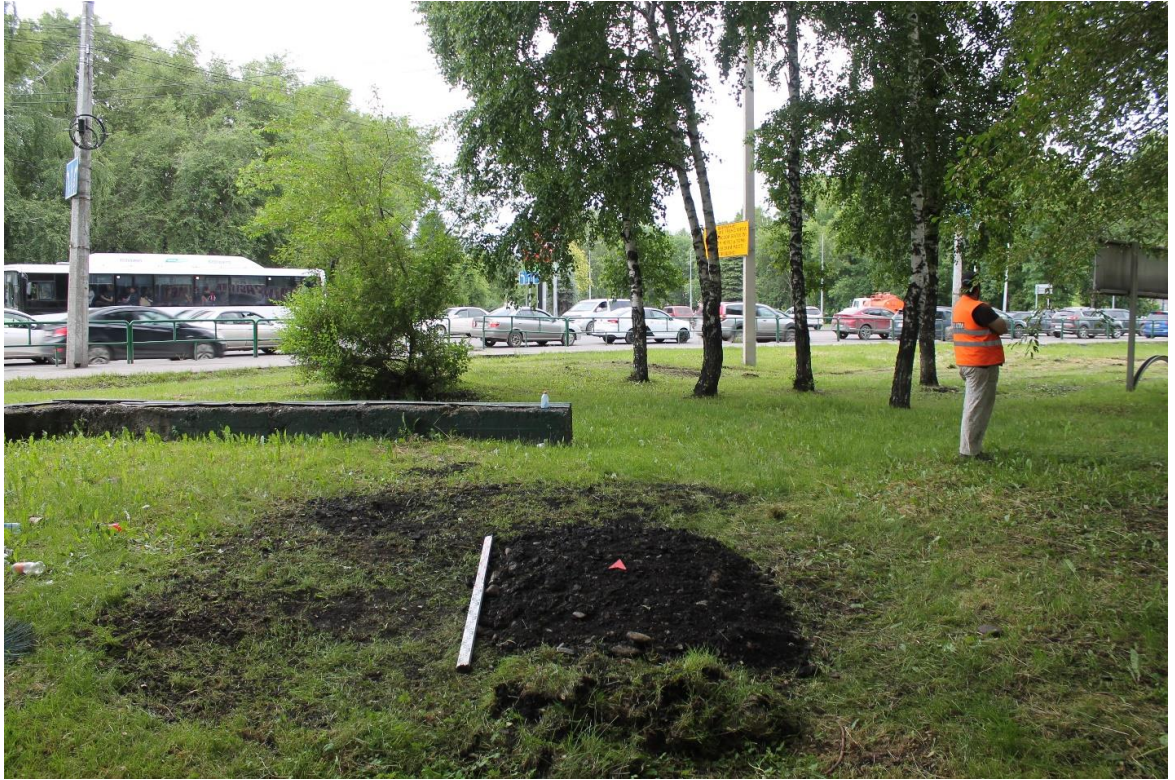
Рис.121. г. Новокузнецк, Кемеровская область, 2021 г. Участок-1. Шурф № 7. Вид после рекультивации, с юга
