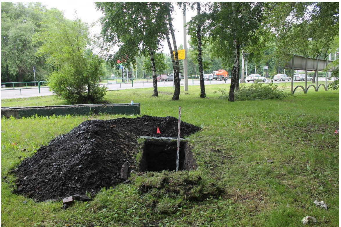
Рис.118. г. Новокузнецк, Кемеровская область, 2021 г. Участок-1. Шурф № 7. Общий вид на шурф, с юга
