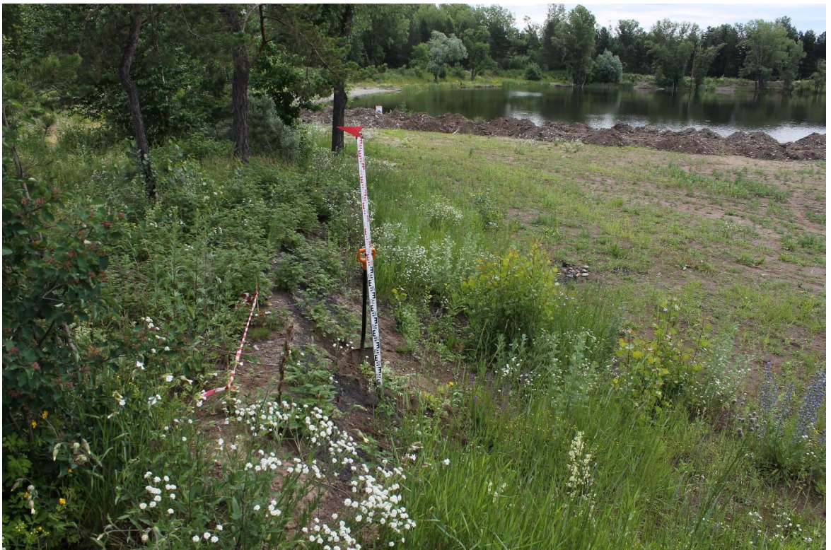
Рис.191. г. Новокузнецк, Кемеровская область, 2021 г. Участок-2. Зачистка № 2. Вид до начала работ, с запада
