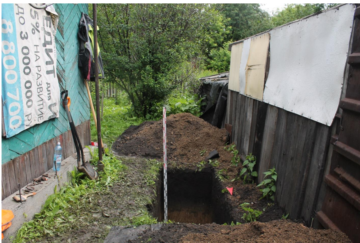
Рис.150. г. Новокузнецк, Кемеровская область, 2021 г. Участок-1. Шурф № 11. Общий вид на шурф (1), с севера
