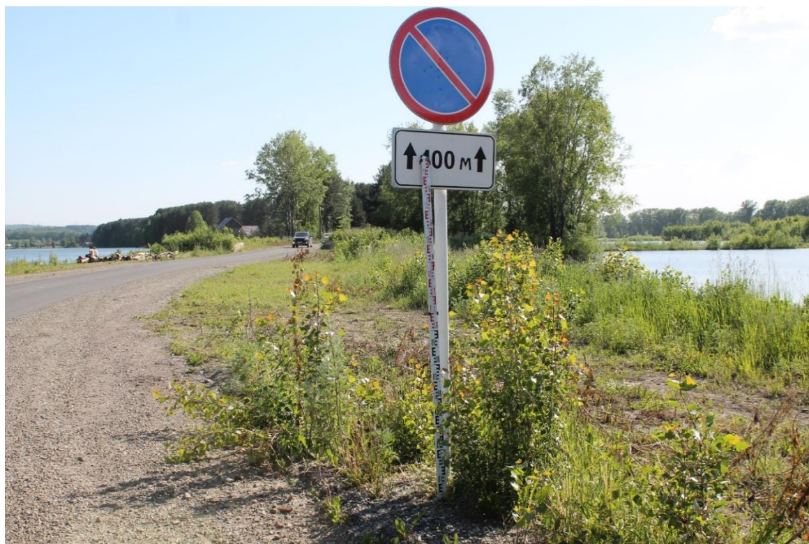
Рис.171. г. Новокузнецк, Кемеровская область, 2021 г. Участок-2. Южный сектор. Дамба через затопленные карьеры, точка Ф4 на схеме фотофиксации, вид с северо-северо-востока
