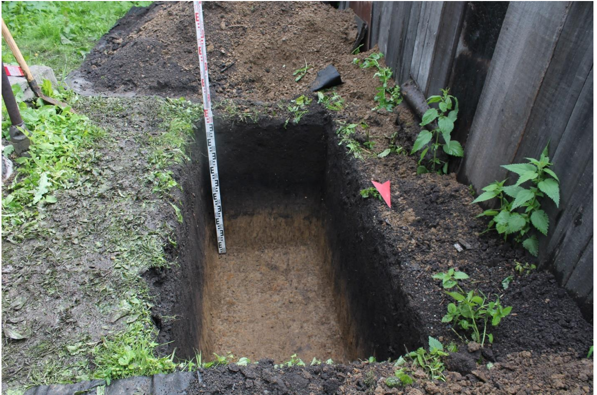
Рис.151. г. Новокузнецк, Кемеровская область, 2021 г. Участок-1. Шурф № 11. Общий вид на шурф (2), с севера
