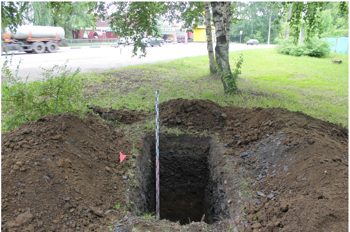
Рис.124. г. Новокузнецк, Кемеровская область, 2021 г. Участок-1. Шурф № 8. Общий вид на шурф, с севера
