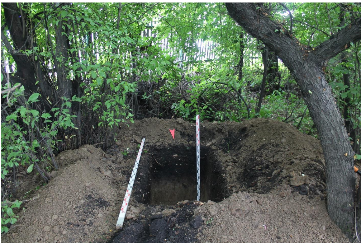
Рис.114. г. Новокузнецк, Кемеровская область, 2021 г. Участок-1. Шурф № 6. Общий вид на шурф, с севера
