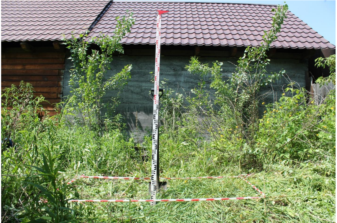
Рис.87. г. Новокузнецк, Кемеровская область, 2021 г. Участок-1. Шурф № 3. Вид до начала работ, с востока
