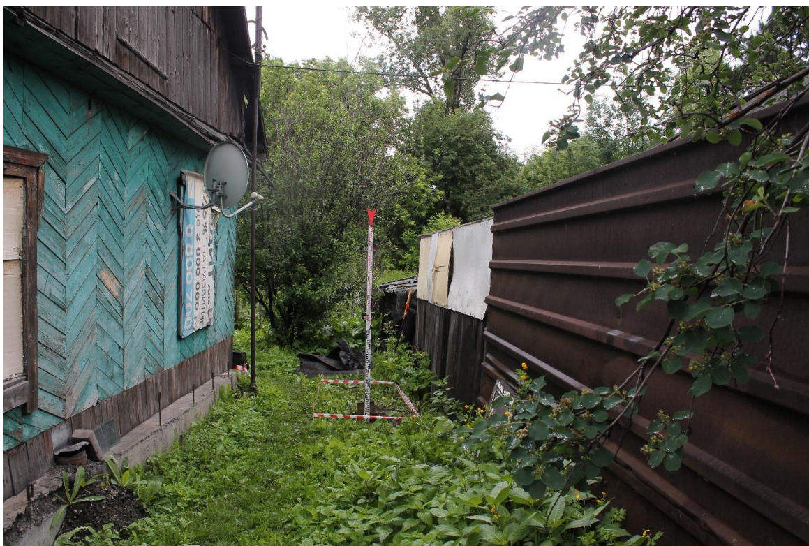
Рис.149. г. Новокузнецк, Кемеровская область, 2021 г. Участок-1. Шурф № 11. Вид до начала работ, с севера
