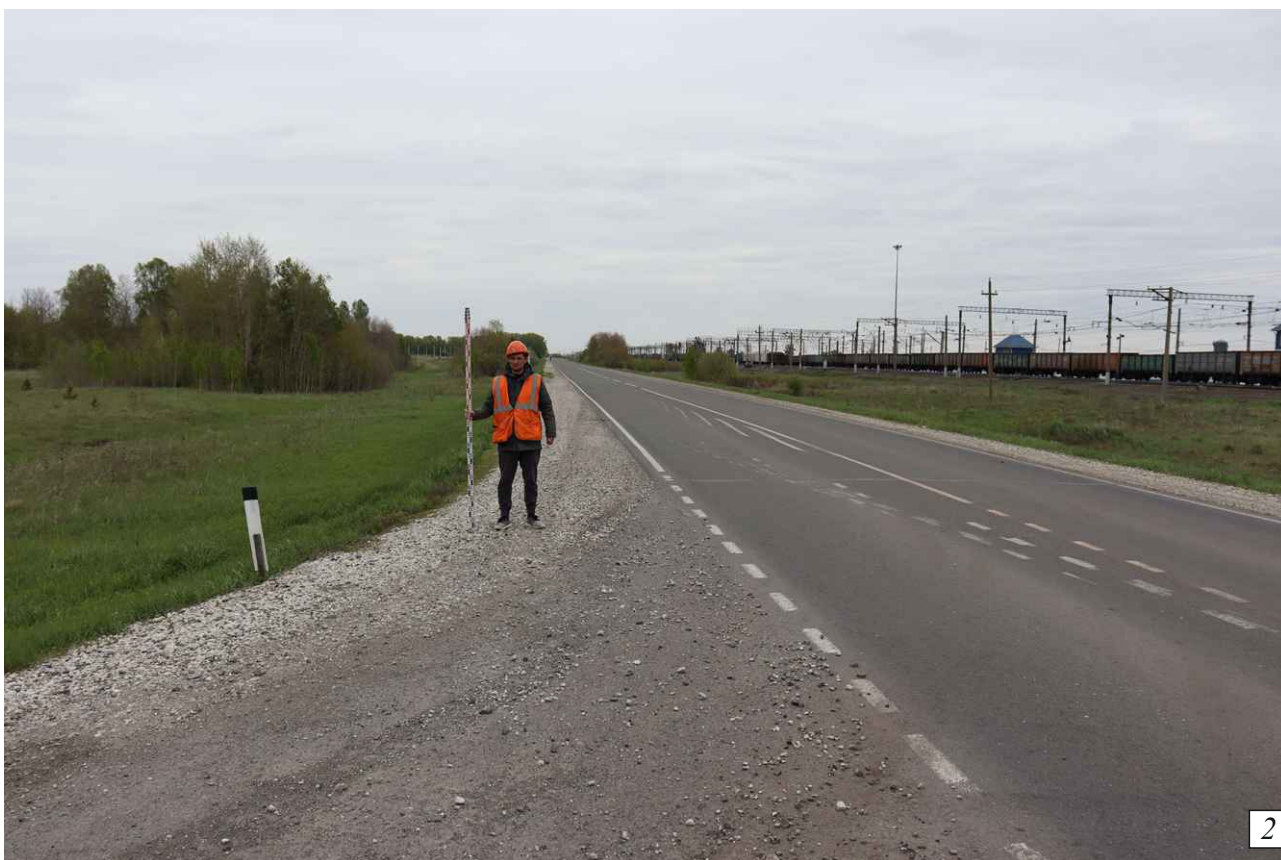
Рис. 16. Археологическое обследование земельного участка, подлежащего воздействию земельных, строительных, хозяйственных и иных работ для разработки раздела проектно-сметной документации по объекту «Станция Мариинск» Красноярской железной дороги» в Мариинском муниципальном районе Кемеровской области. Точка фотофиксации №4: 1 - вид на СЗ; 2 - вид на ЮЗ.
