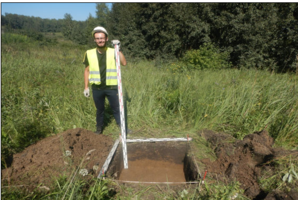
Рис. 370. Кемеровская область, Новокузнецкий муниципальный округ. «Объект размещения отходов АО «Шахта «Большевик». Корректировка». Шурф № 38. Вид после завершения земляных работ. Снято с юга.
