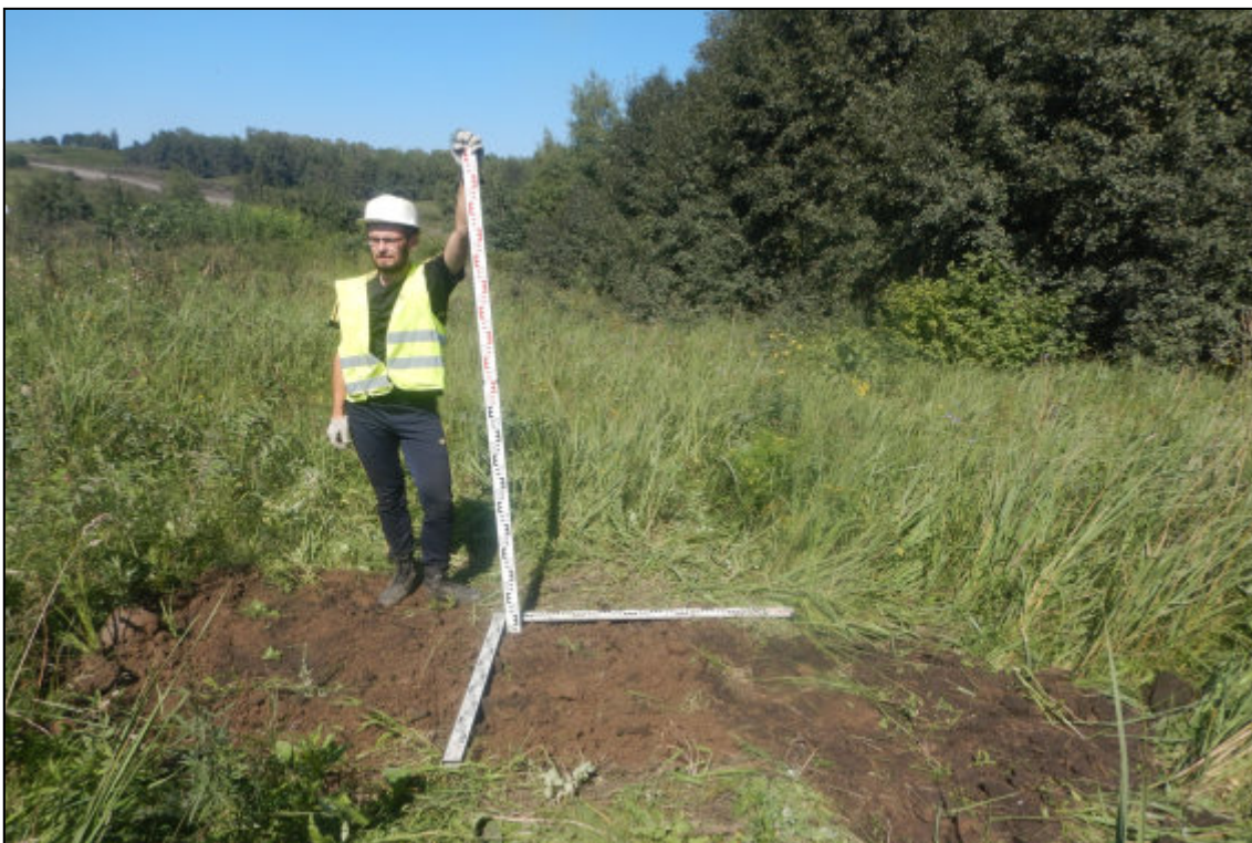
Рис. 372. Кемеровская область, Новокузнецкий муниципальный округ. «Объект размещения отходов АО «Шахта «Большевик». Корректировка». Шурф № 38. Рекультивация. Снято с юга.
