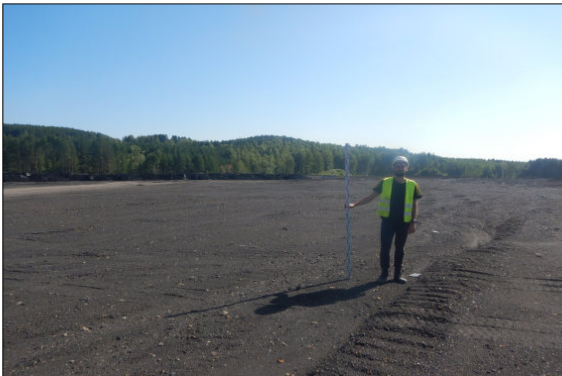
Рис. 241. Кемеровская область, Новокузнецкий муниципальный округ. «Объект размещения отходов АО «Шахта «Большевик». Корректировка». Общий вид. Точка фиксации № 60. Снято с севера.
