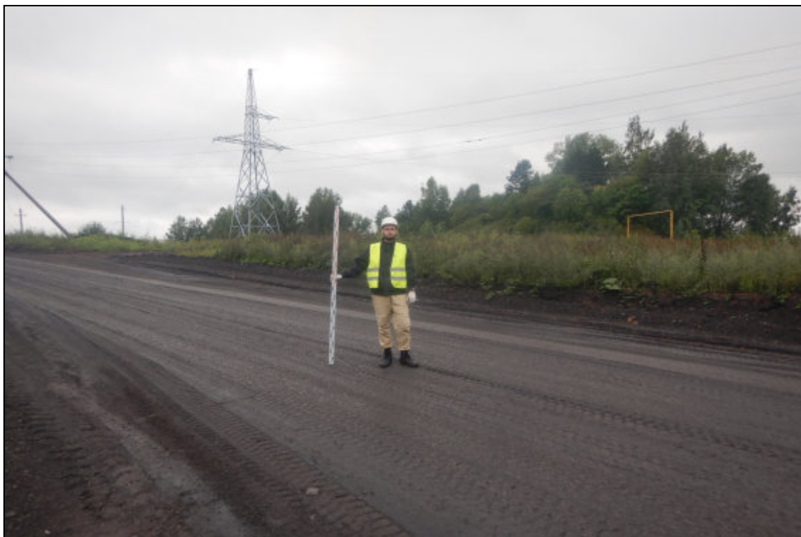
Рис. 111. Кемеровская область, Новокузнецкий муниципальный округ. «Объект размещения отходов АО «Шахта «Большевик». Корректировка». Общий вид. Точка фиксации № 27. Снято с севера.
