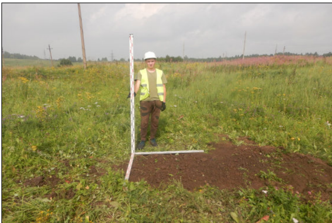
Рис. 282. Кемеровская область, Новокузнецкий муниципальный округ. «Объект размещения отходов АО «Шахта «Большевик». Корректировка». Шурф № 12. Рекультивация. Снято с юга.
