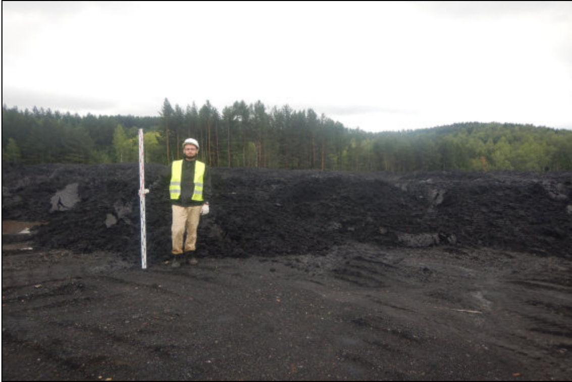
Рис. 79. Кемеровская область, Новокузнецкий муниципальный округ. «Объект размещения отходов АО «Шахта «Большевик». Корректировка». Общий вид. Точка фиксации № 19. Снято с севера.
