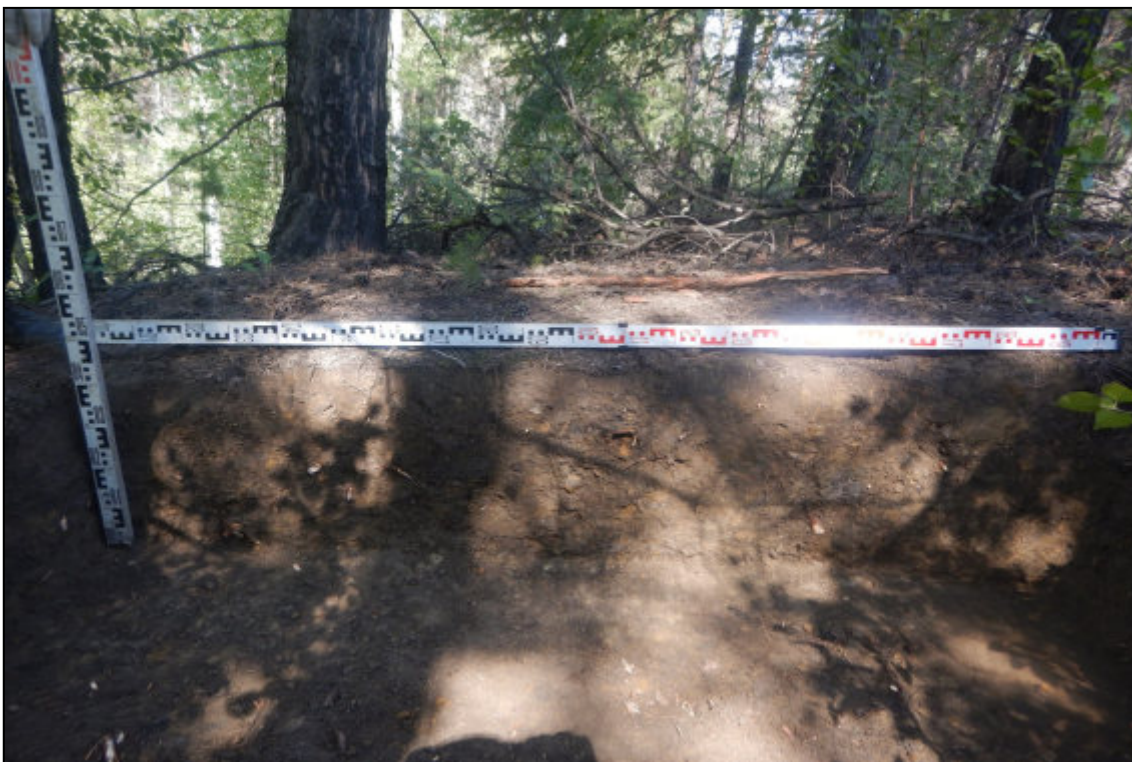
Рис. 394. Кемеровская область, Новокузнецкий муниципальный округ. «Объект размещения отходов АО «Шахта «Большевик». Корректировка». Зачистка № 45. Вид после завершения земляных работ. Снято с юго-востока.
