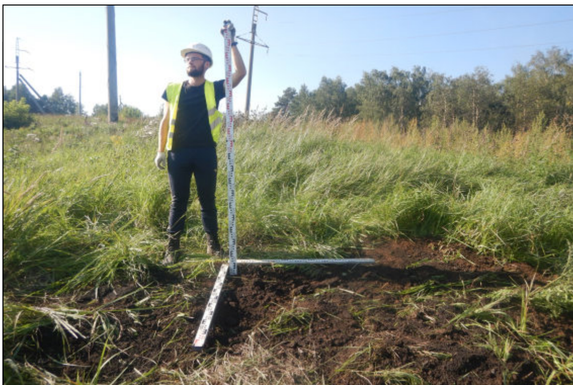
Рис. 340. Кемеровская область, Новокузнецкий муниципальный округ. «Объект размещения отходов АО «Шахта «Большевик». Корректировка». Шурф № 29. Рекультивация. Снято с юга.
