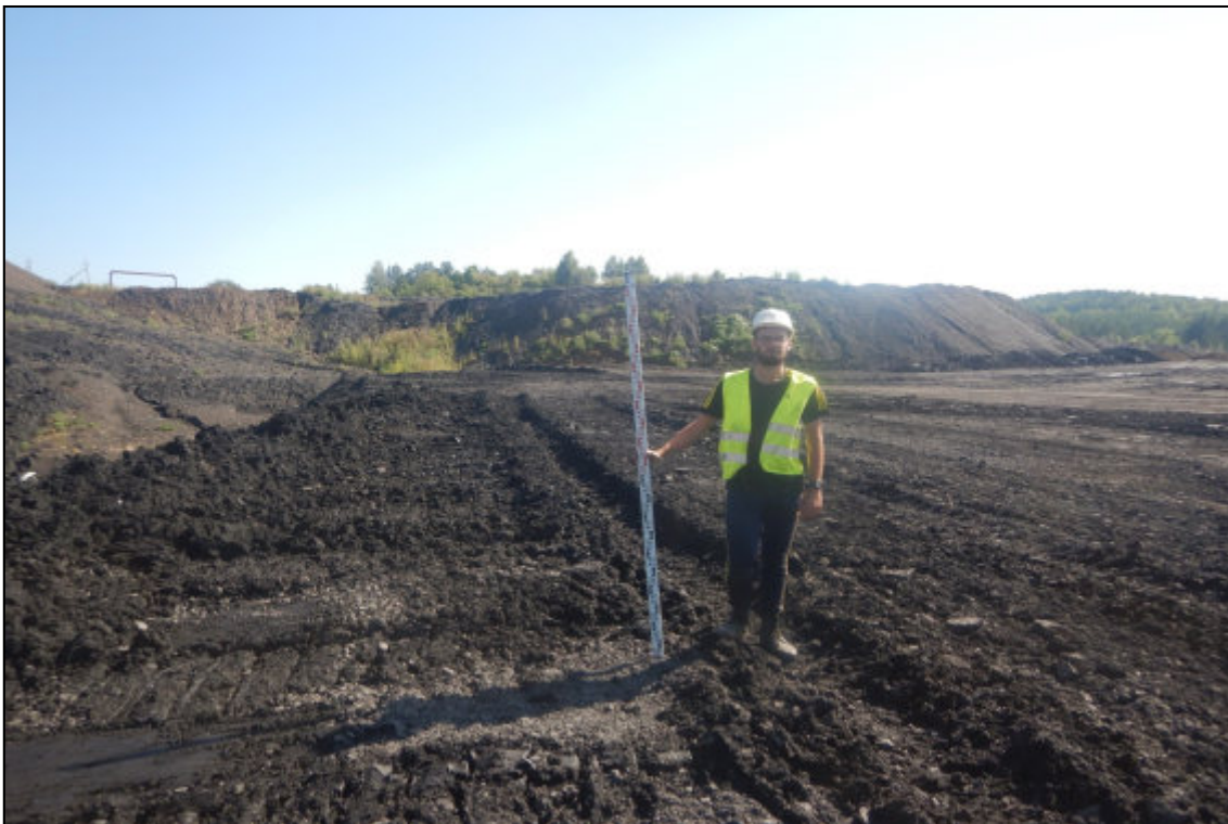
Рис. 229. Кемеровская область, Новокузнецкий муниципальный округ. «Объект размещения отходов АО «Шахта «Большевик». Корректировка». Общий вид. Точка фиксации № 57. Снято с севера.
