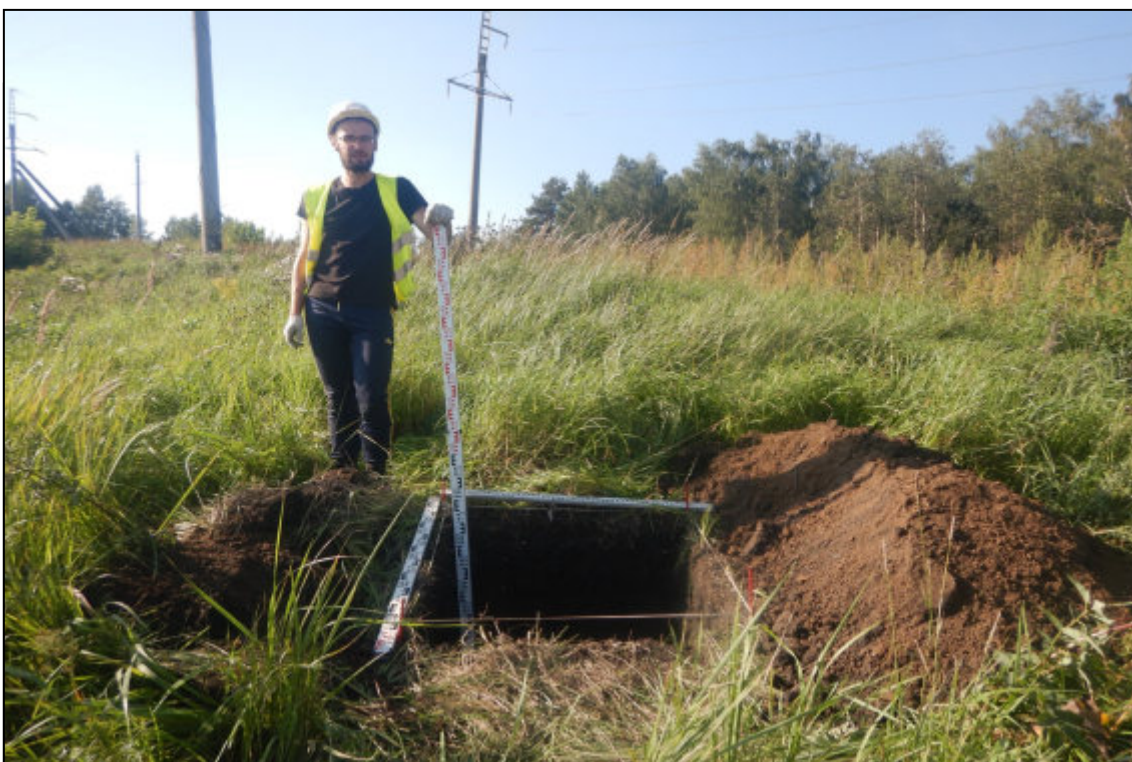
Рис. 338. Кемеровская область, Новокузнецкий муниципальный округ. «Объект размещения отходов АО «Шахта «Большевик». Корректировка». Шурф № 29. Вид после завершения земляных работ. Снято с юга.
