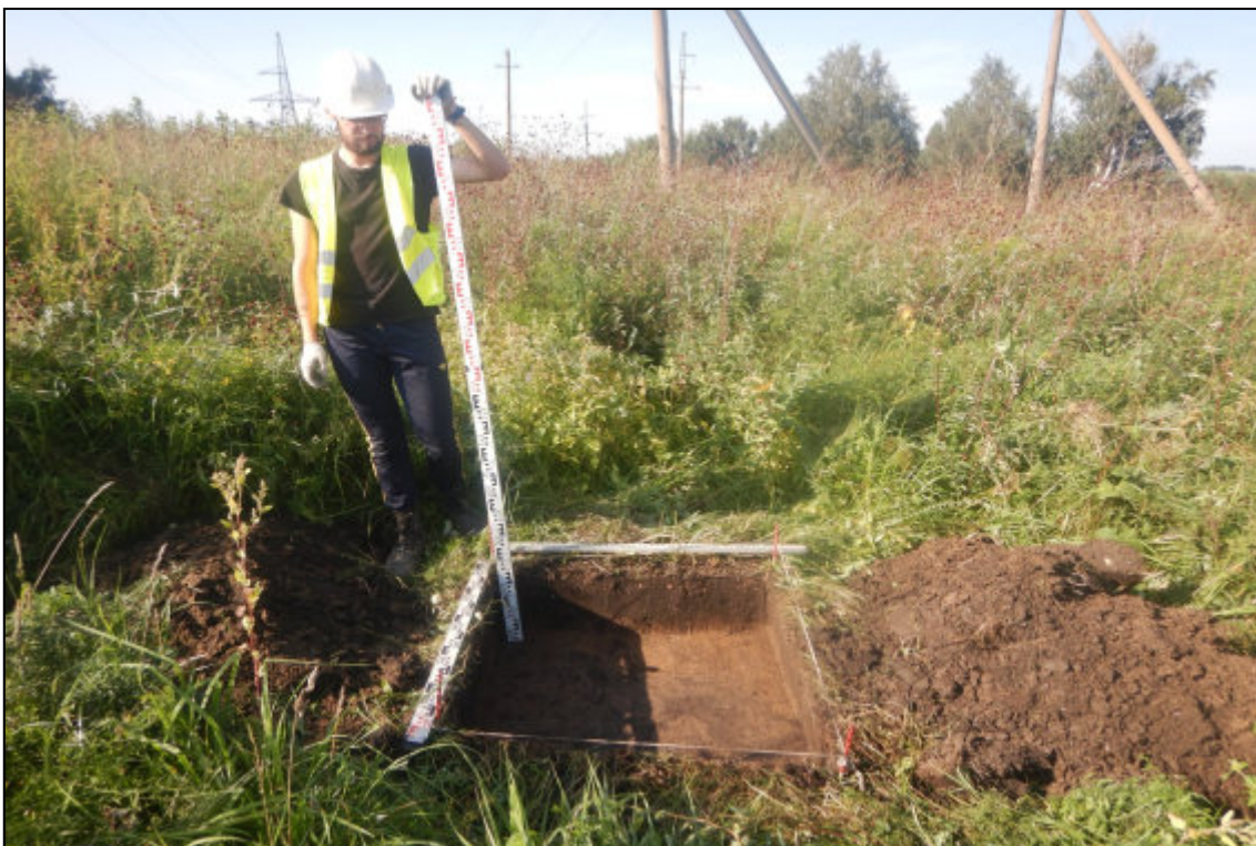
Рис. 342. Кемеровская область, Новокузнецкий муниципальный округ. «Объект размещения отходов АО «Шахта «Большевик». Корректировка». Шурф № 30. Вид после завершения земляных работ. Снято с юга.
