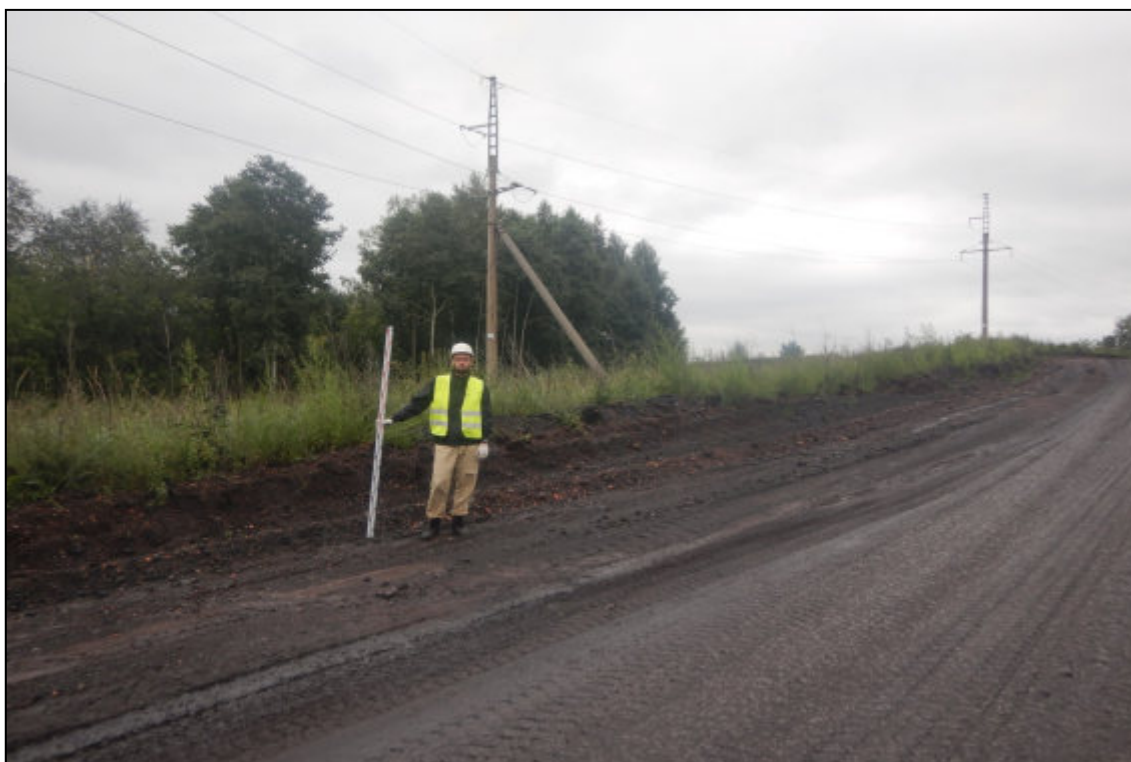
Рис. 110. Кемеровская область, Новокузнецкий муниципальный округ. «Объект размещения отходов АО «Шахта «Большевик». Корректировка». Общий вид. Точка фиксации № 27. Снято с запада.
