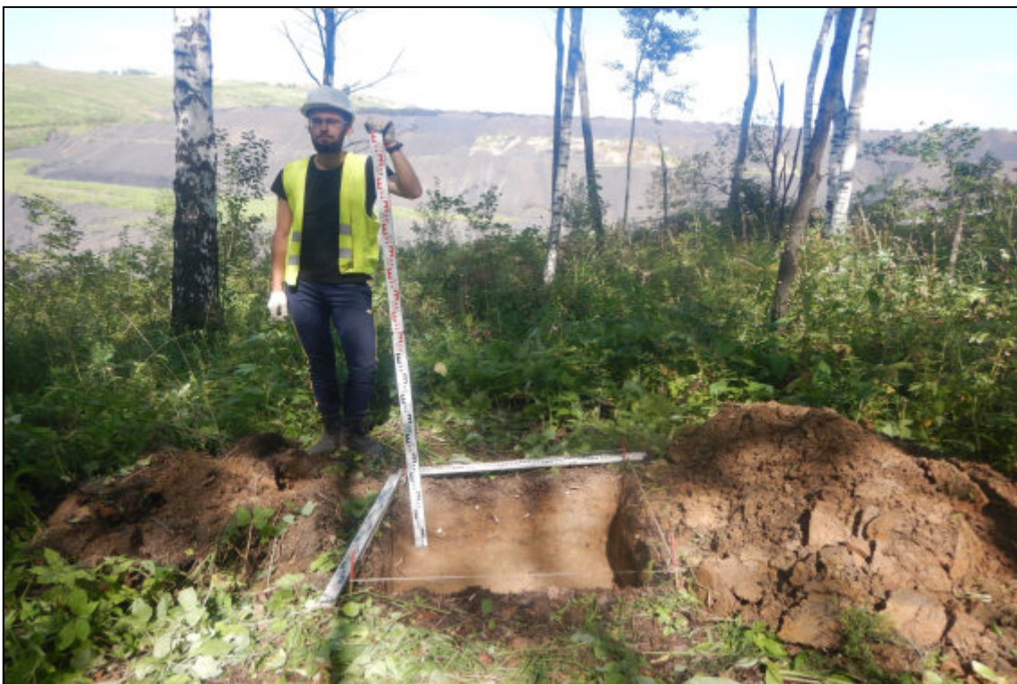
Рис. 334. Кемеровская область, Новокузнецкий муниципальный округ. «Объект размещения отходов АО «Шахта «Большевик». Корректировка». Шурф № 28. Вид после завершения земляных работ. Снято с юга.
