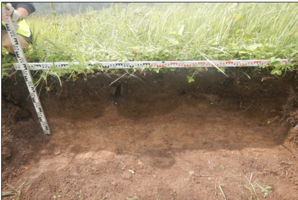
Рис. 298. Кемеровская область, Новокузнецкий муниципальный округ. «Объект размещения отходов АО «Шахта «Большевик». Корректировка». Зачистка № 17. Вид после завершения земляных работ. Снято с юго-востока.
