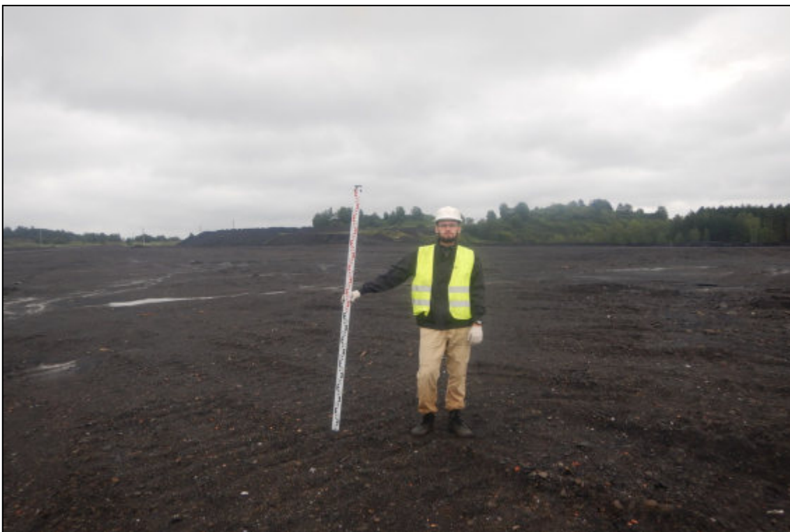
Рис. 66. Кемеровская область, Новокузнецкий муниципальный округ. «Объект размещения отходов АО «Шахта «Большевик». Корректировка». Общий вид. Точка фиксации № 16. Снято с запада.
