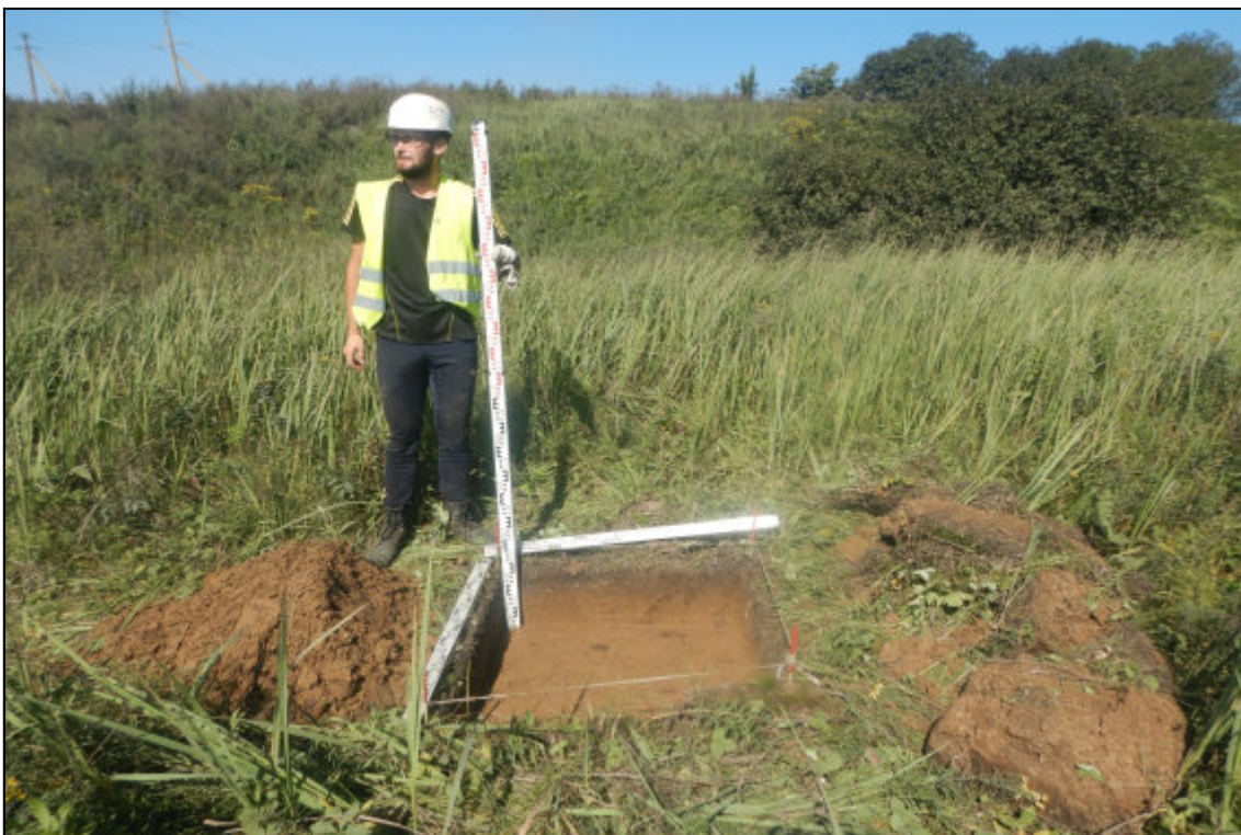
Рис. 354. Кемеровская область, Новокузнецкий муниципальный округ. «Объект размещения отходов АО «Шахта «Большевик». Корректировка». Шурф № 34. Вид после завершения земляных работ. Снято с юга.
