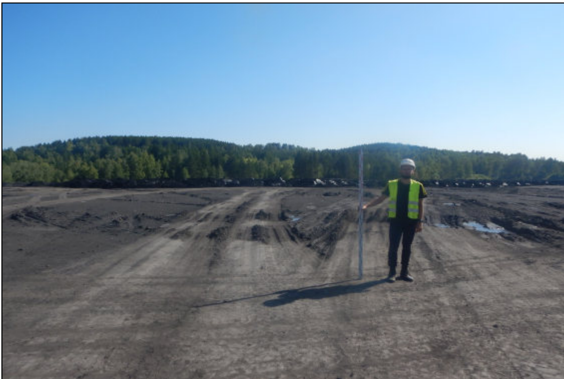
Рис. 237. Кемеровская область, Новокузнецкий муниципальный округ. «Объект размещения отходов АО «Шахта «Большевик». Корректировка». Общий вид. Точка фиксации № 59. Снято с севера.
