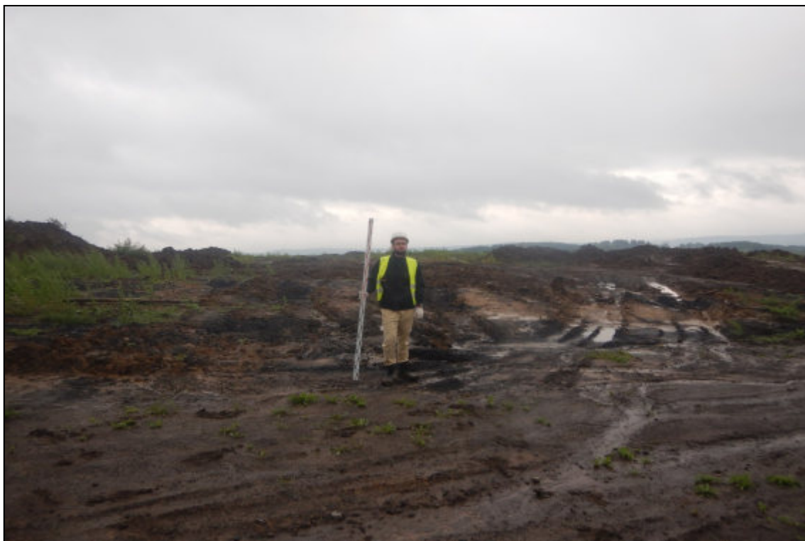
Рис. 15. Кемеровская область, Новокузнецкий муниципальный округ. «Объект размещения отходов АО «Шахта «Большевик». Корректировка». Общий вид. Точка фиксации № 3. Снято с севера.
