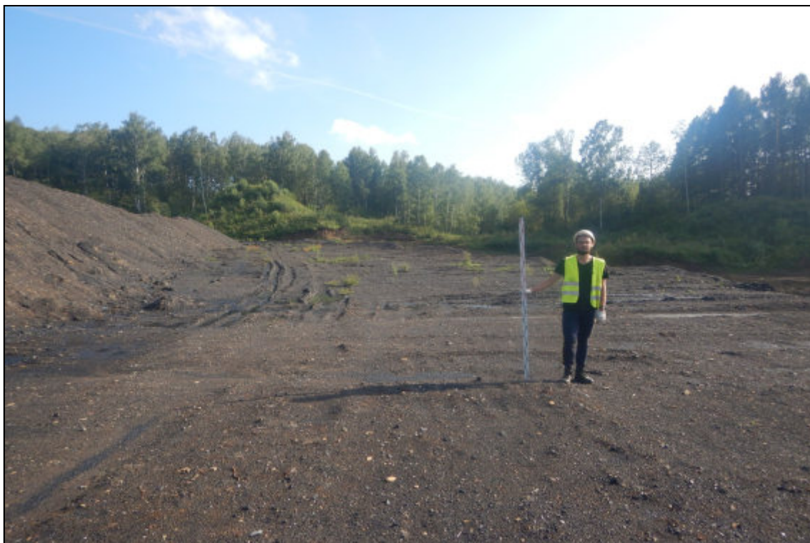
Рис. 213. Кемеровская область, Новокузнецкий муниципальный округ. «Объект размещения отходов АО «Шахта «Большевик». Корректировка». Общий вид. Точка фиксации № 53. Снято с севера.
