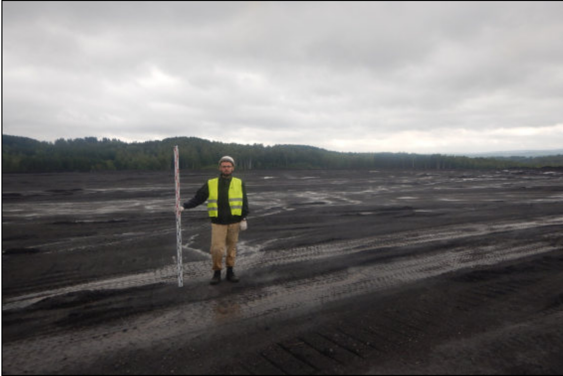
Рис. 59. Кемеровская область, Новокузнецкий муниципальный округ. «Объект размещения отходов АО «Шахта «Большевик». Корректировка». Общий вид. Точка фиксации № 14. Снято с севера.
