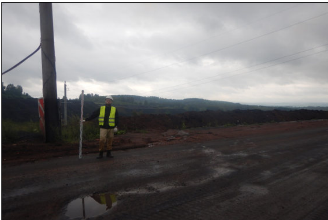
Рис. 43. Кемеровская область, Новокузнецкий муниципальный округ. «Объект размещения отходов АО «Шахта «Большевик». Корректировка». Общий вид. Точка фиксации № 10. Снято с севера.
