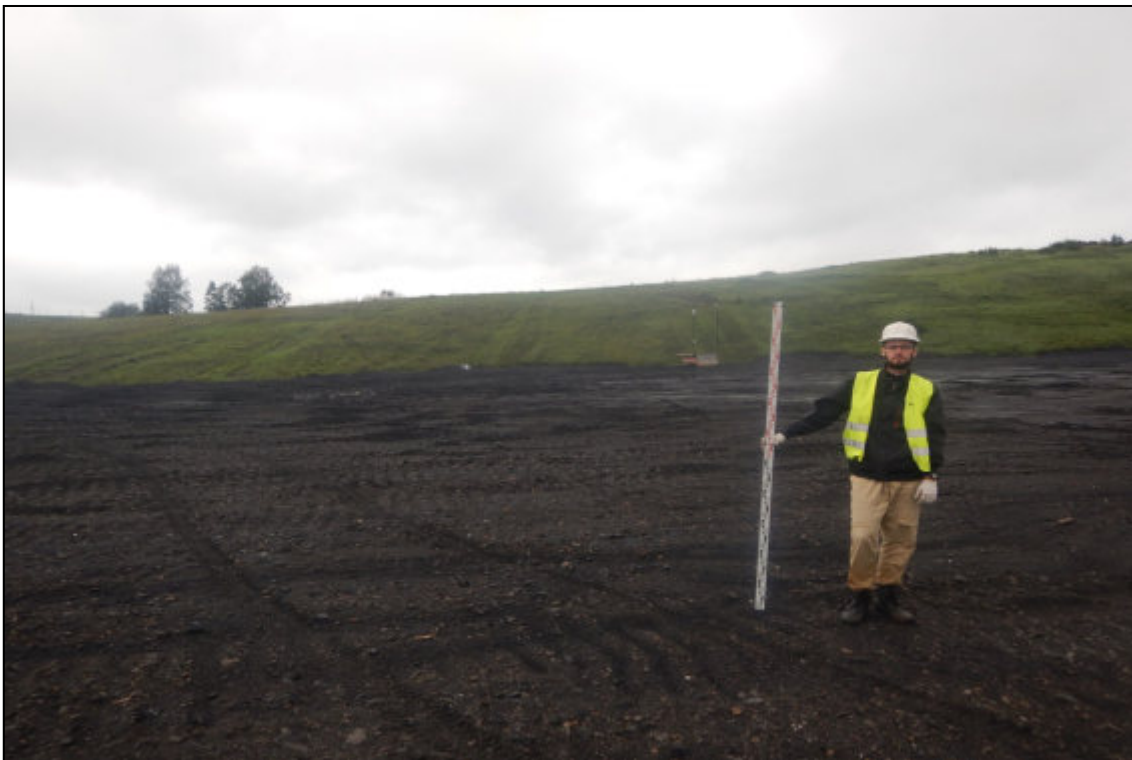
Рис. 65. Кемеровская область, Новокузнецкий муниципальный округ. «Объект размещения отходов АО «Шахта «Большевик». Корректировка». Общий вид. Точка фиксации № 16. Снято с юга.
