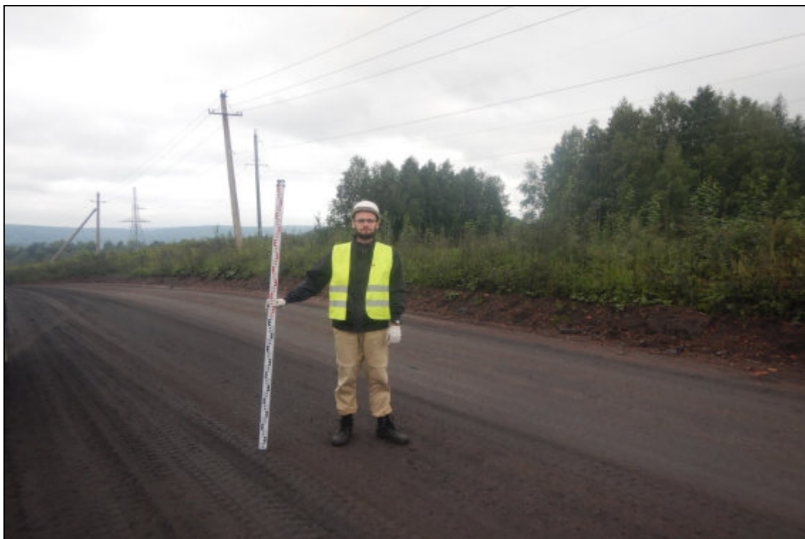
Рис. 107. Кемеровская область, Новокузнецкий муниципальный округ. «Объект размещения отходов АО «Шахта «Большевик». Корректировка». Общий вид. Точка фиксации № 26. Снято с севера.
