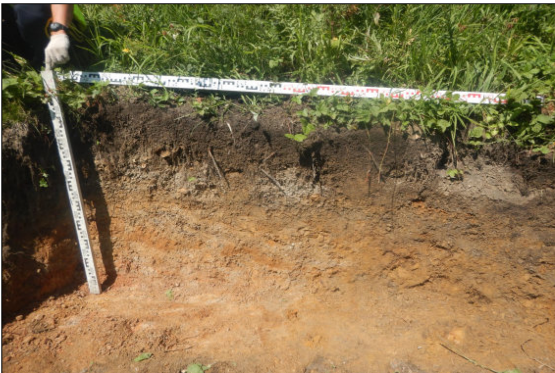
Рис. 332. Кемеровская область, Новокузнецкий муниципальный округ. «Объект размещения отходов АО «Шахта «Большевик». Корректировка». Зачистка № 27. Вид после завершения земляных работ. Снято с юга.
