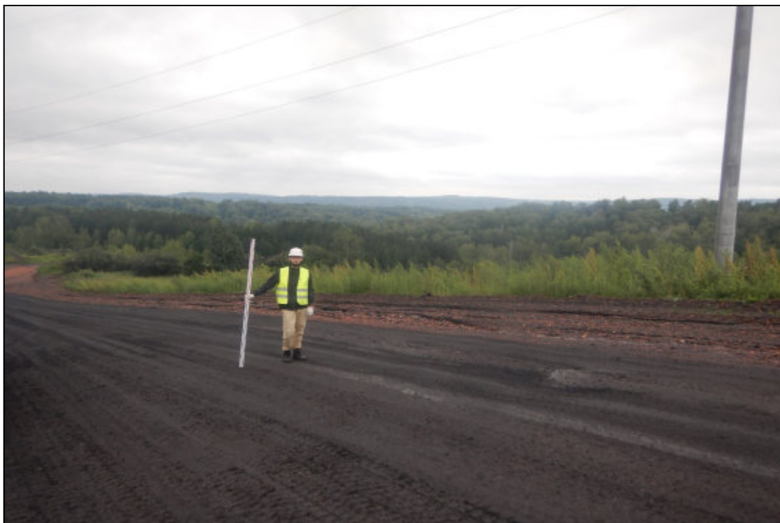
Рис. 99. Кемеровская область, Новокузнецкий муниципальный округ. «Объект размещения отходов АО «Шахта «Большевик». Корректировка». Общий вид. Точка фиксации № 24. Снято с севера.
