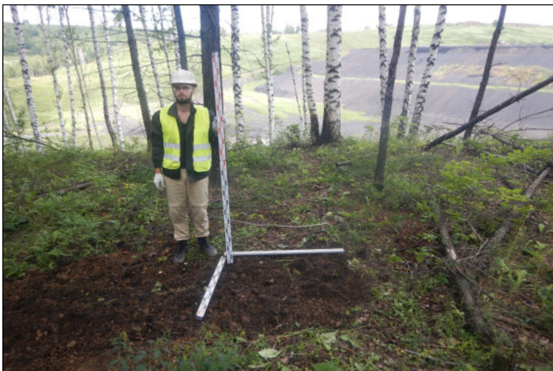
Рис. 254. Кемеровская область, Новокузнецкий муниципальный округ. «Объект размещения отходов АО «Шахта «Большевик». Корректировка». Шурф № 4. Рекультивация. Снято с юга.
