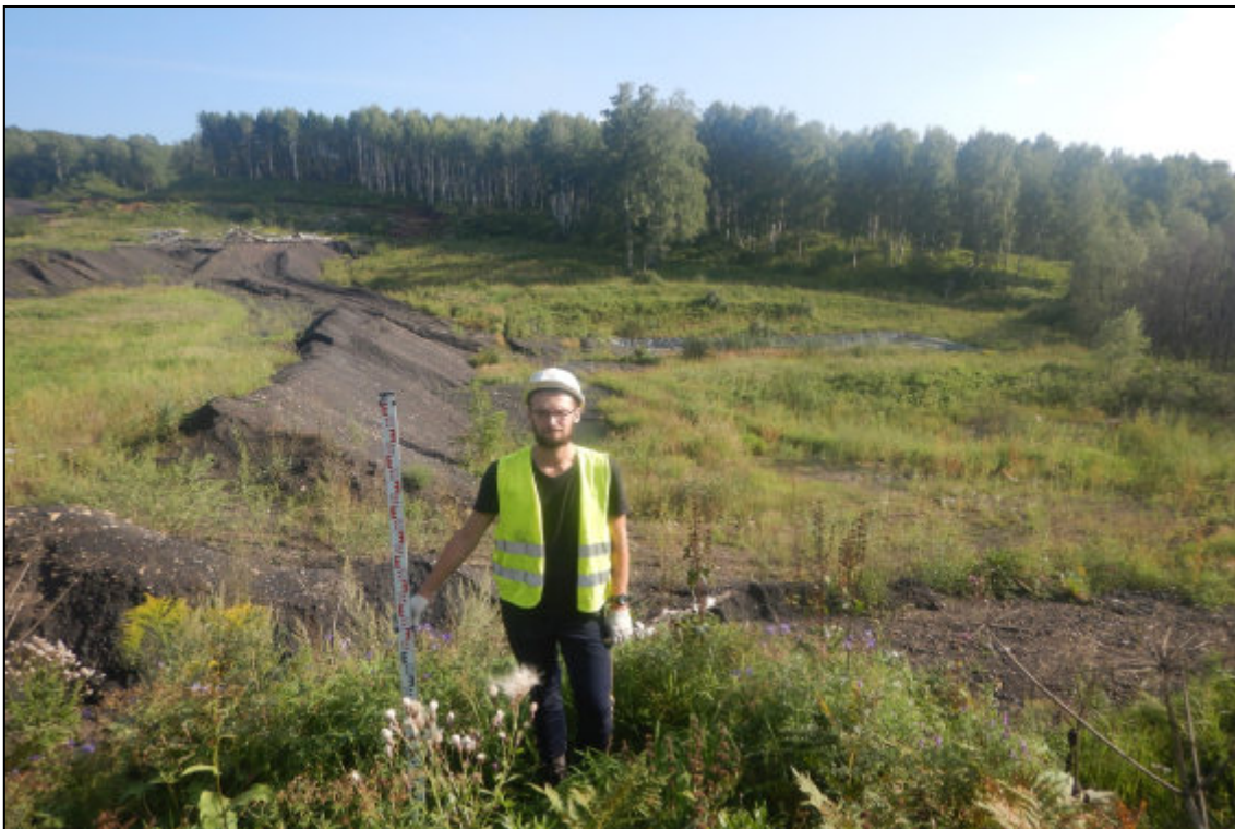
Рис. 201. Кемеровская область, Новокузнецкий муниципальный округ. «Объект размещения отходов АО «Шахта «Большевик». Корректировка». Общий вид. Точка фиксации № 50. Снято с севера.
