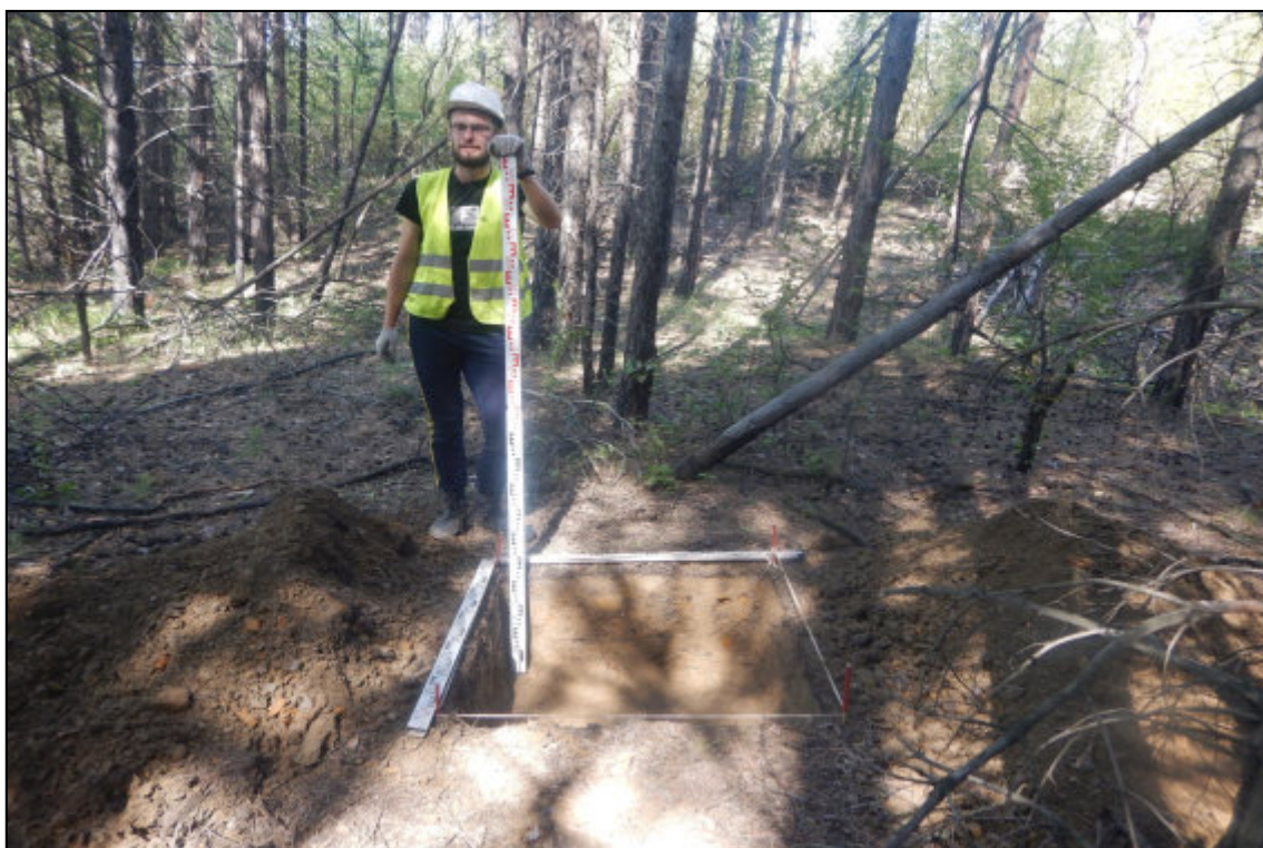
Рис. 396. Кемеровская область, Новокузнецкий муниципальный округ. «Объект размещения отходов АО «Шахта «Большевик». Корректировка». Шурф № 46. Вид после завершения земляных работ. Снято с юга.
