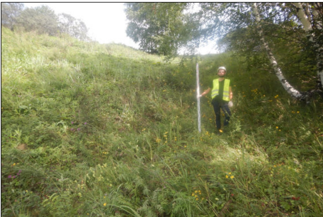
Рис. 118. Кемеровская область, Новокузнецкий муниципальный округ. «Объект размещения отходов АО «Шахта «Большевик». Корректировка». Общий вид. Точка фиксации № 29. Снято с запада.
