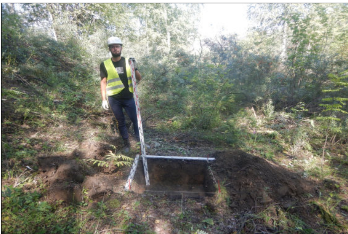
Рис. 388. Кемеровская область, Новокузнецкий муниципальный округ. «Объект размещения отходов АО «Шахта «Большевик». Корректировка». Шурф № 43. Вид после завершения земляных работ. Снято с юга.
