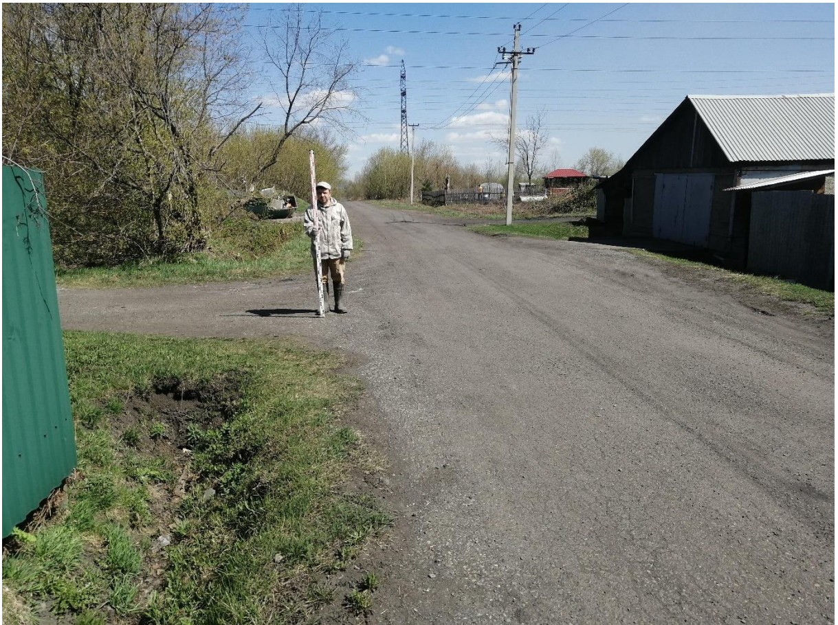
Рис. 39. «Строительство водовода от бункера существующих скважин до узла II подъема...». Точка фотофиксации №14 ( 53^{\circ}46'23.73''\text{С} , 87^{\circ}37'1.66''\text{В} ). Фото с З.
