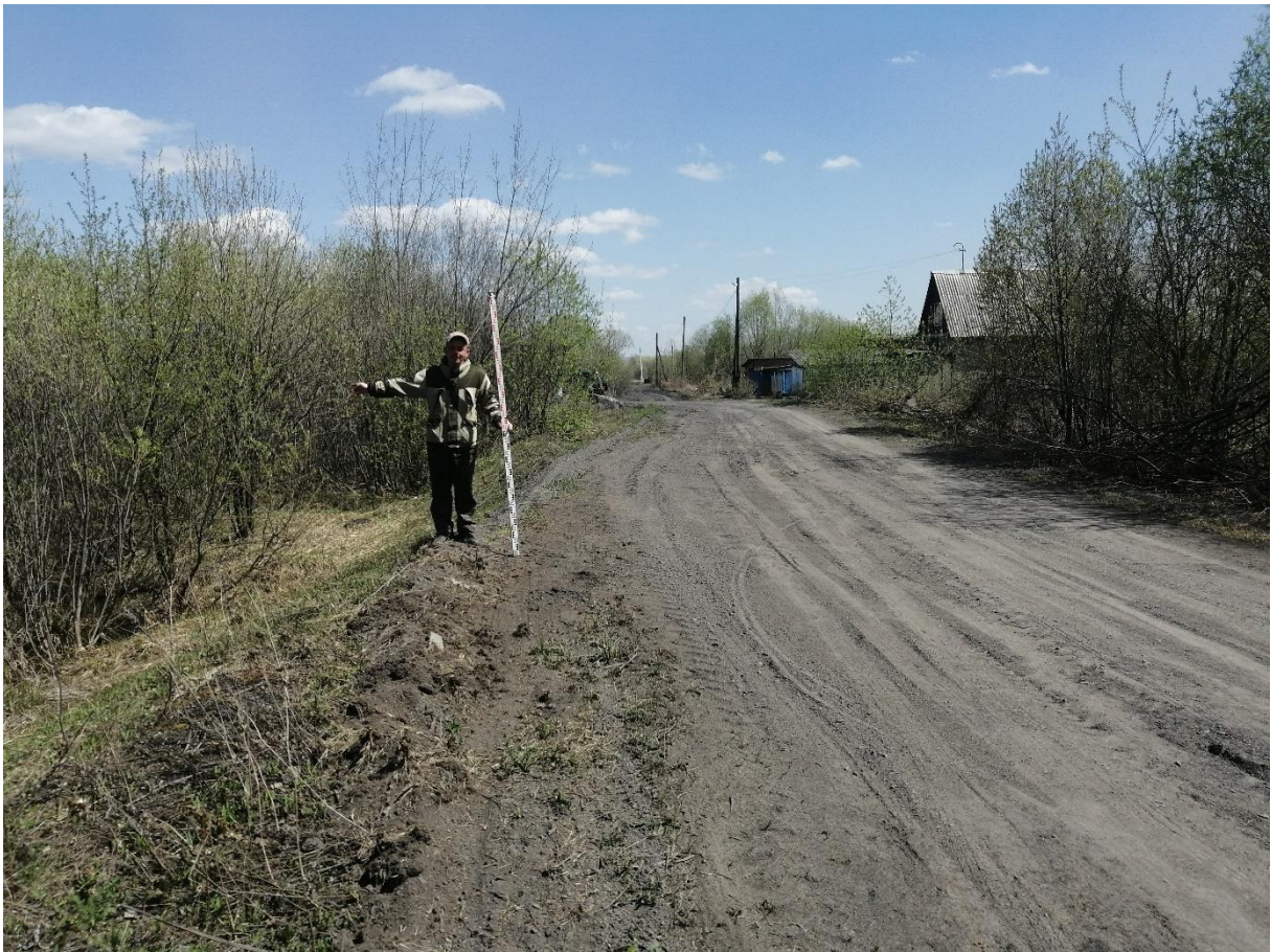
Рис. 27. «Строительство водовода от бункера существующих скважин до узла II подъема...». Точка фотофиксации №8 ( 53^{\circ}46'0.49''\text{С} , 87^{\circ}37'17.30''\text{В} ). Фото с З.
