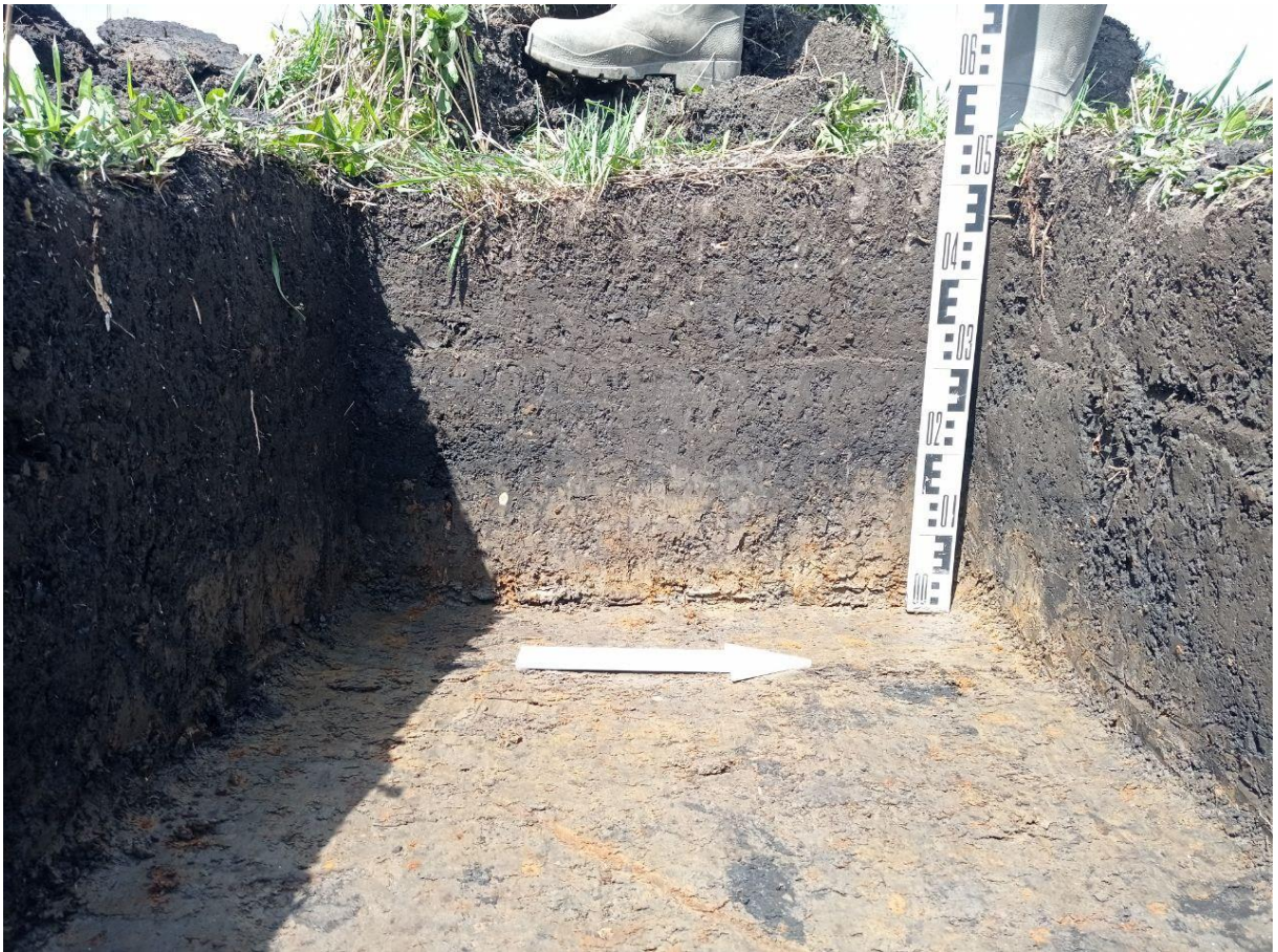
Рис. 61. «Строительство водовода от бункера существующих скважин до узла II подъема...». Шурф №4. Профиль западной стенки. Фото с В.
