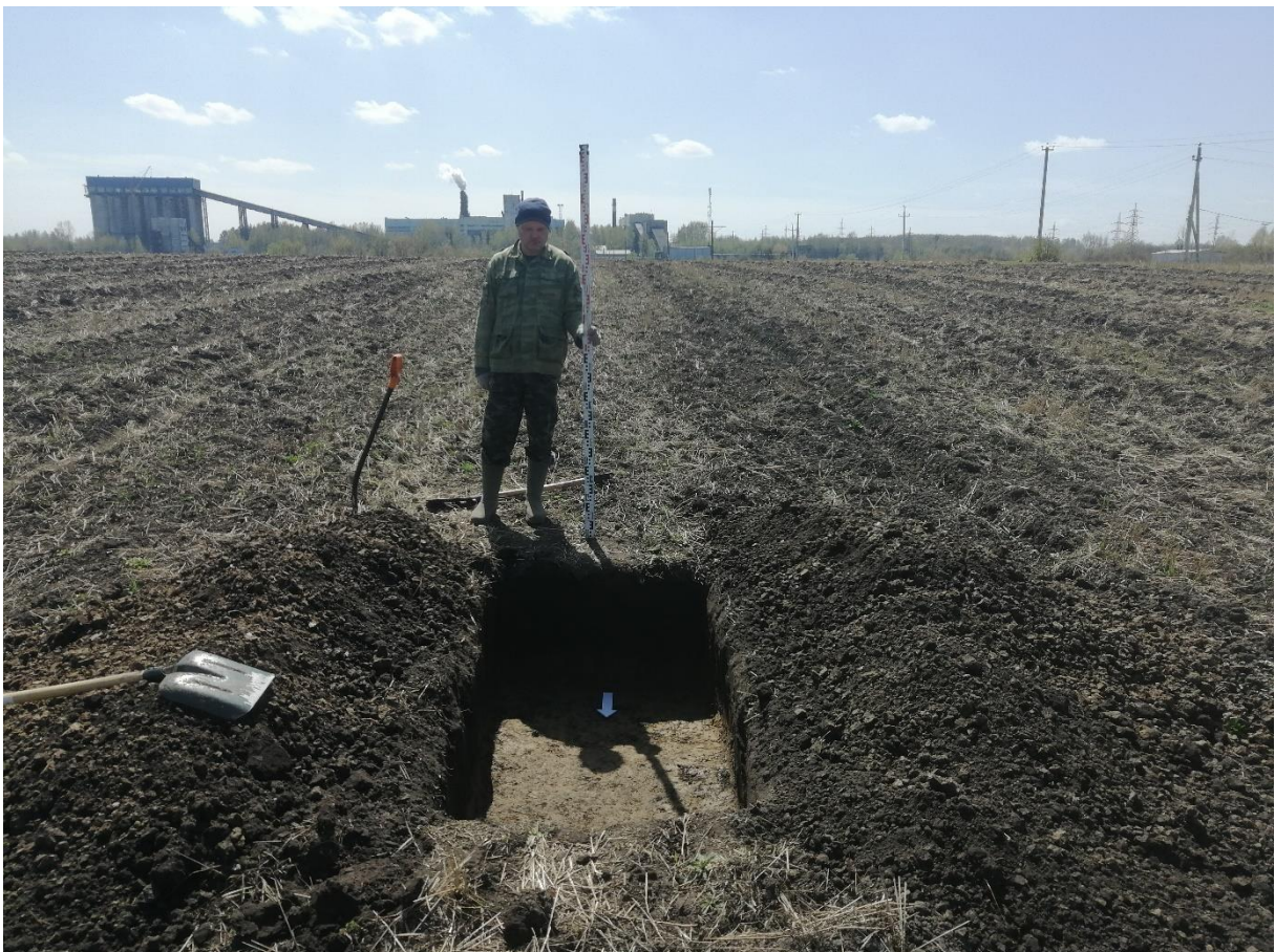
Рис. 64. «Строительство водовода от бункера существующих скважин до узла II подъема...». Шурф №5 после выборки. Фото с С.
