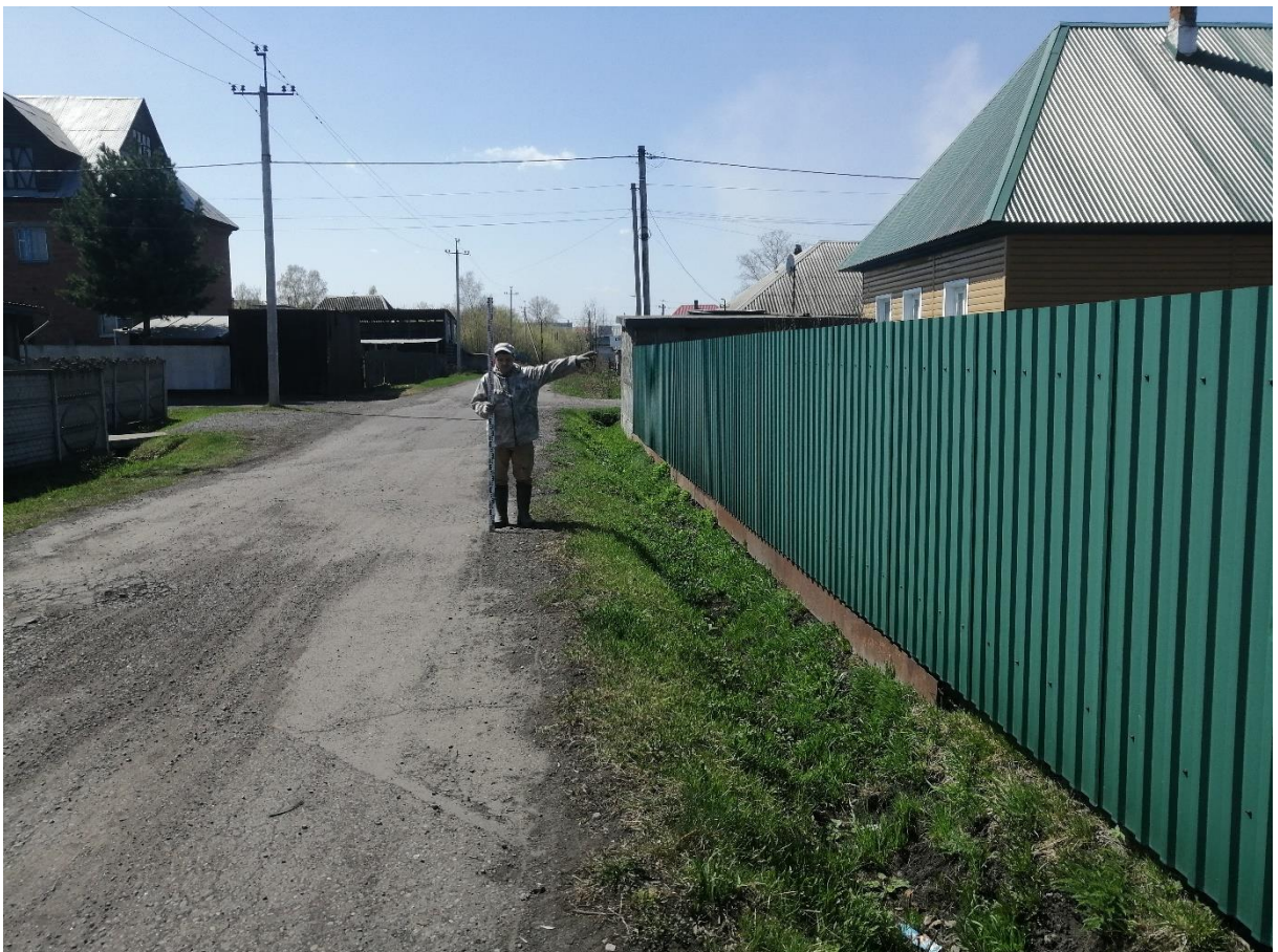
Рис. 40. «Строительство водовода от бункера существующих скважин до узла II подъема...». Точка фотофиксации №14 ( 53^{\circ}46'23.73''\text{С} , 87^{\circ}37'1.66''\text{В} ). Фото с В.
