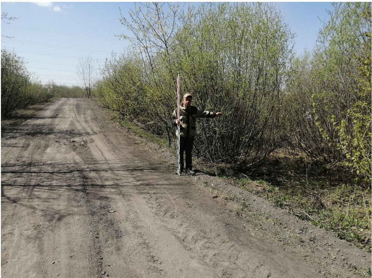
Рис. 28. «Строительство водовода от бункера существующих скважин до узла II подъема...». Точка фотофиксации №8 ( 53^{\circ}46'0.49''\text{С} , 87^{\circ}37'17.30''\text{В} ). Фото с В.
