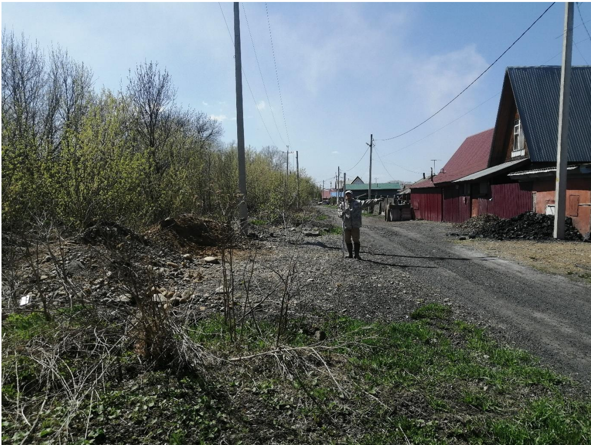
Рис. 41. «Строительство водовода от бункера существующих скважин до узла II подъема...». Точка фотофиксации №15 ( 53^{\circ}46'23.49''\text{С} , 87^{\circ}36'50.63''\text{В} ). Фото с В.
