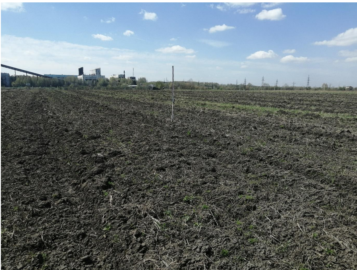
Рис. 20. «Строительство водовода от бункера существующих скважин до узла II подъема...». Точка фотофиксации №4 ( 53^{\circ}45'54.24''\text{С} , 87^{\circ}37'47.52''\text{В} ). Фото с СВ.
