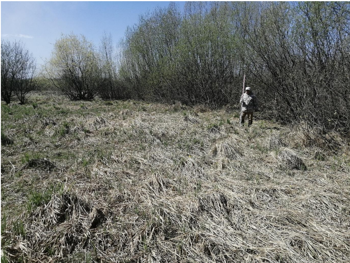
Рис. 37. «Строительство водовода от бункера существующих скважин до узла II подъема...». Точка фотофиксации №13 ( 53^{\circ}46'4.02''\text{С} , 87^{\circ}37'25.22''\text{В} ). Фото с С.
