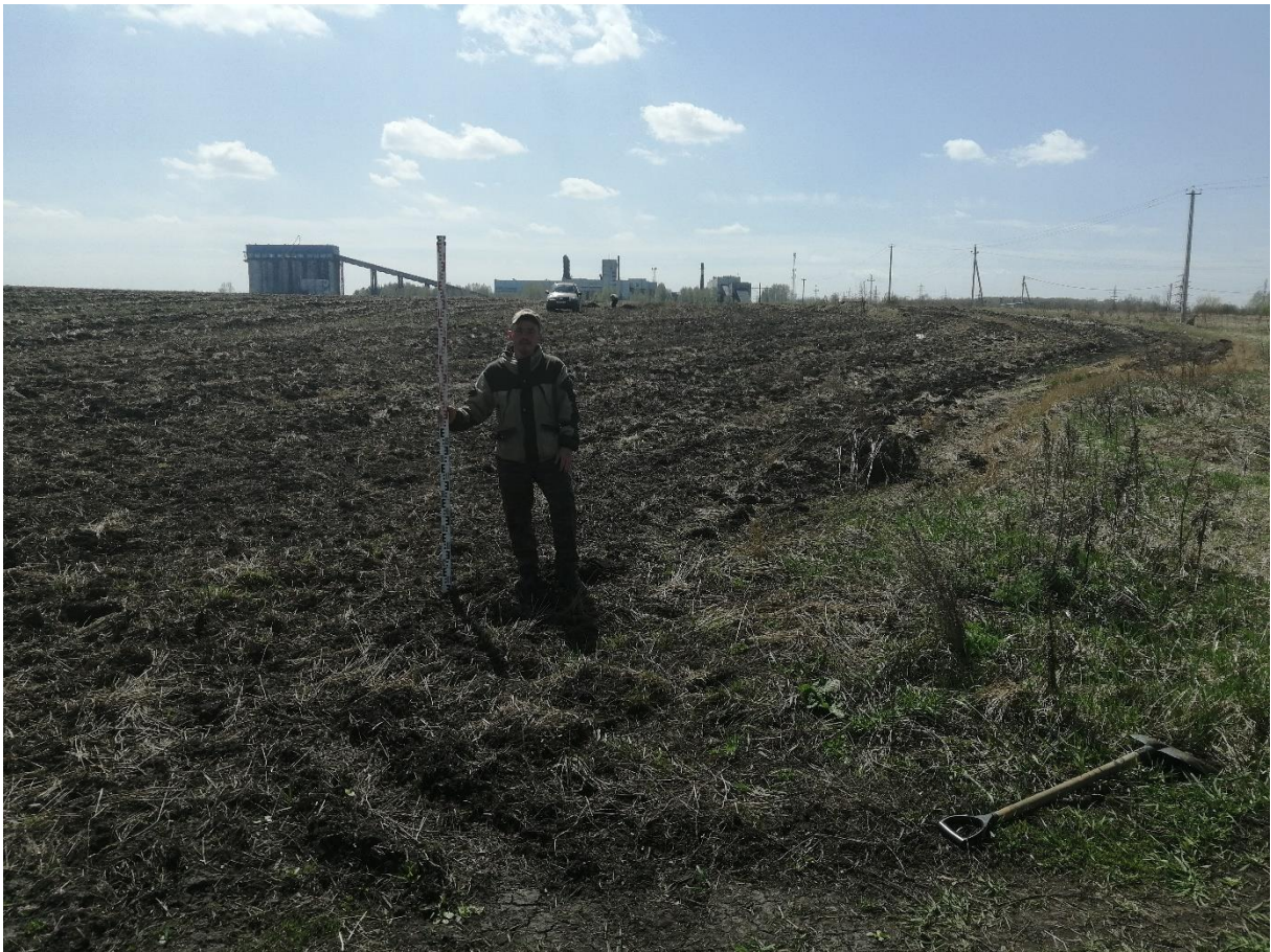
Рис. 25. «Строительство водовода от бункера существующих скважин до узла II подъема...». Точка фотофиксации №7 ( 53^{\circ}45'58.97''\text{С} , 87^{\circ}37'37.35''\text{В} ). Фото с ССВ.
