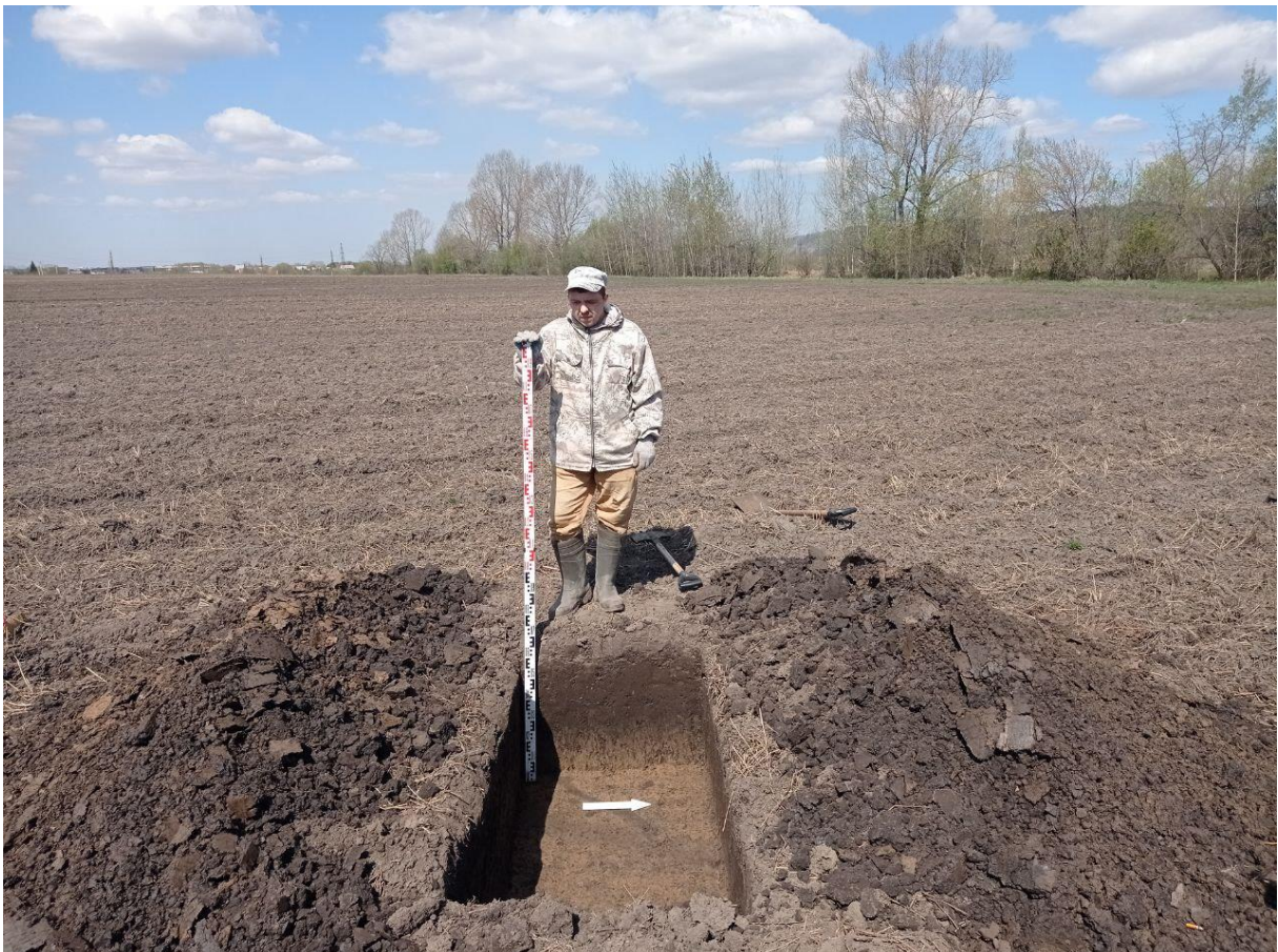
Рис. 52. «Строительство водовода от бункера существующих скважин до узла II подъема...». Шурф №2 после выборки. Фото с В.
