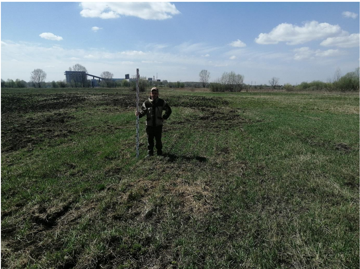
Рис. 22. «Строительство водовода от бункера существующих скважин до узла II подъема...». Точка фотофиксации №5 ( 53^{\circ}46'5.83''\text{С} , 87^{\circ}38'4.70''\text{В} ). Фото с СВ.
