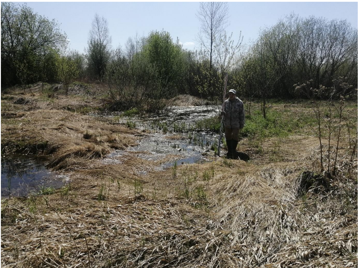
Рис. 36. «Строительство водовода от бункера существующих скважин до узла II подъема...». Точка фотофиксации №12 ( 53^{\circ}46'9.52''\text{С} , 87^{\circ}37'25.83''\text{В} ). Фото с С.
