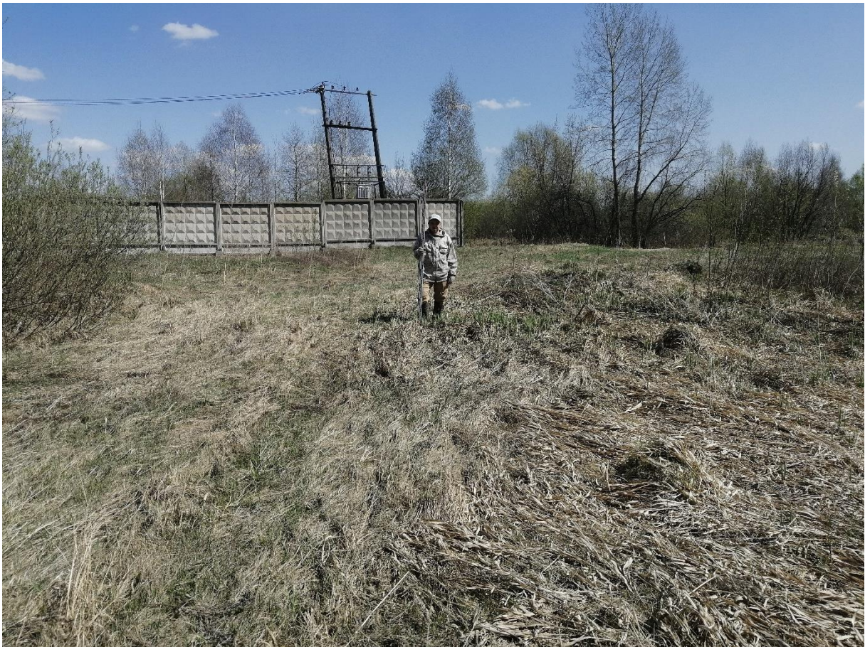
Рис. 35. «Строительство водовода от бункера существующих скважин до узла II подъема...». Точка фотофиксации №12 ( 53^{\circ}46'9.52''\text{С} , 87^{\circ}37'25.83''\text{В} ). Фото с З.
