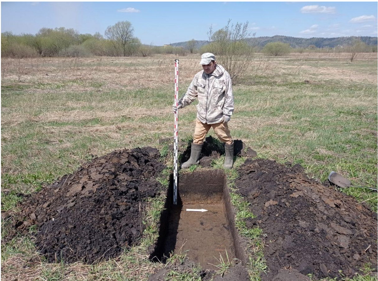
Рис. 60. «Строительство водовода от бункера существующих скважин до узла II подъема...». Шурф №4 после выборки. Фото с В.
