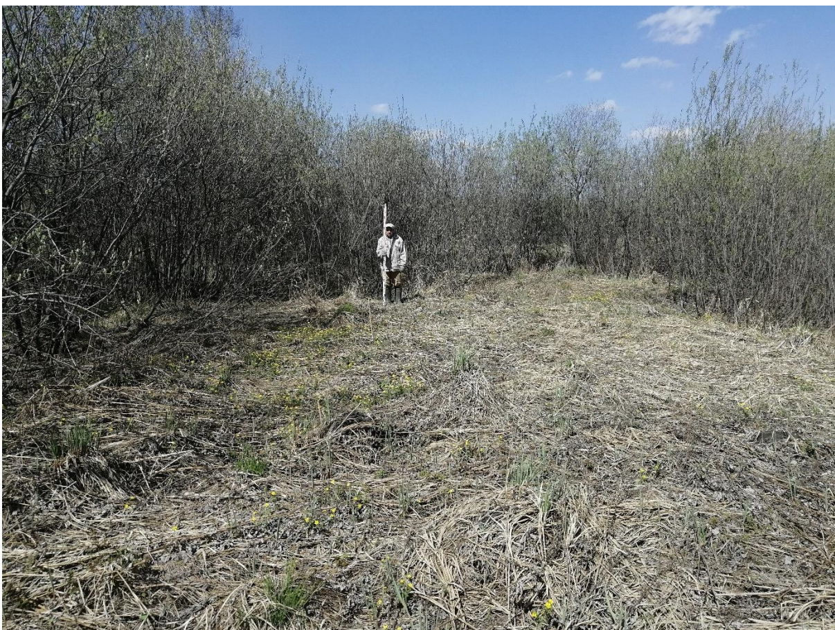
Рис. 34. «Строительство водовода от бункера существующих скважин до узла II подъема...». Точка фотофиксации №11 ( 53^{\circ}46'8.35''\text{С} , 87^{\circ}37'12.24''\text{В} ). Фото с Ю.
