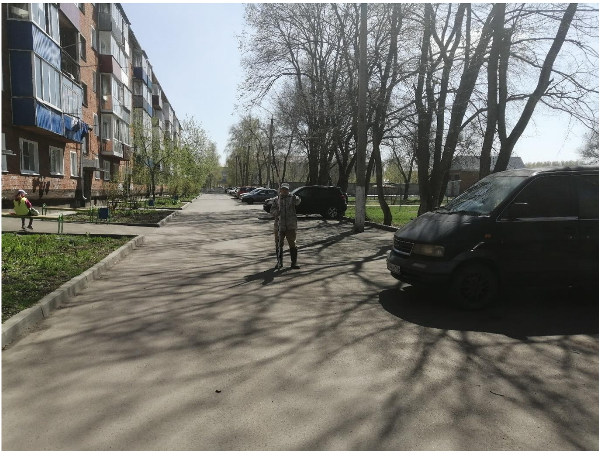
Рис. 45. «Строительство водовода от бункера существующих скважин до узла II подъема...». Точка фотофиксации №17 ( 53^{\circ}46'20.42''\text{С} , 87^{\circ}36'41.81''\text{В} ). Фото с С.
