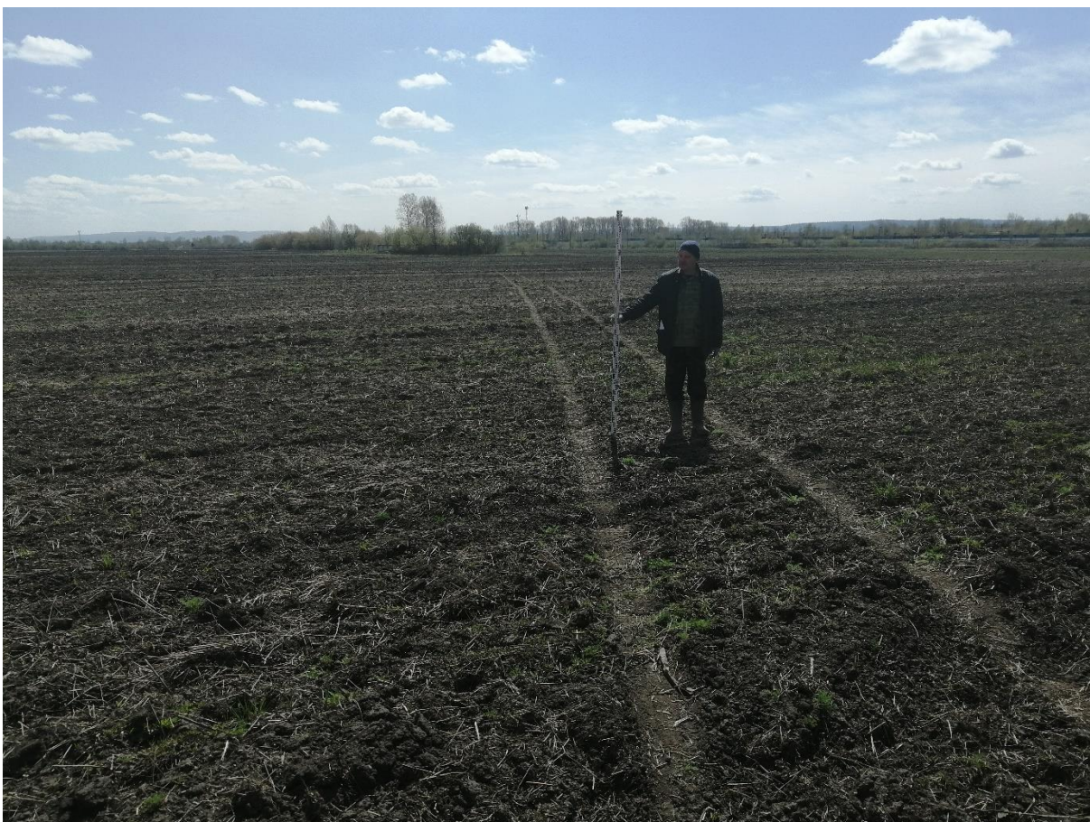
Рис. 18. «Строительство водовода от бункера существующих скважин до узла II подъема...». Точка фотофиксации №3 ( 53^{\circ}45'47.61''\text{С} , 87^{\circ}37'50.10''\text{В} ). Фото с СЗ.
