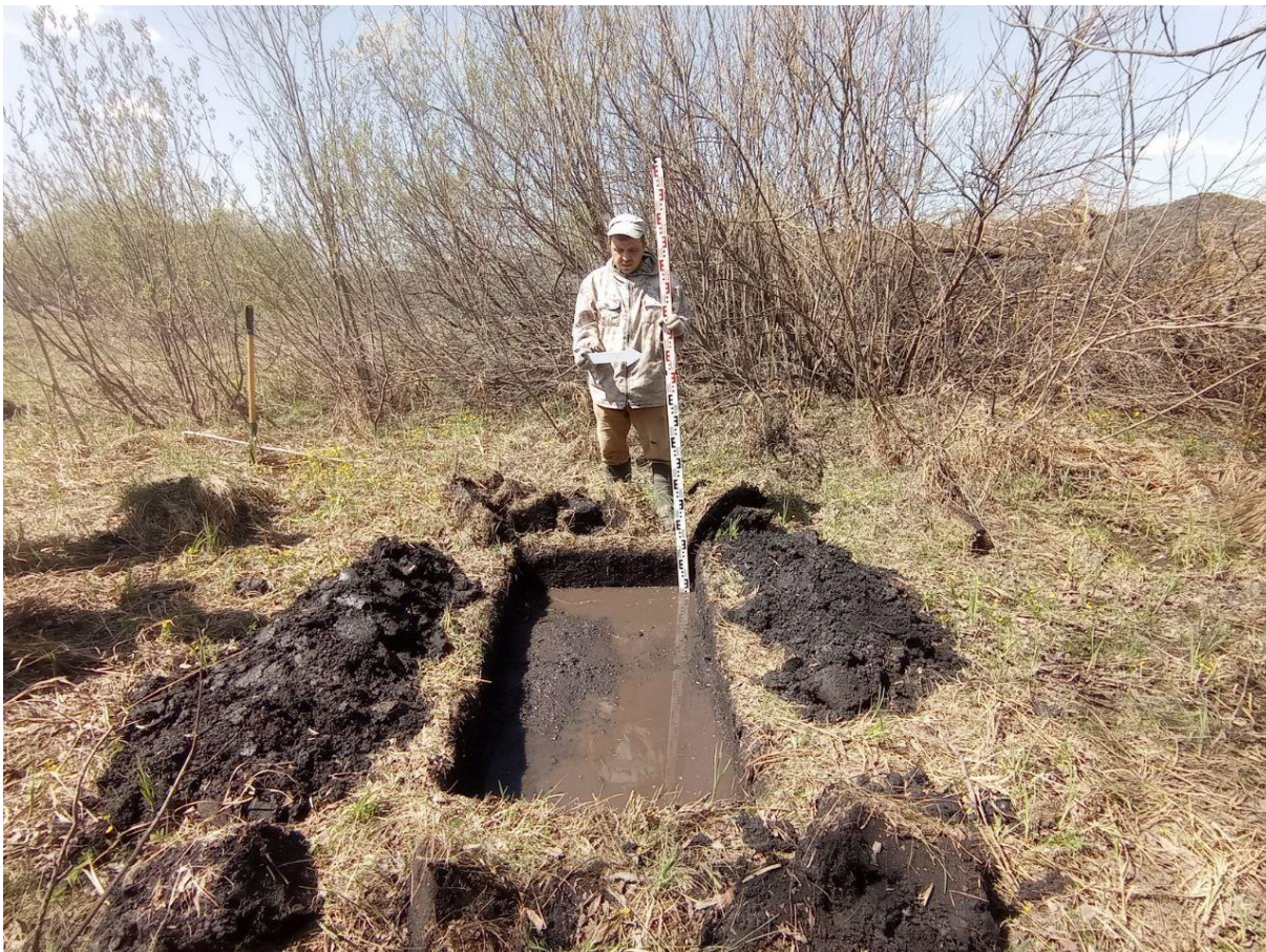
Рис. 68. «Строительство водовода от бункера существующих скважин до узла II подъема...». Шурф №6 после выборки. Фото с В.
