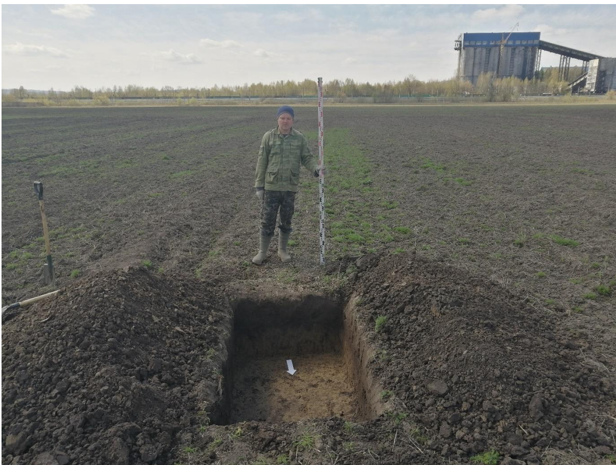
Рис. 48. «Строительство водовода от бункера существующих скважин до узла II подъема...». Шурф №1 после выборки. Фото с С.
