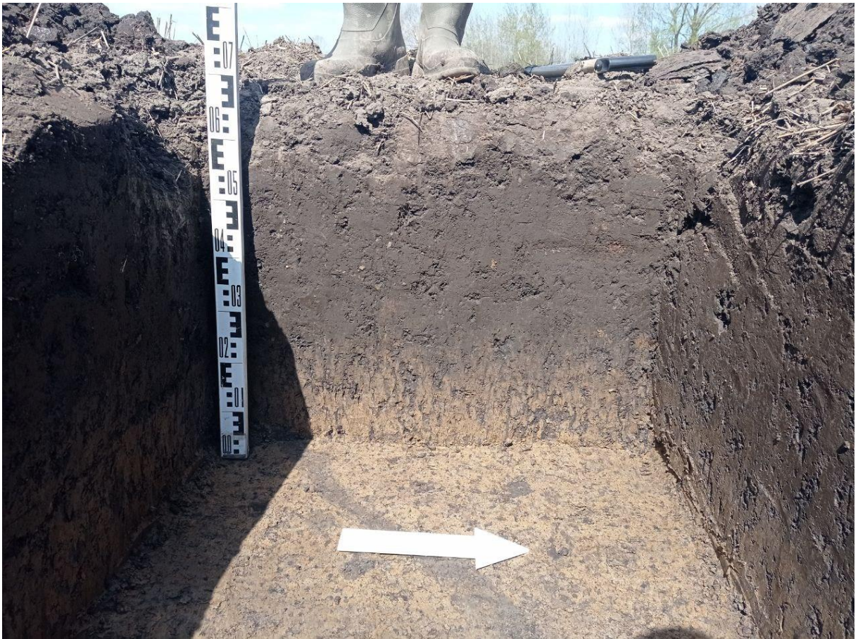
Рис. 53. «Строительство водовода от бункера существующих скважин до узла II подъема...». Шурф №2. Профиль западной стенки. Фото с В.
