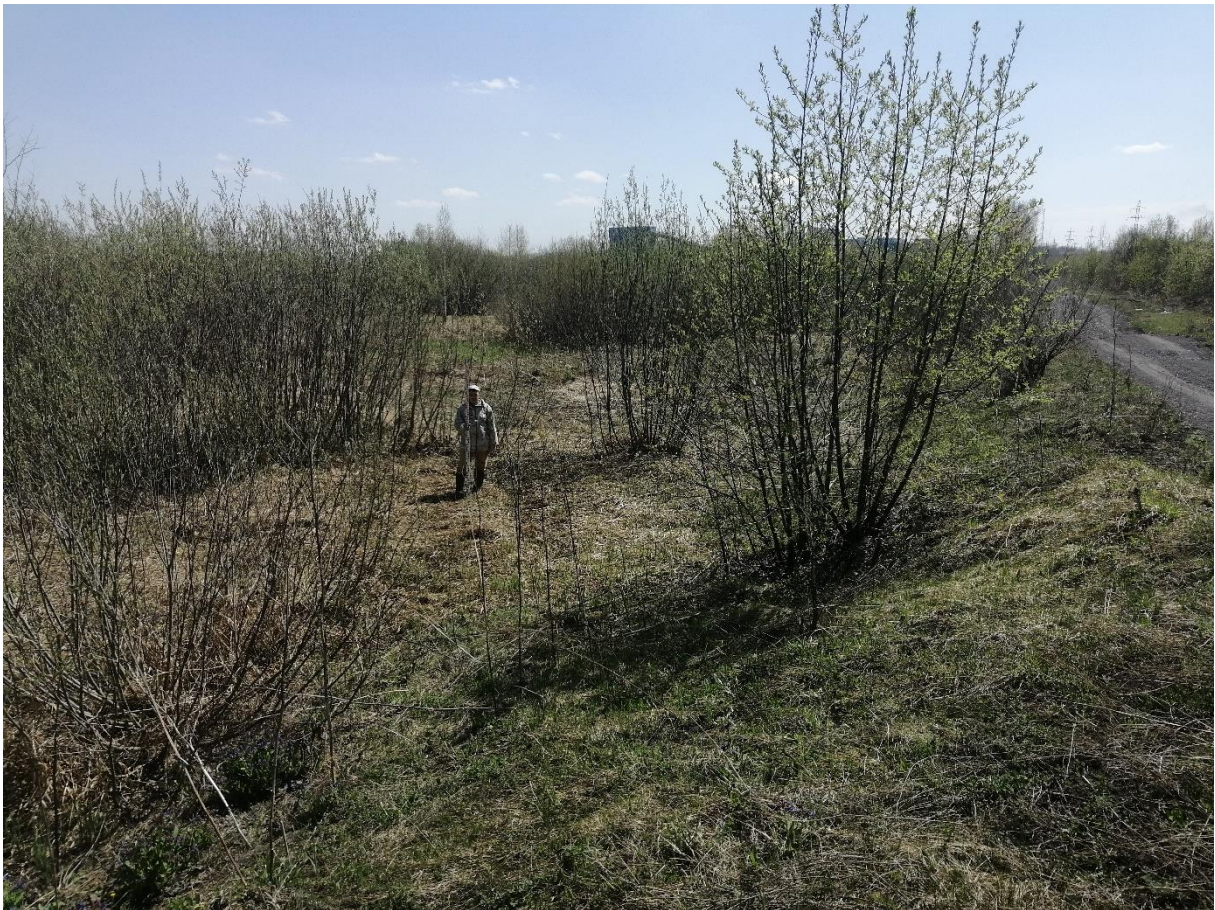
Рис. 31. «Строительство водовода от бункера существующих скважин до узла II подъема...». Точка фотофиксации №10 ( 53^{\circ}46'13.66''\text{С} , 87^{\circ}37'11.90''\text{В} ). Фото с С.
