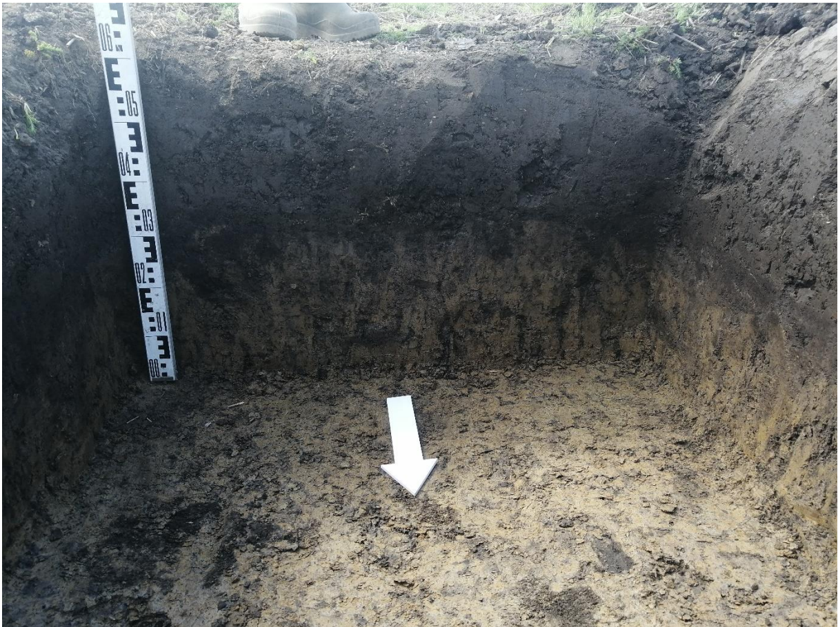
Рис. 49. «Строительство водовода от бункера существующих скважин до узла II подъема...». Шурф №1. Профиль южной стенки. Фото с С.
