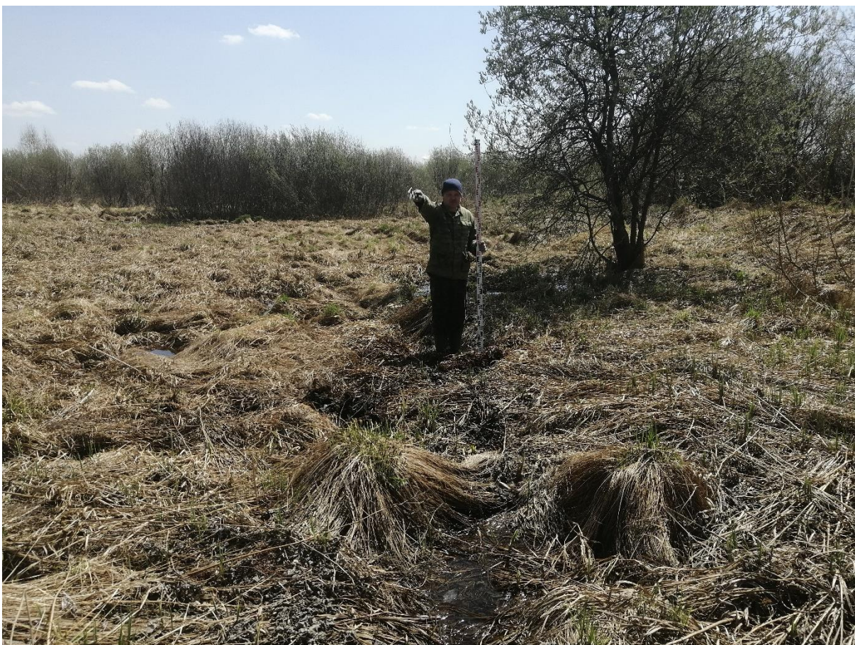
Рис. 30. «Строительство водовода от бункера существующих скважин до узла II подъема...». Точка фотофиксации №9 ( 53^{\circ}46'19.41''\text{С} , 87^{\circ}37'12.26''\text{В} ). Фото с С.
