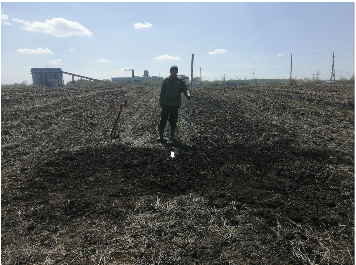
Рис. 66. «Строительство водовода от бункера существующих скважин до узла II подъема...». Шурф №5. Рекультивация. Фото с С.
