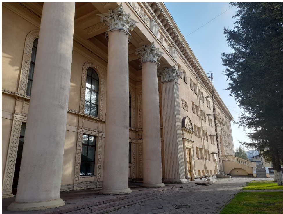
Фото 9. Боковой южный фасад. Фрагмент. 2022 г.
