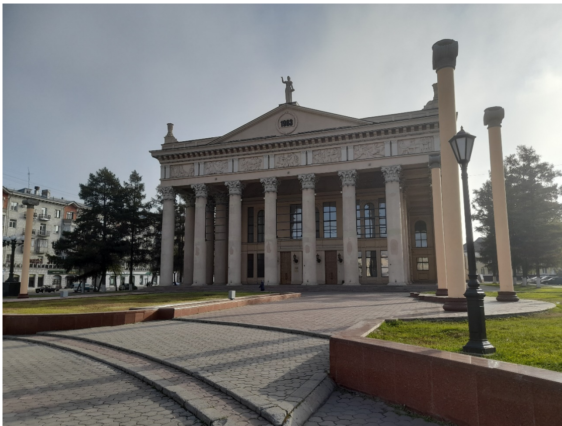
Фото 1. Общий вид главного фасада. 2022 г.
