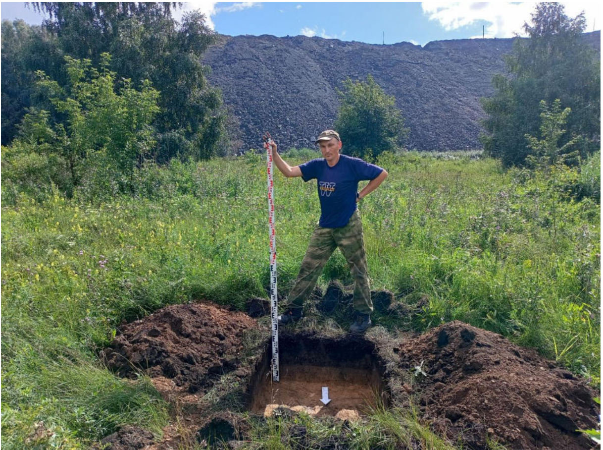
Рис. 250. «Технический проект разработки ... АО «Луговое». Шурф №17 после выборки. Фото с С.
