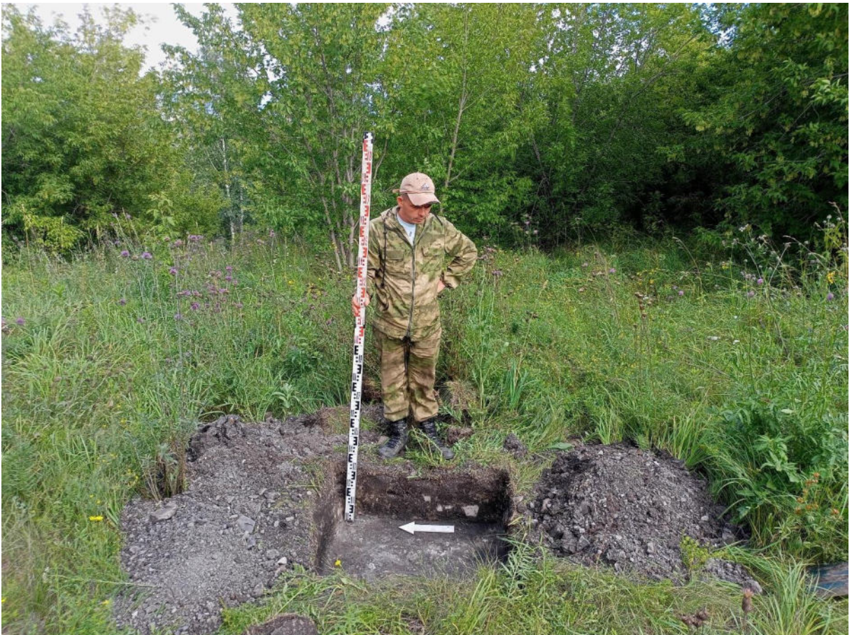
Рис. 390. «Технический проект разработки ... АО «Луговое». Шурф №52 после выборки. Фото с 3.
