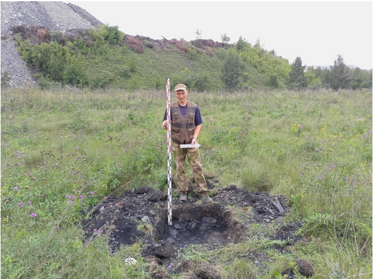
Рис. 238. «Технический проект разработки ... АО «Луговое». Шурф №14 после выборки. Фото с В.
