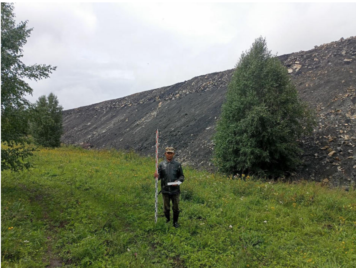
Рис. 116. «Технический проект разработки ... АО «Луговое». Точка фотофиксации №27 ( 54^{\circ}01'14.9''\text{С} , 86^{\circ}34'52.9''\text{В} ). Фото с В.
