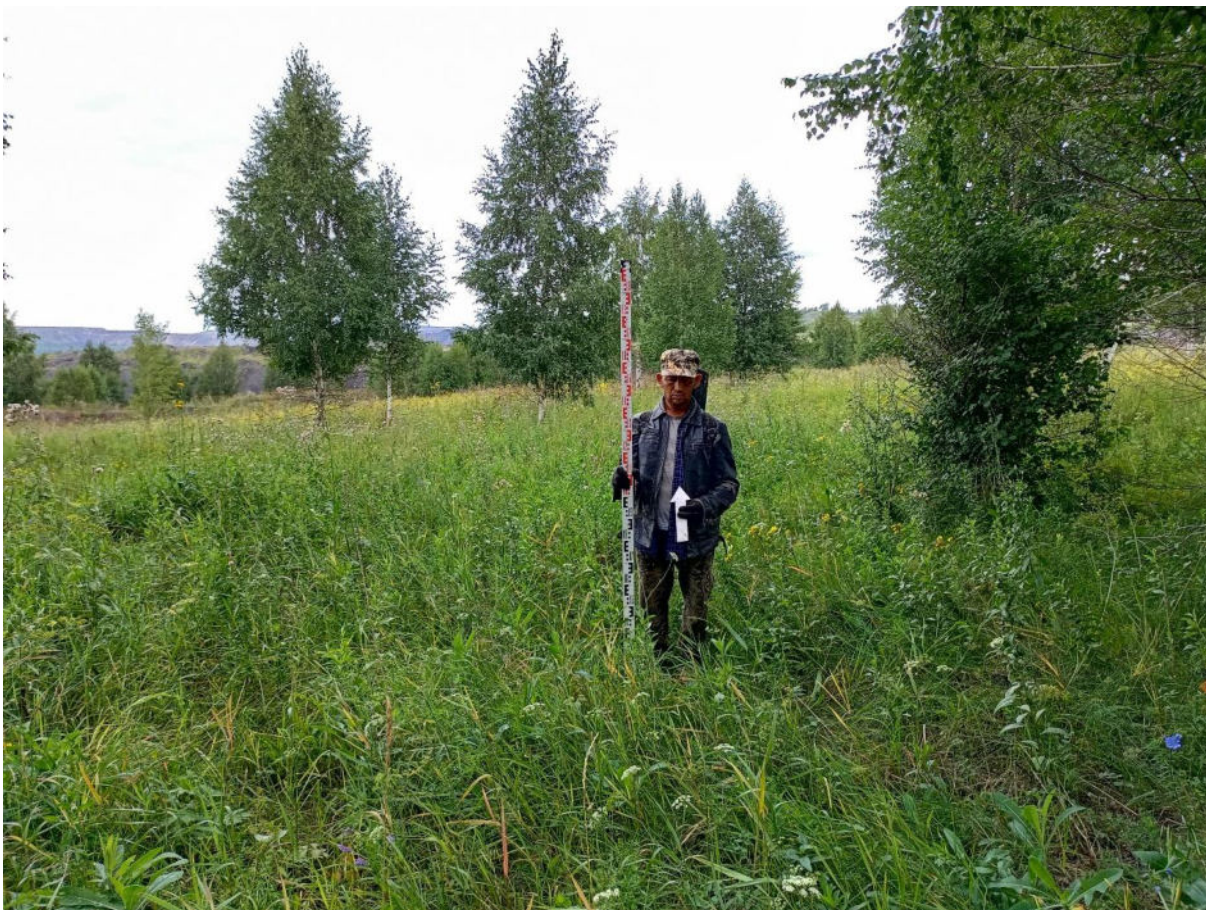
Рис. 325. «Технический проект разработки ... АО «Луговое». Шурф №36 (54°01'15.2"С, 86°34'56.5"В). Место закладки. Фото с Ю.
