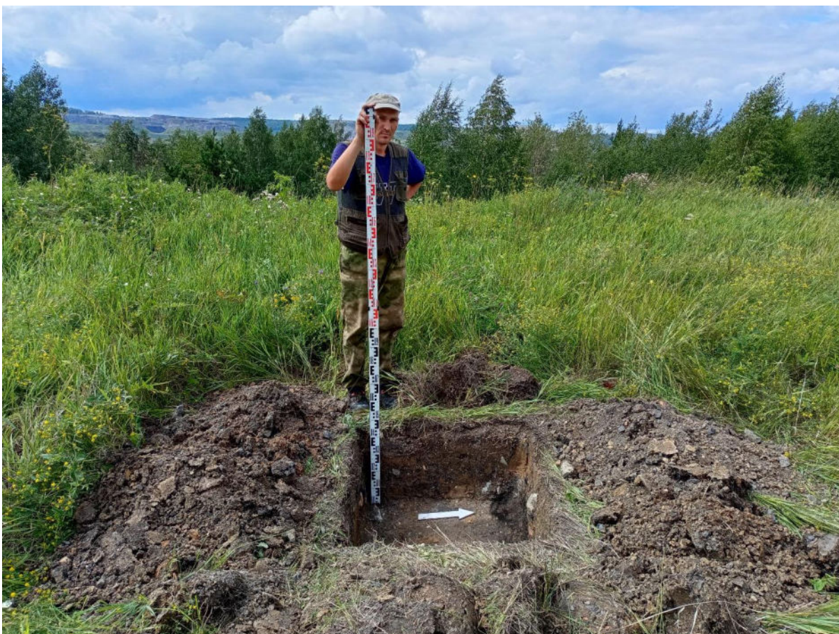
Рис. 278. «Технический проект разработки ... АО «Луговое». Шурф №24 после выборки. Фото с В.
