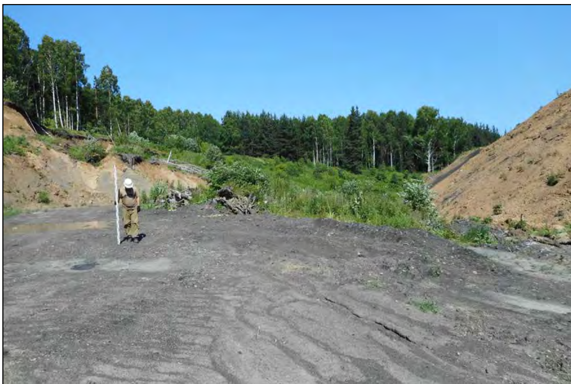
Рис. 8. «III очередь Щедрухинского породного отвала» 2 этап» в Новокузнецком городском округе Кемеровской области. Общий вид. Точка фиксации № 1. Снято с Юга.
