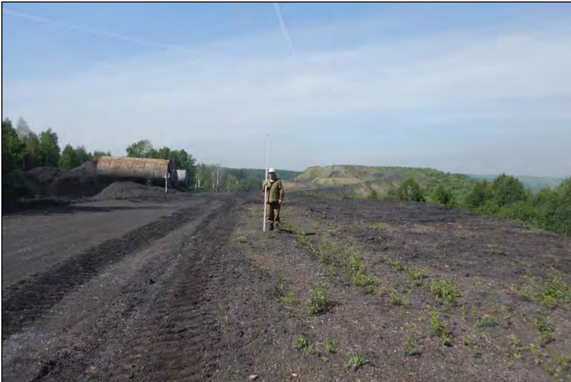
Рис. 53. «III очередь Щедрухинского породного отвала» 2 этап» в Новокузнецком городском округе Кемеровской области. Общий вид. Точка фиксации № 16. Снято с Востока.
