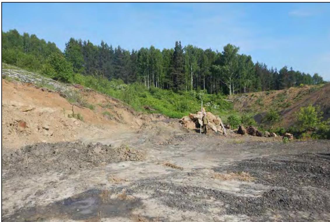
Рис. 55. «III очередь Щедрухинского породного отвала» 2 этап» в Новокузнецком городском округе Кемеровской области. Общий вид. Точка фиксации № 17. Снято с Юга.
