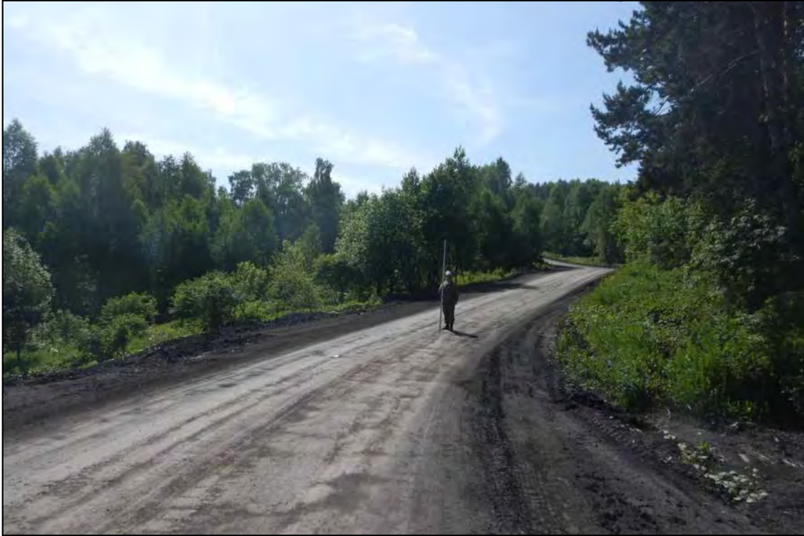
Рис. 51. «III очередь Щедрухинского породного отвала» 2 этап» в Новокузнецком городском округе Кемеровской области. Общий вид. Точка фиксации № 15. Снято с Севера.
