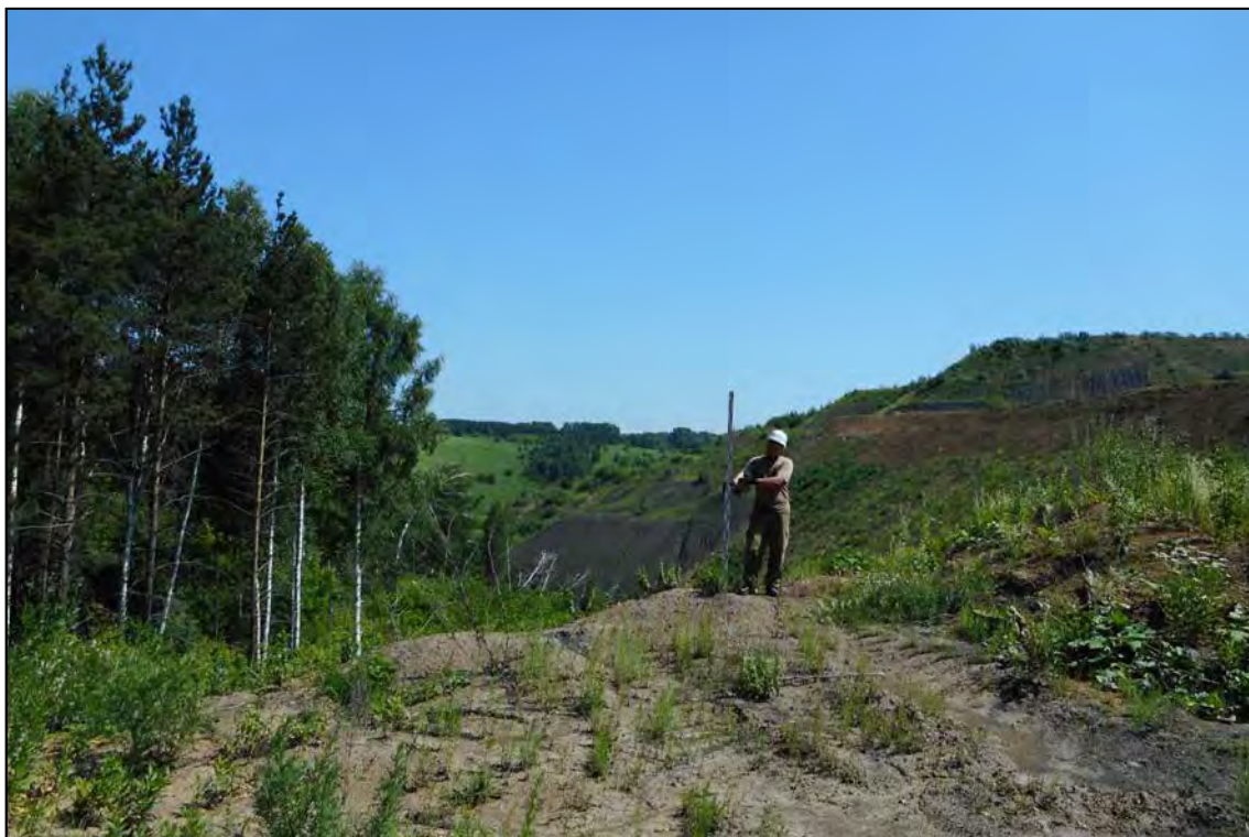
Рис. 13. «III очередь Щедрухинского породного отвала» 2 этап» в Новокузнецком городском округе Кемеровской области. Общий вид. Точка фиксации № 2. Снято с Запада.
