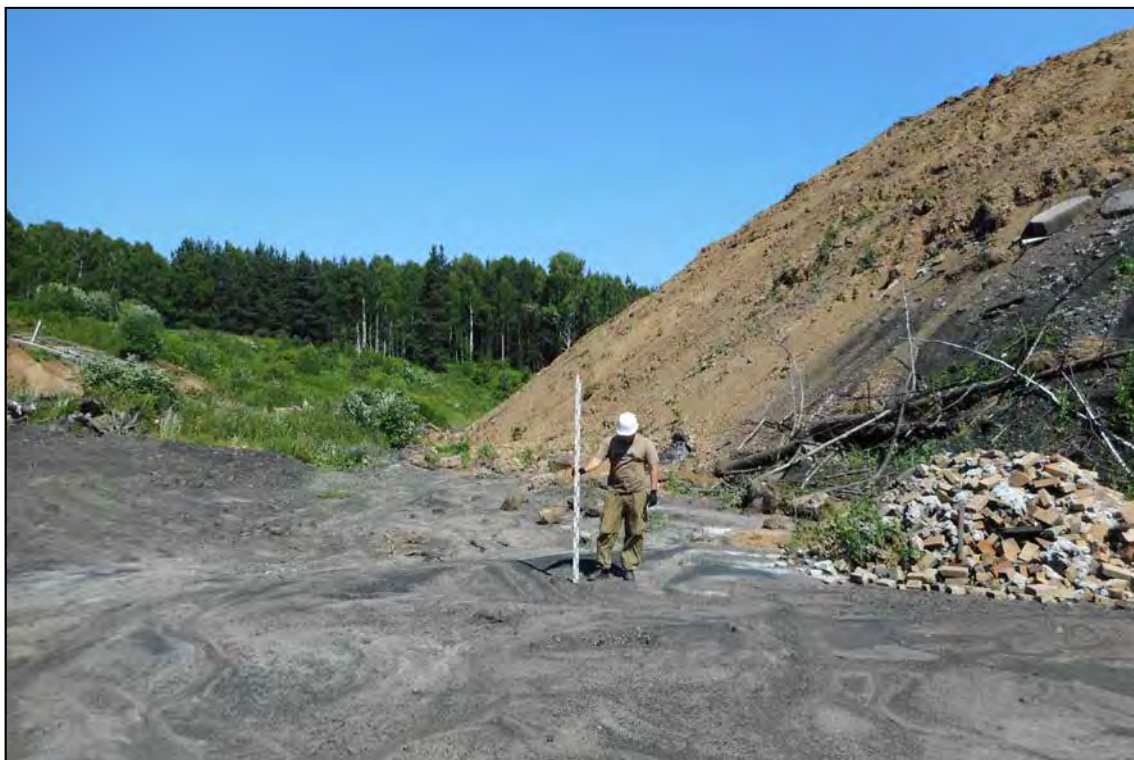
Рис. 5. «III очередь Щедрухинского породного отвала» 2 этап» в Новокузнецком городском округе Кемеровской области. Общий вид. Точка фиксации № 1. Снято с Юго-Востока.
