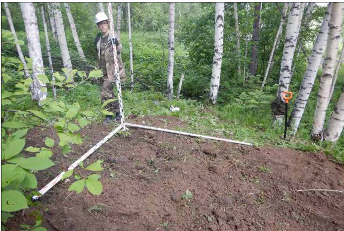
Рис. 116. «III очередь Щедрухинского породного отвала» 2 этап в Новокузнецком городском округе Кемеровской области. Шурф № 11. Рекультивация. Снято с Юга.
