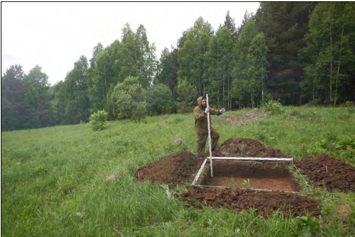
Рис. 106. «III очередь Щедрухинского породного отвала» 2 этап в Новокузнецком городском округе Кемеровской области. Шурф № 9. Вид после завершения земляных работ. Снято с Юга.
