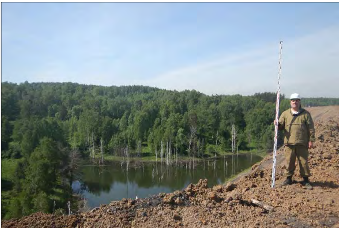
Рис. 68. «III очередь Щедрухинского породного отвала» 2 этап» в Новокузнецком городском округе Кемеровской области. Общий вид. Точка фиксации № 22. Снято с Северо-Восток.
