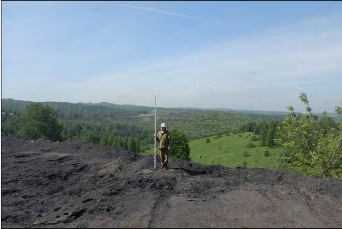
Рис. 69. «III очередь Щедрухинского породного отвала» 2 этап» в Новокузнецком городском округе Кемеровской области. Общий вид. Точка фиксации № 23. Снято с Востока.
