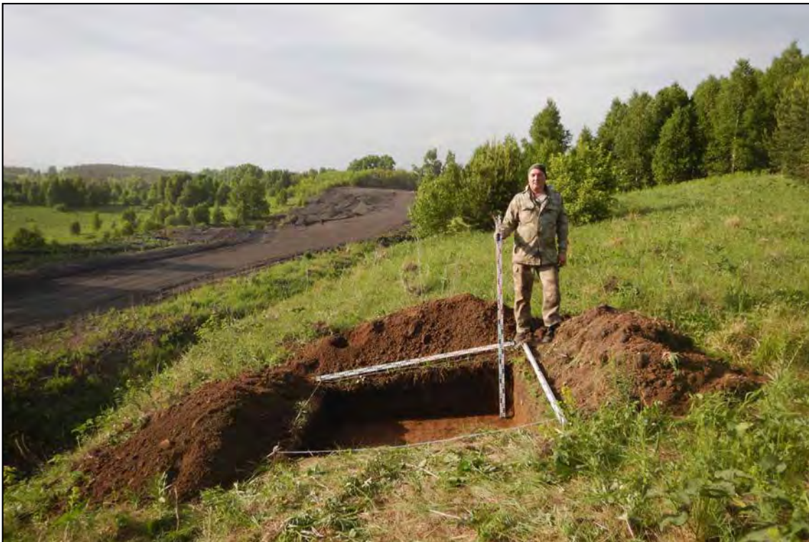
Рис. 78. «III очередь Щедрухинского породного отвала» 2 этап» в Новокузнецком городском округе Кемеровской области. Шурф № 2. Вид после завершения земляных работ. Снято с Юга.
