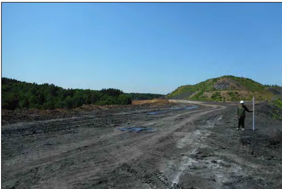
Рис. 30. «III очередь Щедрухинского породного отвала» 2 этап» в Новокузнецком городском округе Кемеровской области. Общий вид. Точка фиксации № 7. Снято с Северо-Востока.
