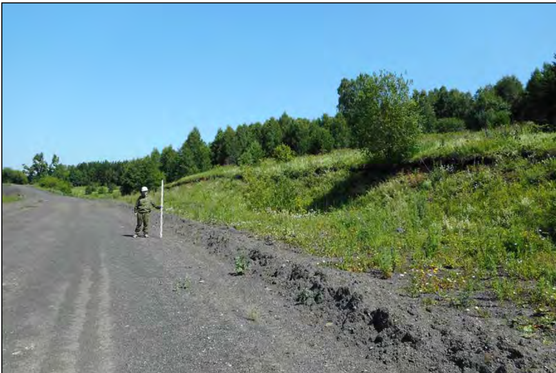
Рис. 33. «III очередь Щедрухинского породного отвала» 2 этап» в Новокузнецком городском округе Кемеровской области. Общий вид. Точка фиксации № 8. Снято с Юга.
