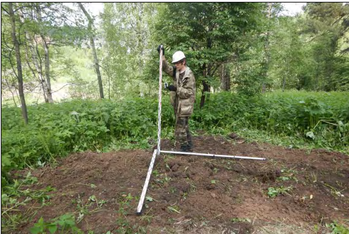
Рис. 112. «III очередь Щедрухинского породного отвала» 2 этап в Новокузнецком городском округе Кемеровской области. Шурф № 10. Рекультивация. Снято с Юга.
