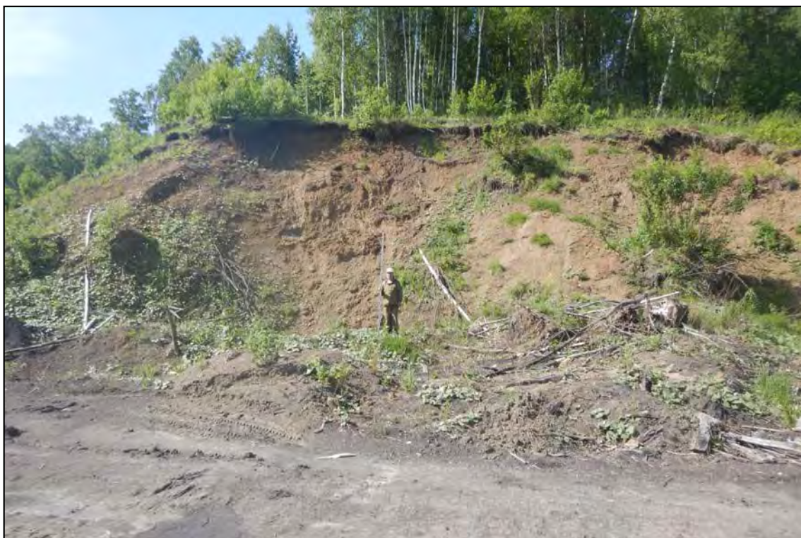
Рис. 62. «III очередь Щедрухинского породного отвала» 2 этап» в Новокузнецком городском округе Кемеровской области. Общий вид. Точка фиксации № 19. Снято с Востока.
