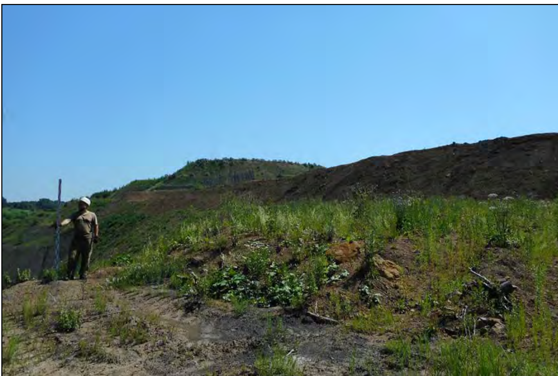
Рис. 12. «III очередь Щедрухинского породного отвала» 2 этап» в Новокузнецком городском округе Кемеровской области. Общий вид. Точка фиксации № 2. Снято с Запада.
