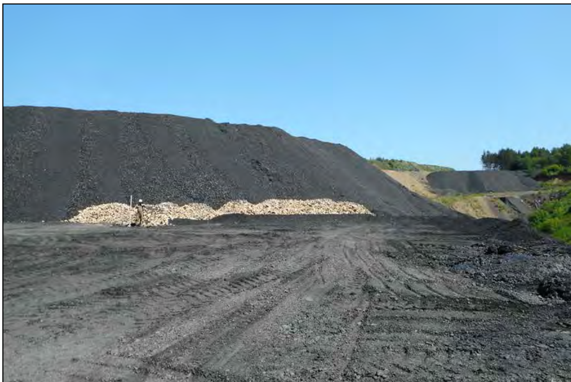
Рис. 17. «III очередь Щедрухинского породного отвала» 2 этап» в Новокузнецком городском округе Кемеровской области. Общий вид. Точка фиксации № 3. Снято с Юга.
