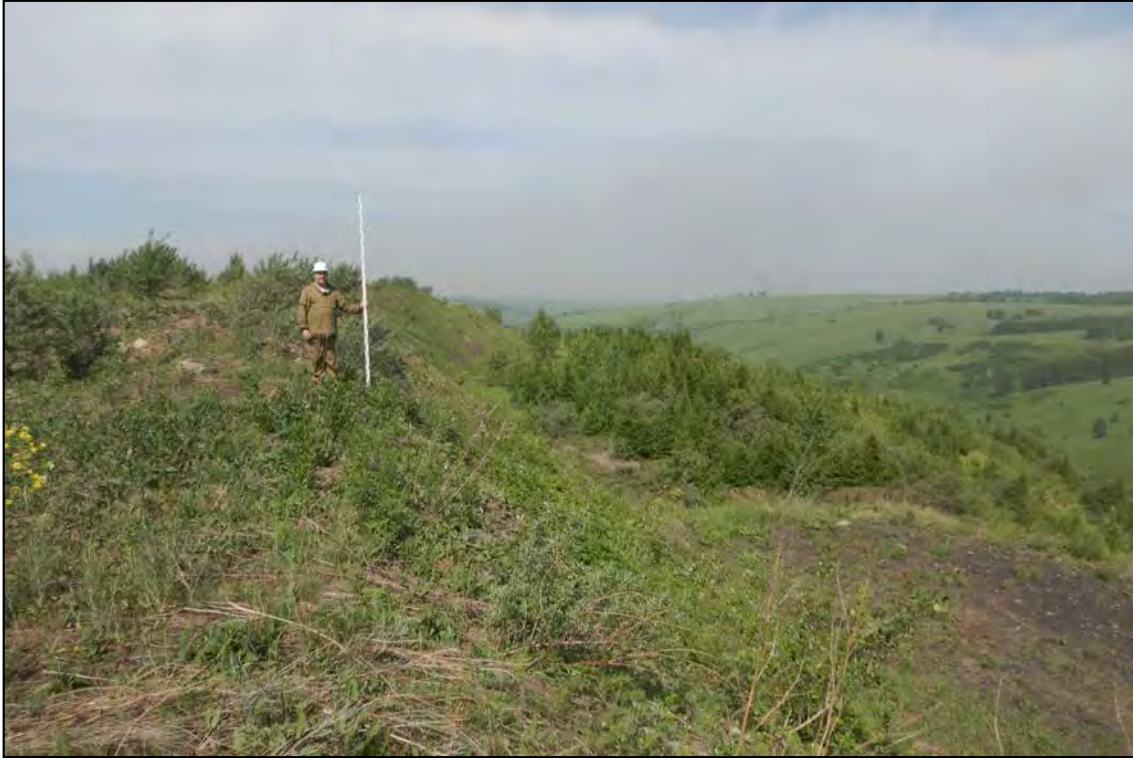
Рис. 71. «III очередь Щедрухинского породного отвала» 2 этап» в Новокузнецком городском округе Кемеровской области. Общий вид. Точка фиксации № 24. Снято с Юго-Востока.
