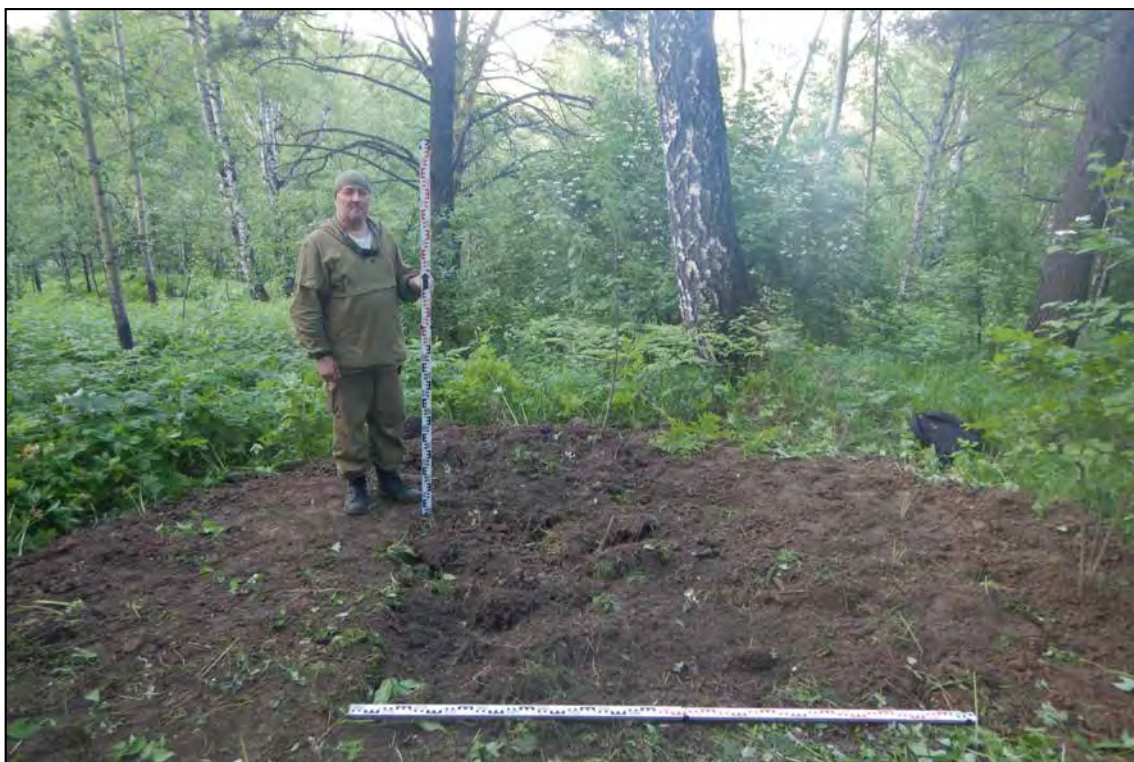
Рис. 132. «III очередь Щедрухинского породного отвала» 2 этап в Новокузнецком городском округе Кемеровской области. Шурф № 15. Рекультивация. Снято с Юга.
