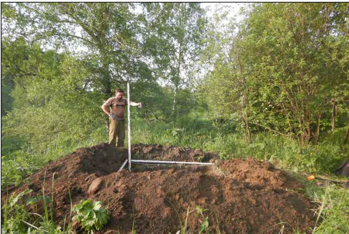
Рис. 90. «III очередь Щедрухинского породного отвала» 2 этап» в Новокузнецком городском округе Кемеровской области. Шурф № 5. Вид после завершения земляных работ. Снято с Юга.
