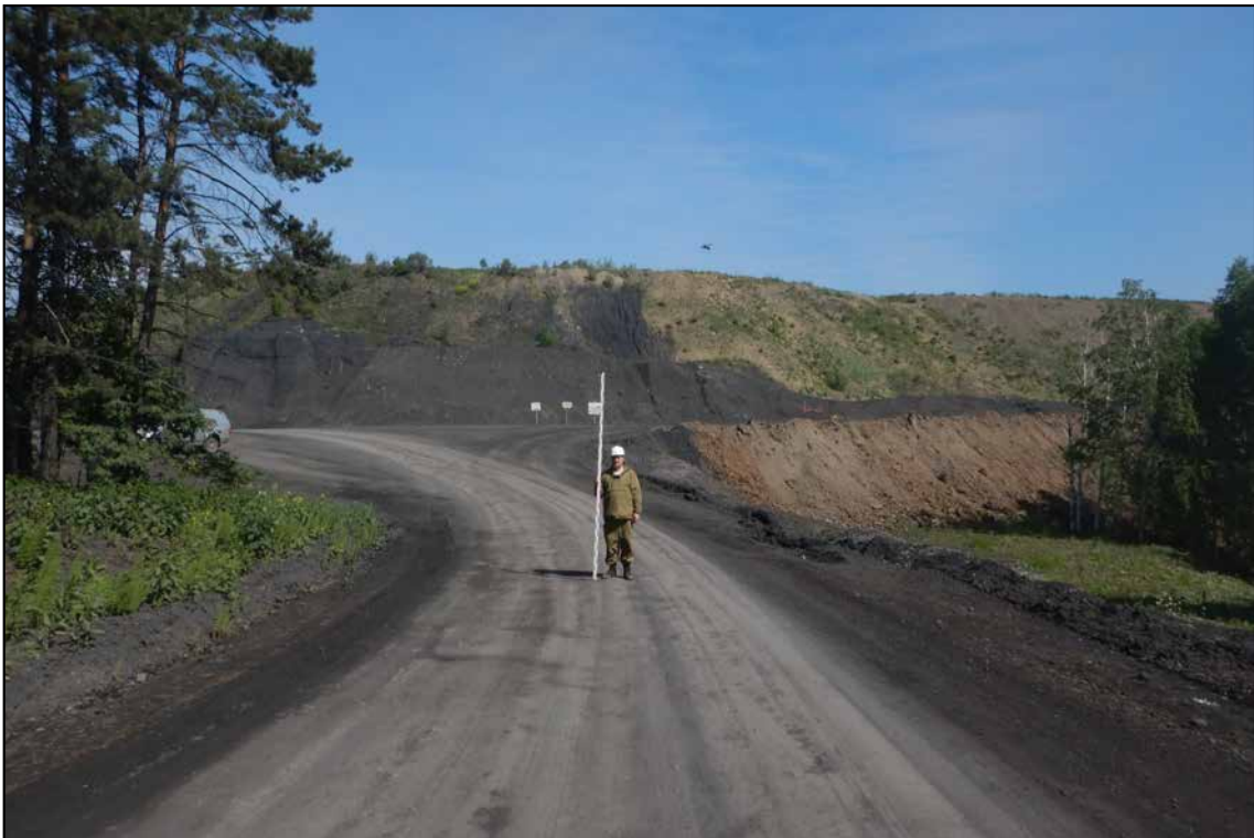
Рис. 52. «III очередь Щедрухинского породного отвала» 2 этап» в Новокузнецком городском округе Кемеровской области. Общий вид. Точка фиксации № 15. Снято с Юга.
