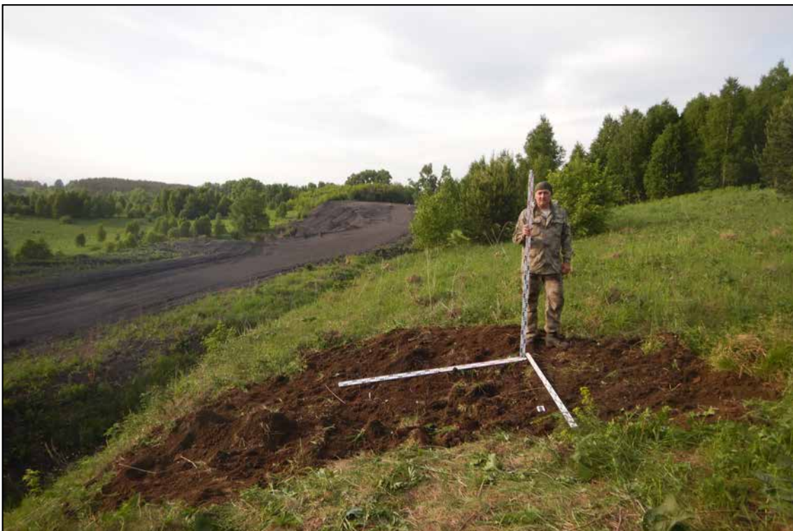
Рис. 80. «III очередь Щедрухинского породного отвала» 2 этап» в Новокузнецком городском округе Кемеровской области. Шурф № 2. Рекультивация. Снято с Юга.
